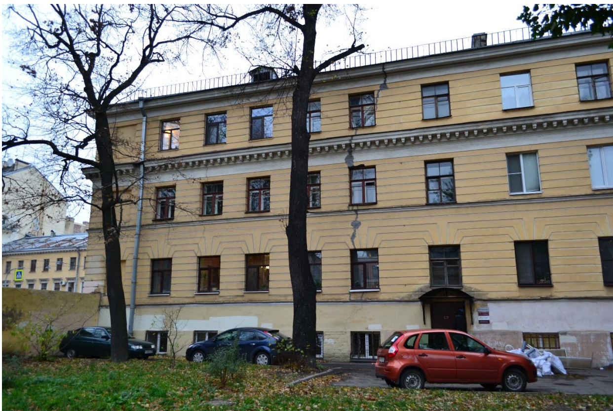
Фото 2. Фрагмент бокового (южного) фасада. Вид с юга.
