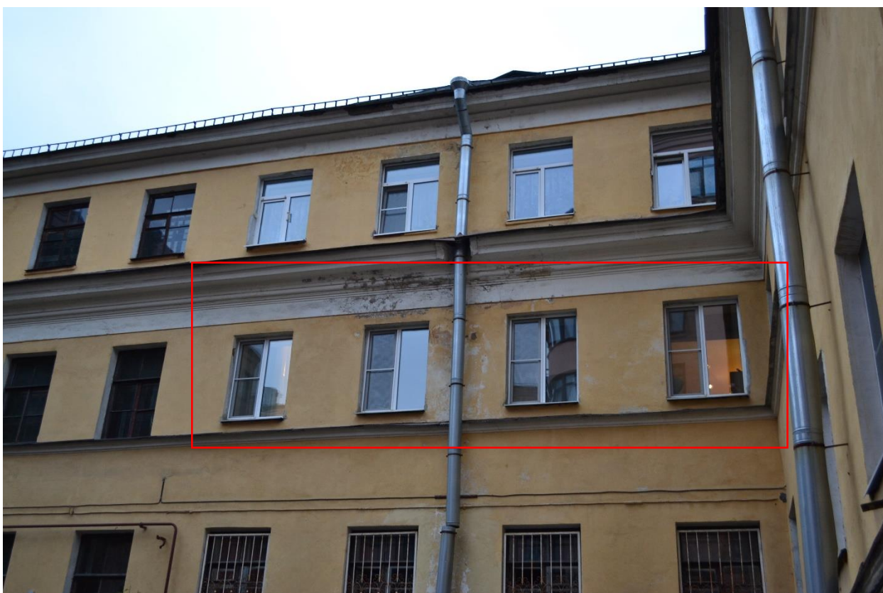
Фото 4. Фрагмент дворового (восточного) фасада. Вид с востока на оконные заполнения квартиры №20.
