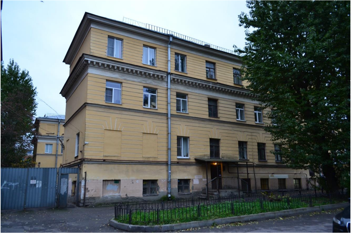
Фото 5. Фрагмент бокового (северного) фасада. Вид с северо-востока.
