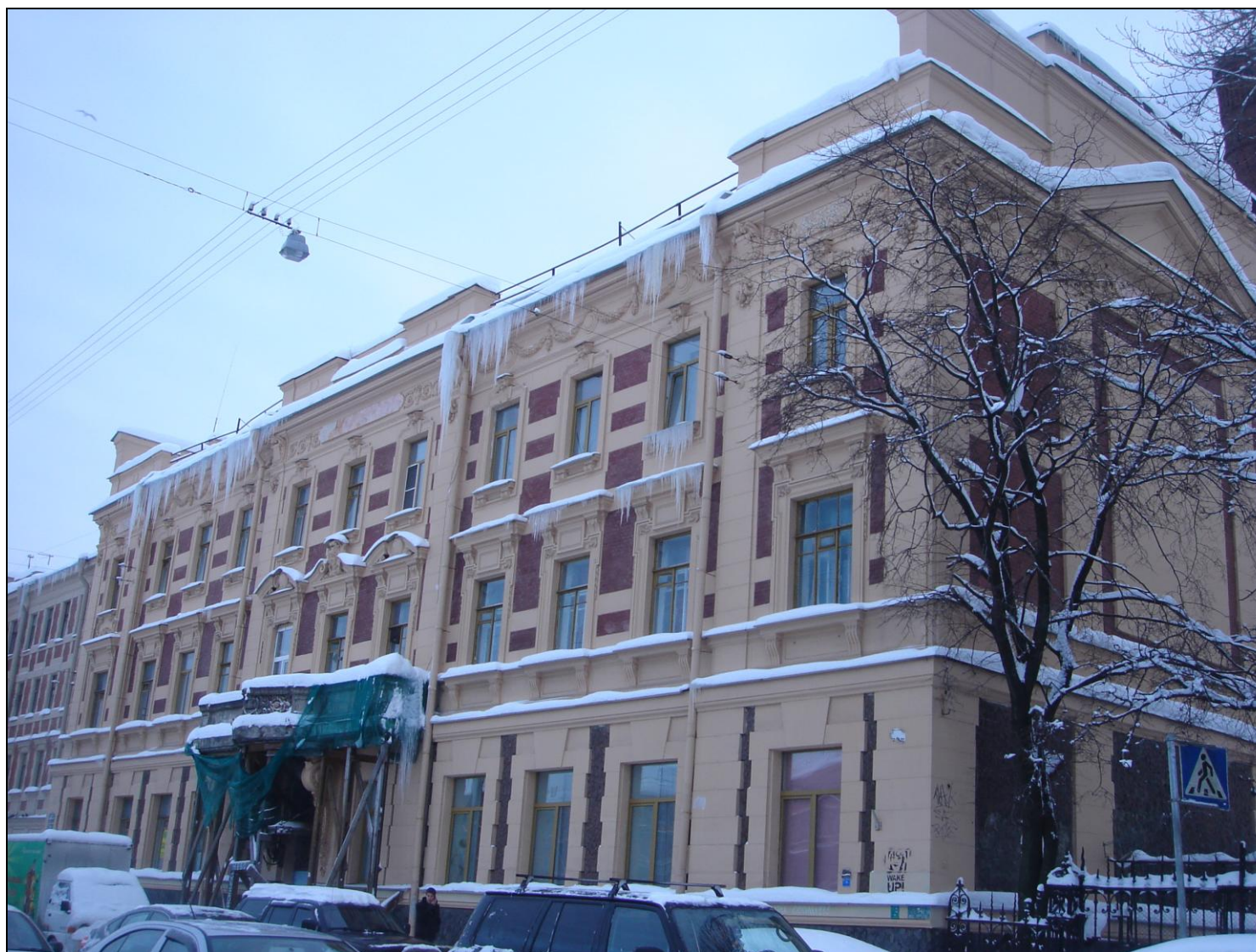
Илл. 27. Общий вид дома № 104 по набережной реки Фонтанки. Фотография. 13 декабря 2010 г. Автор съемки: В.И. Лелина.
