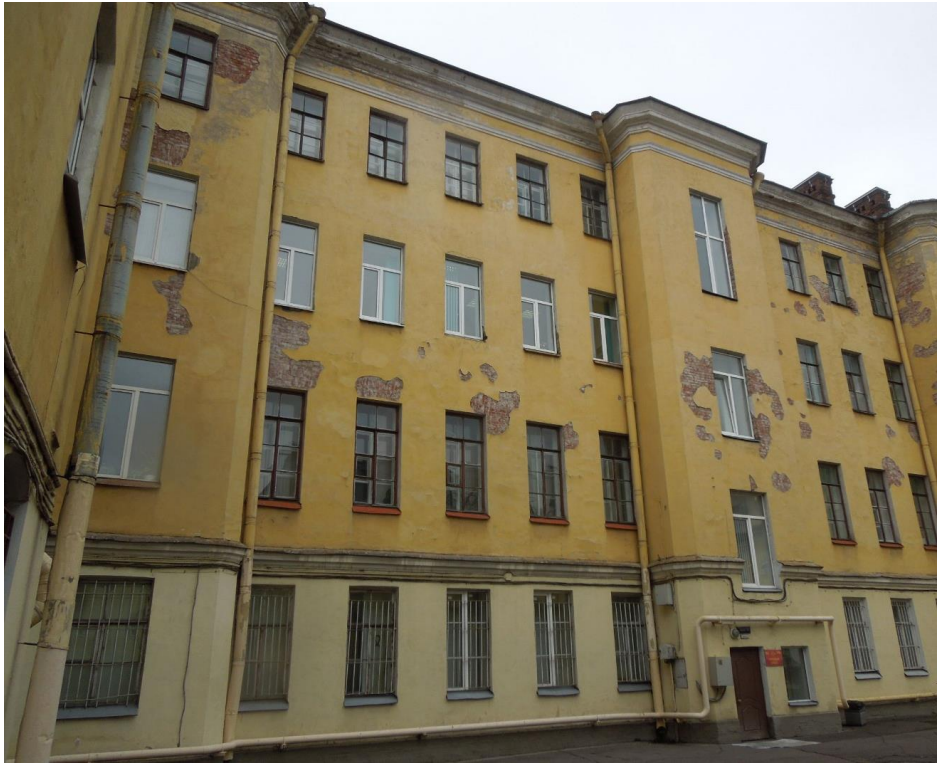
13. Объект культурного наследия регионального значения «Академия Михайловская артиллерийская, где преподавали ученые Ленц Э.Х., Остроградский М.В., Петрушевский В.Ф.» по адресу: Санкт-Петербург, улица Комсомола, дом 22, литера А. Дворовый фасад. Фрагмент.
