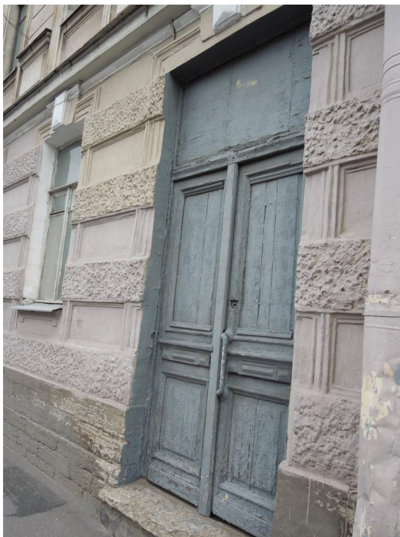
10. Объект культурного наследия регионального значения «Академия Михайловская артиллерийская, где преподавали ученые Ленц Э.Х., Остроградский М.В., Петрушевский В.Ф.» по адресу: Санкт-Петербург, улица Комсомола, дом 22, литера А. Лицевой фасад по улице Академика Лебедева. Историческое деревянное филенчатое дверное заполнение.
