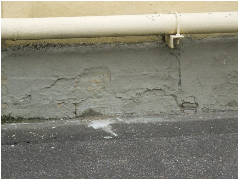
18. Объект культурного наследия регионального значения «Академия Михайловская артиллерийская, где преподавали ученые Ленц Э.Х., Остроградский М.В., Петрушевский В.Ф.» по адресу: Санкт-Петербург, улица Комсомола, дом 22, литера А. Дворовый фасад. Фрагмент. Известняковая облицовка цокольной части здания (частично скрыта культурным слом, частично покрашена, либо закрыта цементными обмазками).
