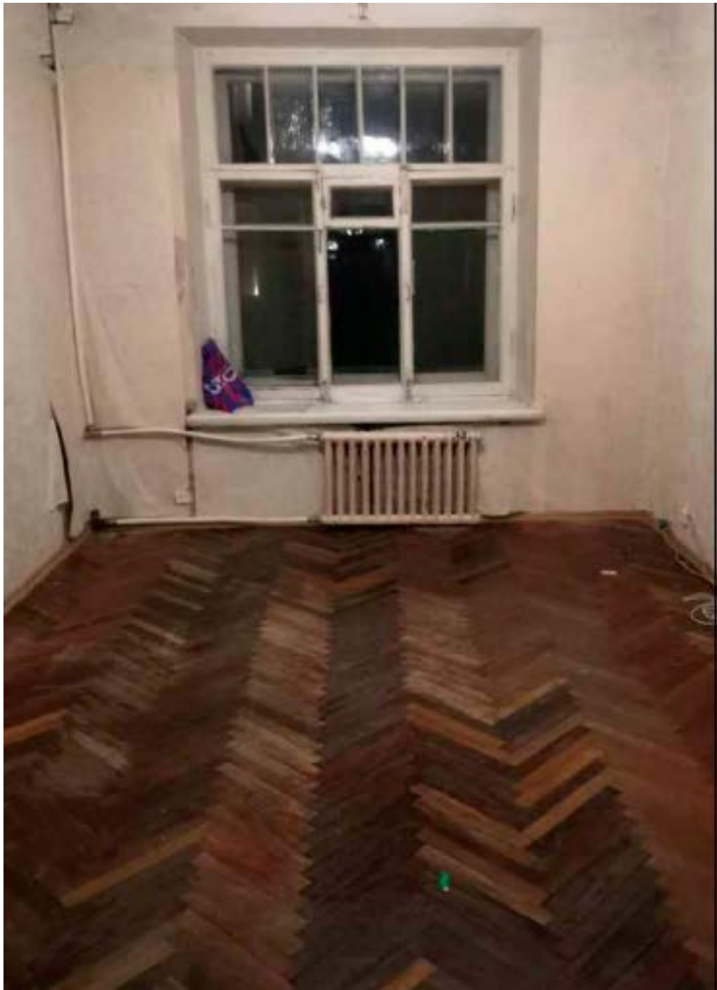
13. Помещение №4 кв. №2 в уровне 2-го этажа объекта культурного наследия регионального значения «Дом Т.П. Павловой», расположенного по адресу: г. Санкт-Петербург, Конная ул., д. 8, литера А. 30.12.2020.
