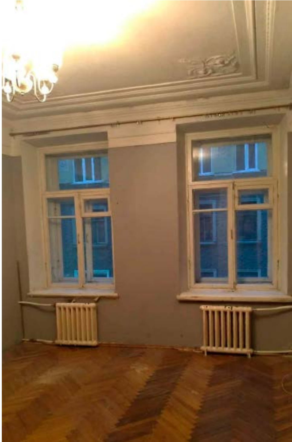
8. Помещение №2 кв. №2 в уровне 2-го этажа объекта культурного наследия регионального значения «Дом Т.П. Павловой», расположенного по адресу: г. Санкт-Петербург, Конная ул., д. 8, литера А. 30.12.2020.
