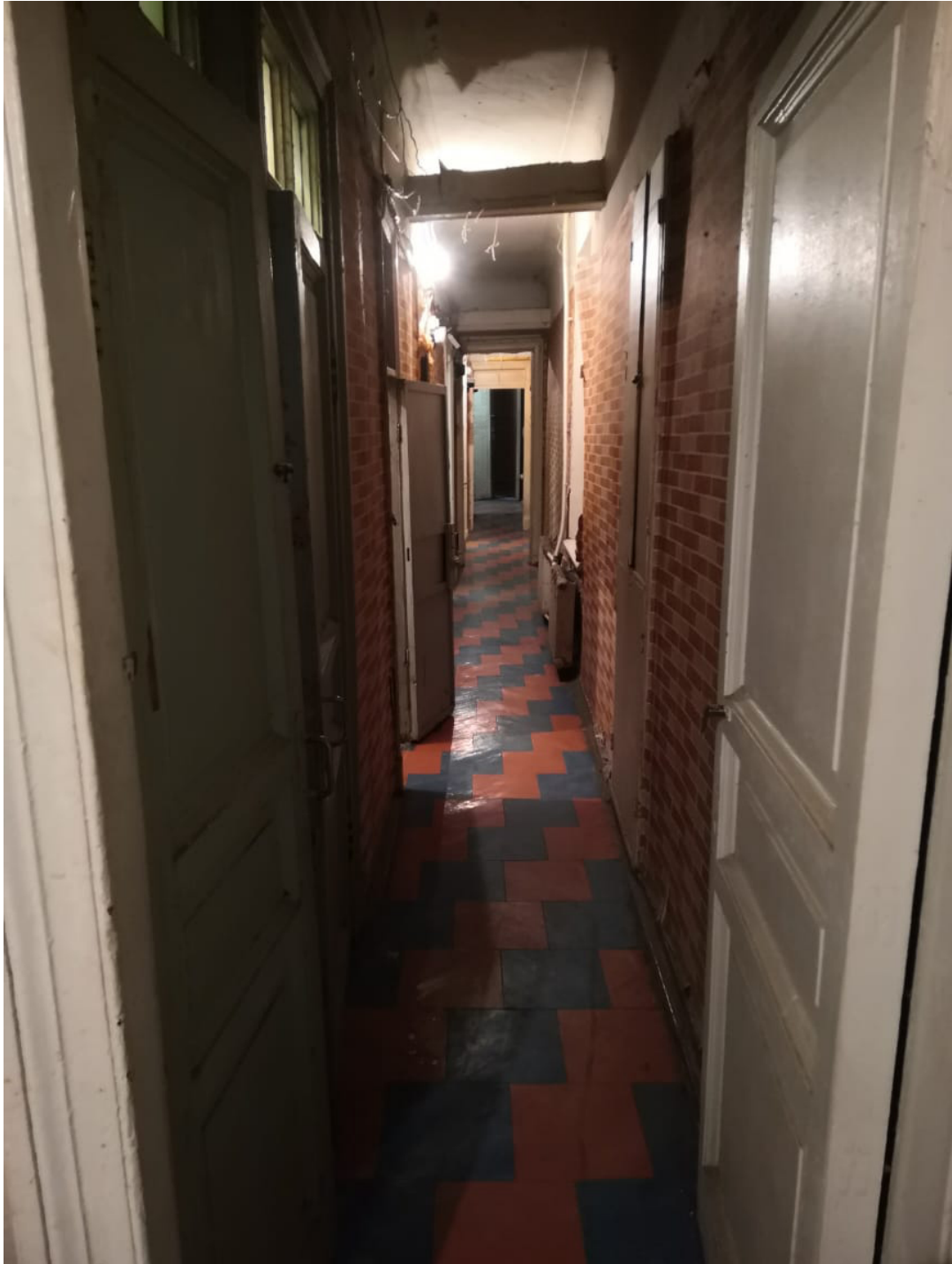
6. Помещение №13 кв. №2 в уровне 2-го этажа объекта культурного наследия регионального значения «Дом Т.П. Павловой», расположенного по адресу: г. Санкт-Петербург, Конная ул., д. 8, литера А. 30.12.2020.
