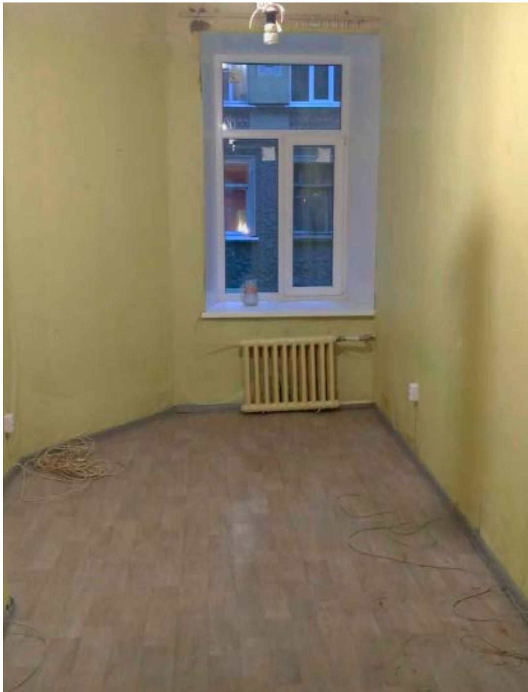
14. Помещение №5 кв. №2 в уровне 2-го этажа объекта культурного наследия регионального значения «Дом Т.П. Павловой», расположенного по адресу: г. Санкт-Петербург, Конная ул., д. 8, литера А. 30.12.2020.
