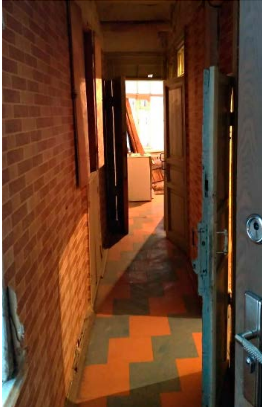
19. Помещение №11 кв. №2 в уровне 2-го этажа объекта культурного наследия регионального значения «Дом Т.П. Павловой», расположенного по адресу: г. Санкт-Петербург, Конная ул., д. 8, литера А. 30.12.2020.
