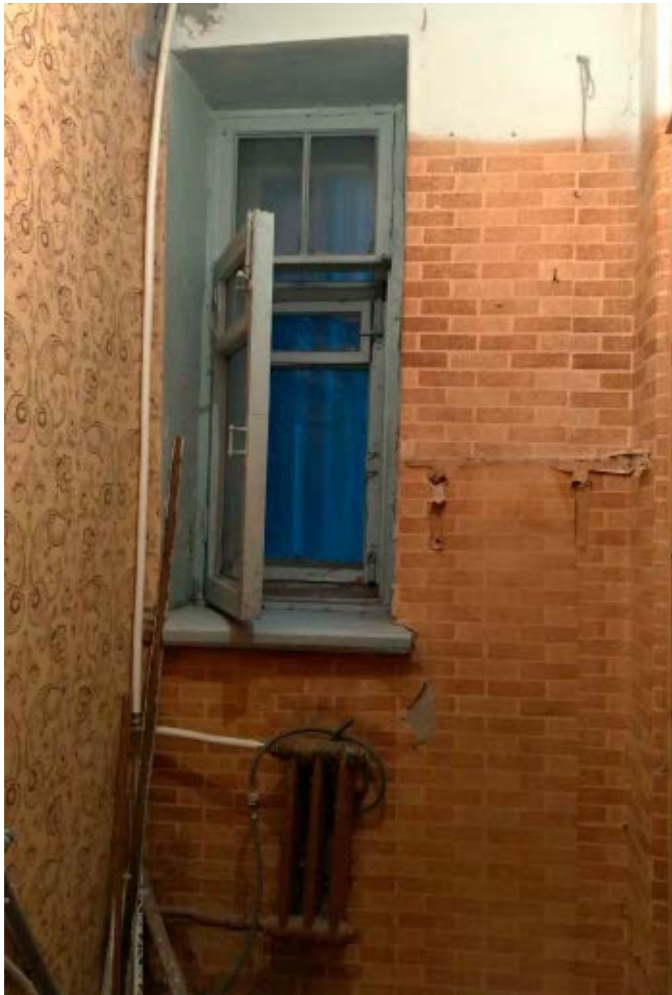
15. Помещение №6 кв. №2 в уровне 2-го этажа объекта культурного наследия регионального значения «Дом Т.П. Павловой», расположенного по адресу: г. Санкт-Петербург, Конная ул., д. 8, литера А. 30.12.2020.
