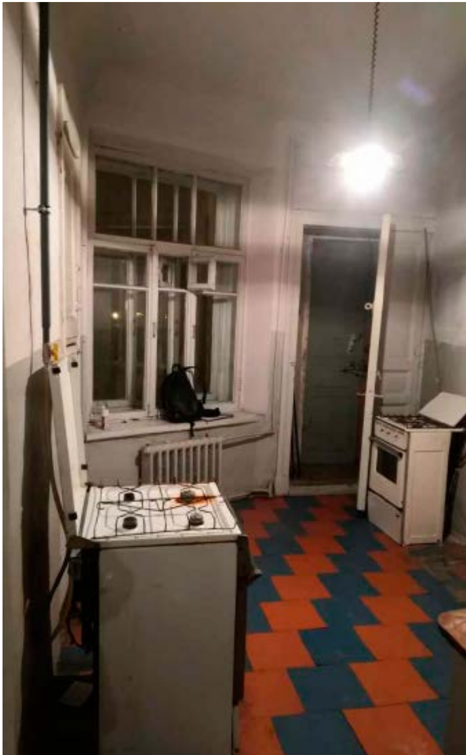
18. Помещение №10 кв. №2 в уровне 2-го этажа объекта культурного наследия регионального значения «Дом Т.П. Павловой», расположенного по адресу: г. Санкт-Петербург, Конная ул., д. 8, литера А. 30.12.2020.
