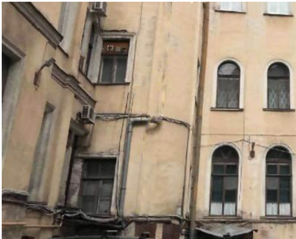
31. Дом А.С.Уварова (В.А.Грейга) (наб. реки Мойки, д. 93, лит. А.). Фото мест проектируемого прохождения кабельных трасс. 01.10.2020. Штиглиц М.С.
