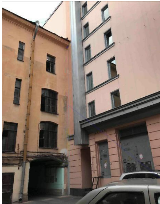
23. Дом А.П.Козлова (Большая Морская ул., д. 56, лит. А.). Фото мест проектируемого прохождения кабельных трасс. 01.10.2020. Штиглиц М.С.
