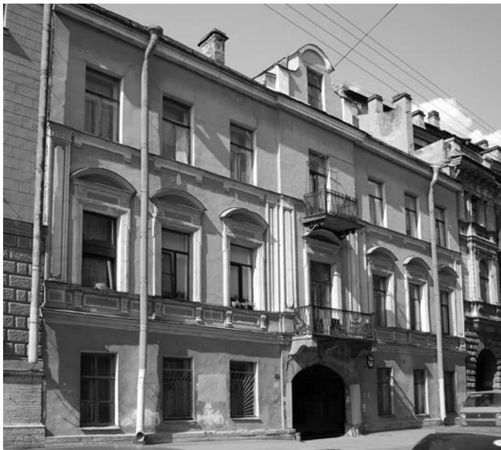
1. Дом кн. Л.Д.Вяземского (Галерная ул., д. 67, лит. А.). Фото начала 2000-х г. [19].
