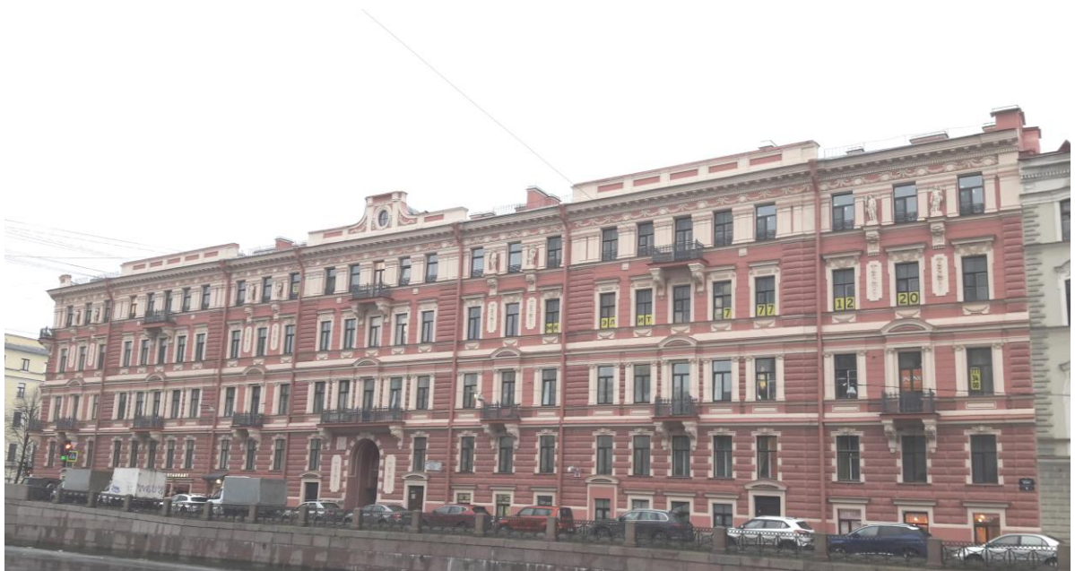
26. Доходный дом. Доходные дома М.С.Воронина (наб. р. Мойки, д. 82, лит. А.). 01.10.2020. Штиглиц М.С.
