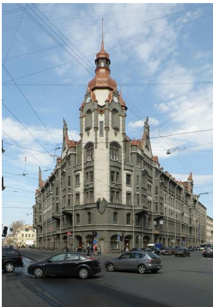
34. Дом городских учреждений (Садовая ул., д. 55-57, лит. А.). 01.10.2020. Штиглиц М.С.
