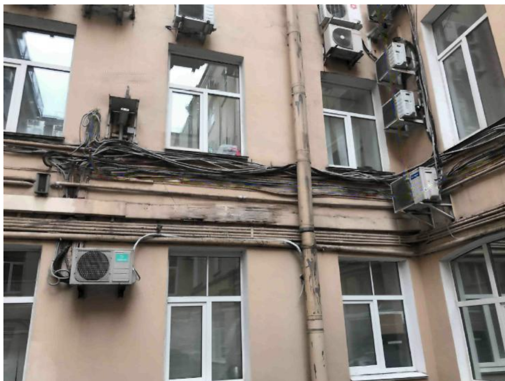
14. Дом Паскевича Ф.И. с дворовыми флигелями (Галерная ул., д, 7. лит. А.). Фото мест проектируемого прохождения кабельных трасс. 01.10.2020. Штиглиц М.С.
