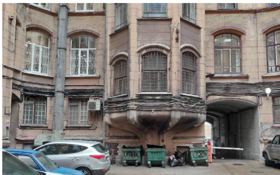
36. Дом городских учреждений (Садовая ул., д. 55-57, лит. А.). Фото мест проектируемого прохождения кабельных трасс. 01.10.2020. Штиглиц М.С.
