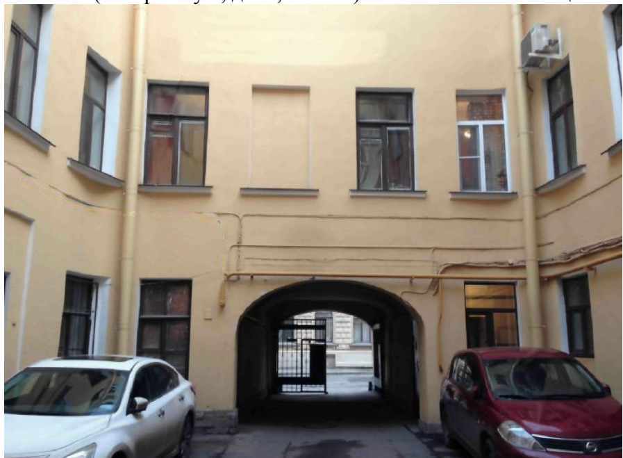
2. Дом кн. Л.Д.Вяземского (Галерная ул., д. 67, лит. А.). Фото мест проектируемого прохождение кабельных трасс. 01.10.2020. Штиглиц М.С.
