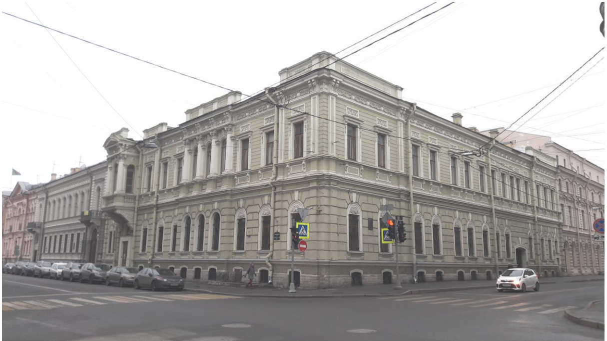
25. Дом Карамзина В.Н. (Коровиной Л.Н.) с дворовыми флигелями (Большая Морская ул., д. 55, лит. А). 01.10.2020. Штиглиц М.С.
