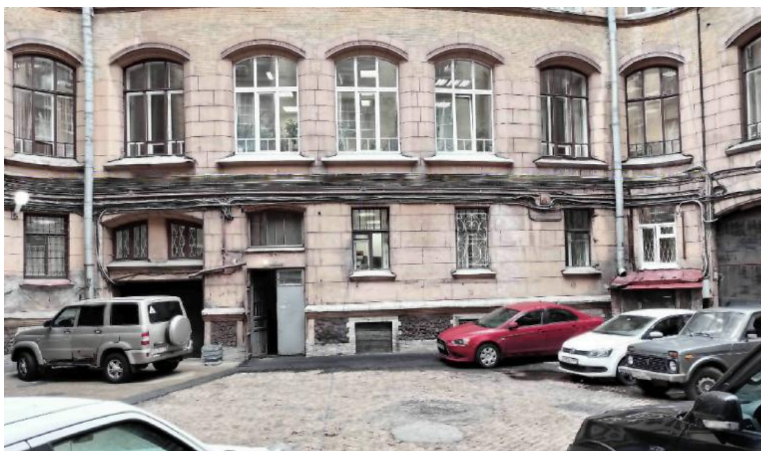
35. Дом городских учреждений (Садовая ул., д. 55-57, лит. А.). Фото мест проектируемого прохождения кабельных трасс. 01.10.2020. Штиглиц М.С.
