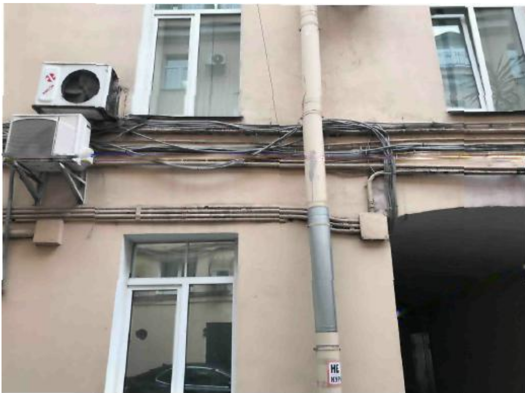
15. Дом Паскевича Ф.И. с дворовыми флигелями (Галерная ул., д. 7. лит. А.). Фото мест проектируемого прохождения кабельных трасс. 01.10.2020. Штиглиц М.С.
