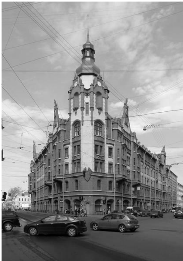
38. Дом городских учреждений ( Садовая ул., д. 55-57, лит. А.). [19].
