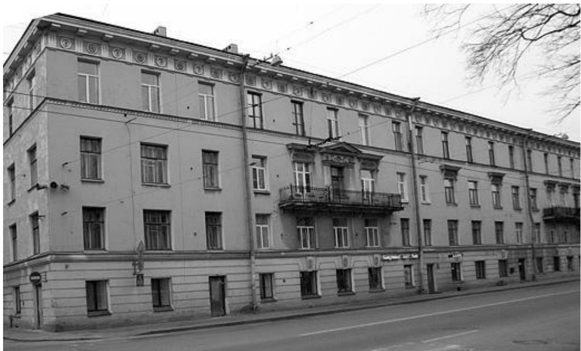
47. Конногвардейский бульвар, д. 6, лит. А. Фото начала 2000-х г. [19].
