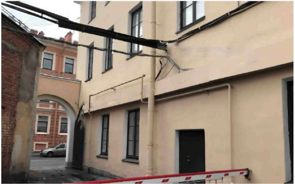
17. Казармы (Трёхэскадронный корпус) (Конногвардейский бульв., д. 4. лит. А.). Фото мест проектируемого прохождения кабельных трасс. 01.10.2020. Штиглиц М.С.
