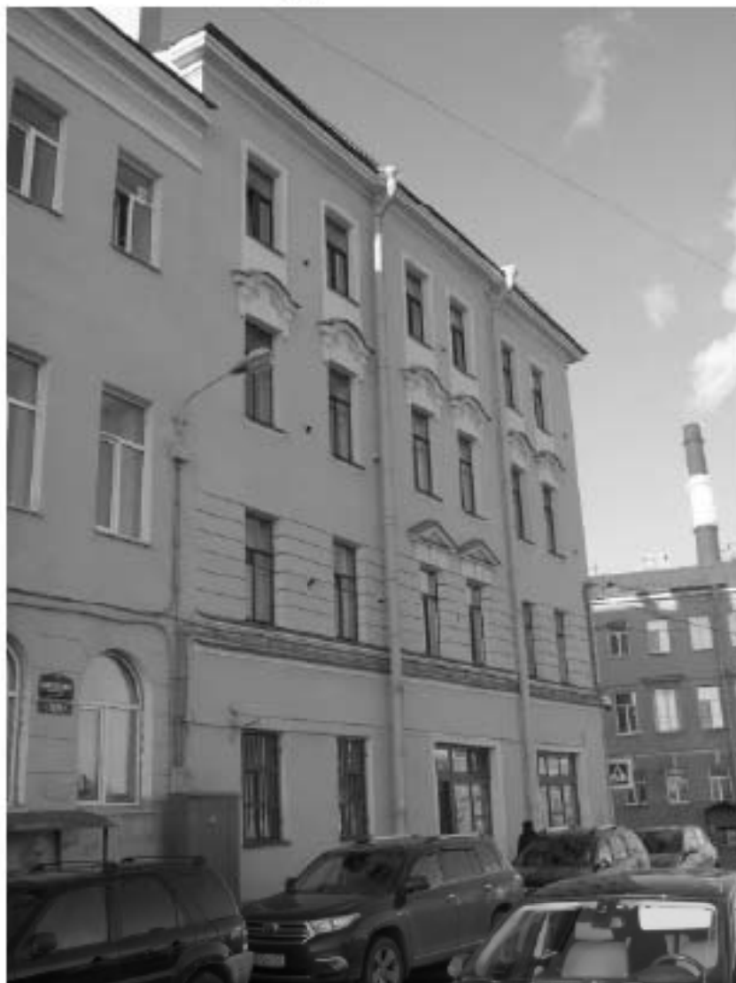
Фото 4.2. Общий вид здания (фасад со стороны Синопской наб.)
