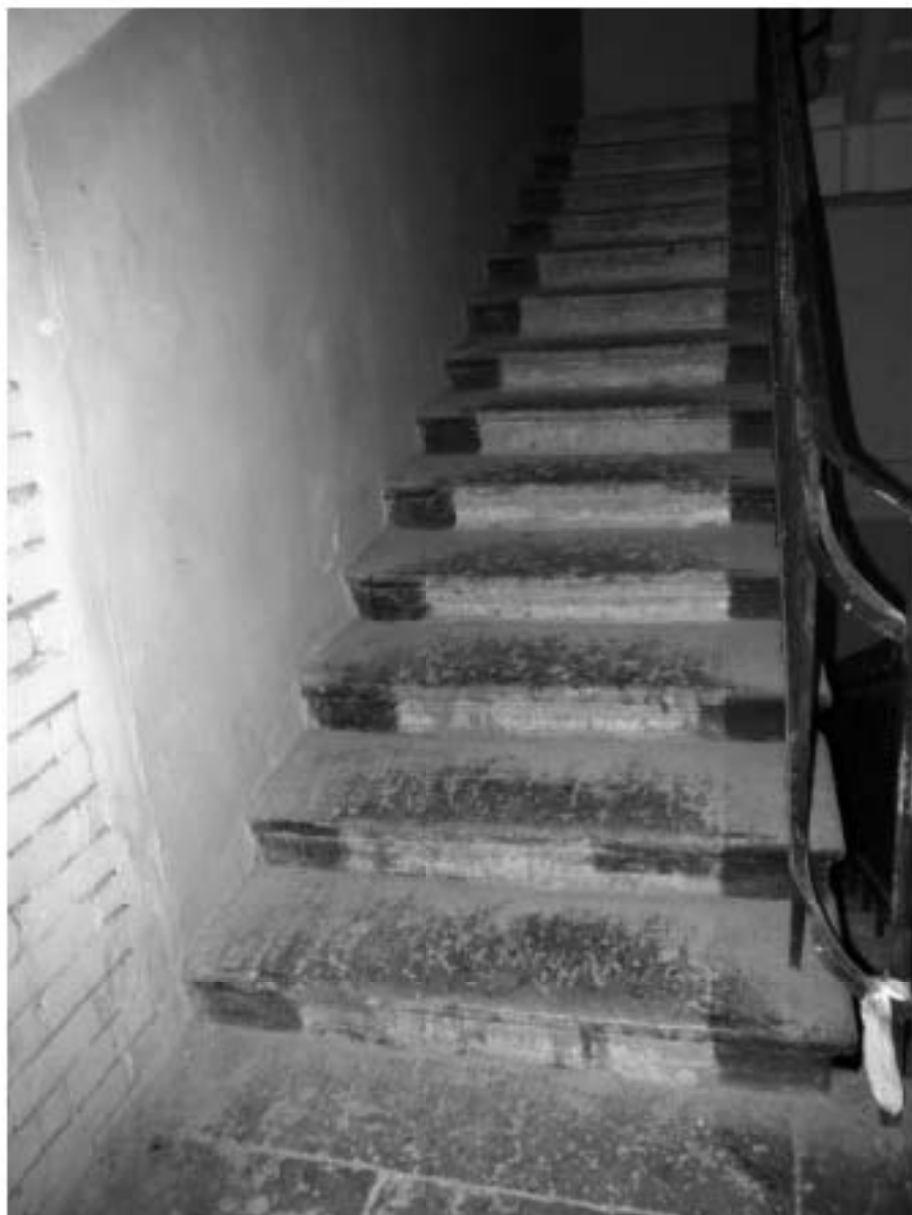
Фото 5.4.3. Фотофиксация лестницы «А-Б/7-8».
