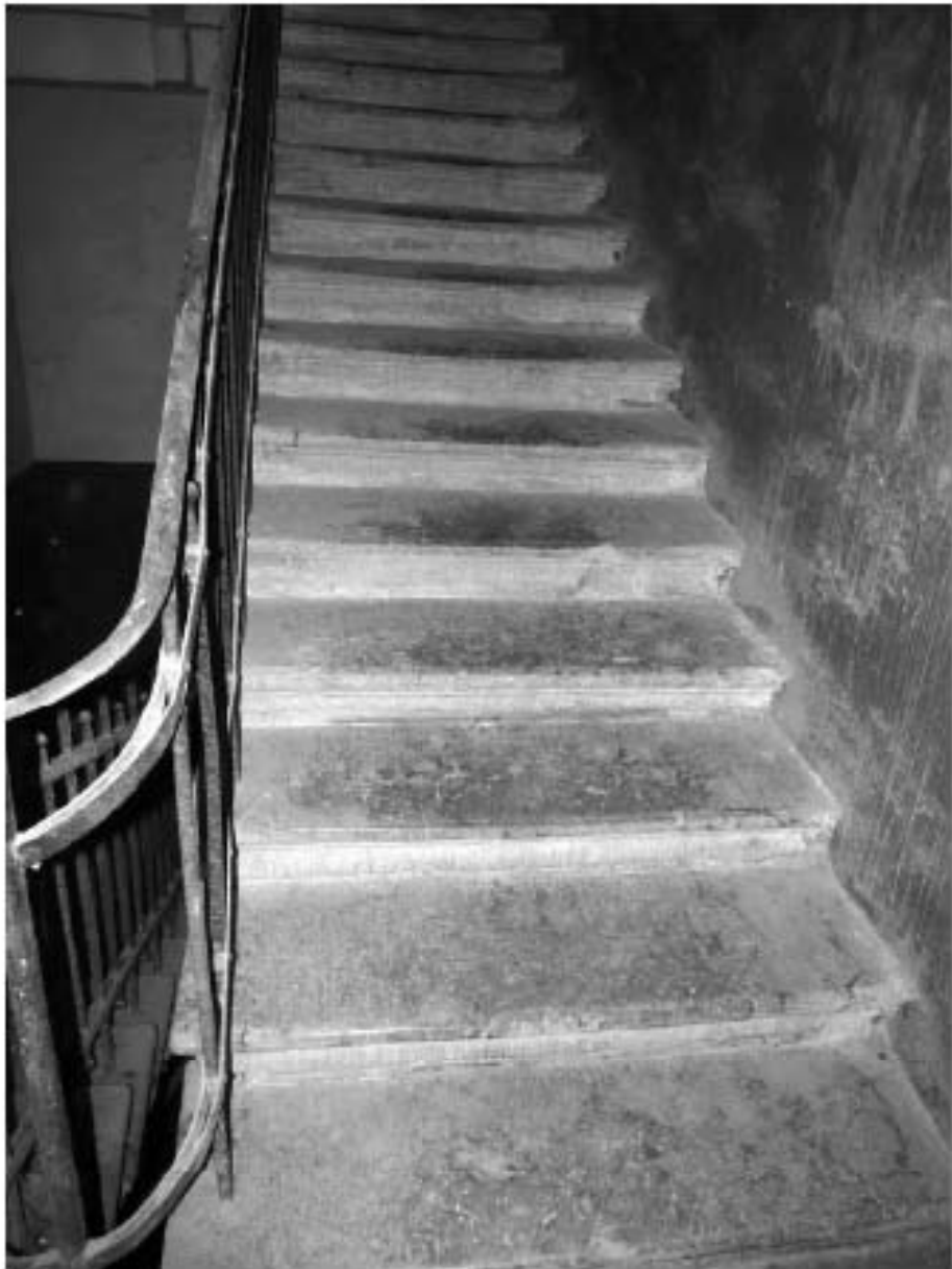
Фото 5.4.5. Фотофиксация лестницы «А-Б/14-15».
