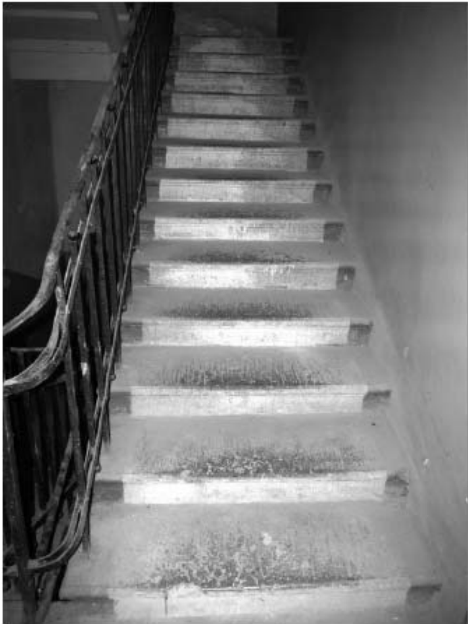
Фото 5.4.1. Фотофиксация лестницы в осях «А-Б/1-2».
