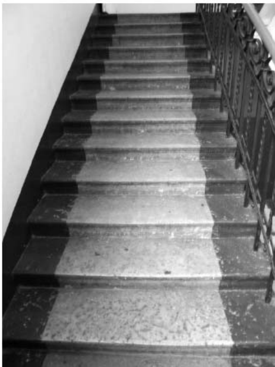
Фото 5.4.6. Фотофиксация лестницы в осях «А2-Г1/17-19».
