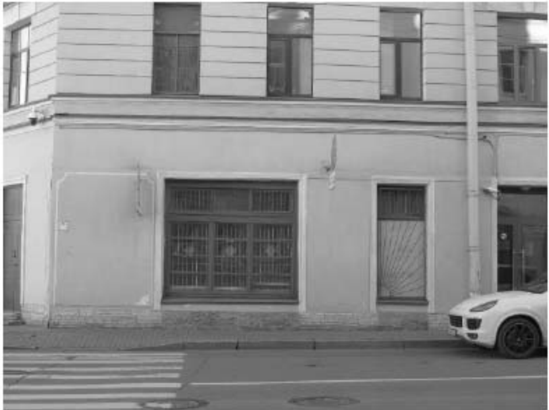
Фото. 5.2.1. Наружная стена здания.
