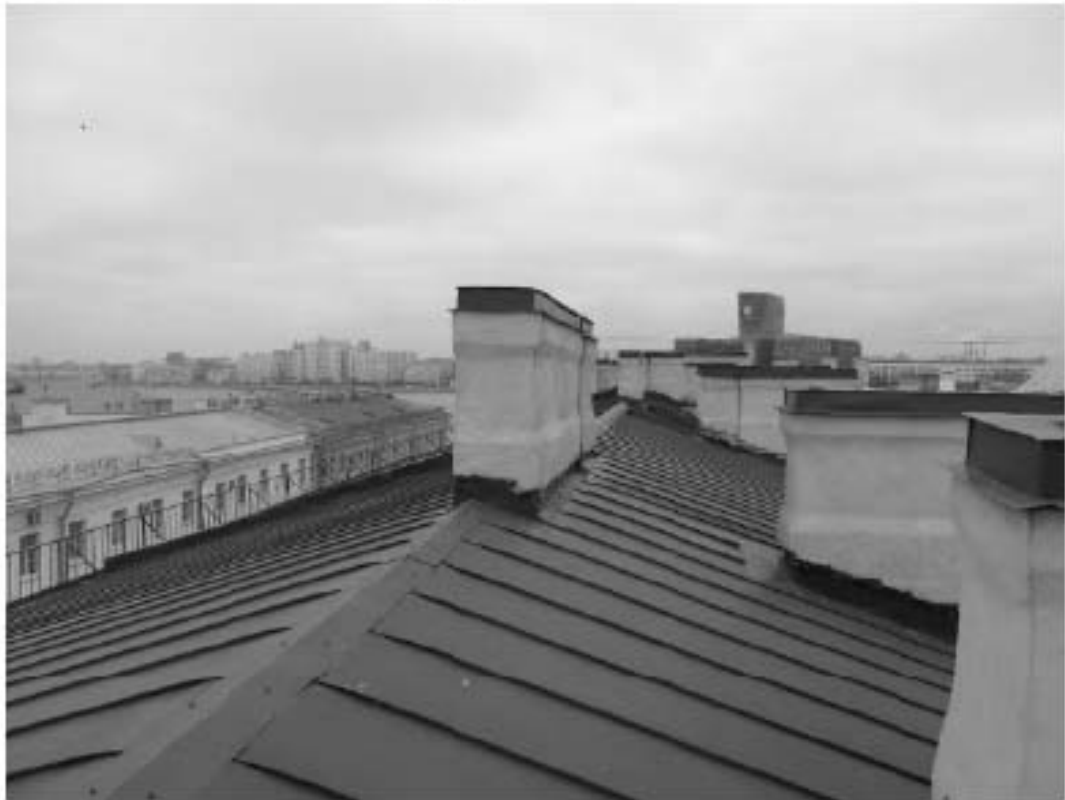
Фото 5.6.1. Общий вид кровли здания
