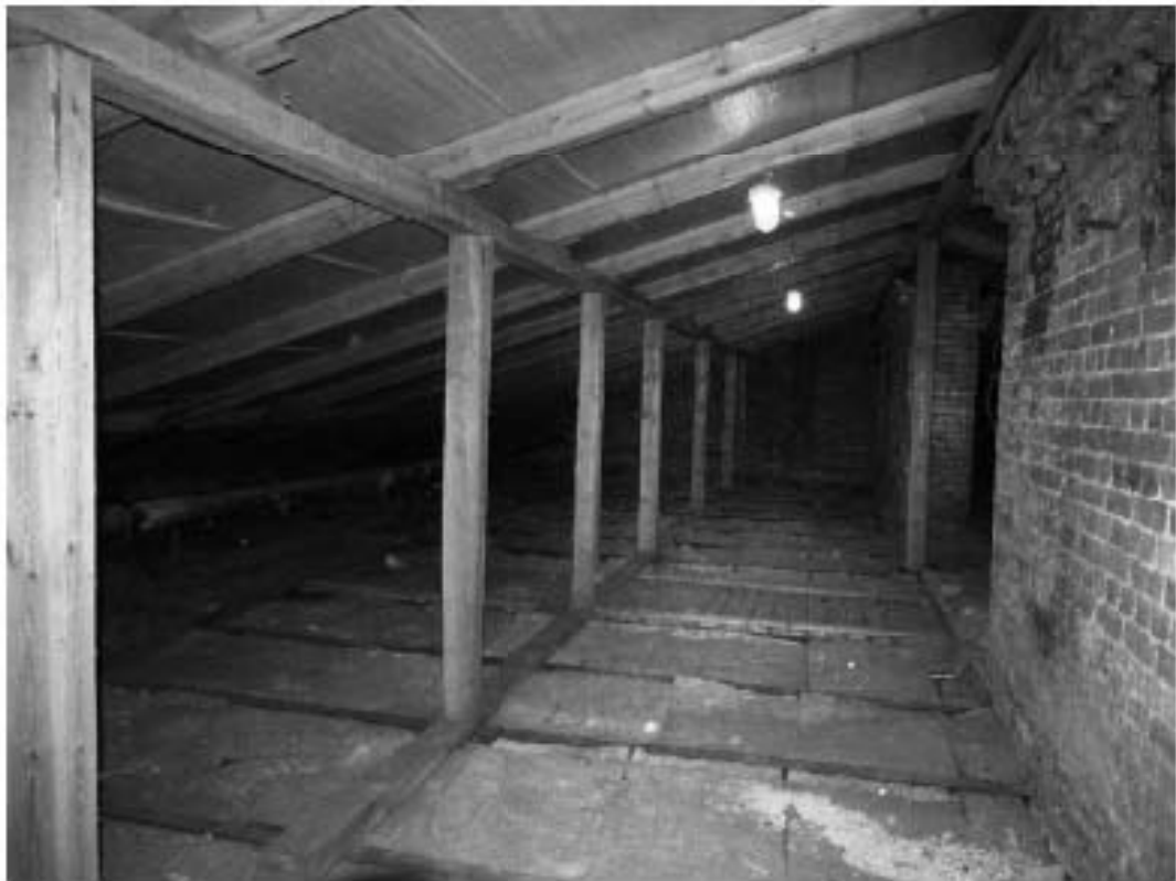
Фото 5.6.2. Общий вид чердака здания
