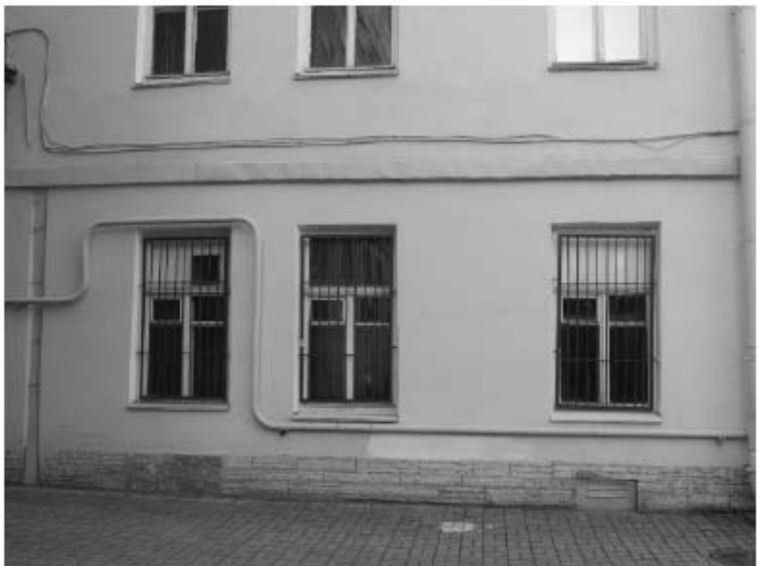
Фото. 5.2.2. Стена во внутреннем дворе здания
