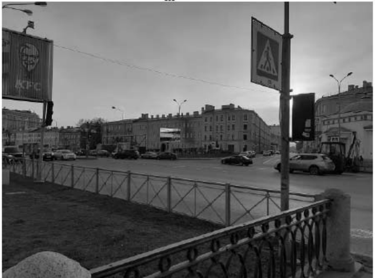
Рисунок 5.2 - Вид на реконструируемое здание с Синопской набережной
