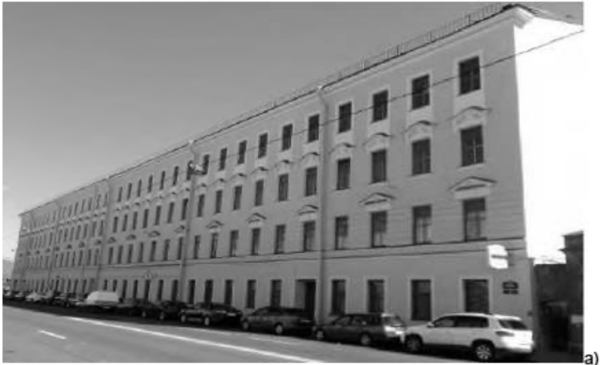
Фасад здания в осях Г/1-22
