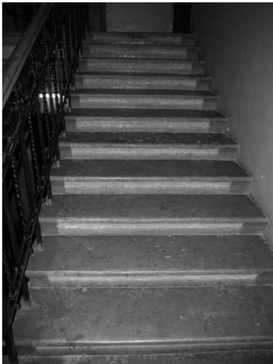
Фото 5.4.2. Фотофиксация лестницы в осях «А-Б/3-5».
