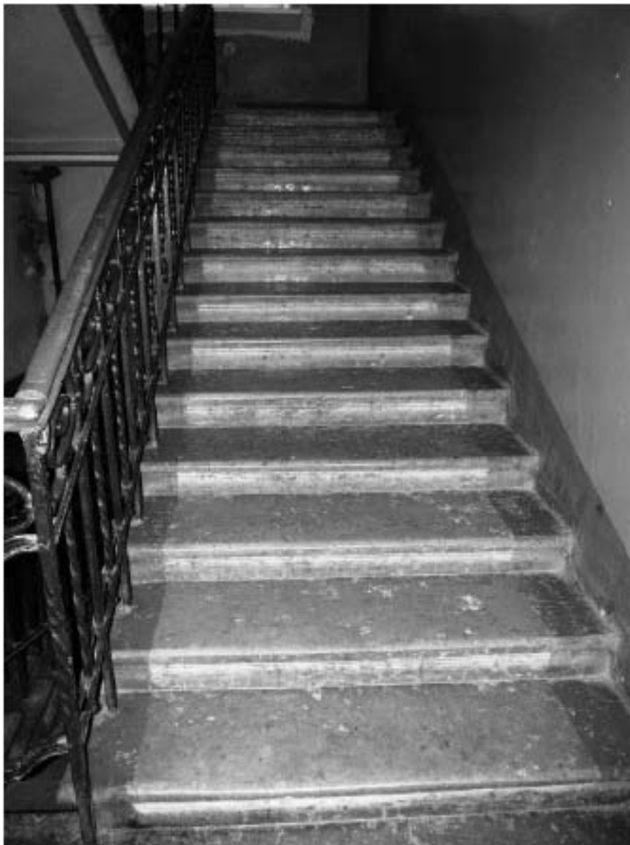
Фото 5.4.4. Фотофиксация лестницы «А-Б/10-12».
