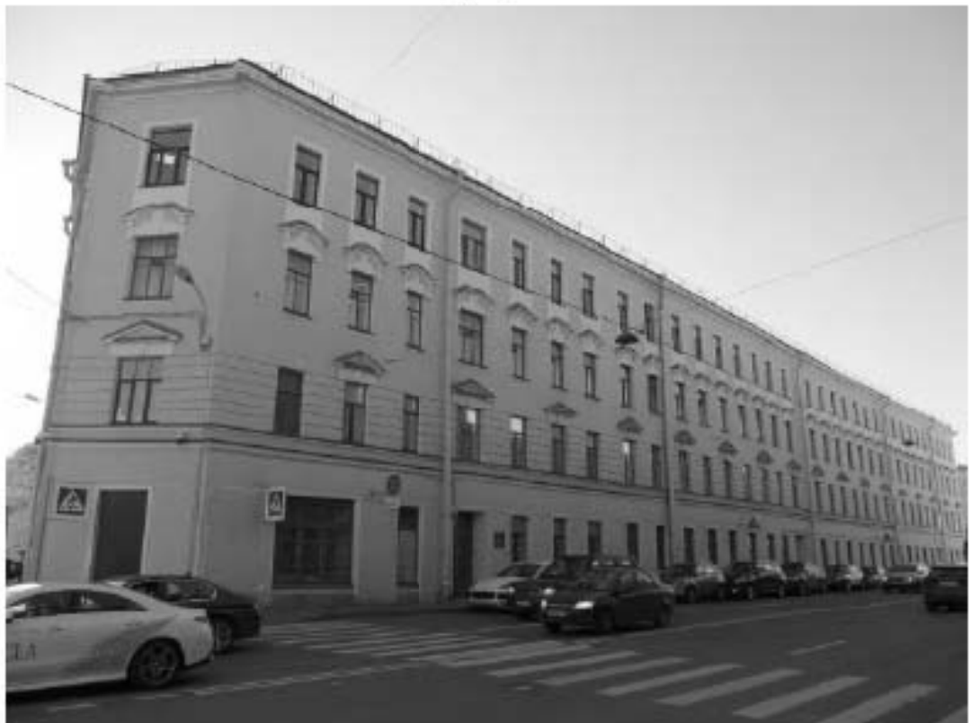
Фото 4.1. Общий вид здания (фасад со стороны пр. Бакунина)
