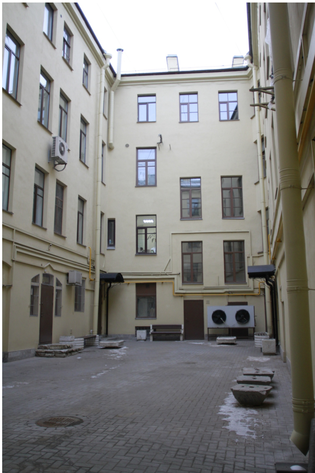
8. «Дом И.Д. Черткова». Санкт-Петербург, ул. Гороховая, д.24/24, литера А. Западный дворовый фасад. Фото: 15.11.2020.
