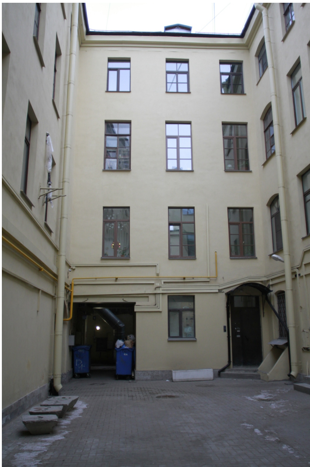
11. «Дом И.Д. Черткова». Санкт-Петербург, ул. Гороховая, д.24/24, литера А. Восточный дворовый фасад. Фото: 15.11.2020.
