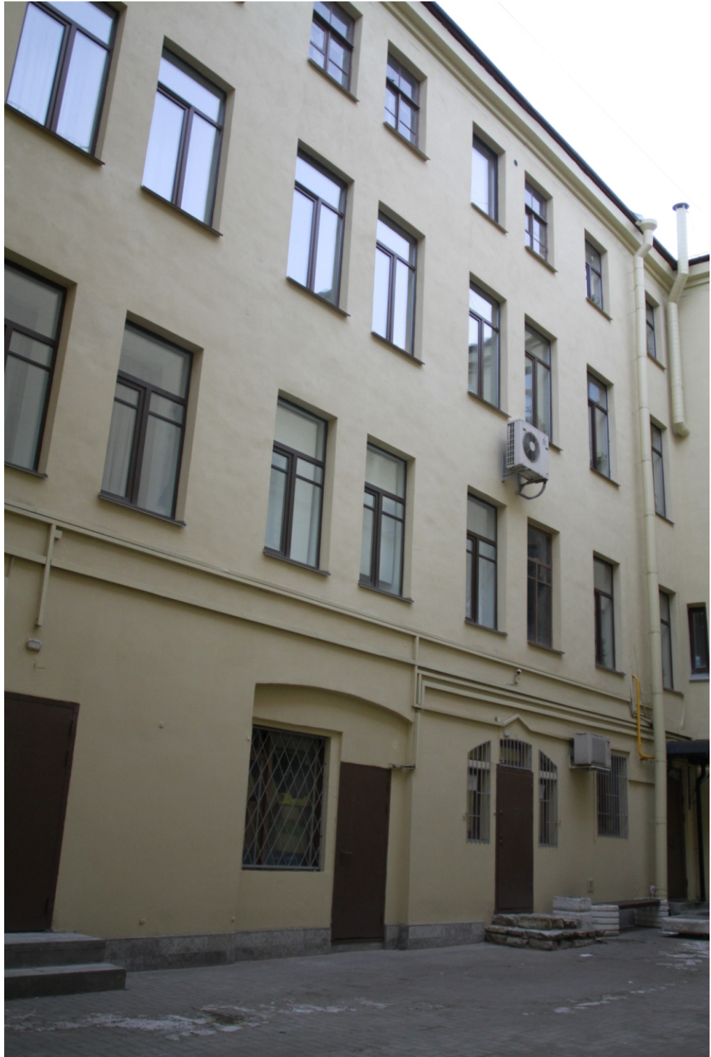
7. «Дом И.Д. Черткова». Санкт-Петербург, ул. Гороховая, д.24/24, литера А. Южный дворовый фасад. Фрагмент. Фото: 15.11.2020.
