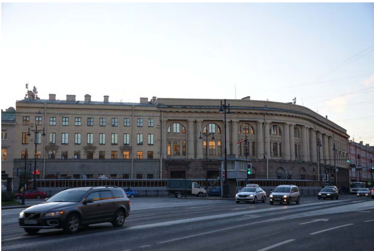
1. Общий вид объекта культурного наследия регионального значения «Станция метро "Технологический институт" (с перронным залом)»
