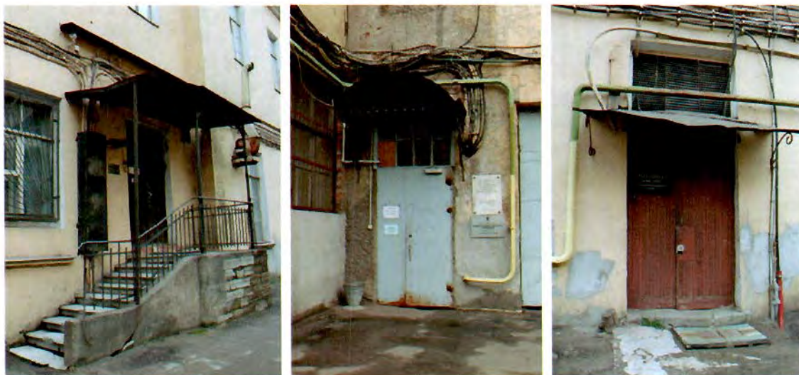
Фото №39, 40, 41. Литера А 3-4. Входные группы.
