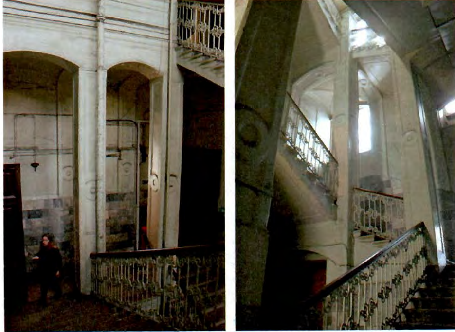
Фото №27, 28. Литера А1. Пом. 35Н(V), Л-5.
