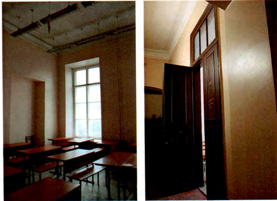
Фото №29, 30. Литера А1. Учебное помещение и дверной проем.
