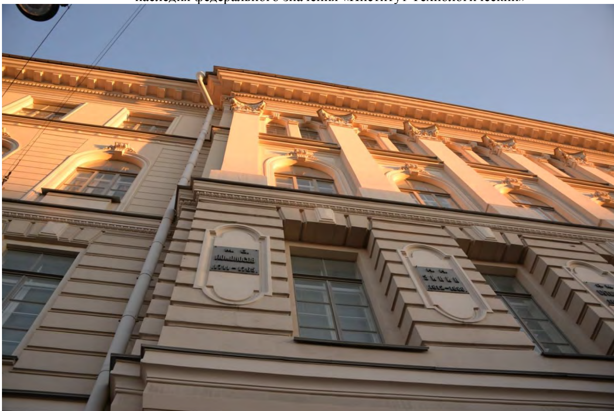
8. Фрагмент фасада, выходящего на Технологическую площадь, объекта культурного наследия федерального значения «Институт Технологический»
