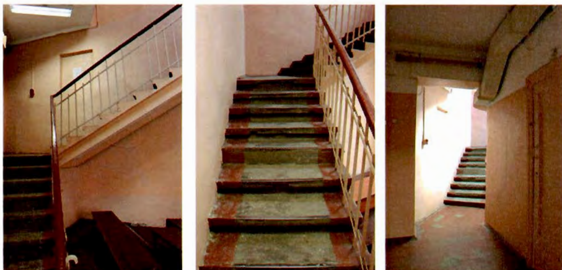
Фото №55, 56, 57. Литера А1. Служебные лестничные клетки.
