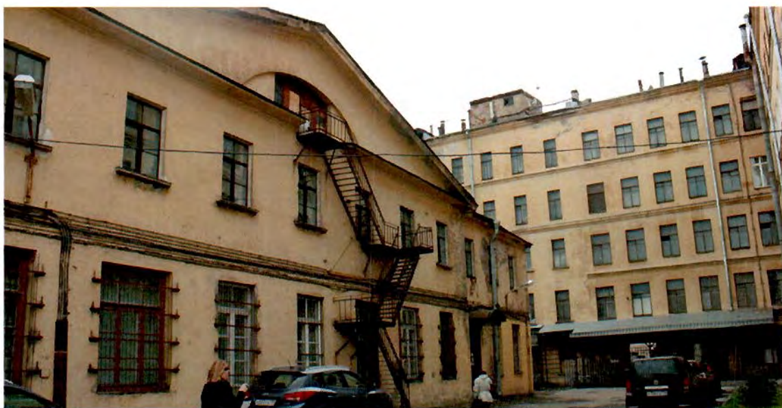
Фото №44. Внутренний двор. Северный фасад Литеры А 3-4 и восточный фасад Литеры А6.
