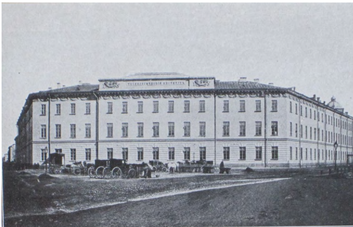
Технологический институт (до перестройки).
