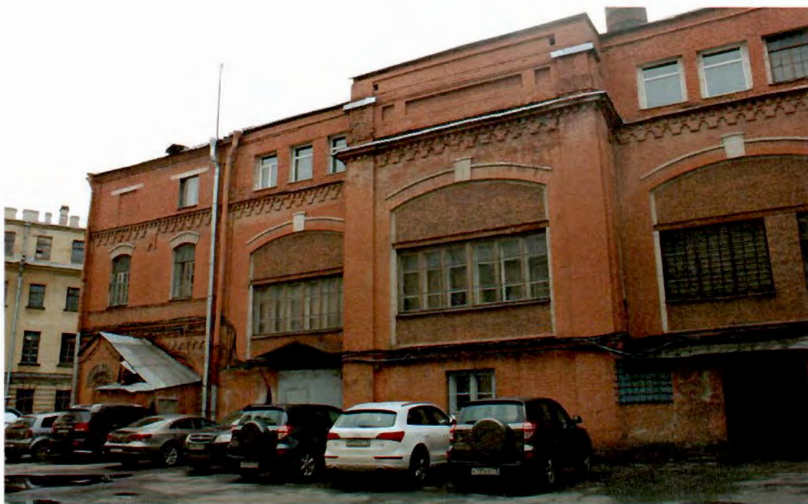
Фото №51. Внутренний двор. Северо-восточный фасад Литеры А 5.
