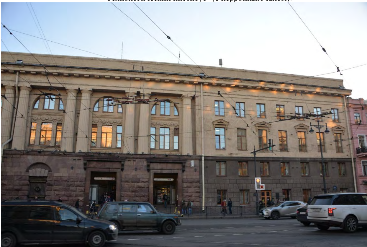
4. Фрагмент фасада объекта культурного наследия регионального значения «Станция метро "Технологический институт" (с перронным залом)»
