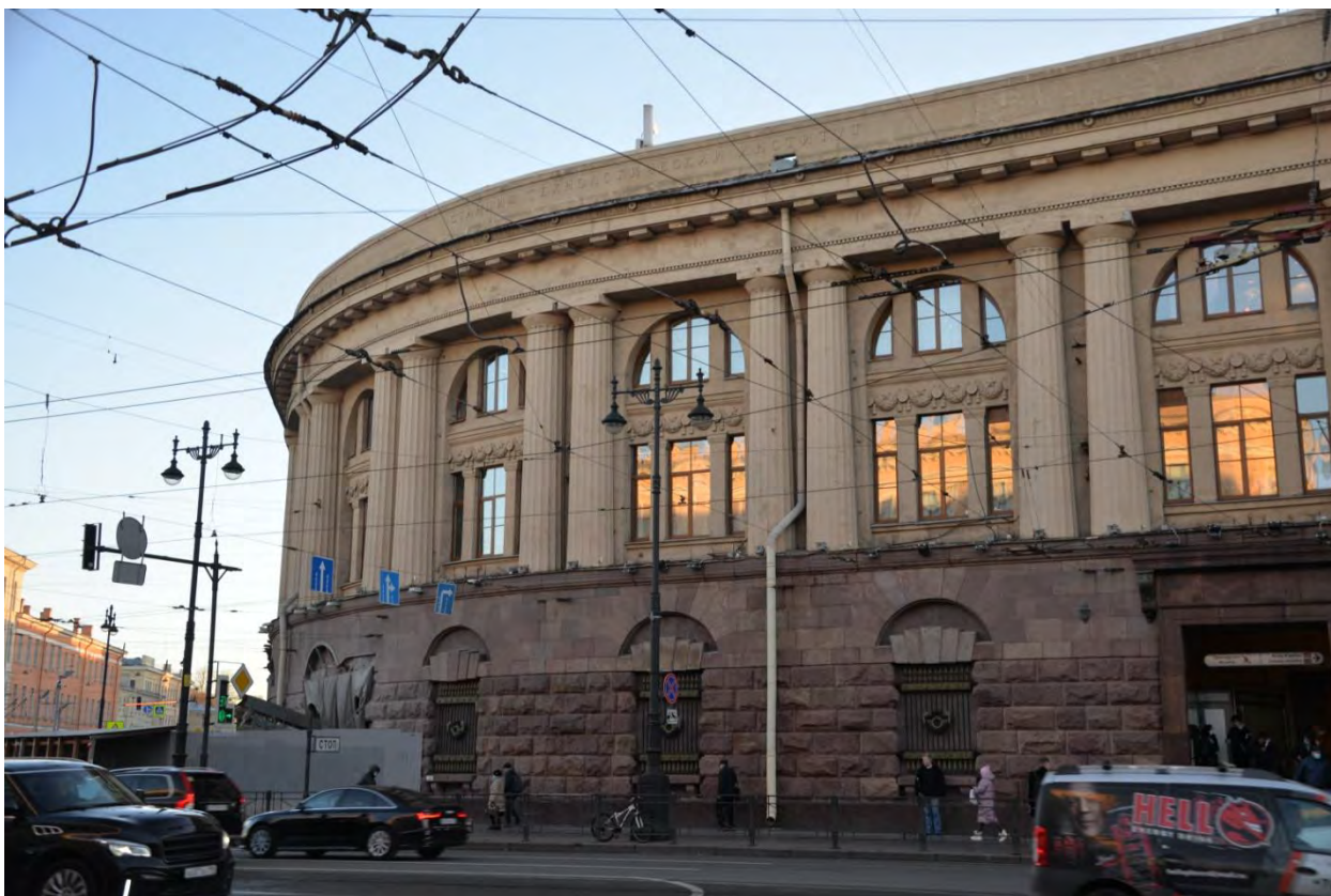
5. Фрагмент фасада объекта культурного наследия регионального значения «Станция метро "Технологический институт" (с перронным залом)»
