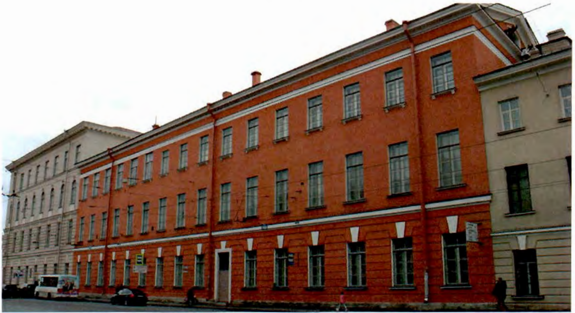
Фото №3. Лицевой фасад трехэтажного корпуса Литеры А1 по Загородному пр.
