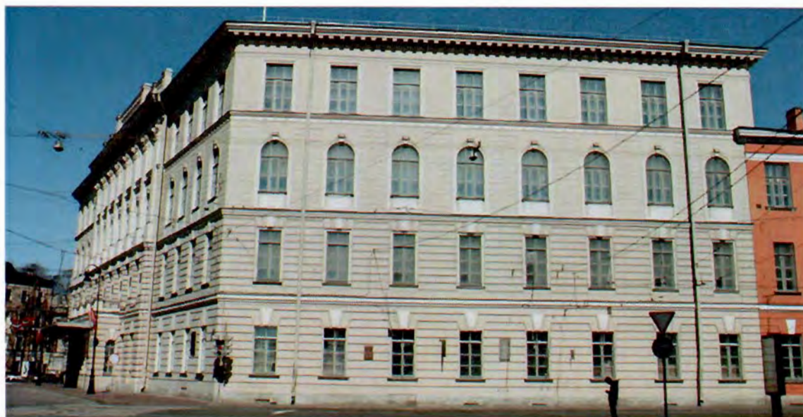
Фото №2. Лицевой фасад четырехэтажного корпуса Литеры А1 по Загородному пр.
