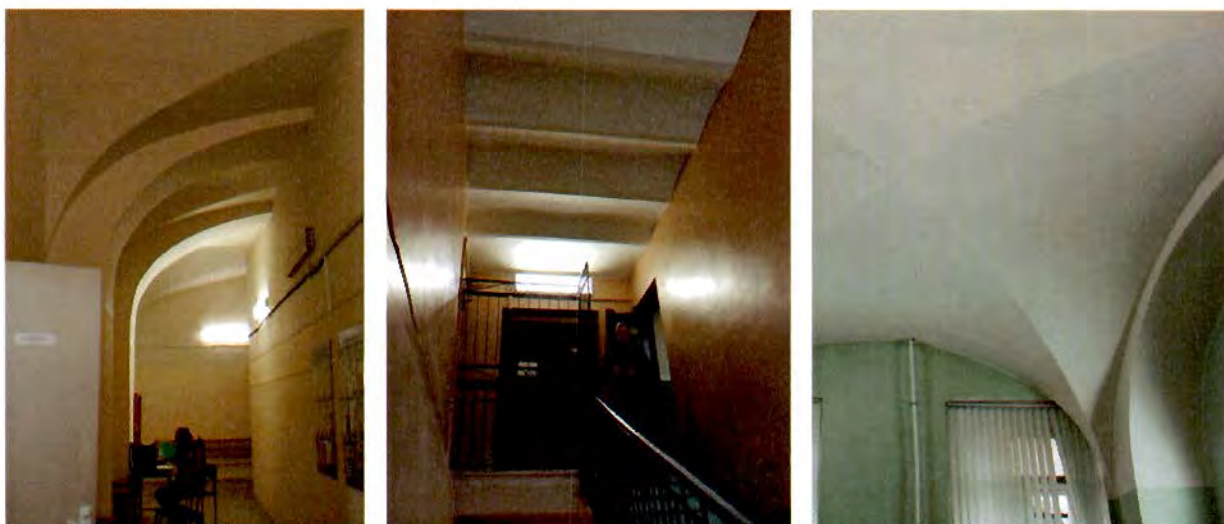
Фото №45, 46, 47. Литера А3-4. Межэтажные сводчатые перекрытия.
