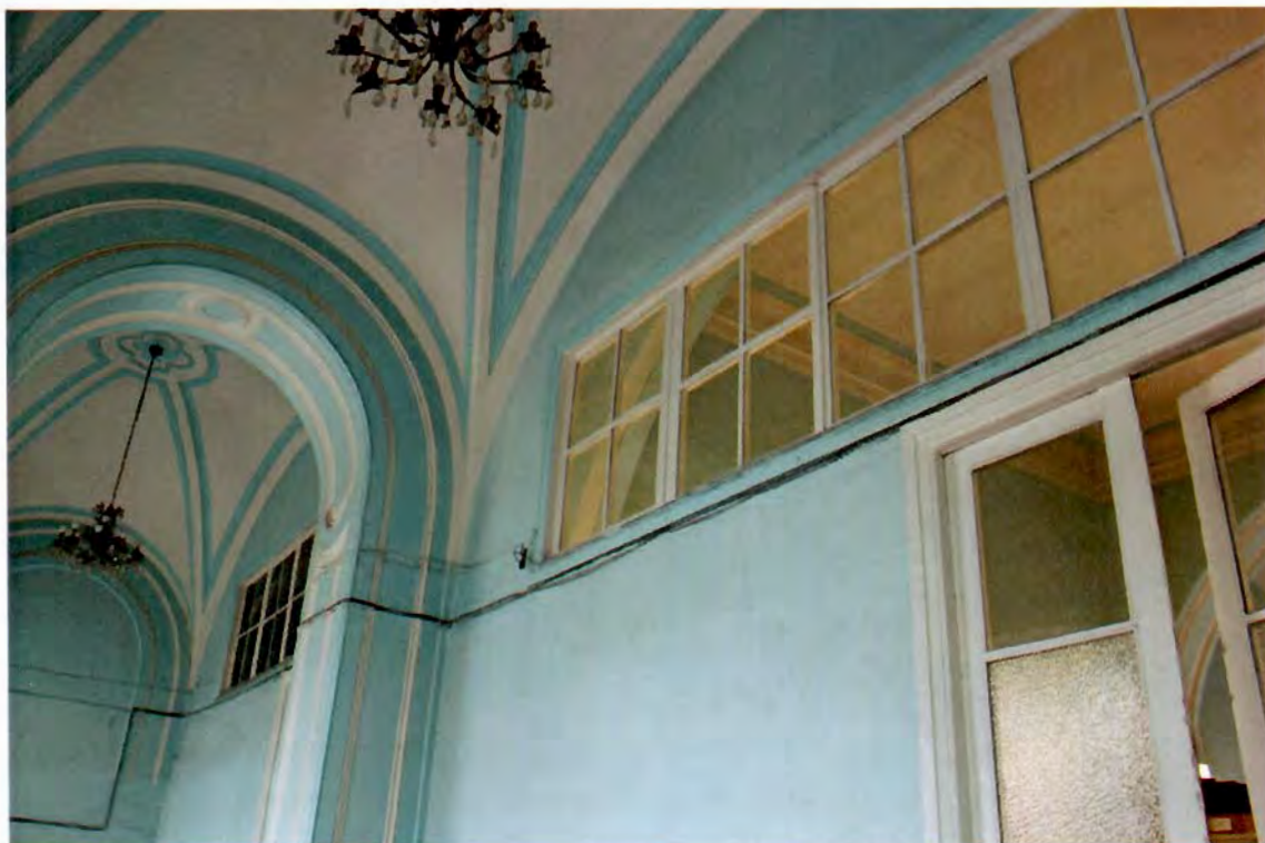
Фото №23. Литера А1. Пом. 35Н(4,7,9,10,11).
