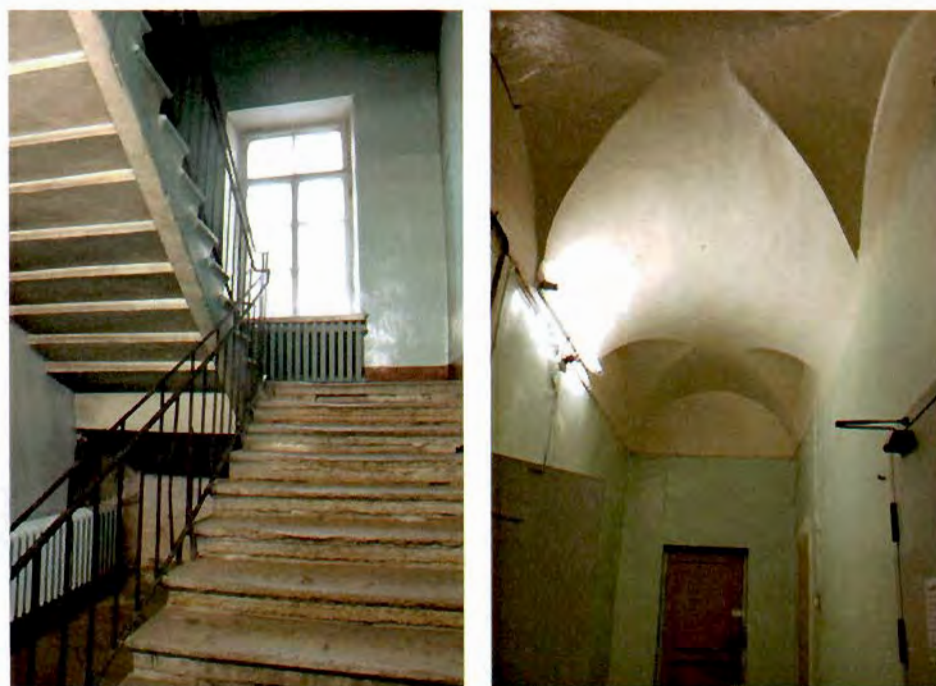
Фото №35, 36. Литера А2. Службная лестничная клетка и межэтажное сводчатое перекрытие.
