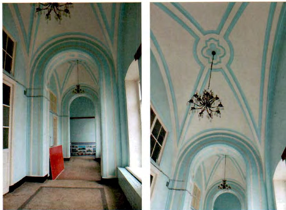
Фото №24, 25. Литера А1. Пом. 35Н(4,7,9,10,11).
