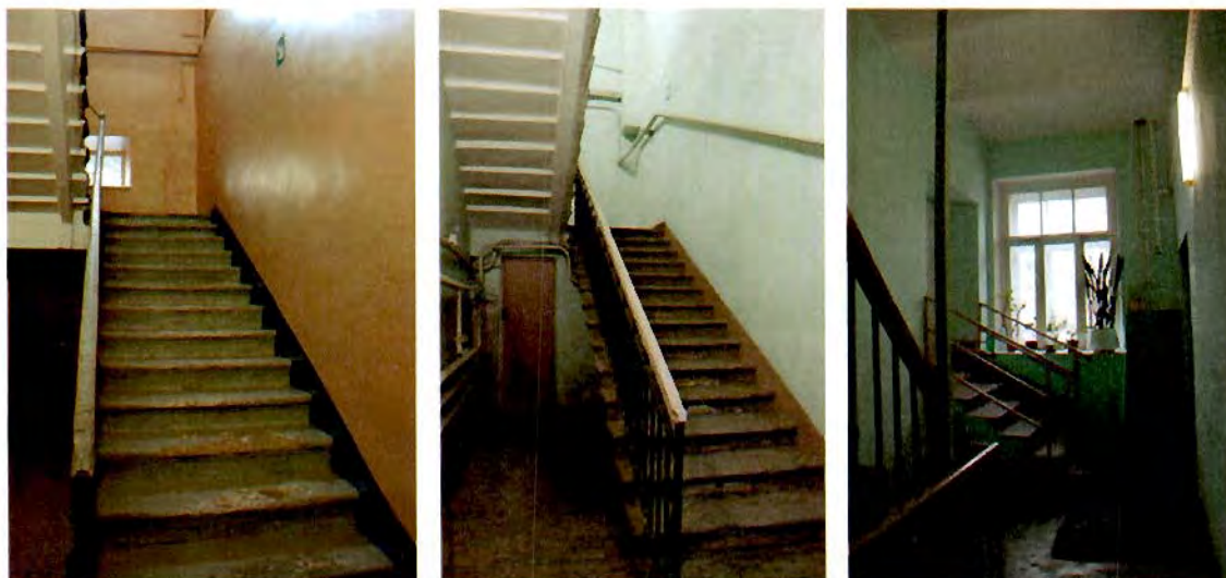
Фото №48, 49, 50. Литера А3-4. Служебные лестничные клетки.
