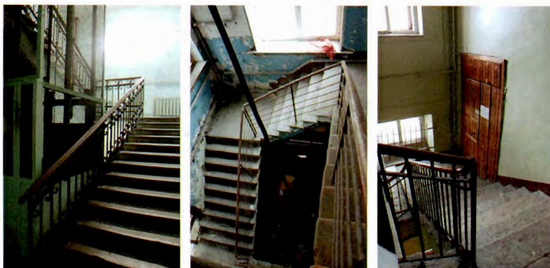
Фото №8, 9, 10. Литера А6. Служебные лестничные клетки.
