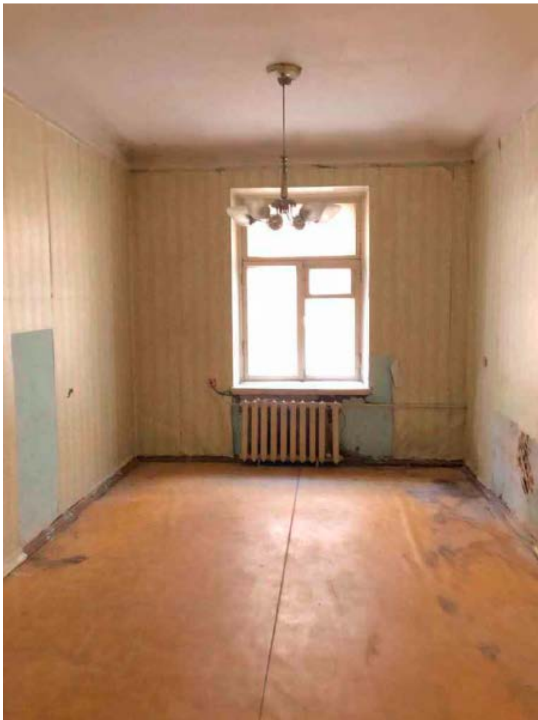
9. Помещение №17 кв. №11 в уровне 1-го этажа объекта культурного наследия регионального значения «Дом кн. Л.Д. Вяземского», расположенного по адресу: г. Санкт-Петербург, Галерная ул., д. 67, литера А. 15.12.2021.
