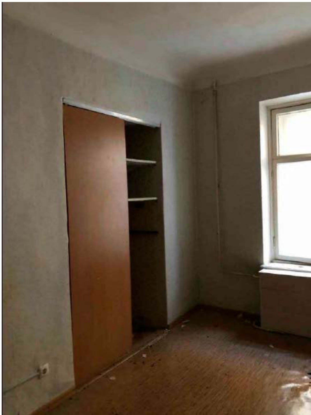
8. Помещение №10 кв. №11 в уровне 1-го этажа объекта культурного наследия регионального значения «Дом кн. Л.Д. Вяземского», расположенного по адресу: г. Санкт-Петербург, Галерная ул., д. 67, литера А. 15.12.2021.
