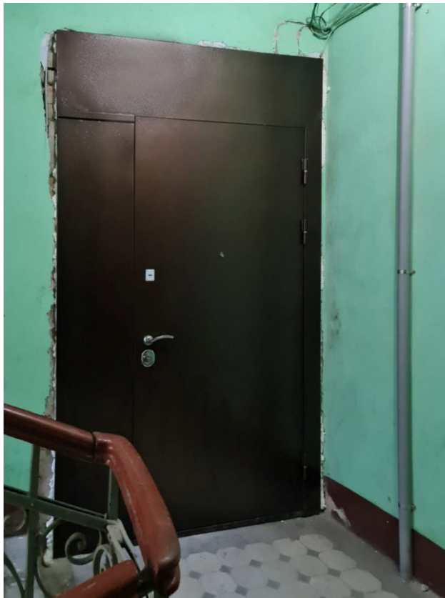
3. Выявленный объект культурного наследия «Дом М.Д. Усова» по адресу: г. Санкт-Петербург, ул. Смоленская, д. 1, лит. Д. Вход в квартиру 9.
