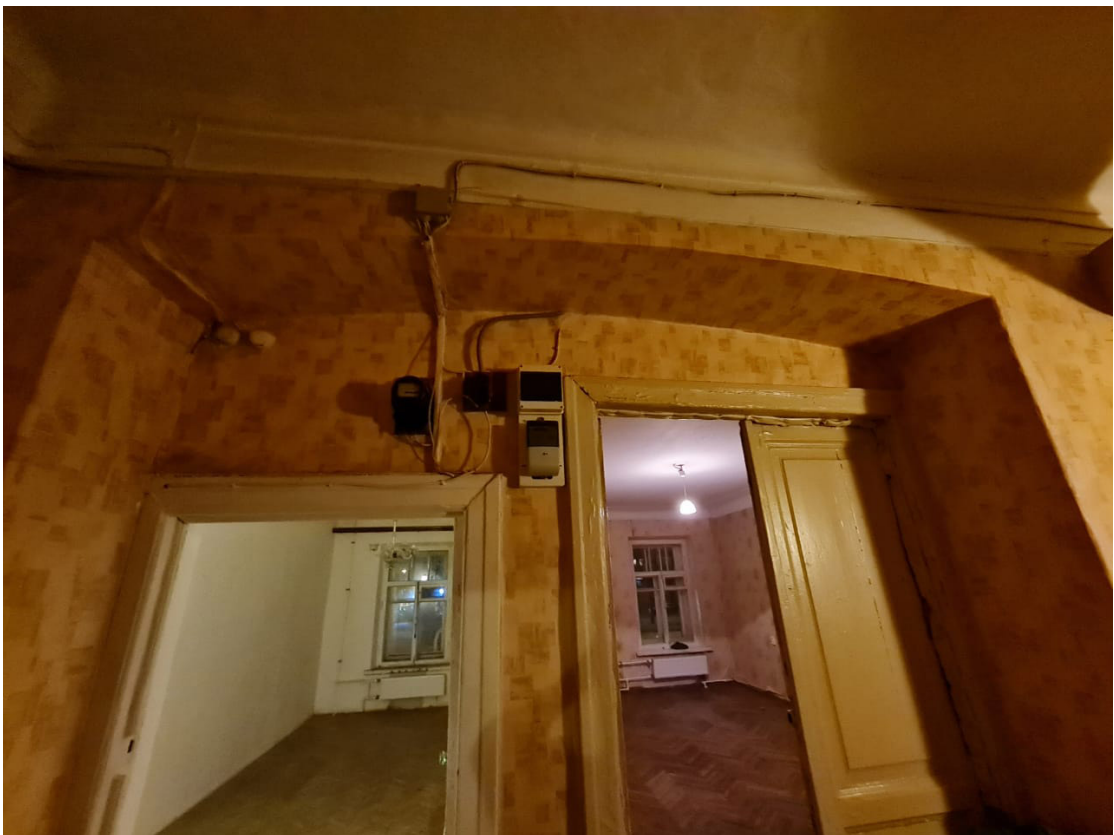
12. Выявленный объект культурного наследия «Дом М.Д. Усова» по адресу: г. Санкт-Петербург, ул. Смоленская, д. 1, лит. Д. Квартира 9 (коридор)
