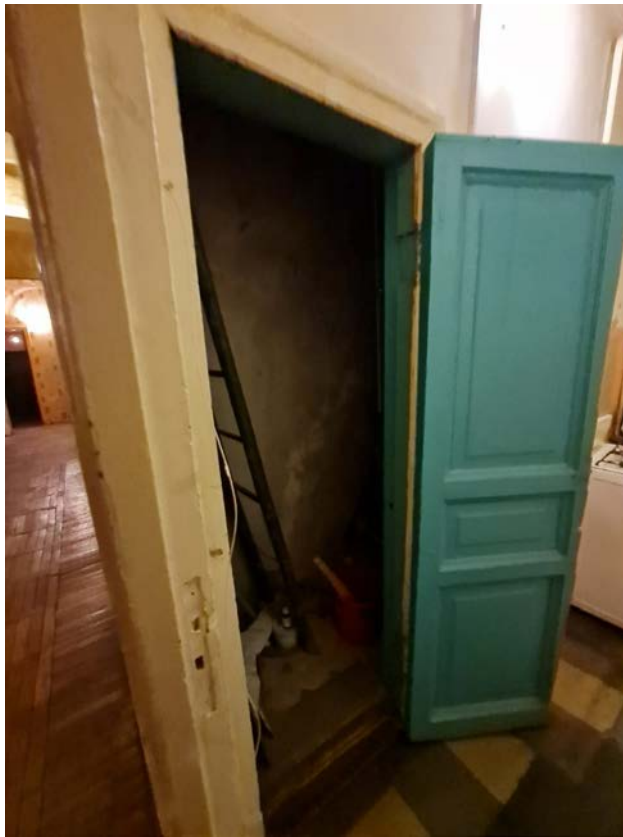
9. Выявленный объект культурного наследия «Дом М.Д. Усова» по адресу: г. Санкт-Петербург, ул. Смоленская, д. 1, лит. Д. Квартира 9 (помещение 13)
