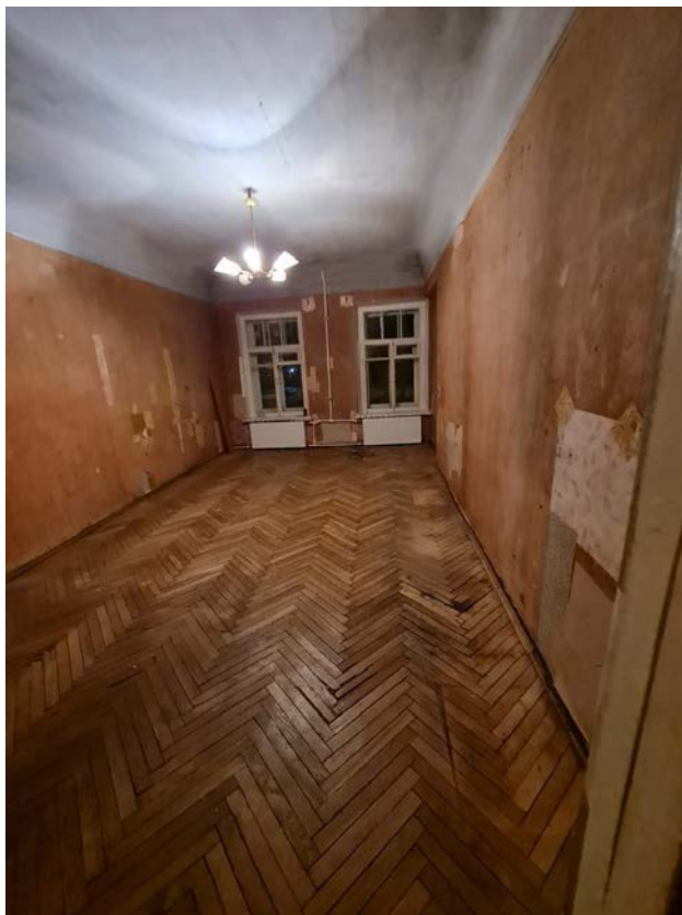
16. Выявленный объект культурного наследия «Дом М.Д. Усова» по адресу: г. Санкт-Петербург, ул. Смоленская, д. 1, лит. Д. Квартира 9 (помещение 9/26,7)
