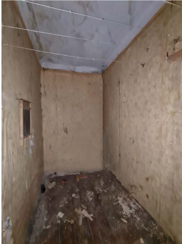
7. Выявленный объект культурного наследия «Дом М.Д. Усова» по адресу: г. Санкт-Петербург, ул. Смоленская, д. 1, лит. Д. Квартира 9 (помещение 4/5,5)
