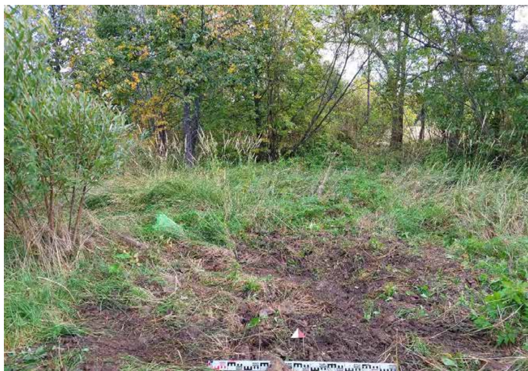
Рис. 391. г. Санкт-Петербург, Курортный район, г. Сестрорецк – 2021 г. Шурф №70. Засыпка. Вид с Ю.
