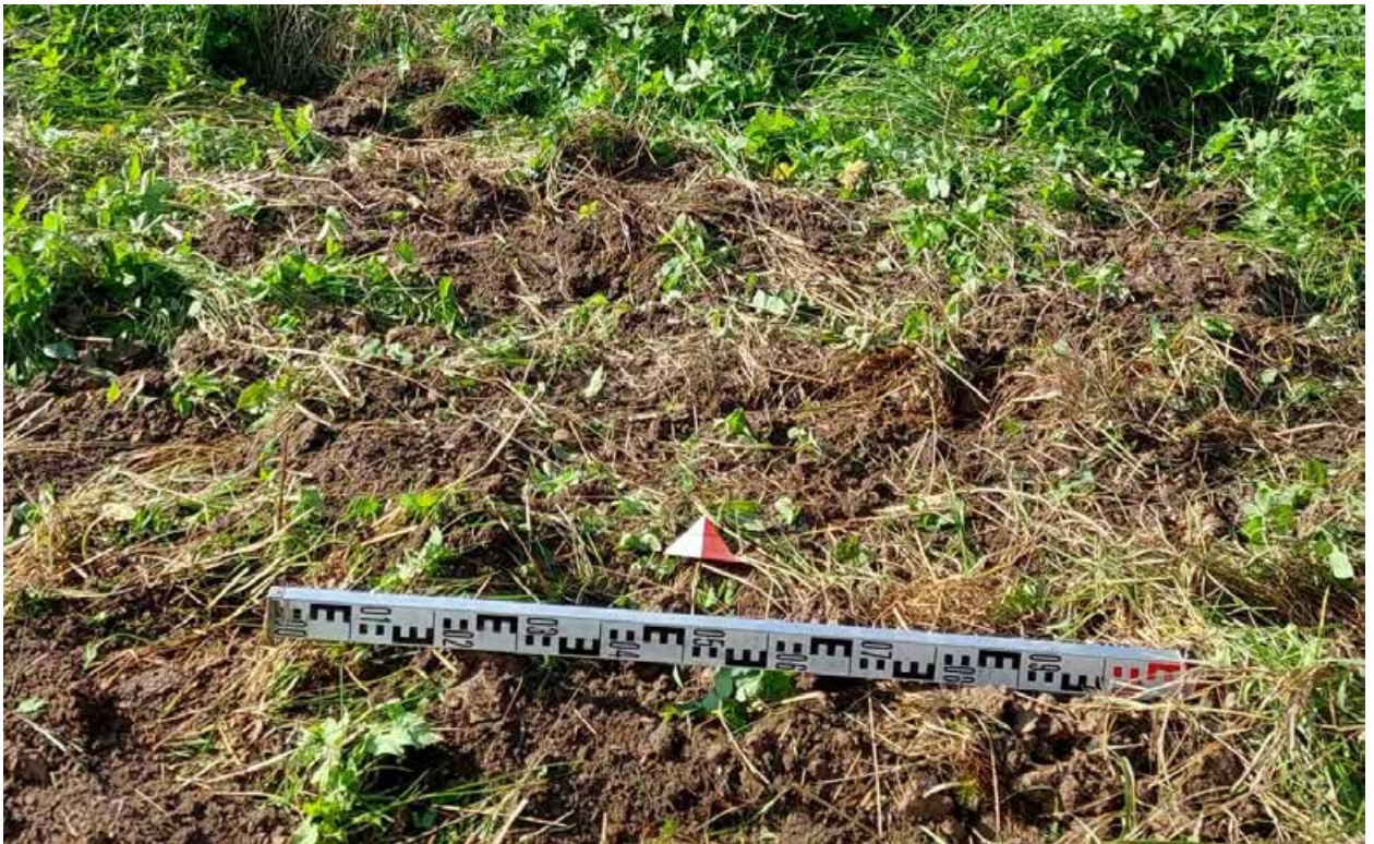
Рис. 88. г. Санкт-Петербург, Курортный район, г. Сестрорецк – 2021 г. Шурф №9. Засыпка. Вид с Ю.
