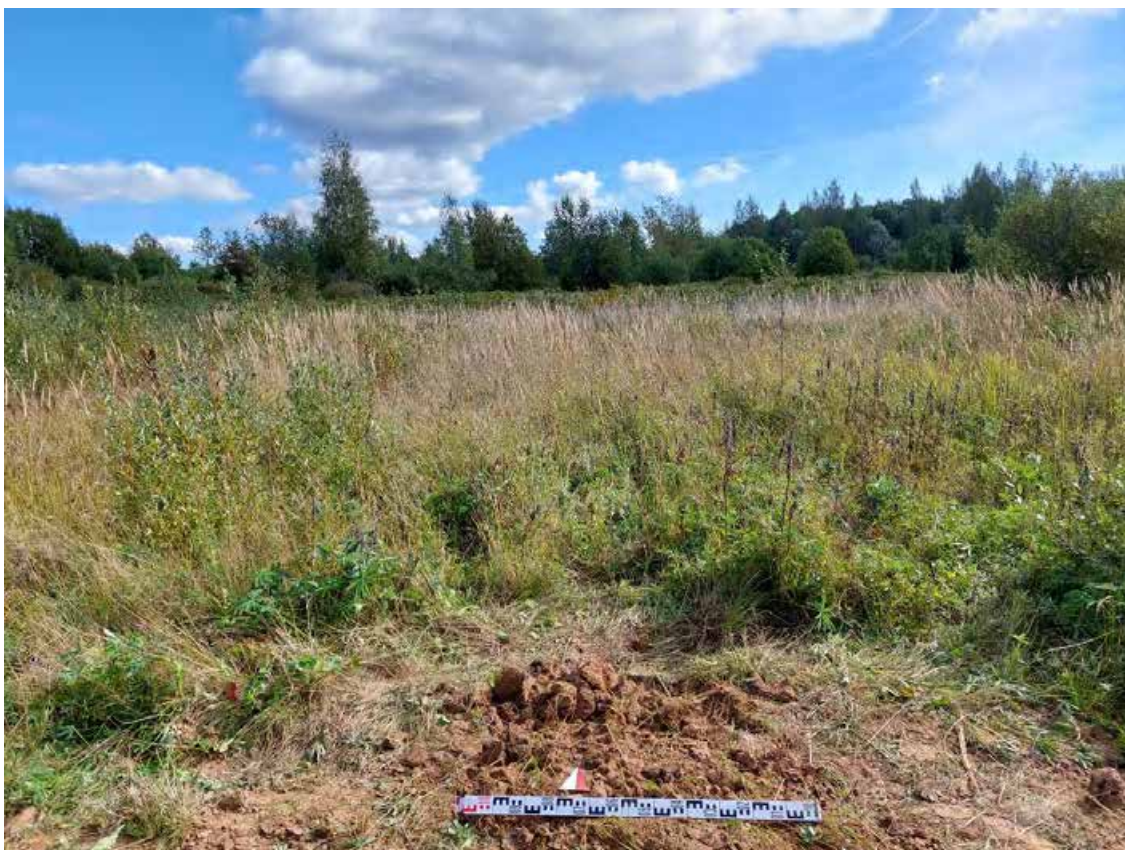
Рис. 138. г. Санкт-Петербург, Курортный район, г. Сестрорецк – 2021 г. Шурф №19. Засыпка. Вид с Ю.
