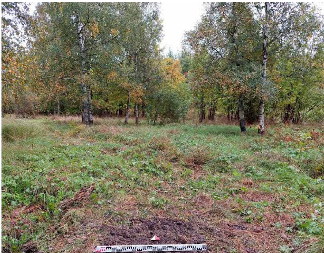
Рис. 222. г. Санкт-Петербург, Курортный район, г. Сестрорецк – 2021 г. Шурф №36. Засыпка. Вид с Ю.
