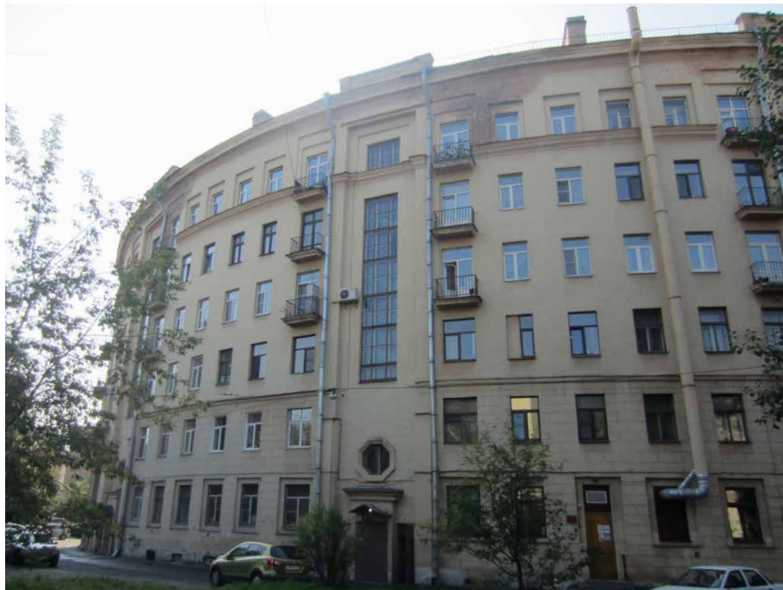
10. Объект культурного наследия регионального значения «Комплекс жилых домов (6 зданий)», расположенный по адресу: Санкт-Петербург, Красногвардейский район, Малоохтинский пр., 86, лит. А Фрагмент дворового фасада с востока Съемка: 12 сентября 2019г.
