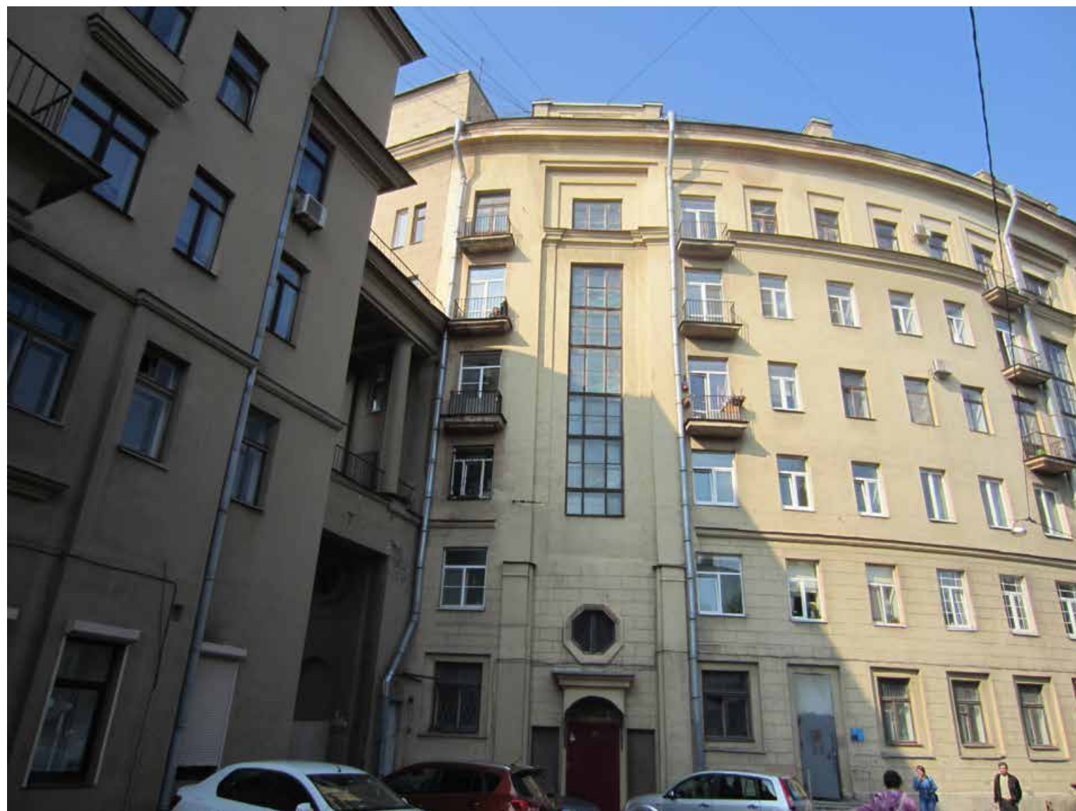
15. Объект культурного наследия регионального значения «Комплекс жилых домов (6 зданий)», расположенный по адресу: Санкт-Петербург, Красногвардейский район, Малоохтинский пр., 86, лит. А Фрагмент дворового фасада. Южная пристройка к основному объему здания Съемка: 12 сентября 2019г.
