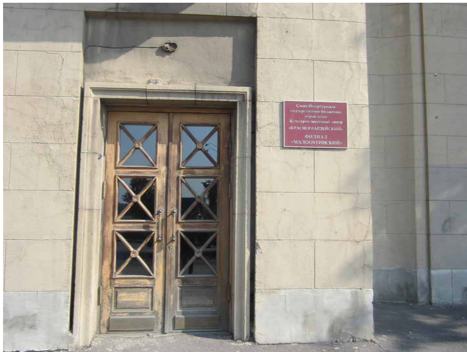
7. Объект культурного наследия регионального значения «Комплекс жилых домов (6 зданий)», расположенный по адресу: Санкт-Петербург, Красногвардейский район, м. Фрагмент лицевого фасада. Оформление дверного проема Съемка: 12 сентября 2019г.
