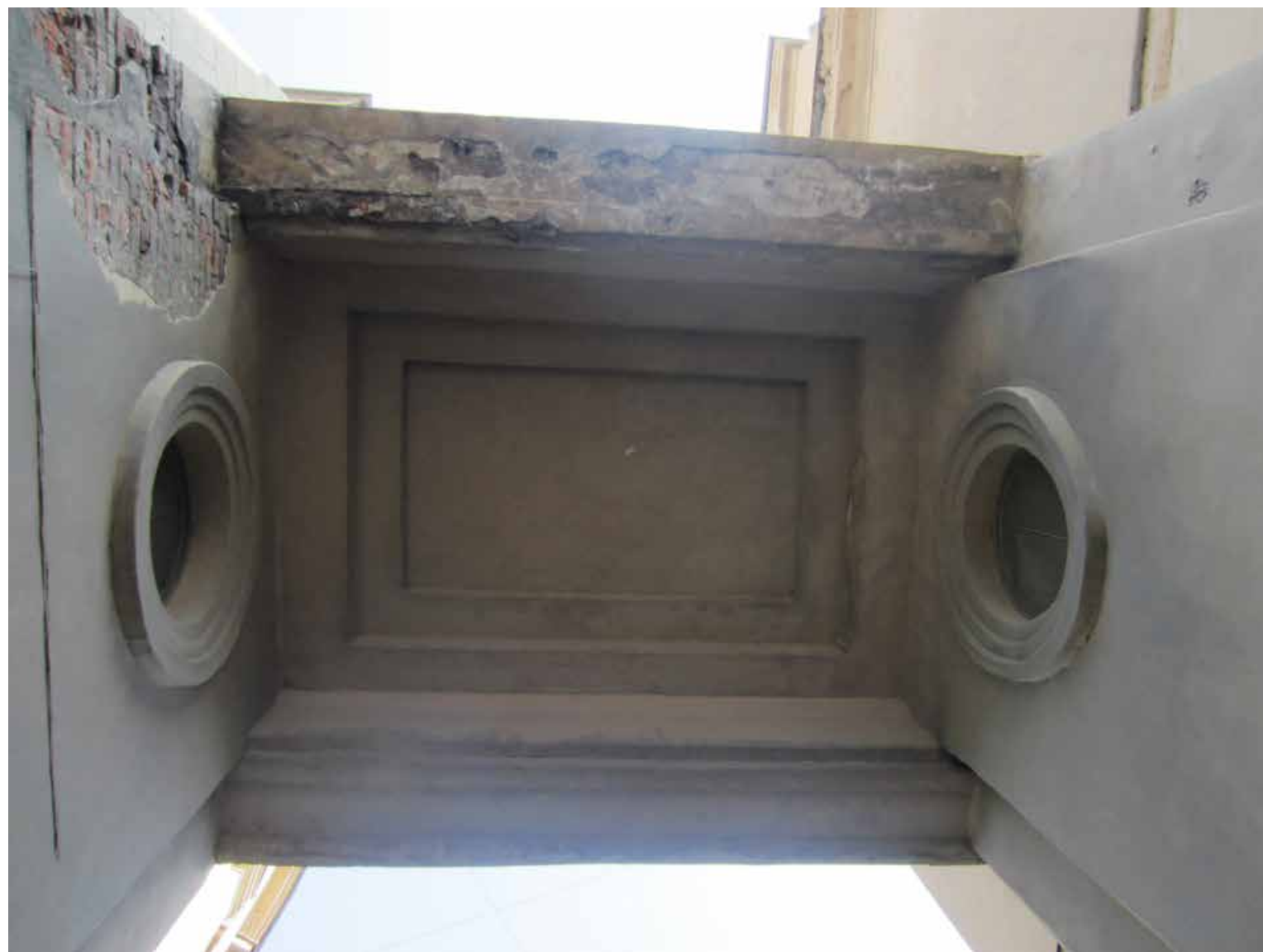
25. Объект культурного наследия регионального значения «Комплекс жилых домов (6 зданий)», расположенный по адресу: Санкт-Петербург, Красногвардейский район, Малоохтинский пр., 86, лит. А Круглые оконные проемы в стенах арочного проезда южной пристройки Съемка: 12 сентября 2019г.
