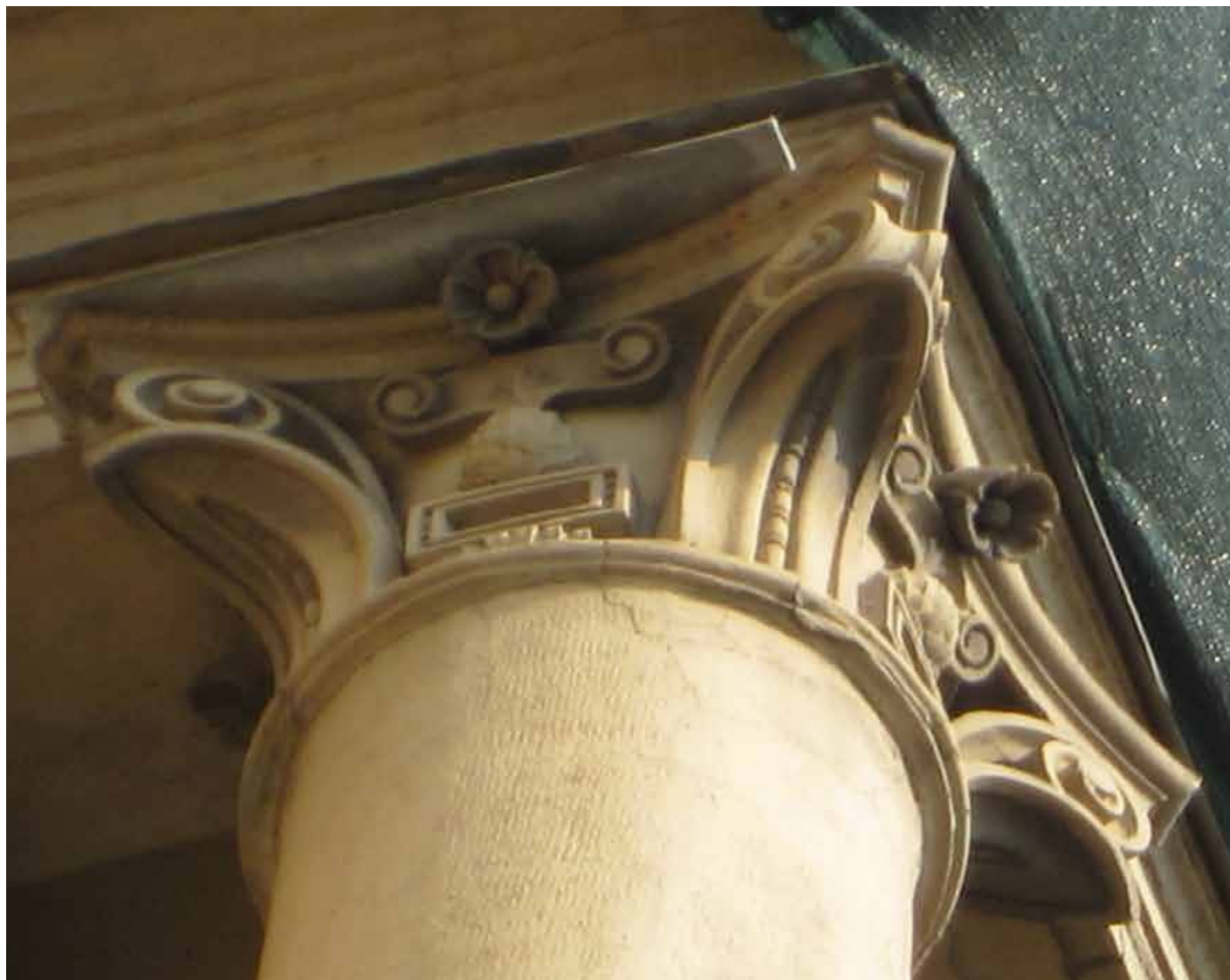
34. Объект культурного наследия регионального значения «Комплекс жилых домов (6 зданий)», расположенный по адресу: Санкт-Петербург, Красногвардейский район, Малоохтинский пр., 86, лит. А Фрагмент фасада. Стилизованная дорическая колонна в эркере на уровне 6 этажа Съемка: 14 декабря 2020 г.
