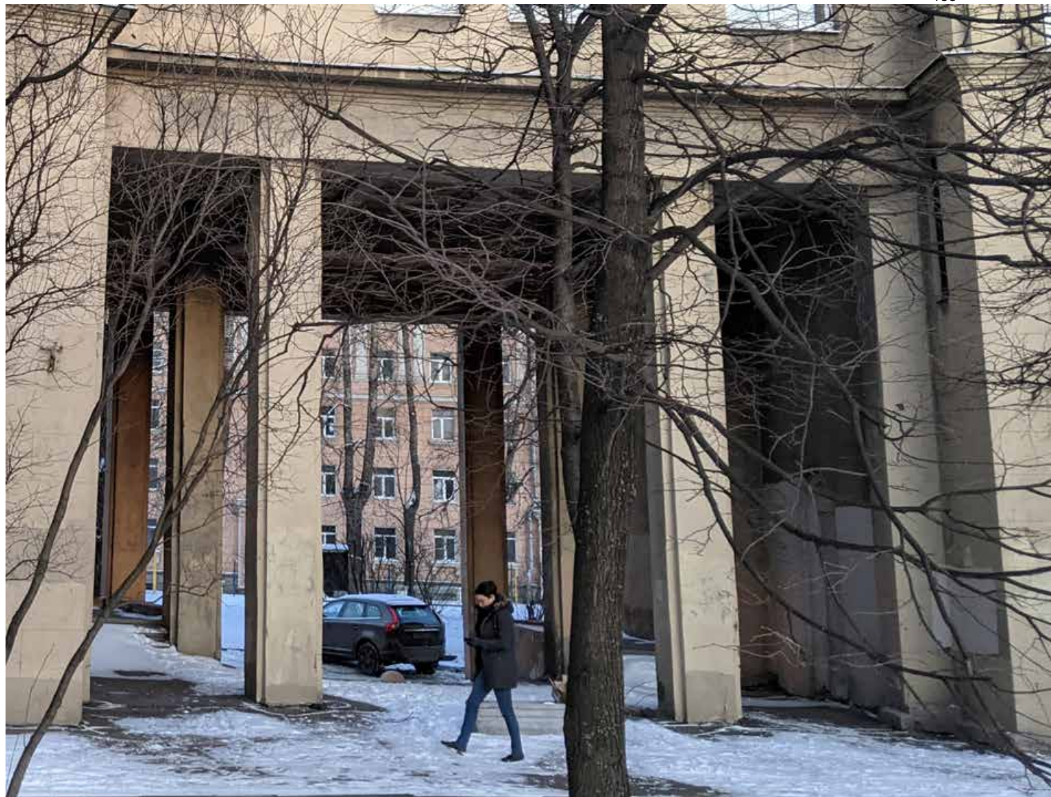
45. Объект культурного наследия регионального значения «Комплекс жилых домов (6 зданий)», расположенный по адресу: Санкт-Петербург, Красногвардейский район, Малоохтинский пр., 86, лит. А Вид воротного проезда на пилонах с юга Съемка: 14 декабря 2020 г.
