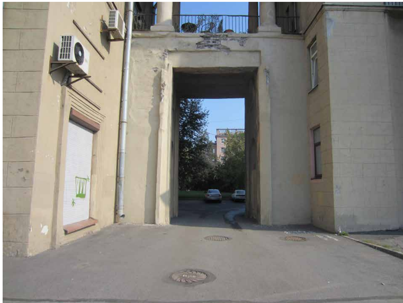
17. Объект культурного наследия регионального значения «Комплекс жилых домов (6 зданий)», расположенный по адресу: Санкт-Петербург, Красногвардейский район, Малоохтинский пр., 86, лит. А Фрагмент северной пристройки здания Съемка: 12 сентября 2019г.
