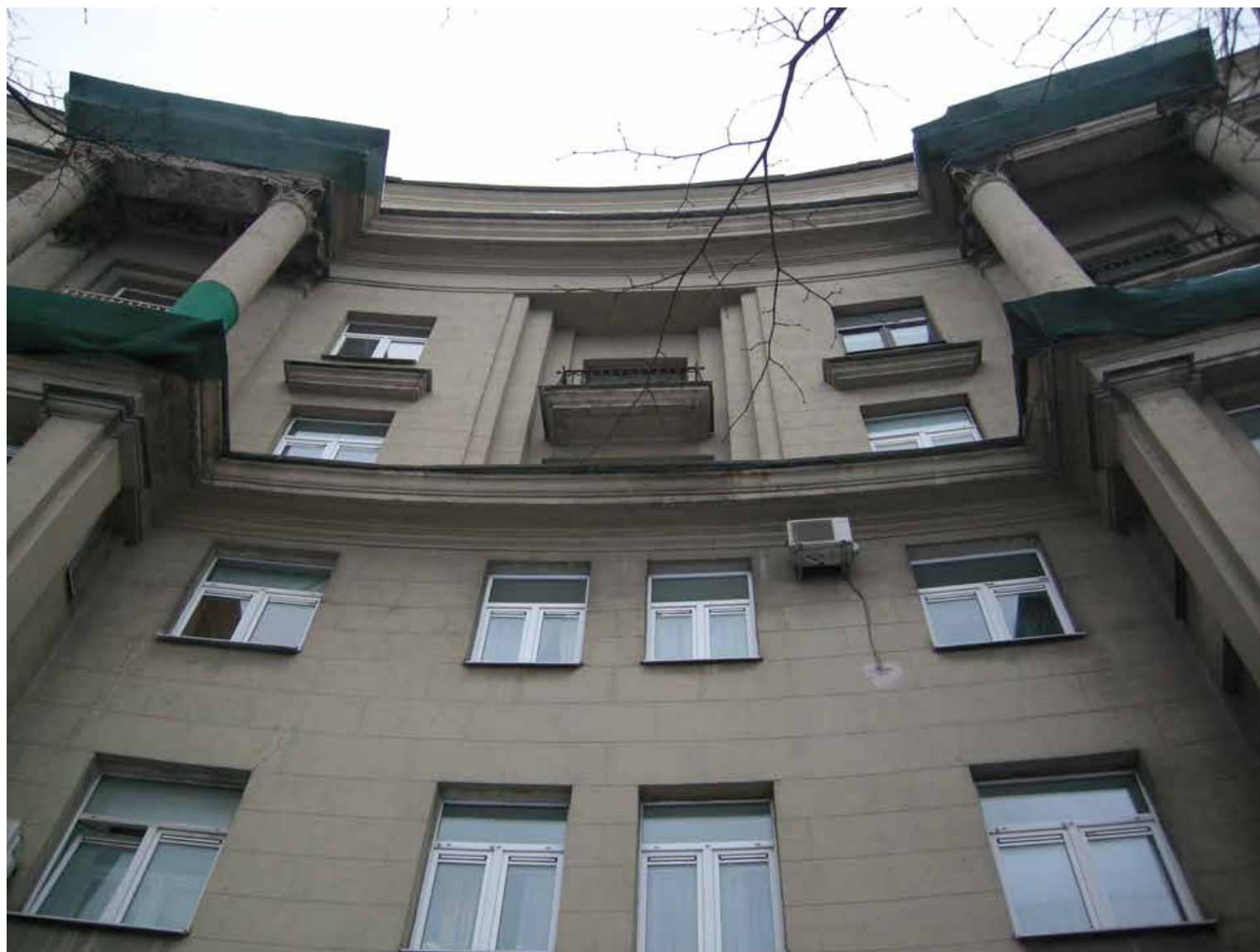
31. Объект культурного наследия регионального значения «Комплекс жилых домов (6 зданий)», расположенный по адресу: Санкт-Петербург, Красногвардейский район, Малоохтинский пр., 86, лит. А Фрагмент лицевого фасада. Заполнение оконных проемов, стилизованные колонны коринфского ордера на уровне 5-6 этажей Съемка: 14 декабря 2020 г.
