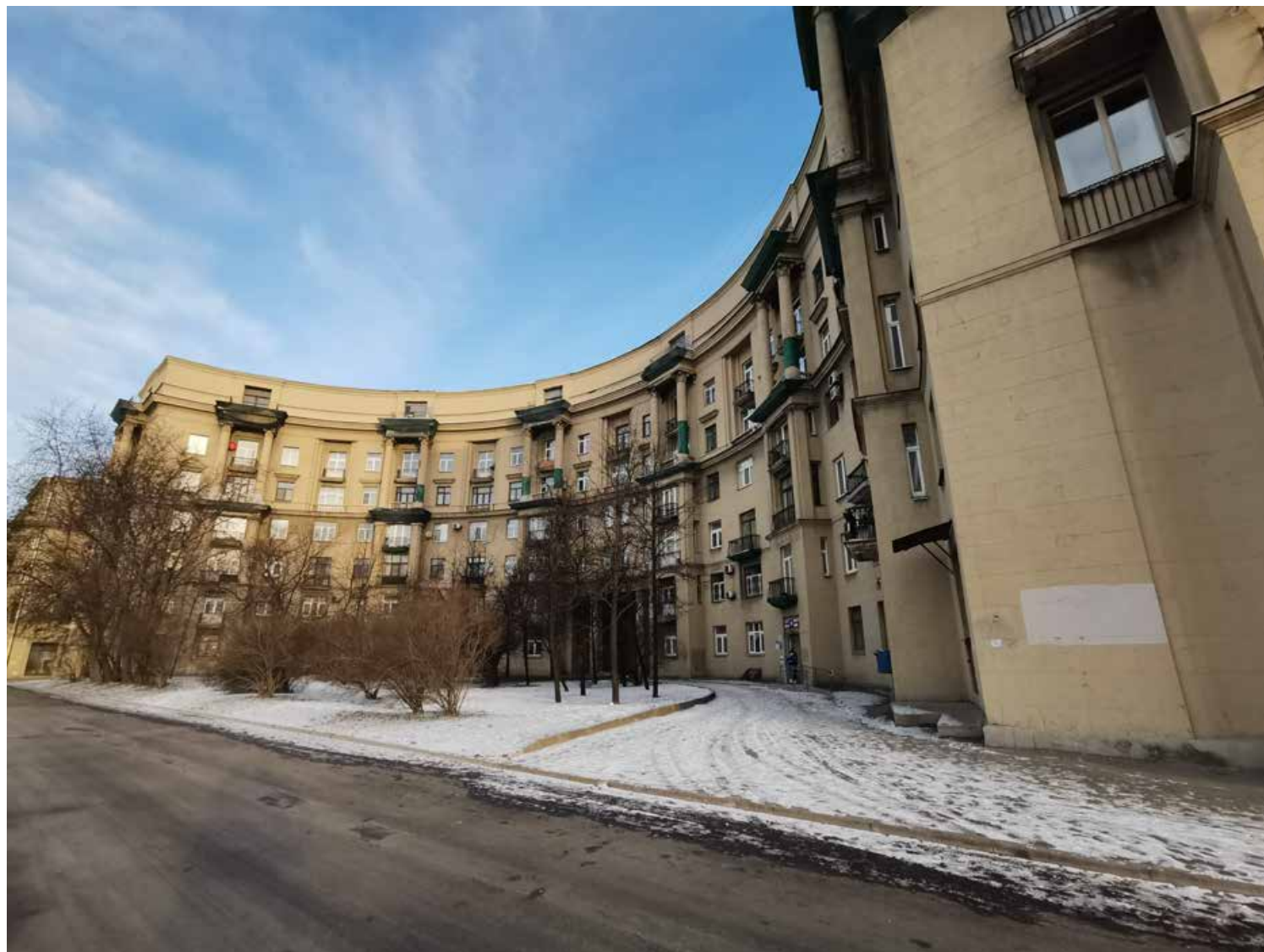
27 Объект культурного наследия регионального значения «Комплекс жилых домов (6 зданий)», расположенный по адресу: Санкт-Петербург, Красногвардейский район, Малоохтинский пр., 86, лит. А Вид лицевого фасада с Малоохтинского проспекта. Эркеры на высоту 1-2 этажей, завершенные 2-х ярусными порталами (с пилонами на уровне 3-4 этажей и колоннами на уровне 5-6 этажей) Съемка: 14 декабря 2020 г. .
