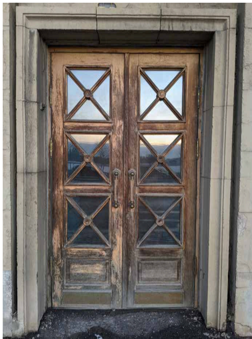
32. Объект культурного наследия регионального значения «Комплекс жилых домов (6 зданий)», расположенный по адресу: Санкт-Петербург, Красногвардейский район, м Фрагмент лицевого фасада. Оформление дверного проема Съемка: 14 декабря 2020 г.
