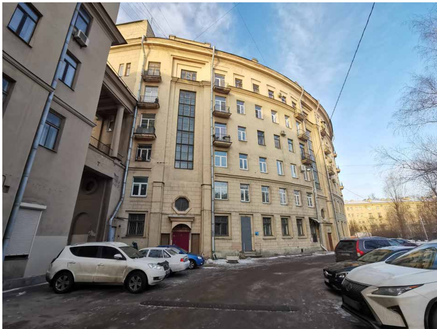
40. Объект культурного наследия регионального значения «Комплекс жилых домов (6 зданий)», расположенный по адресу: Санкт-Петербург, Красногвардейский район, Малоохтинский пр., 86, лит. А Фрагмент дворового фасада. Южная пристройка к основному объему здания Съемка: 14 декабря 2020 г.
