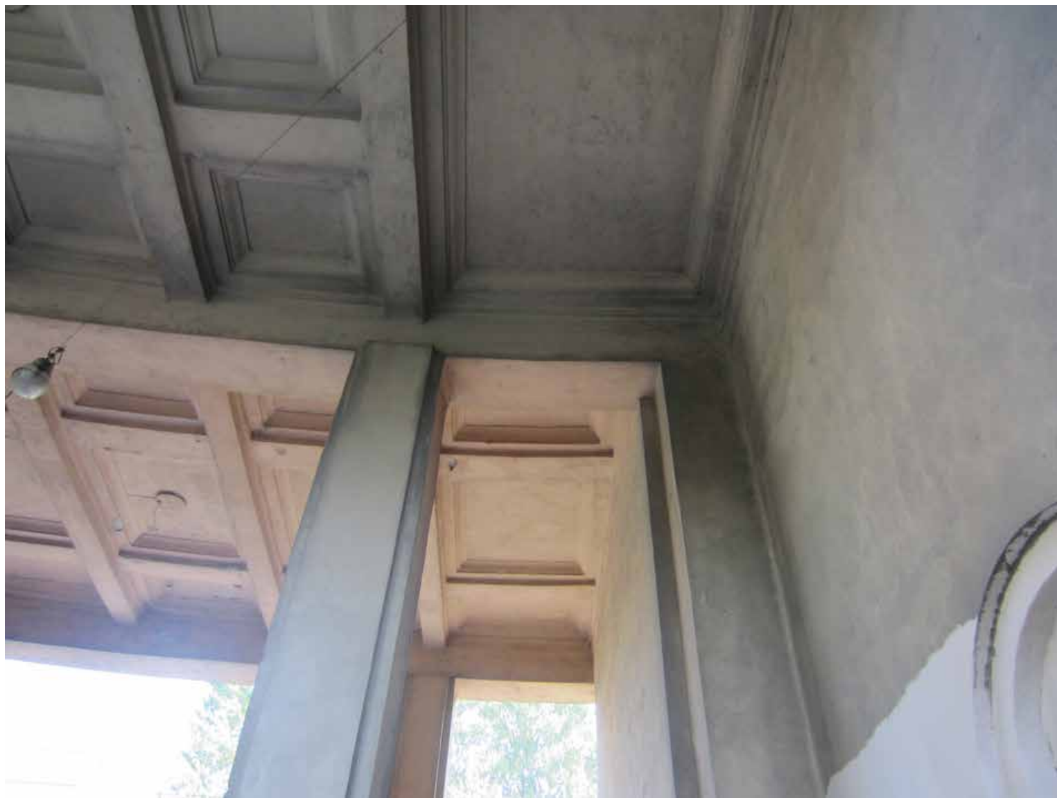
22. Объект культурного наследия регионального значения «Комплекс жилых домов (6 зданий)», расположенный по адресу: Санкт-Петербург, Красногвардейский район, Малоохтинский пр., 86, лит. А Декорированный центральный проезд Съемка: 12 сентября 2019г.
