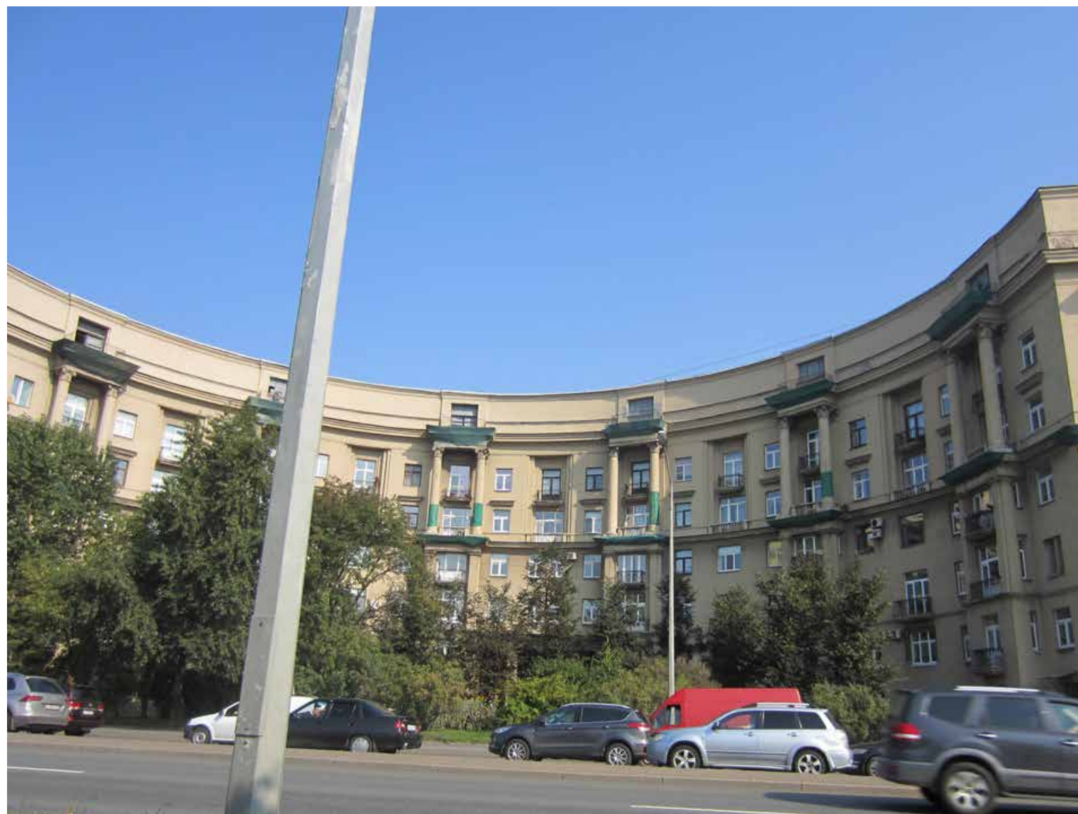
2. Объект культурного наследия регионального значения «Комплекс жилых домов (6 зданий)», расположенный по адресу: Санкт-Петербург, Красногвардейский район, Малоохтинский пр., 86, лит. А Вид лицевого фасада с Малоохтинского проспекта. Эркеры на высоте 1-2 этажей, завершенные 2-х ярусными порталами (с пилонами на уровне 3-4 этажей и колоннами на уровне 5-6 этажей) Съемка: 12 сентября 2019г.
