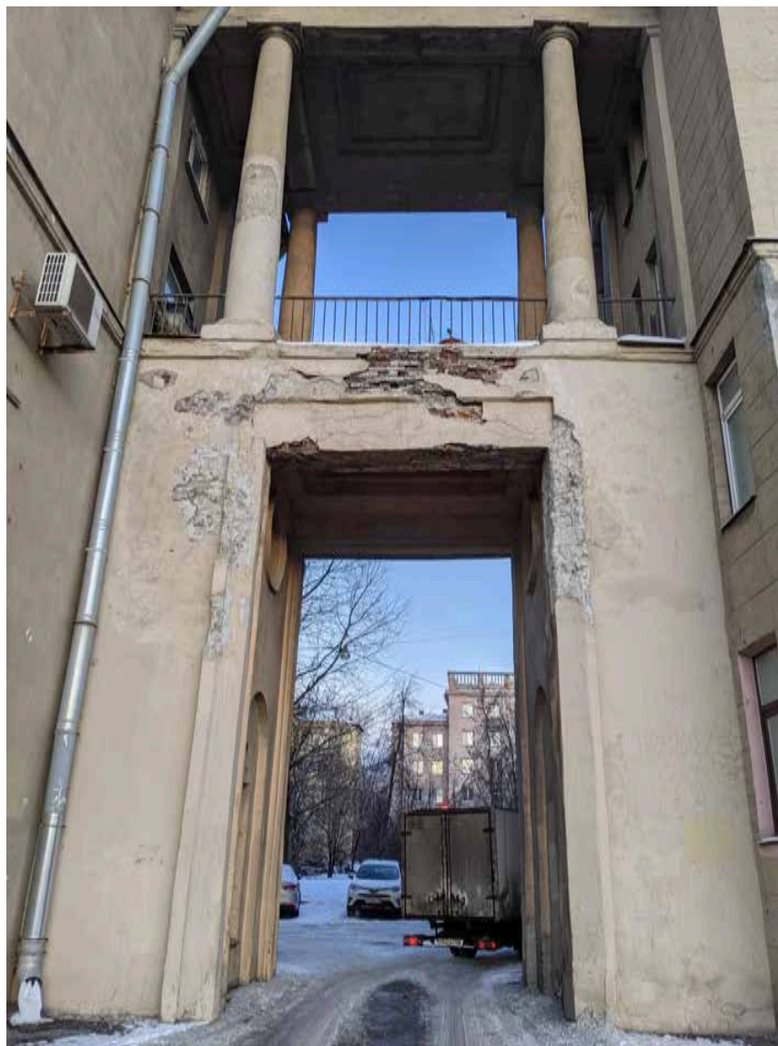
42. Объект культурного наследия регионального значения «Комплекс жилых домов (6 зданий)», расположенный по адресу: Санкт-Петербург, Красногвардейский район, Малоохтинский пр., 86, лит. А Фрагмент северной пристройки здания Съемка: 14 декабря 2020 г.
