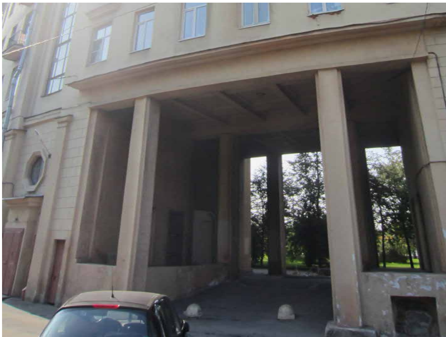
14. Объект культурного наследия регионального значения «Комплекс жилых домов (6 зданий)», расположенный по адресу: Санкт-Петербург, Красногвардейский район, Малоохтинский пр., 86, лит. А Центральный воротный проезд на пилонах с плоским кессонированным перекрытием Съемка: 12 сентября 2019г.
