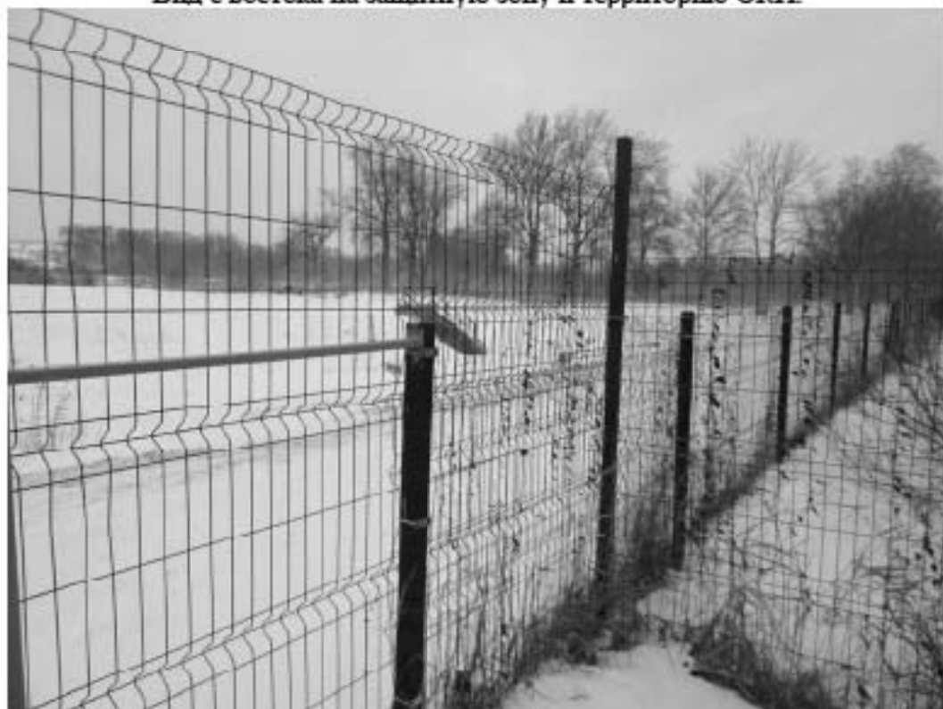
Илл. 32. Г. Санкт-Петербург, Петергоф (граница Лен. обл. и СПб у п. Санино). Точка фотофиксации Ф4. Вид с юга на территорию ОКН – Старопетергофский канал, ограда Лугового парка.
