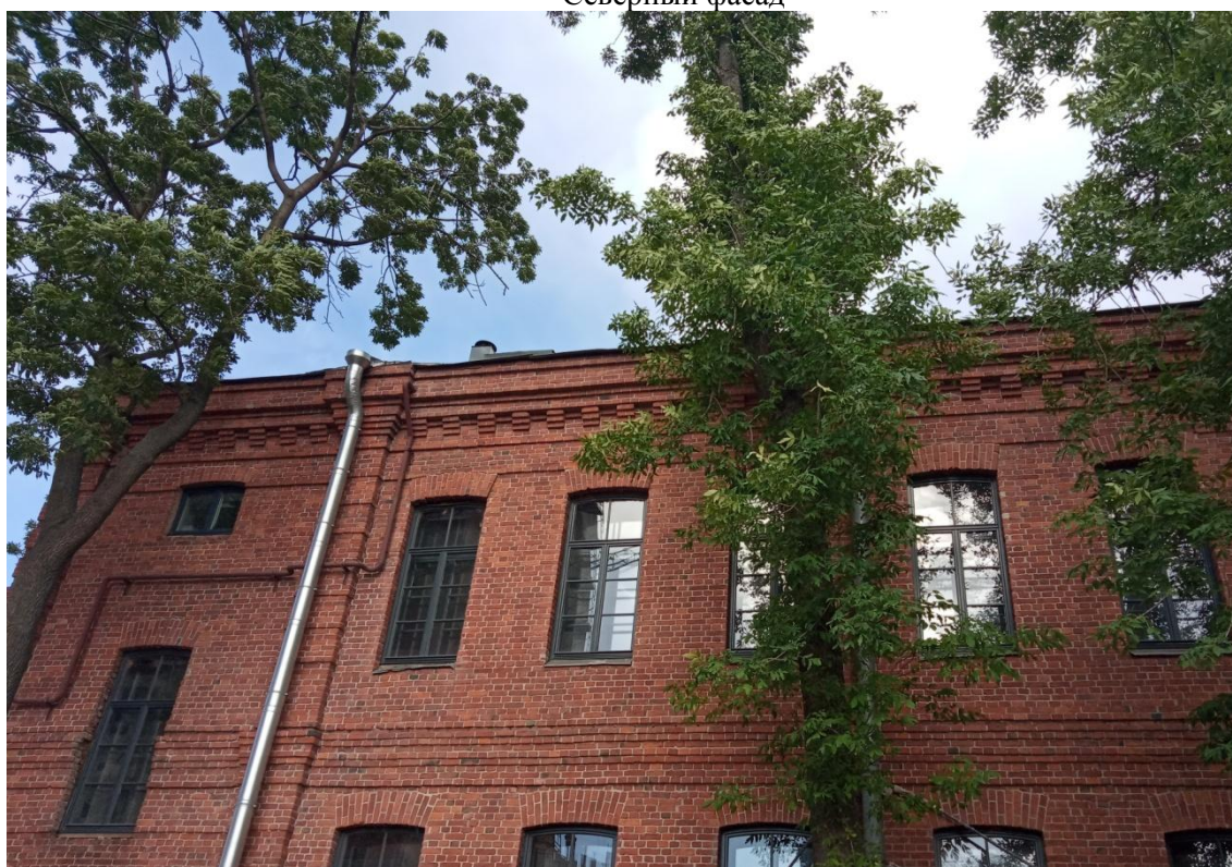
6. Фрагмент фасада выявленного объекта культурного наследия «Конторское здание». Западный фасад
