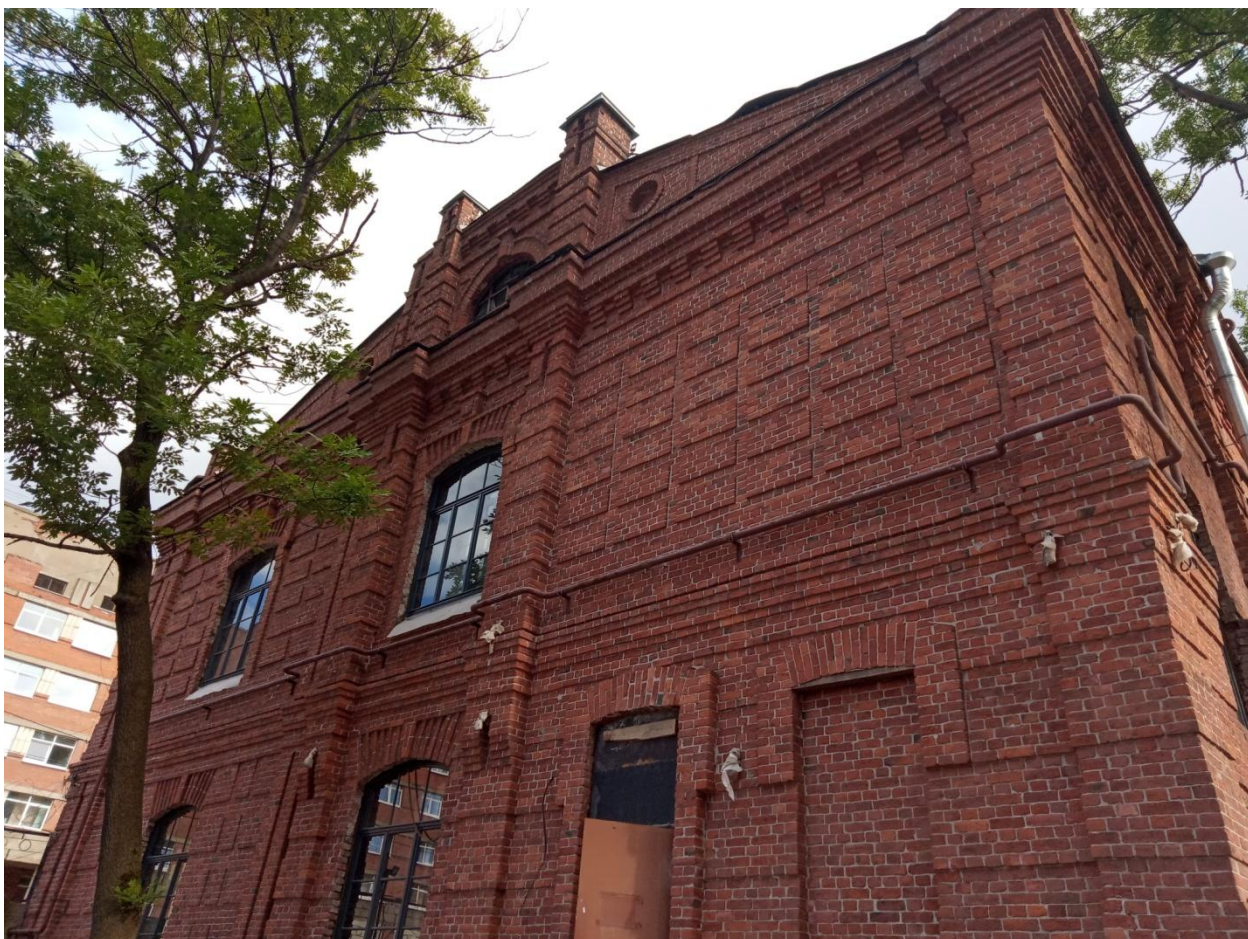
5. Фрагмент фасада выявленного объекта культурного наследия «Конторское здание». Северный фасад
