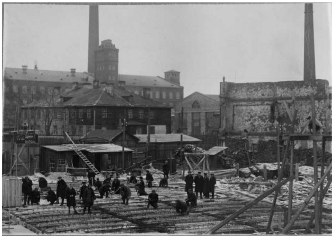
16. Панорама строительства нового завода на территории Ленинградского механического завода им. Карла Маркса. 1932 г. — ЦГАКФФД СПб ДР 7928.
