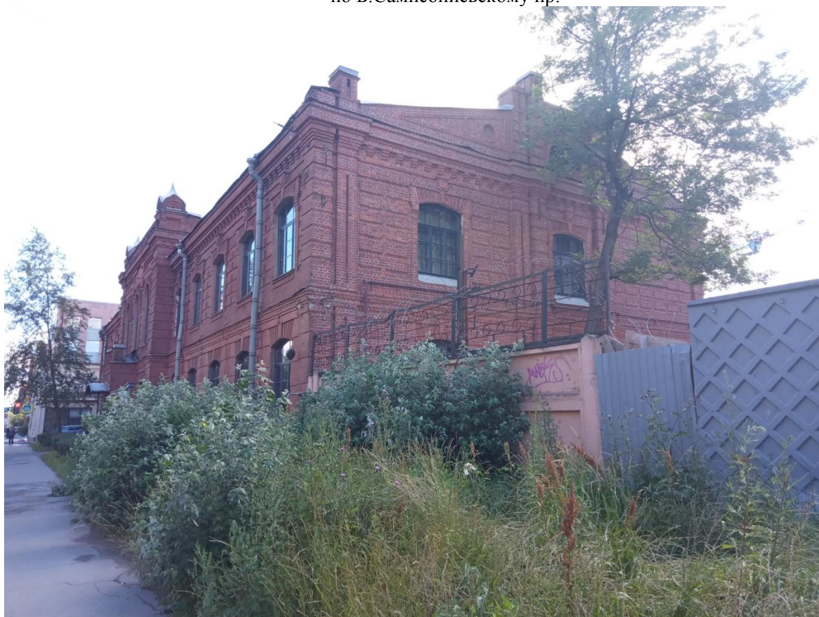
4. Фрагмент фасада выявленного объекта культурного наследия «Конторское здание». Северный фасад
