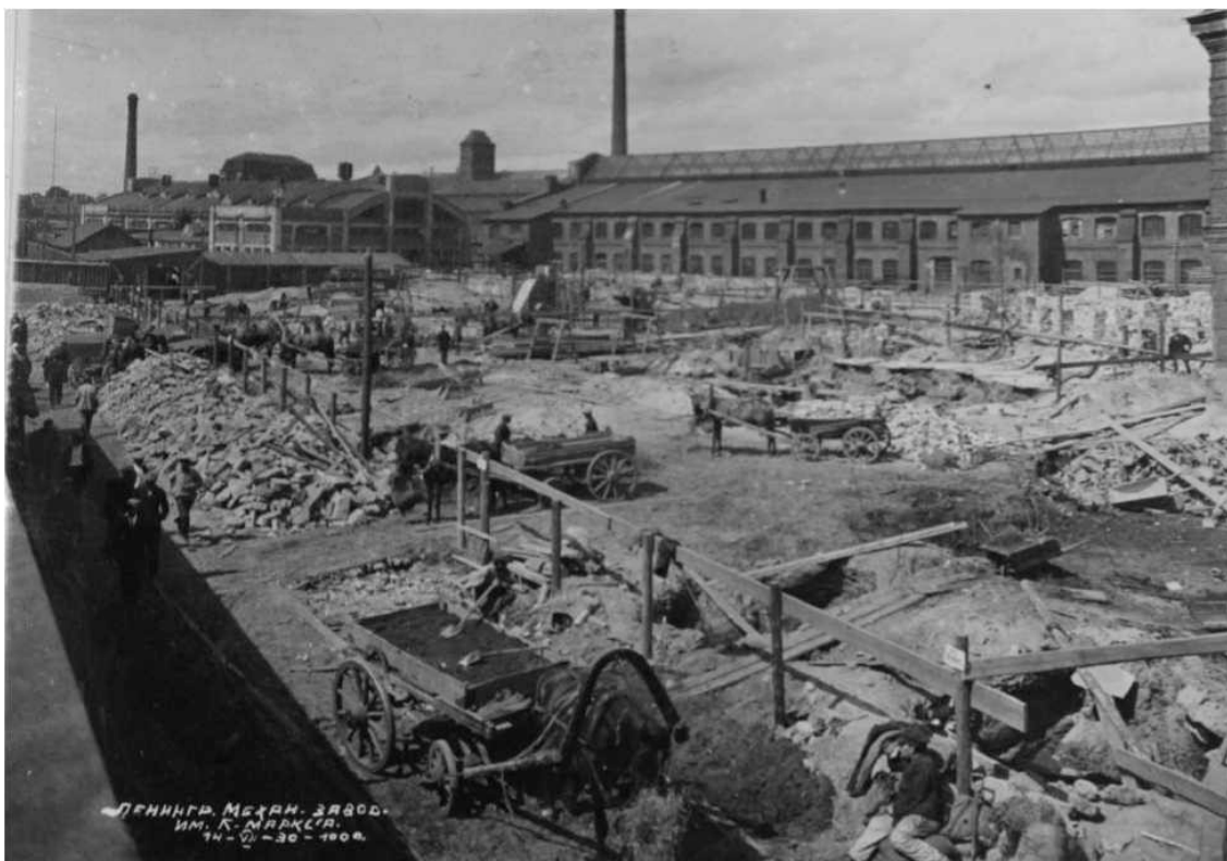
13. Вид строительства на территории Ленинградского механического завода им. Карла Маркса. 14.09.1930 г. — ЦГАКФФД СПб ГР 84306.
