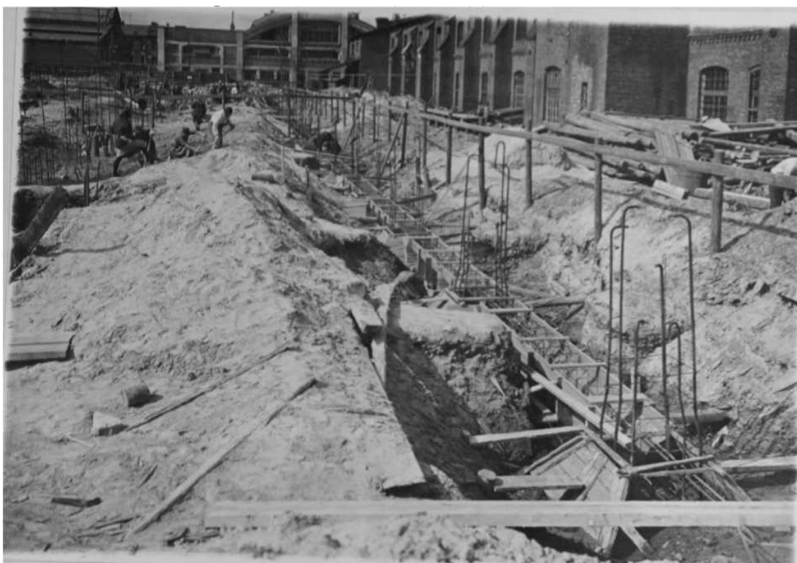
14. Строительство Ленинградского механического завода им. Карла Маркса. 14.09.1930 г. — ЦГАКФФД СПб ГР 84274.
