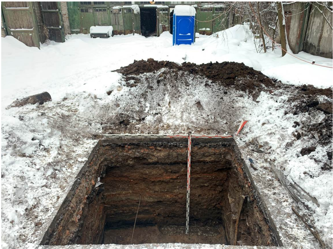
Рис. 47. Санкт-Петербург, Адмиралтейский район, ул. Марата, д. 92. Шурф 1. Финальная зачистка. Общий вид ЮВ стенки. Вид с СЗ.
