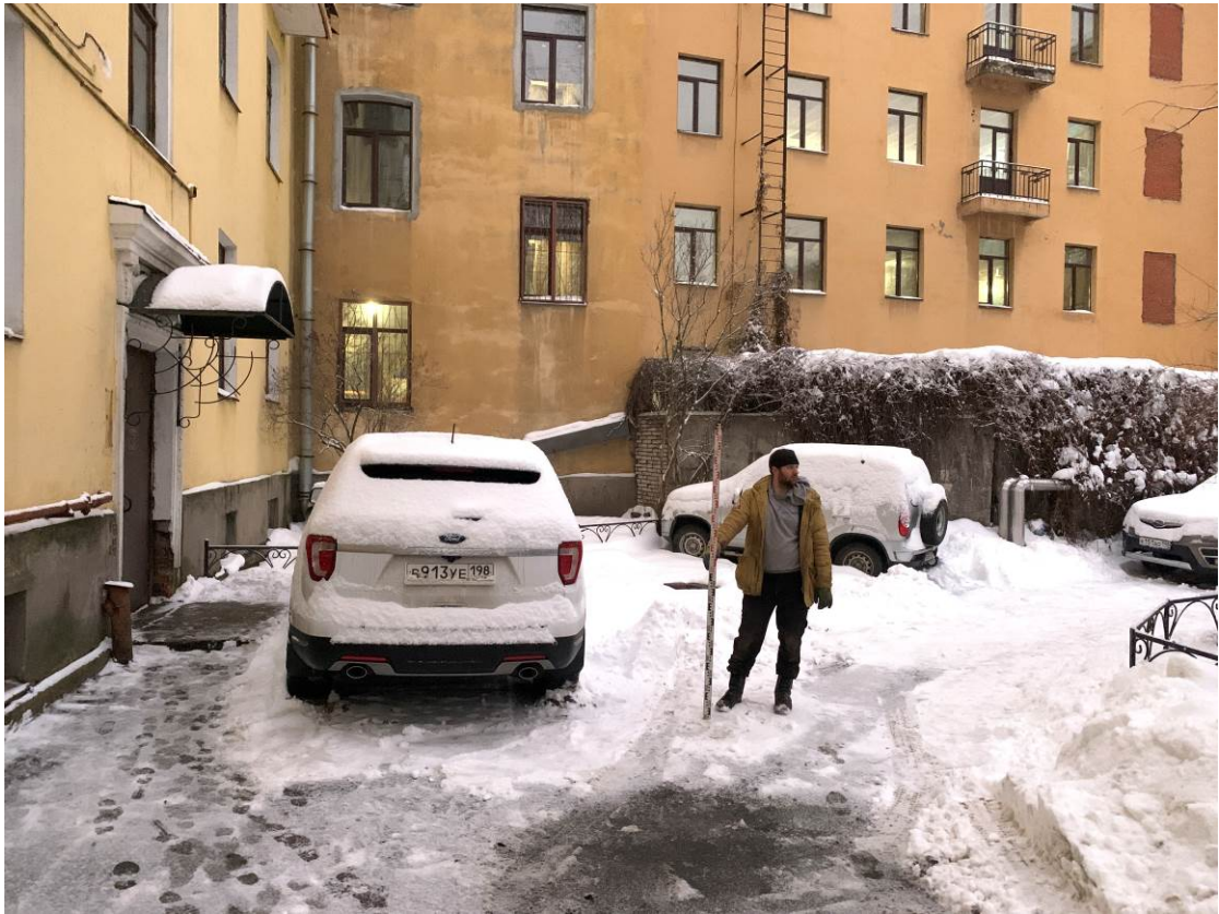
Рис. 28. Санкт-Петербург, Адмиралтейский район, ул. Марата, д. 92. Точка съёмки 7. Общий вид участка обследования. Вид с 3.
