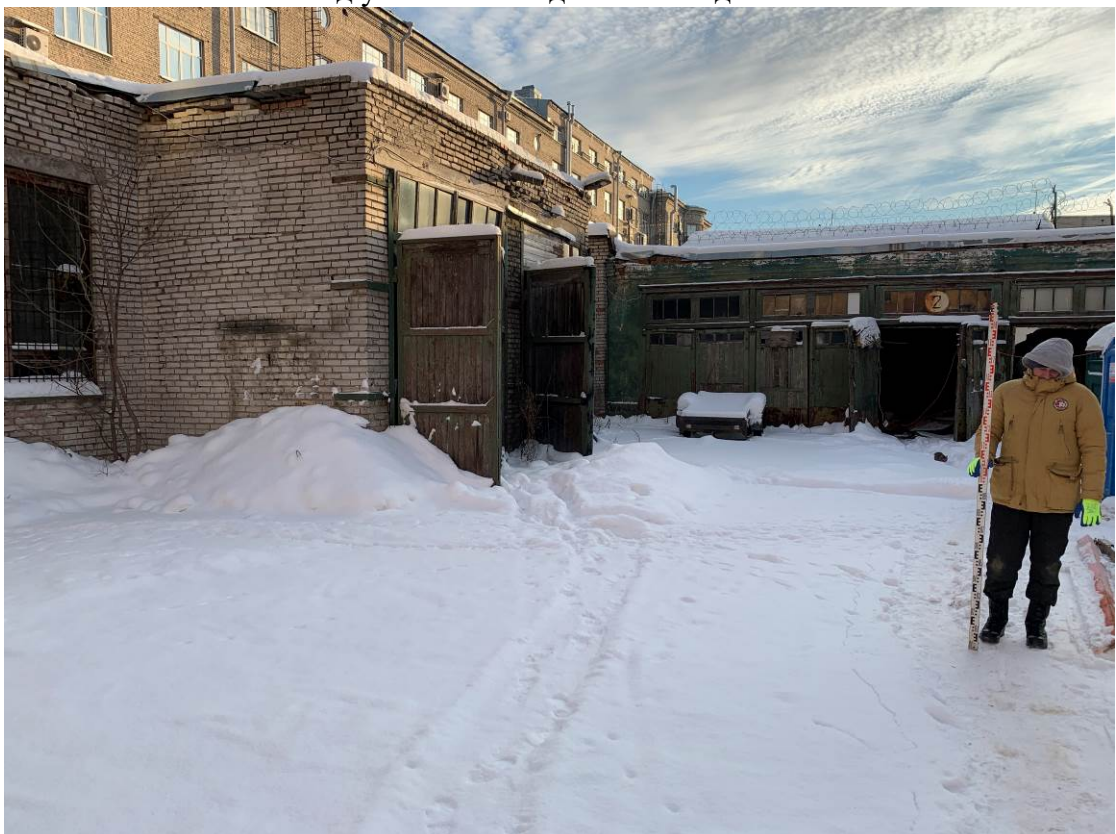
Рис. 15. Санкт-Петербург, Адмиралтейский район, ул. Марата, д. 92. Точка съёмки 2. Общий вид участка обследования. Вид с ЮЗ.
