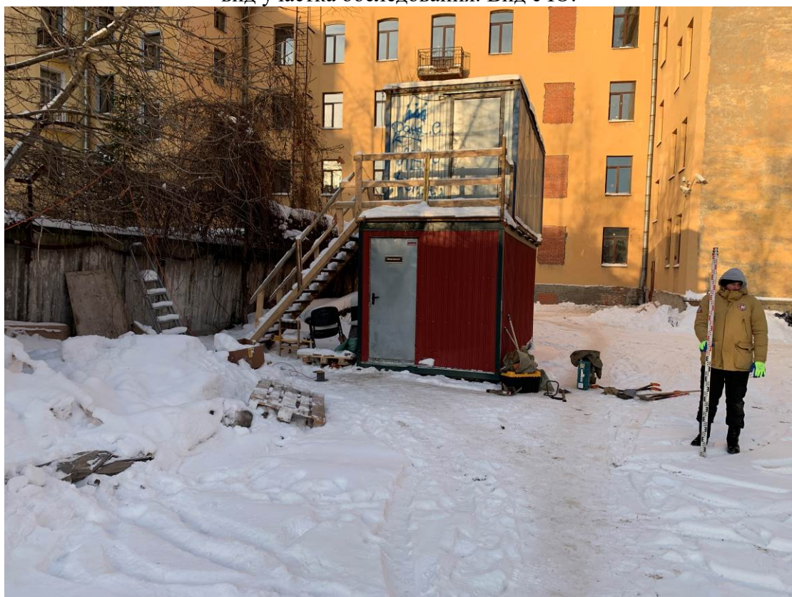
Рис. 13. Санкт-Петербург, Адмиралтейский район, ул. Марата, д. 92. Точка съёмки 2. Общий вид участка обследования. Вид с ЮЗ.
