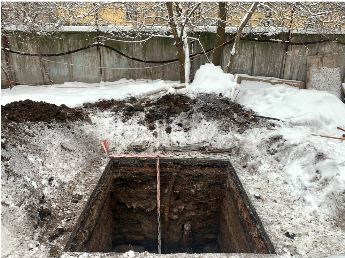
Рис. 49. Санкт-Петербург, Адмиралтейский район, ул. Марата, д. 92 Шурф 1. Финальная зачистка. Общий вид ЮЗ стенки. Вид с СВ.
