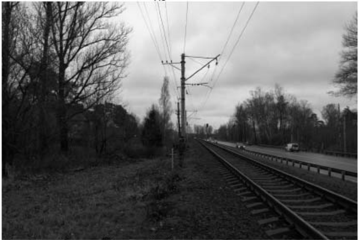
Рис. 32. г. Санкт-Петербург, Курортный район, Октябрьская железная дорога, Сестрорецкая линия. Общий вид участка обследования в районе ж/д пл. Александровская. Вид с севера.
