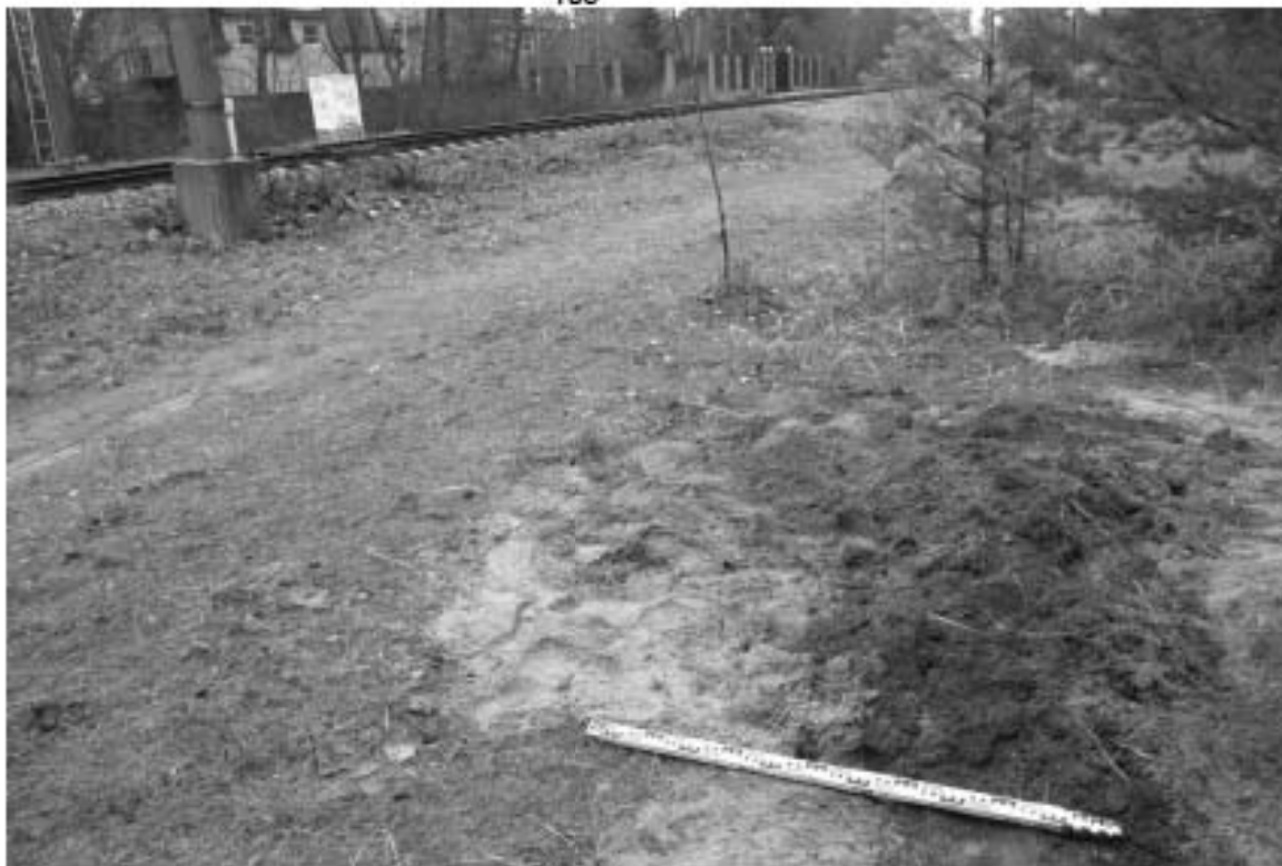
Рис. 20. г. Санкт-Петербург, Курортный район, Октябрьская железная дорога, Сестрорецкая линия. Шурф 1. Рекультивация. Вид с юго-востока.
