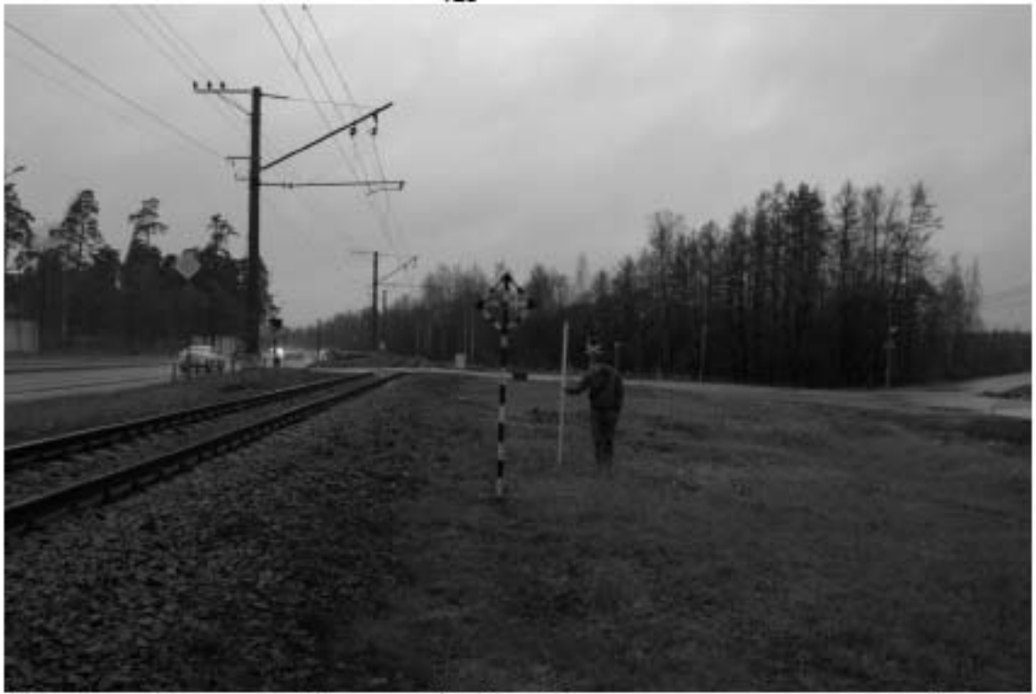
Рис. 52. г. Санкт-Петербург, Приморский район, Октябрьская железная дорога, Сестрорешская линия. Общий вид участка обследования в районе ж/д пл. Лисий нос. Вид с северо-запада.
