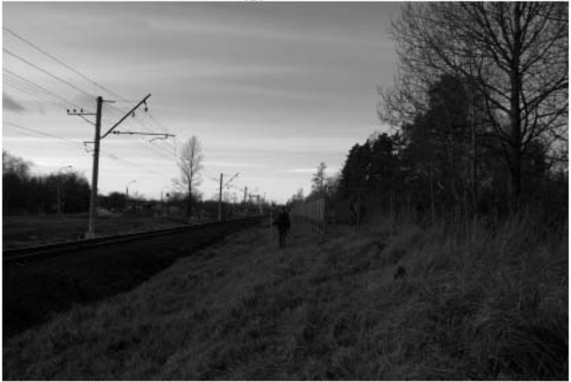
Рис. 50. г. Санкт-Петербург, Курортный район, Октябрьская железная дорога, Сестрорецкая линия. Общий вид участка обследования в районе Горского кладбища. Вид с юго-востока.
