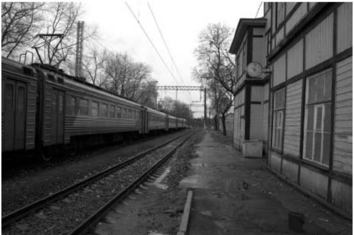
Рис. 13. г. Санкт-Петербург, Курортный район, Октябрьская железная дорога, Сестрорецкая линия. Общий вид участка обследования в районе ОКН «Сестрорецкий вокзал». Вид с севера.
