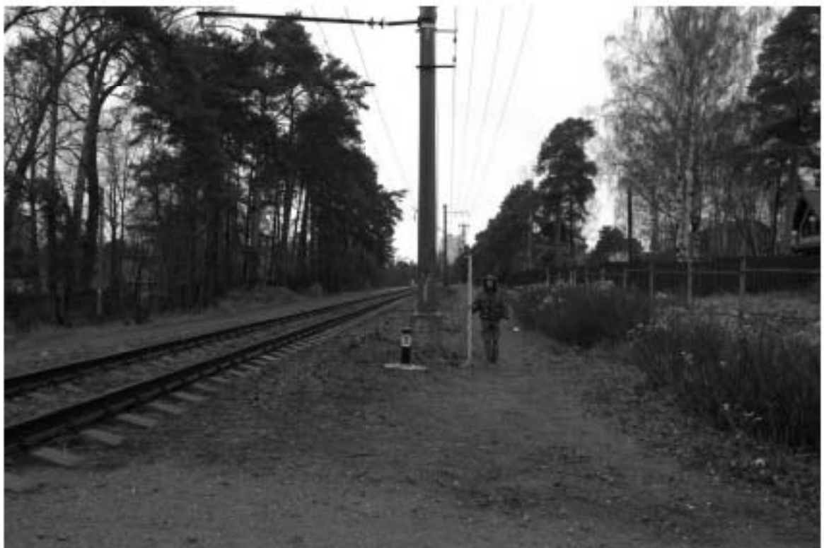
Рис. 15. г. Санкт-Петербург, Курортный район, Октябрьская железная дорога, Сестрорецкая линия. Общий вид участка обследования в район ул. Малая Ленинградская в г. Сестрорецк. Вид с юго-востока.
