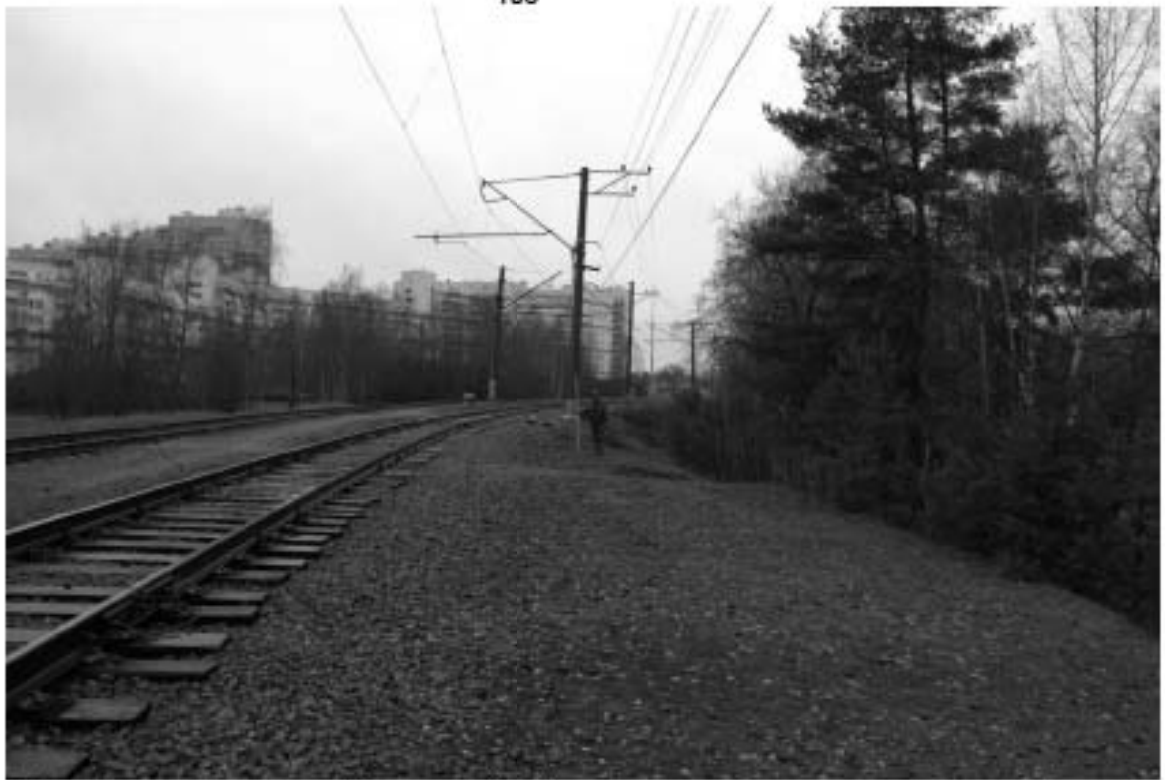
Рис. 14. г. Санкт-Петербург, Курортный район, Октябрьская железная дорога, Сестрорецкая линия. Общий вид участка обследования в месте пересечения Водосливного канала в г. Сестрорецк. Вид с северо-запада
