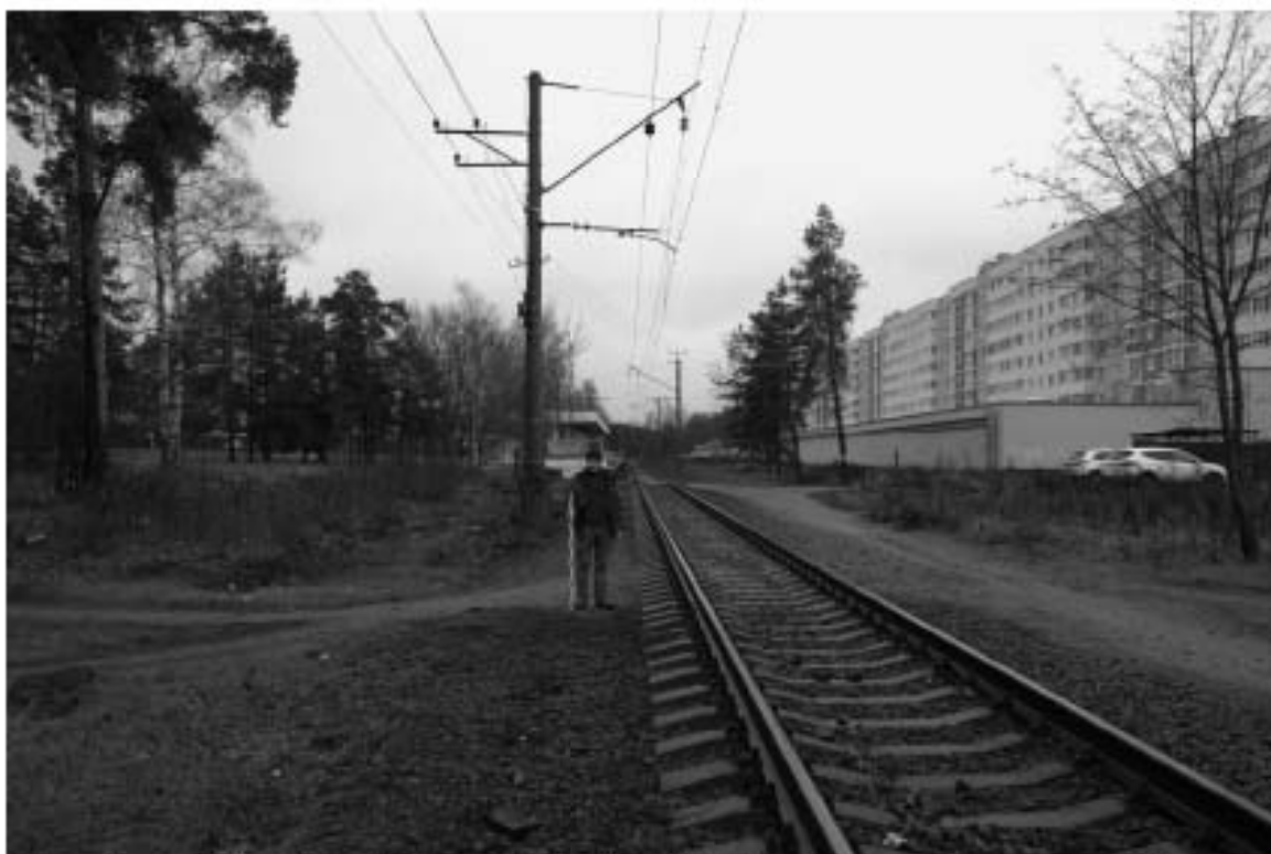
Рис. 25. г. Санкт-Петербург, Курортный район, Октябрьская железная дорога, Сестрорецкая линия. Общий вид участка обследования в районе остановочного пункта Разлив. Вид с северо-запада
