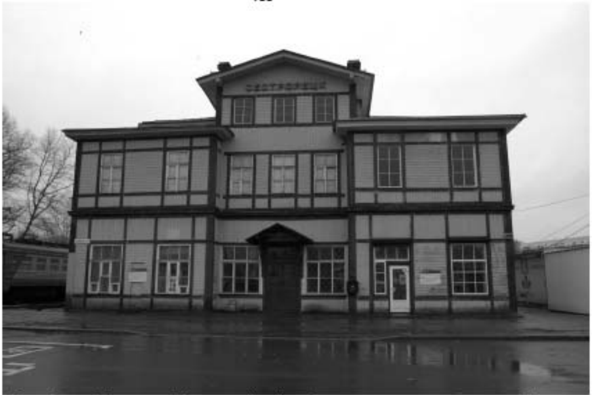
Рис. 12. г. Санкт-Петербург, Курортный район, Октябрьская железная дорога, Сестрорецкая линия. Общий вид участка обследования в районе ОКН «Сестрорецкий вокзал». Вид с севера.
