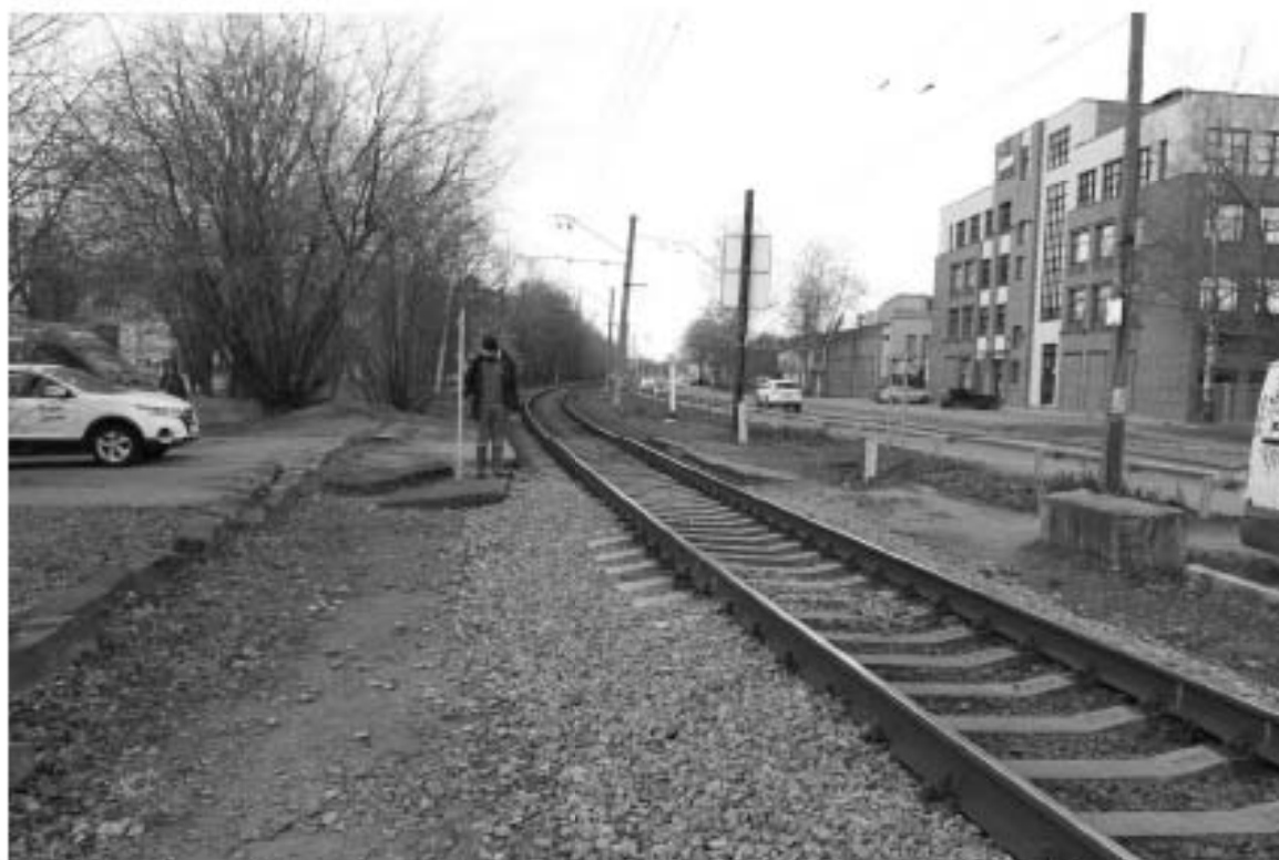
Рис. 31. г. Санкт-Петербург, Приморский район, Октябрьская ж.-д. Общий вид участка обследования в районе ул. Заусадная. Вид с востока.
