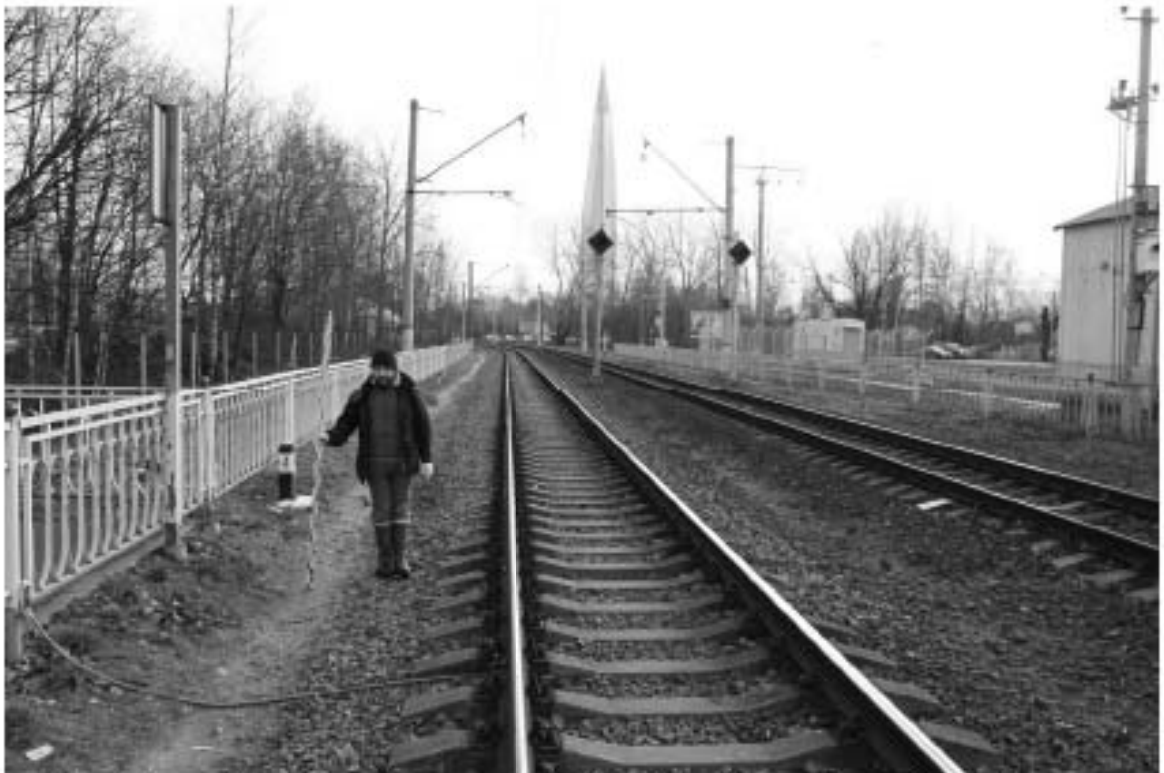
Рис. 11. г. Санкт-Петербург, Приморский район, Октябрьская ж.-д. Общий вид участка обследования в районе ж.-д. станции Лахта. Вид с северо-запада.
