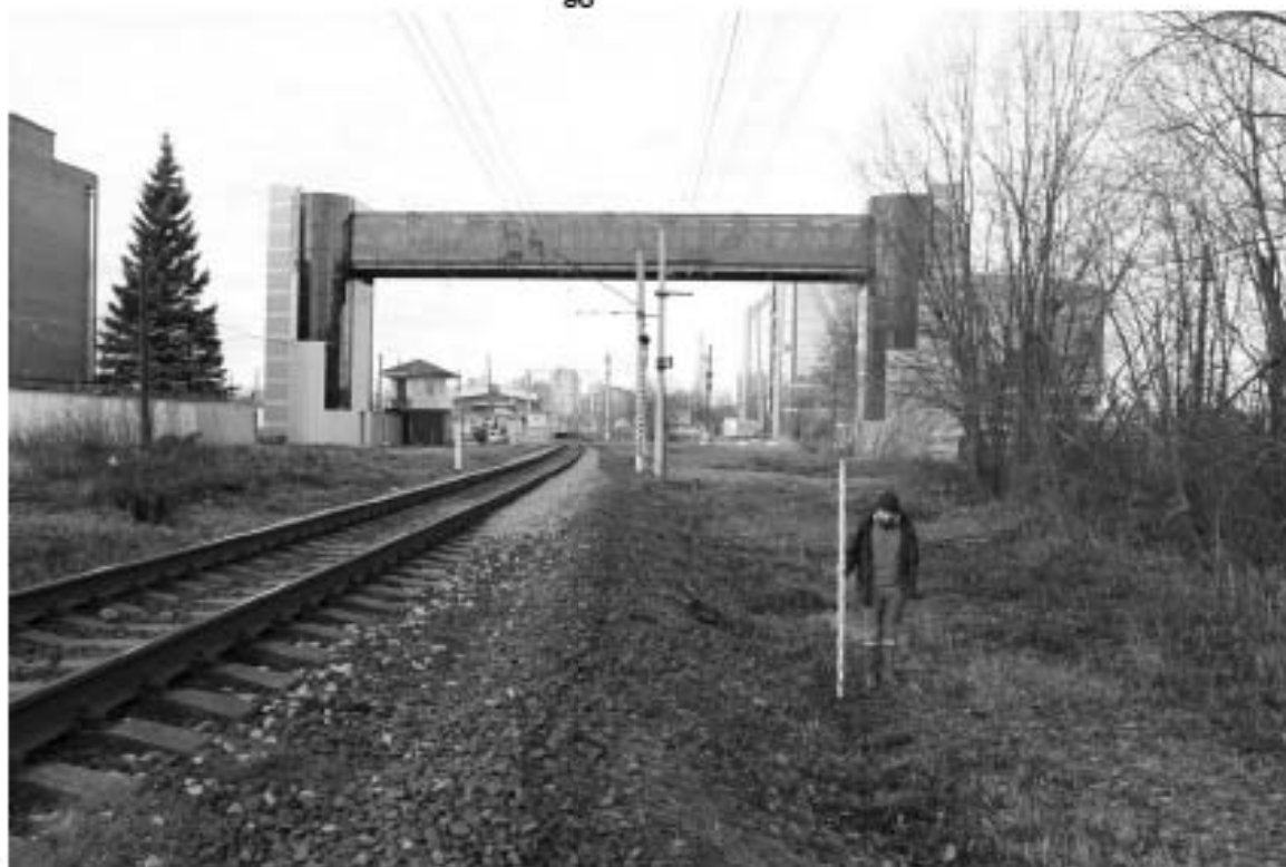
Рис. 30. г. Санкт-Петербург, Приморский район, Октябрьская ж.-д. Общий вид участка обследования в районе пересечения ул. Заусадная и Торфяная дор. Вид с северо-востока.
