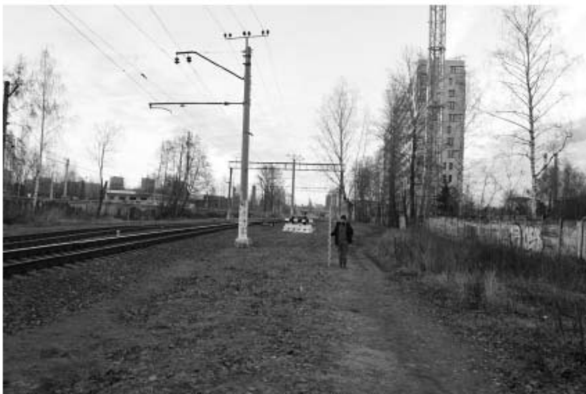
Рис. 33. г. Санкт-Петербург, Приморский район, Октябрьская ж.-д. Общий вид участка обследования в районе ж.-д. станции Новая Деревня. Вид с юго-запада.
