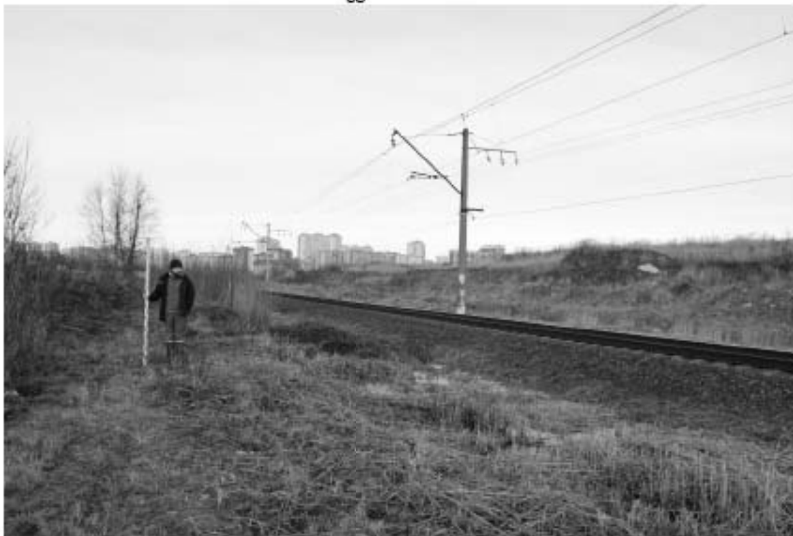
Рис. 28. г. Санкт-Петербург, Приморский район, Октябрьская ж.-д. Общий вид участка обследования в районе западного конца ул. Школьная. Вид с юго-востока
