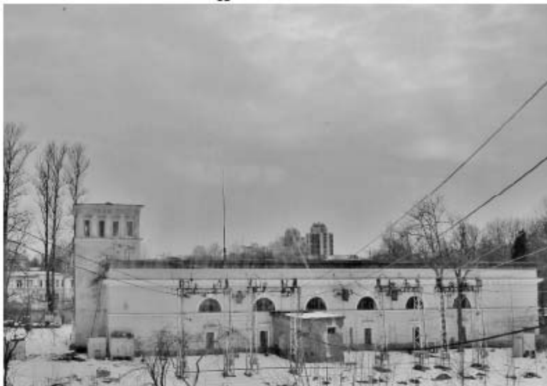
Рис. 34. г. Санкт-Петербург, Приморский район, Октябрьская ж.-д. Общий вид участка обследования в районе электрической подстанции «Ланская» 1948 г.п. Вид с юго-запада.
