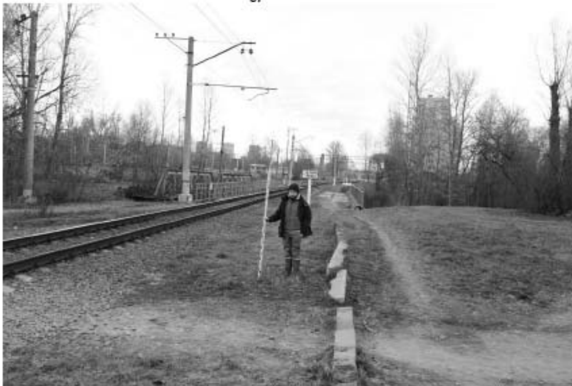
Рис. 32. г. Санкт-Петербург, Приморский район, Октябрьская ж.-д. Общий вид участка обследования в районе пересечения р. Черная речка. Вид с юго-запада.
