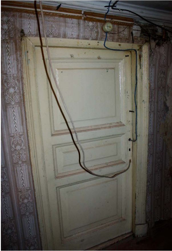
Фото 19. Дверное заполнение комнаты 3.
