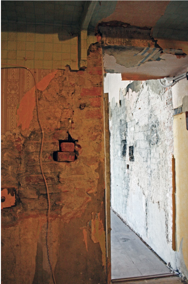
Фото 39. Кладка стены между помещением 8 и комнатой 12.
