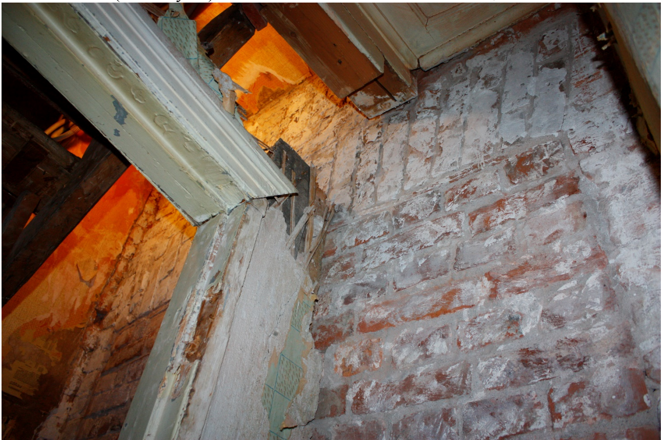
Фото 29. Заложенный дверной проем в помещении 8.
