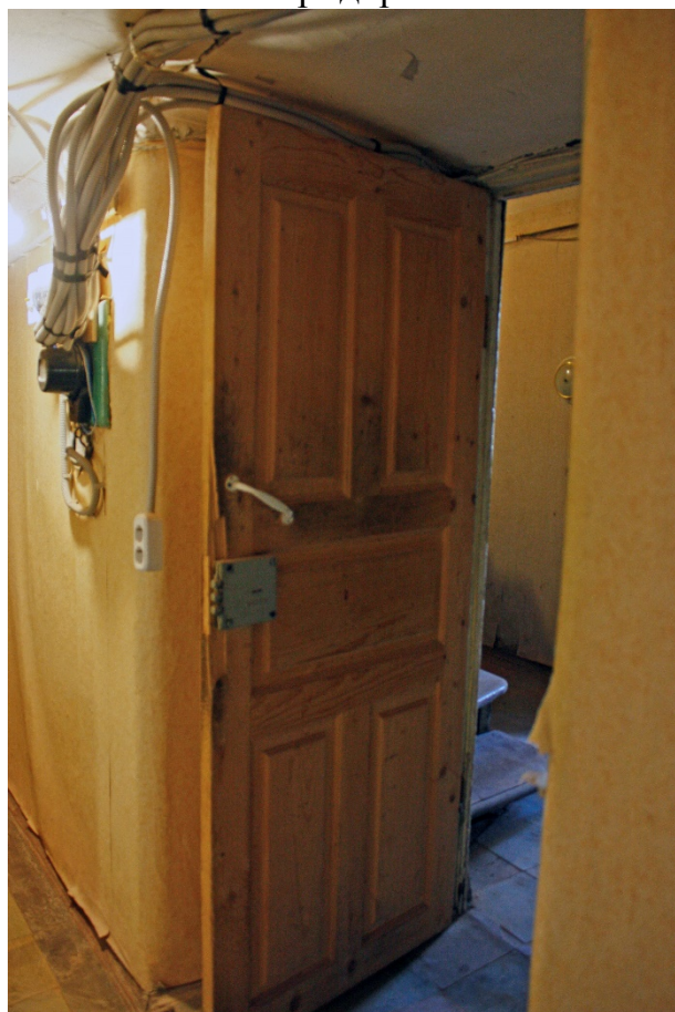
Фото 11. Дверной проем с заполнением.
