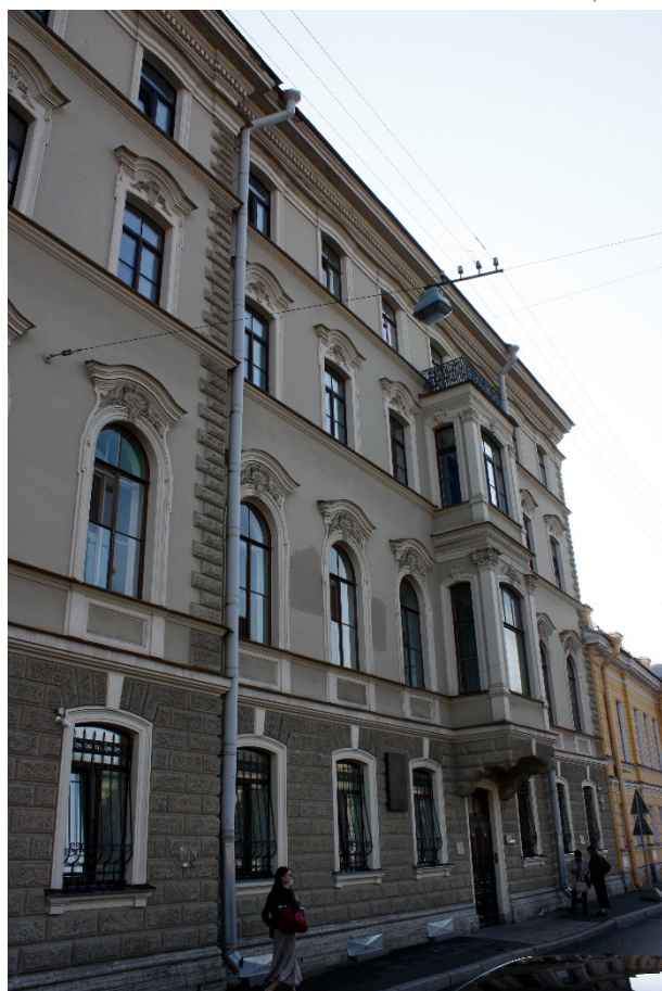
Фото 2. Фрагмент западной части фасада по наб.р.Мойки.
