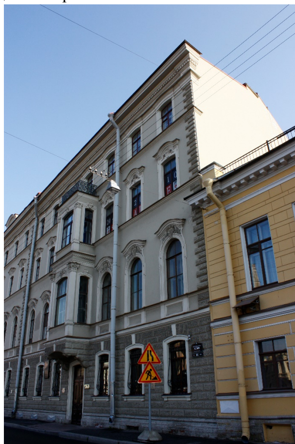
Фото 3. Фрагмент западной части фасада по наб.р.Мойки.
