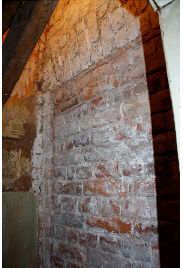
Фото 31. Заложенный дверной проем в помещении 8.
