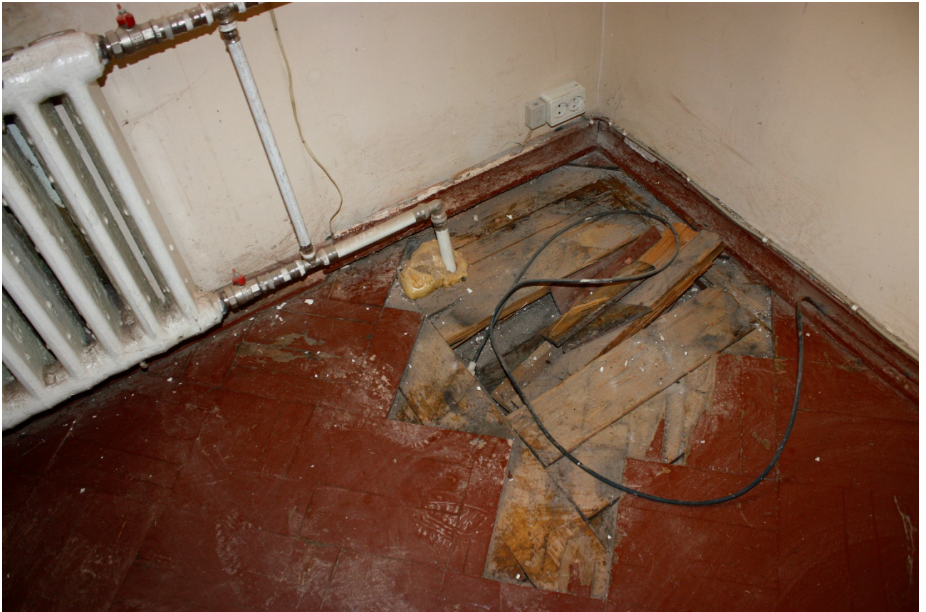
Фото 21. Покрытие пола комнаты 3.
