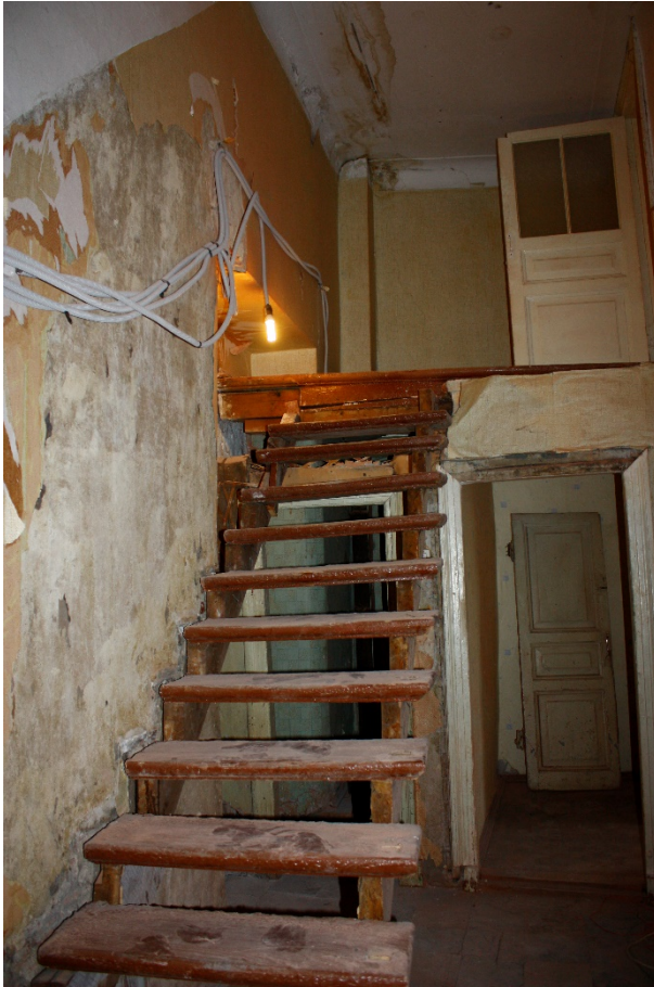
Фото 27. Лестница на антресоль (комнату 13).
