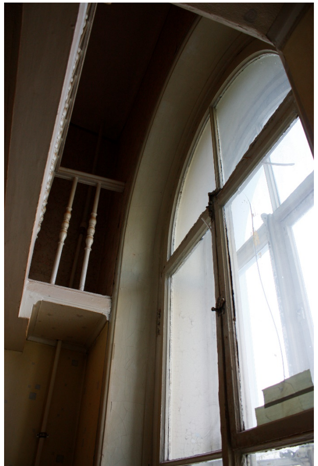
Фото 38. Примыкание антресоли к оконному проему.
