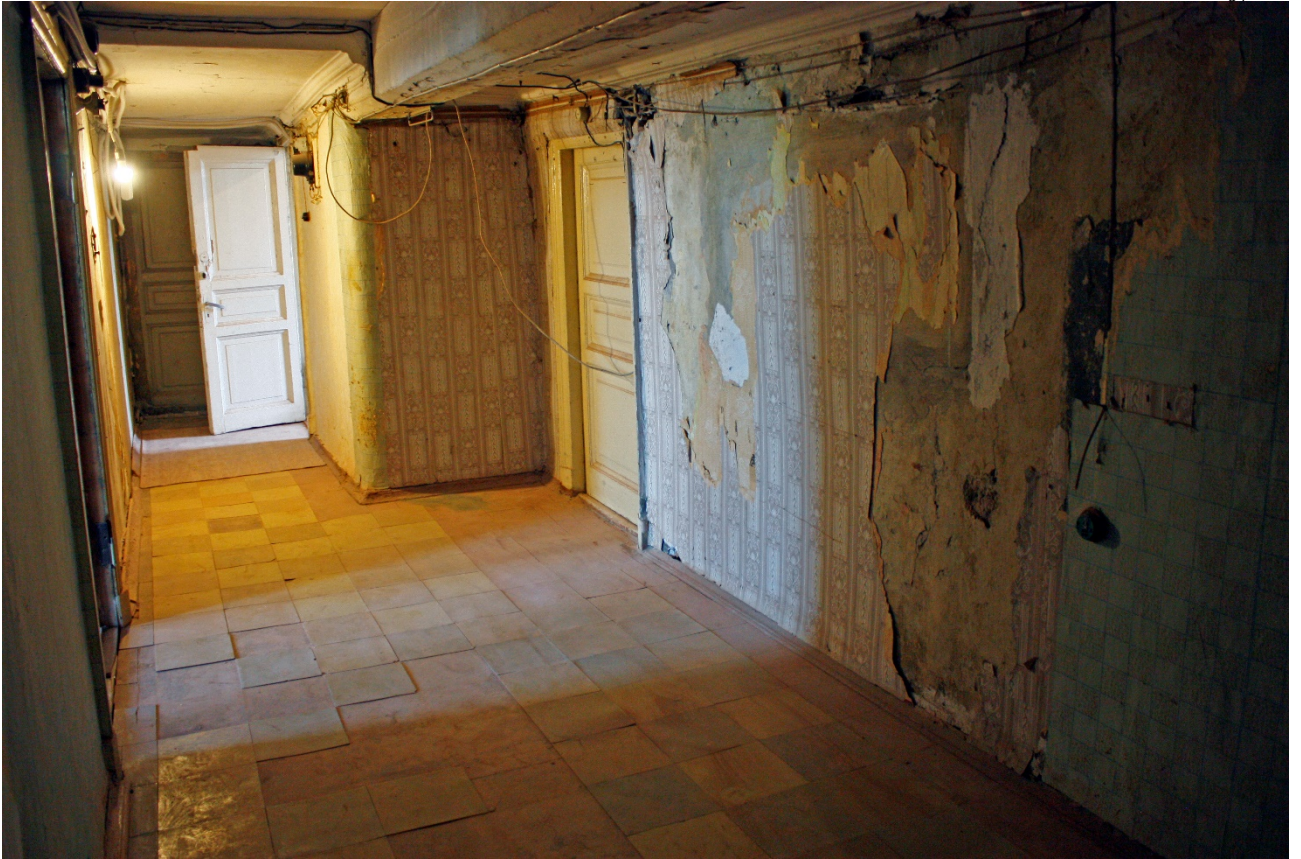
Фото 12. Общий вид центральной части коридора.
