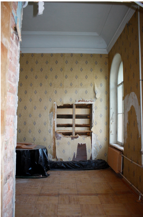
Фото 25. Вид комнаты 11 из проема комнаты 12.
