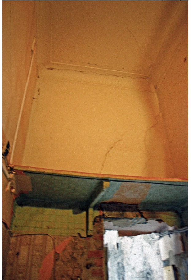
Фото 40. Антресоль над проемом.
