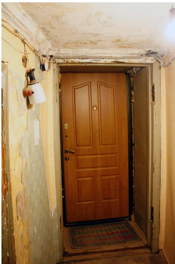
Фото 10. Вход в квартиру.
