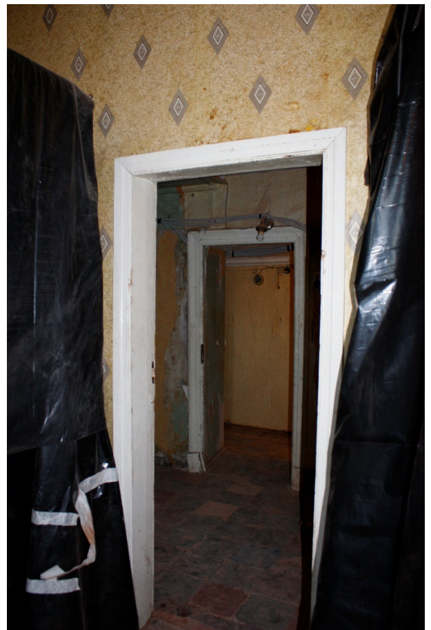
Фото 26. Проемы комнаты 11, и помещения 8 в коридор.
