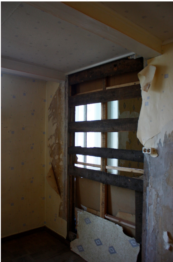
Фото 37. Перегородка между комнатами 10 и 11.
