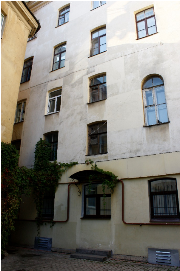
Фото 4. Фрагмент дворового фасада западной части здания.
