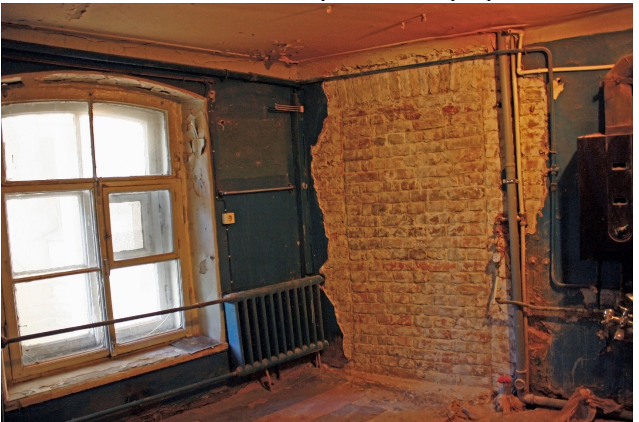
Фото 13. Комната 6. Заложенный проем на лестницу.
