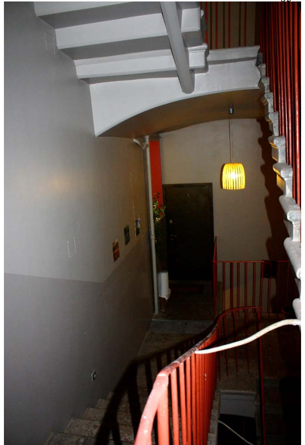
Фото 5. Общий вид на междуэтажную площадку второго этажа.
