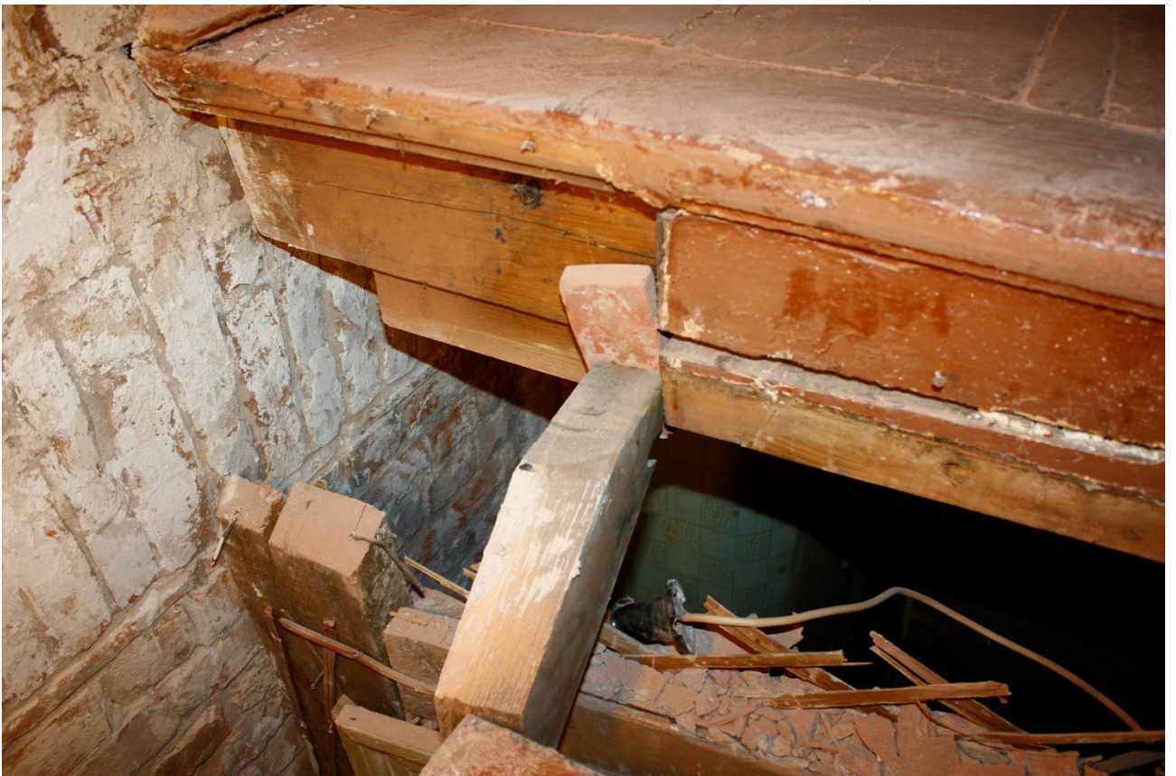
Фото 32. Разрушения лестницы.
