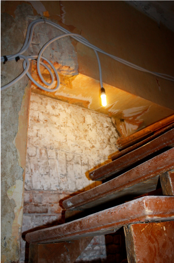
Фото 30. Крепление лестницы к стене.
