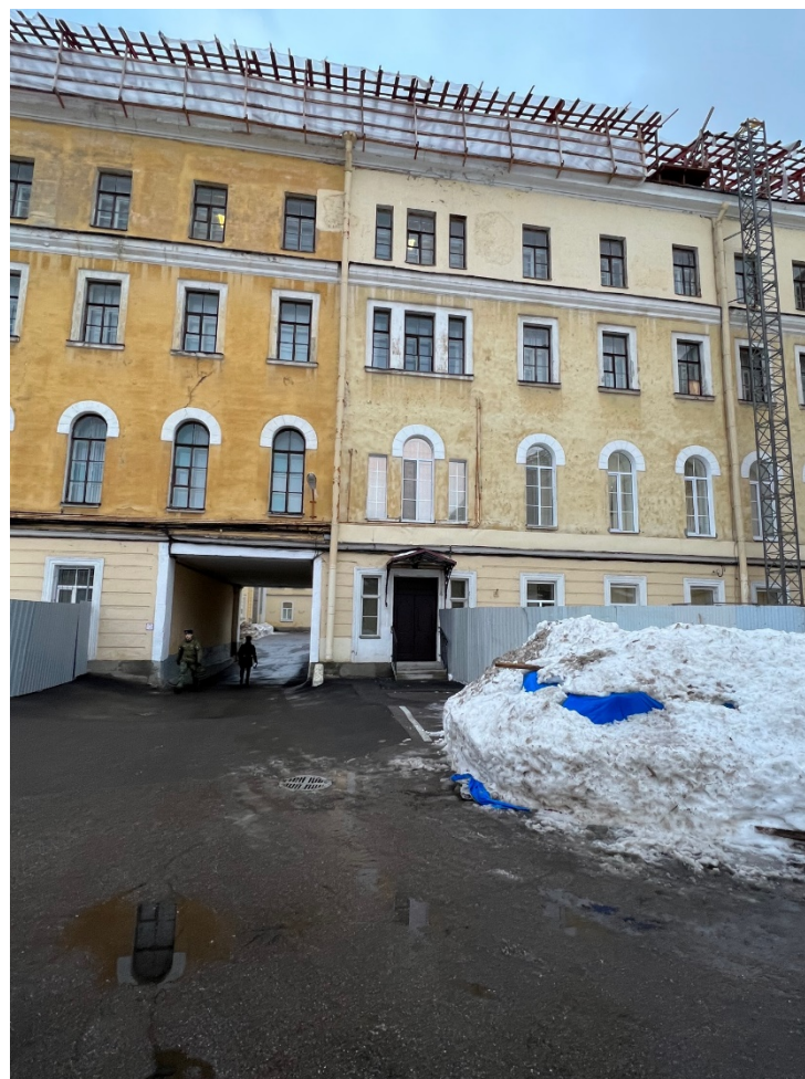
17. Юго-восточный дворовый фасад выявленного объекта культурного наследия «Главный корпус с 1-м солдатским корпусом, офицерским флигелем и Михайловское артиллерийское училище», расположенного по адресу: г. Санкт-Петербург, ул. Комсомола, д. 22, литера А. 06.12.2021
