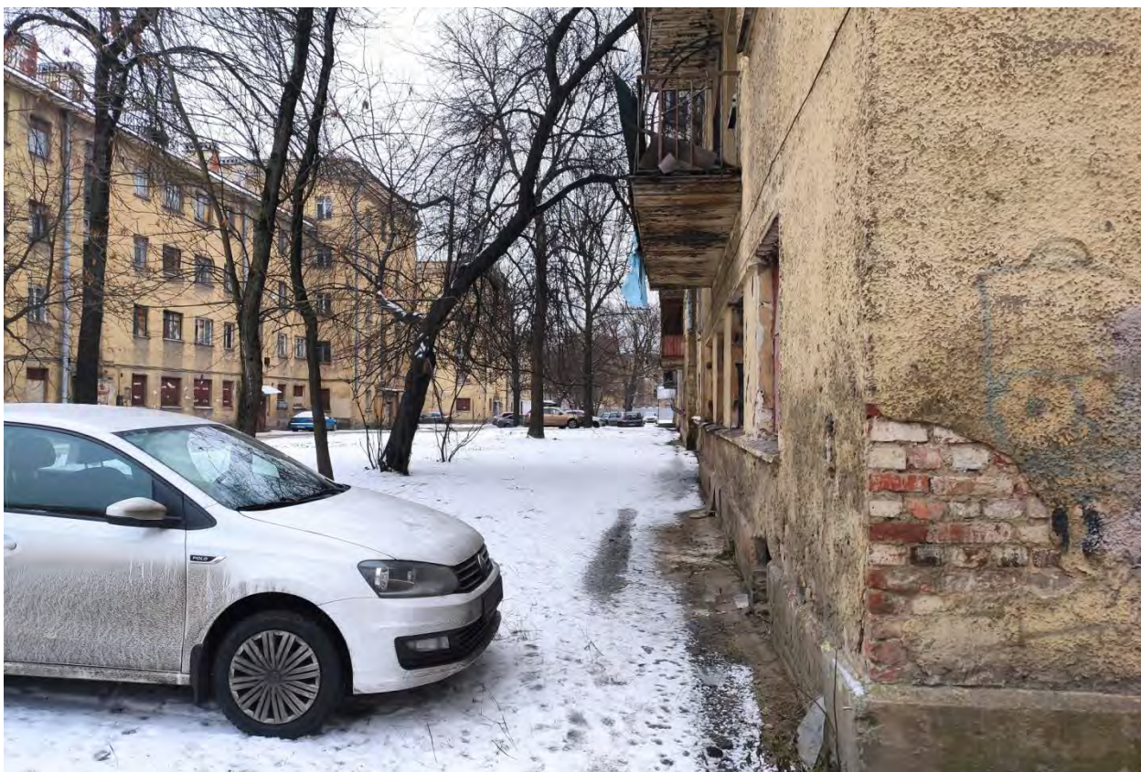
Фото 17. Вид на территорию объекта вдоль здания – д.40, корп.7.
