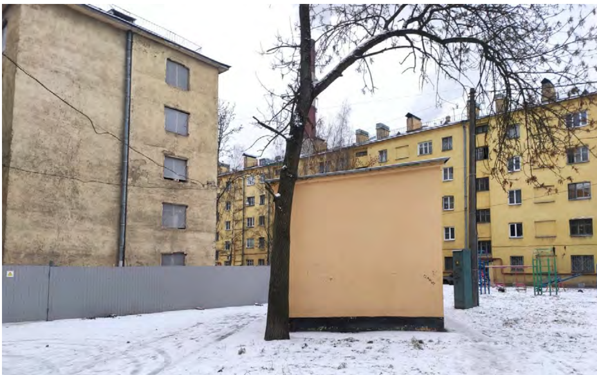
Фото 10. Вид на территорию объекта, ТП и торец здания – д.40, корп.8.
