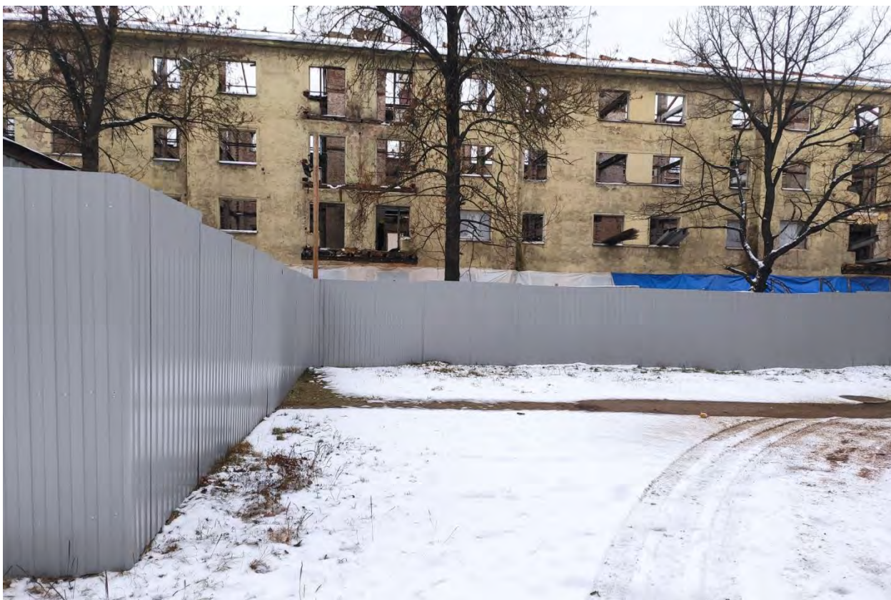
Фото 4. Вид на внутривортовую территорию, видно здание – дом 40, корп.2.
