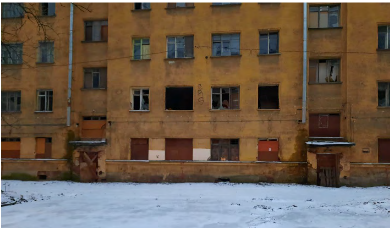
Фото 12.1. Корпус 9. Северный фасад (место размещения проектируемого кабельного киоска).
