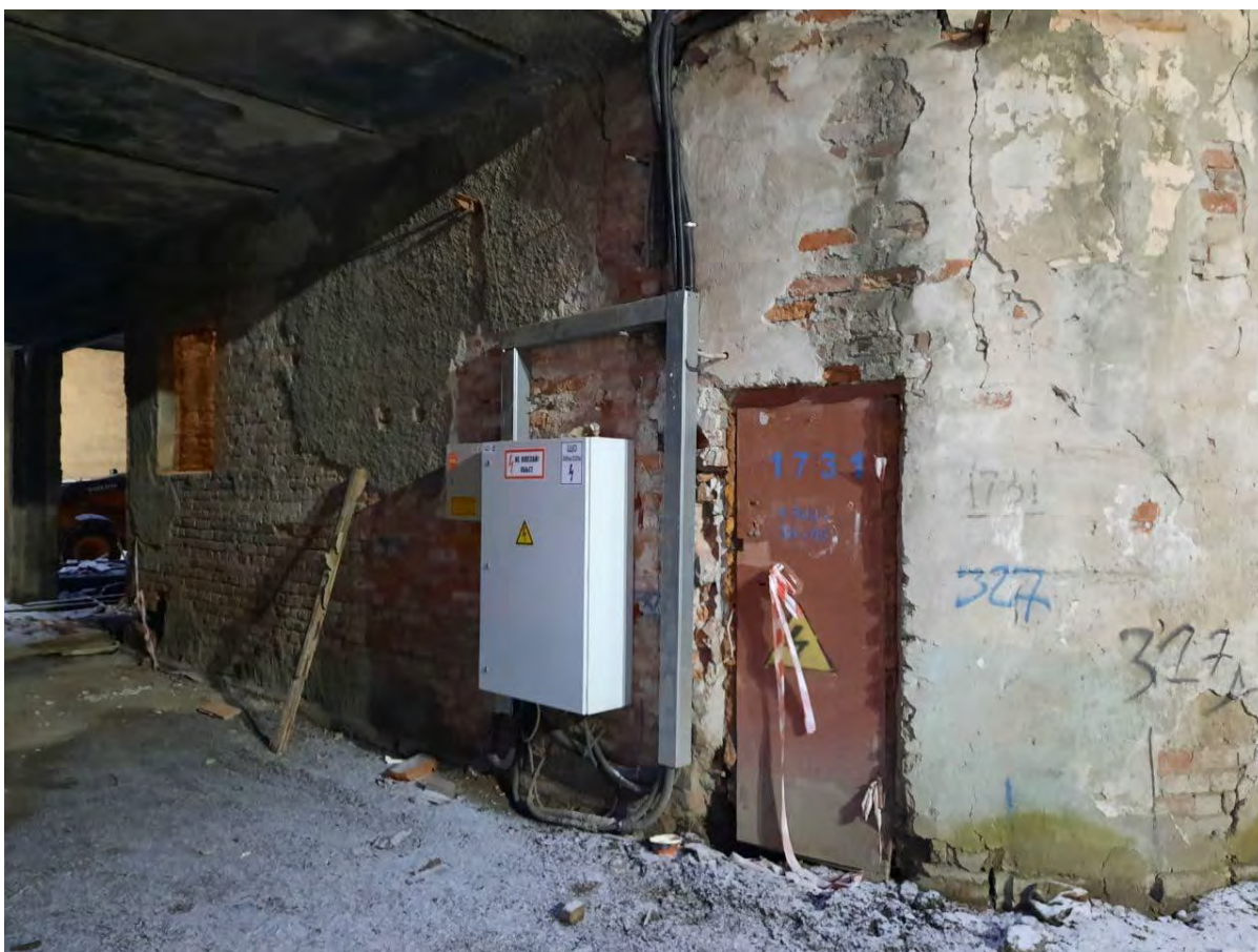
Фото 7.2. Корпус 8. Западный фасад (место размещения проектируемого кабельного киоска запланировано в левой (западной) проездной арке, за щитом освещения).
