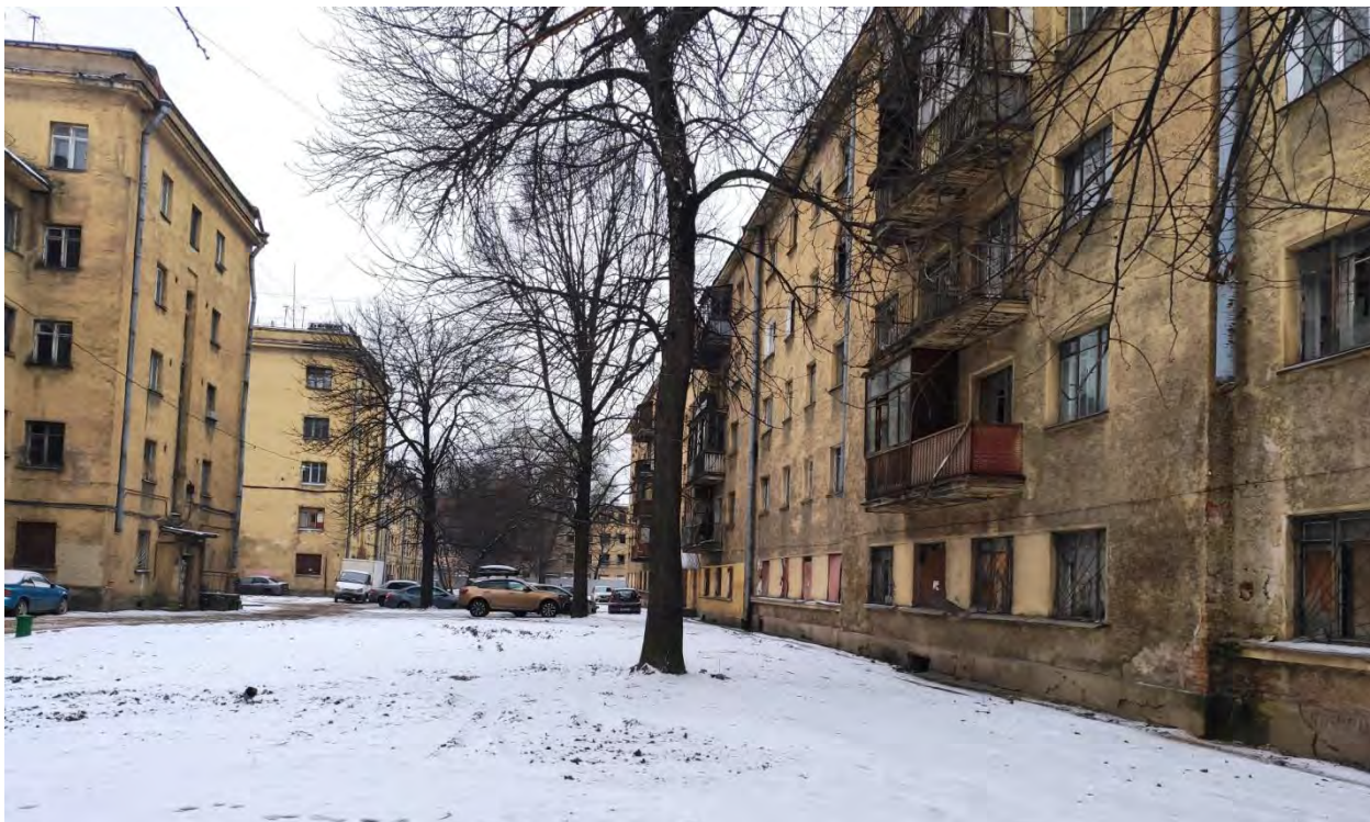
Фото 18. Вид на территорию объекта вдоль здания – д.40, корп.7.
