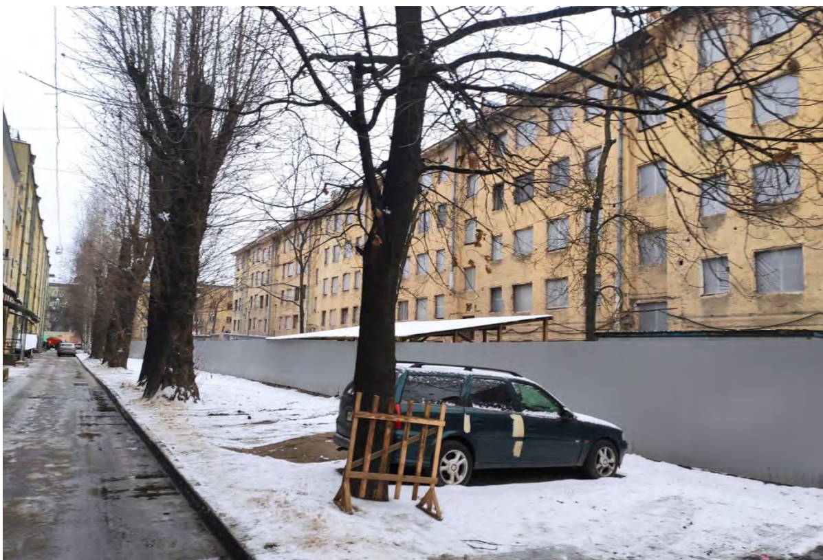
Фото 7. Вид на территорию объекта и здание – д.40, корп.8.
