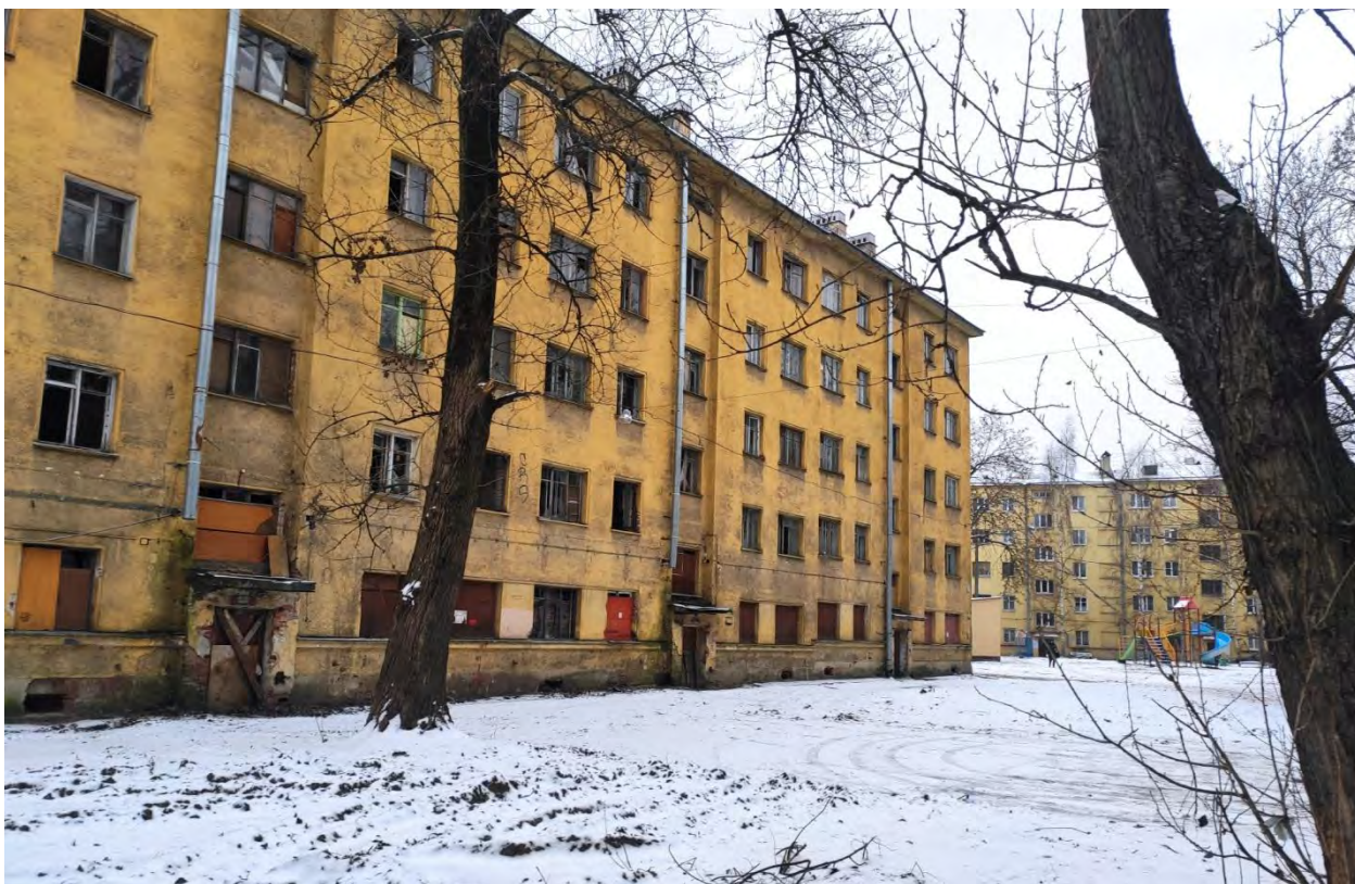
Фото 14. Вид на территорию объекта, здание – д.40, корп.9 и фрагмент ТП (на дальнем плане).
