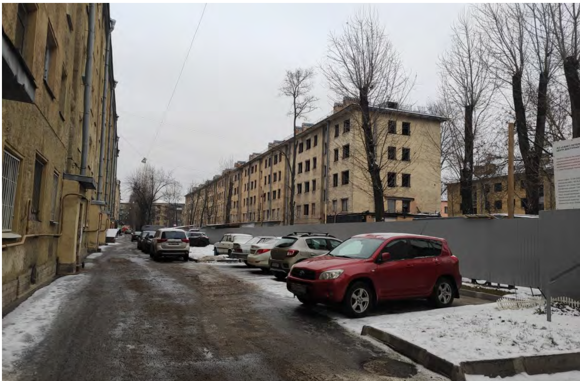
Фото 6. Вид на территорию объекта и здание – д.40, корп.8.
