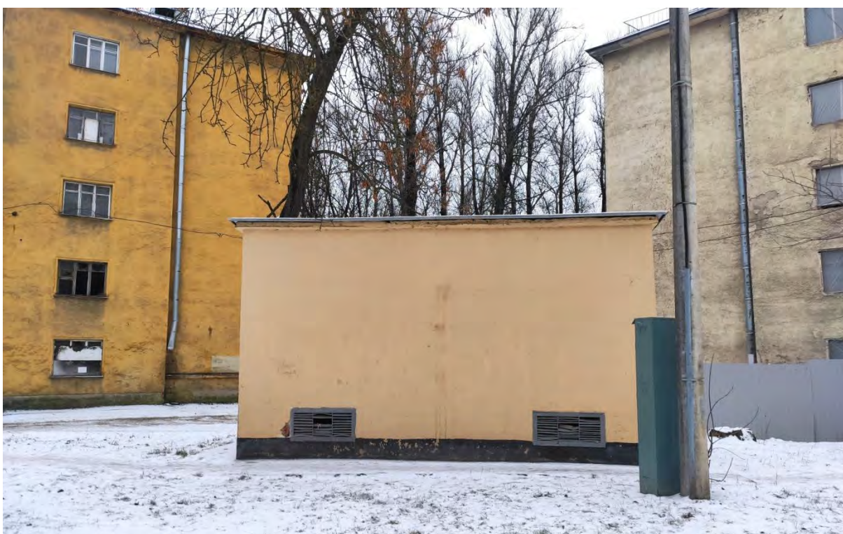
Фото 9. Вид на территорию объекта и ТП.
