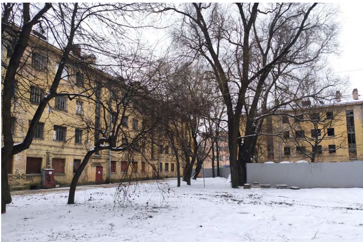
Фото 2. Вид на территорию двора и здание д. 40, корп.1., виден существующий кабельный киоск.
