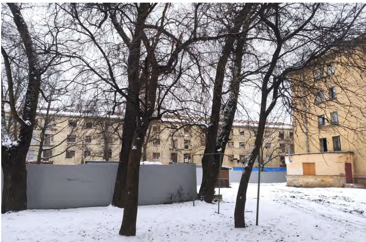
Фото 3. Вид на территорию двора и торец здания (д.40, корп.7) .
