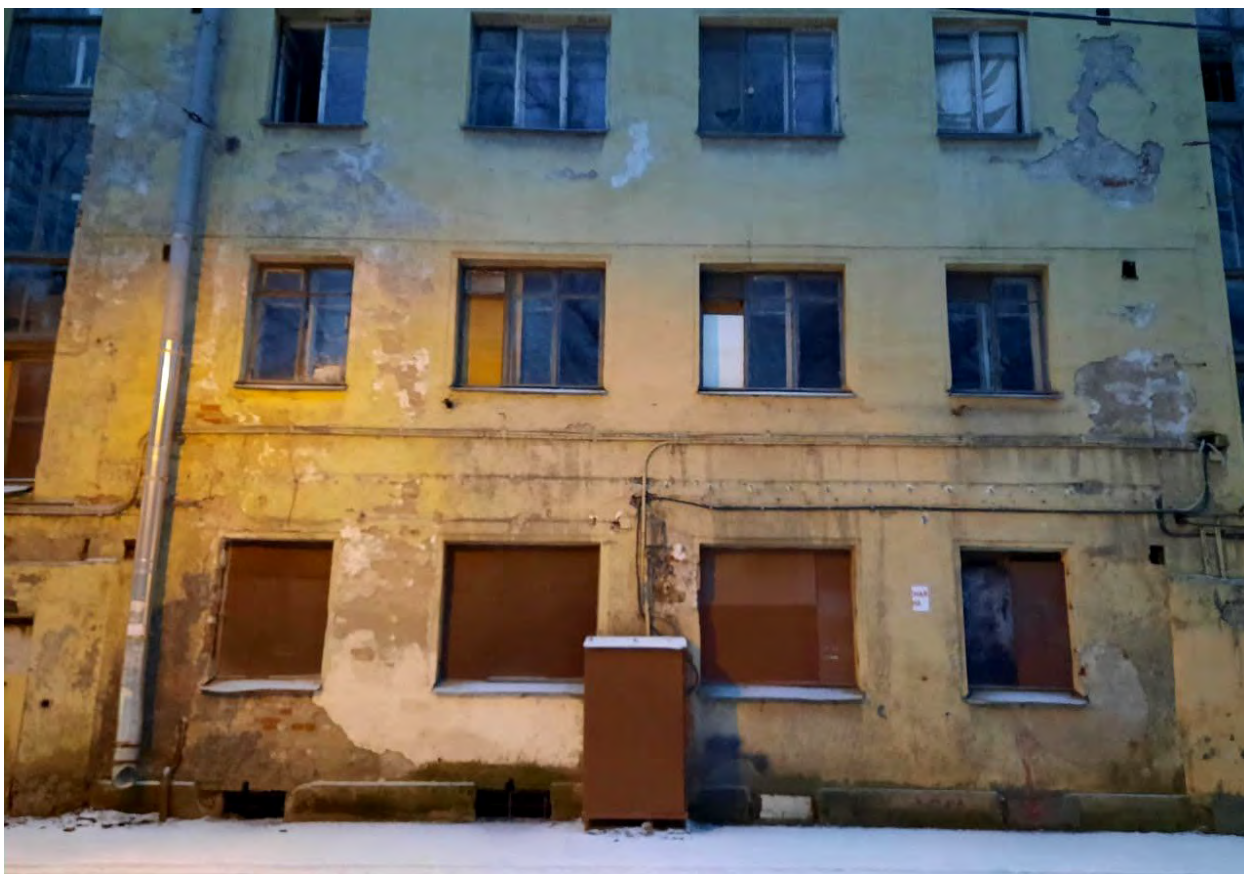
Фото 2.1. Корпус 1. Западный фасад. Вид на существующий кабельный киоск КК №1728.
