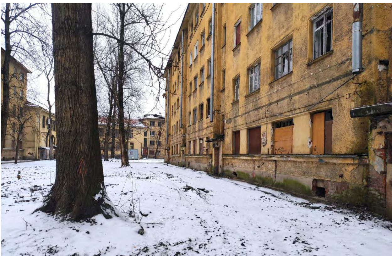
Фото 12. Вид на территорию объекта и здание – д.40, корп.9.
