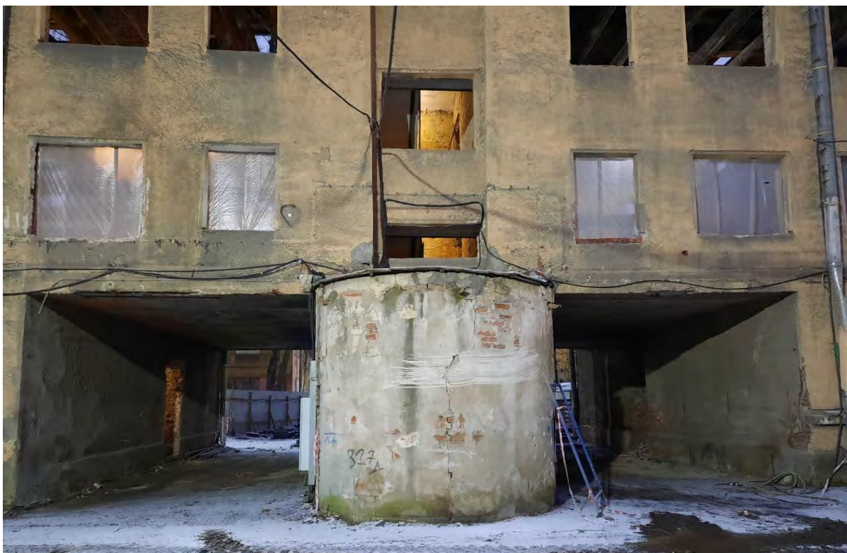
Фото 7.1. Корпус 8. Западный фасад (место размещения проектируемого кабельного киоска запланировано в левой (западной) проездной арке).
