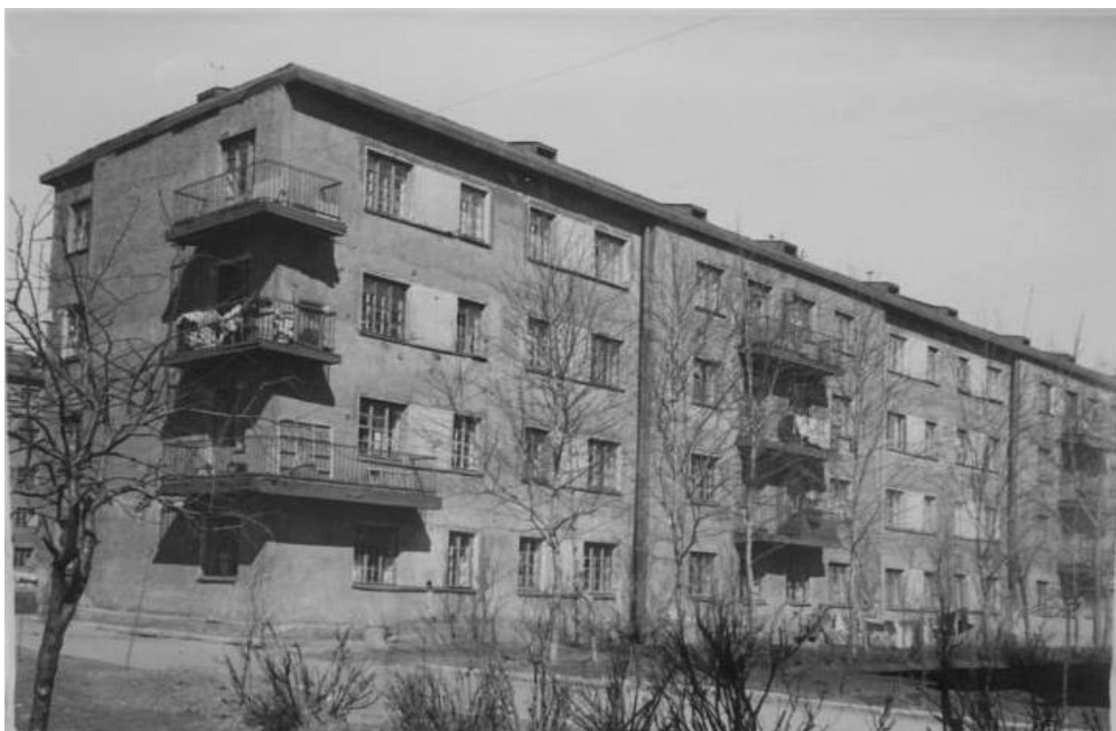
Илл. 2. Кондратьевский жилмассив. Жилой корпус. 1936-1939 гг.
