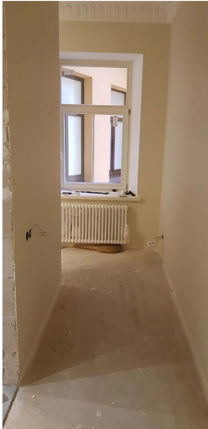
5. Помещение №1 (коридор) кв. №8 в уровне 3-го этажа выявленного объекта культурного наследия «Дом В.А. Квасникова», расположенного по адресу: г. Санкт-Петербург, 7-я линия В.О., д. 28, литера А. 15.09.2020.
