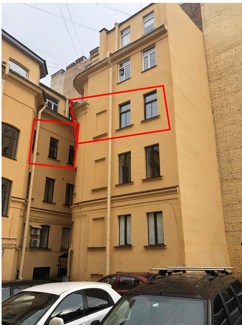
2. Оконные заполнения кв. №8 в уровне 3-го этажа дворового фасада выявленного объекта культурного наследия «Дом В.А. Квасникова», расположенного по адресу: г. Санкт-Петербург, 7-я линия В.О., д. 28, литера А. 15.09.2020
