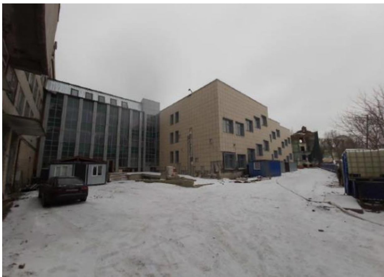
19. Вид на учебно-лабораторный корпус, расположенный по адресу: г. Санкт-Петербург, 1-я Красноармейская улица, д. 13, литера В. 01.12.2021
