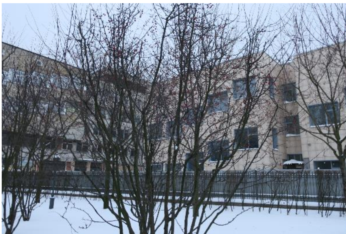
3. Вид на зону производства работ - учебно-лабораторный корпус с территории объекта культурного наследия федерального значения «Сад», расположенного по адресу: г. Санкт-Петербург, наб. реки Фонтанки, д. 118, входящего в состав объекта культурного наследия федерального значения «Усадьба Державина Г.Р.». 01.12.2021
