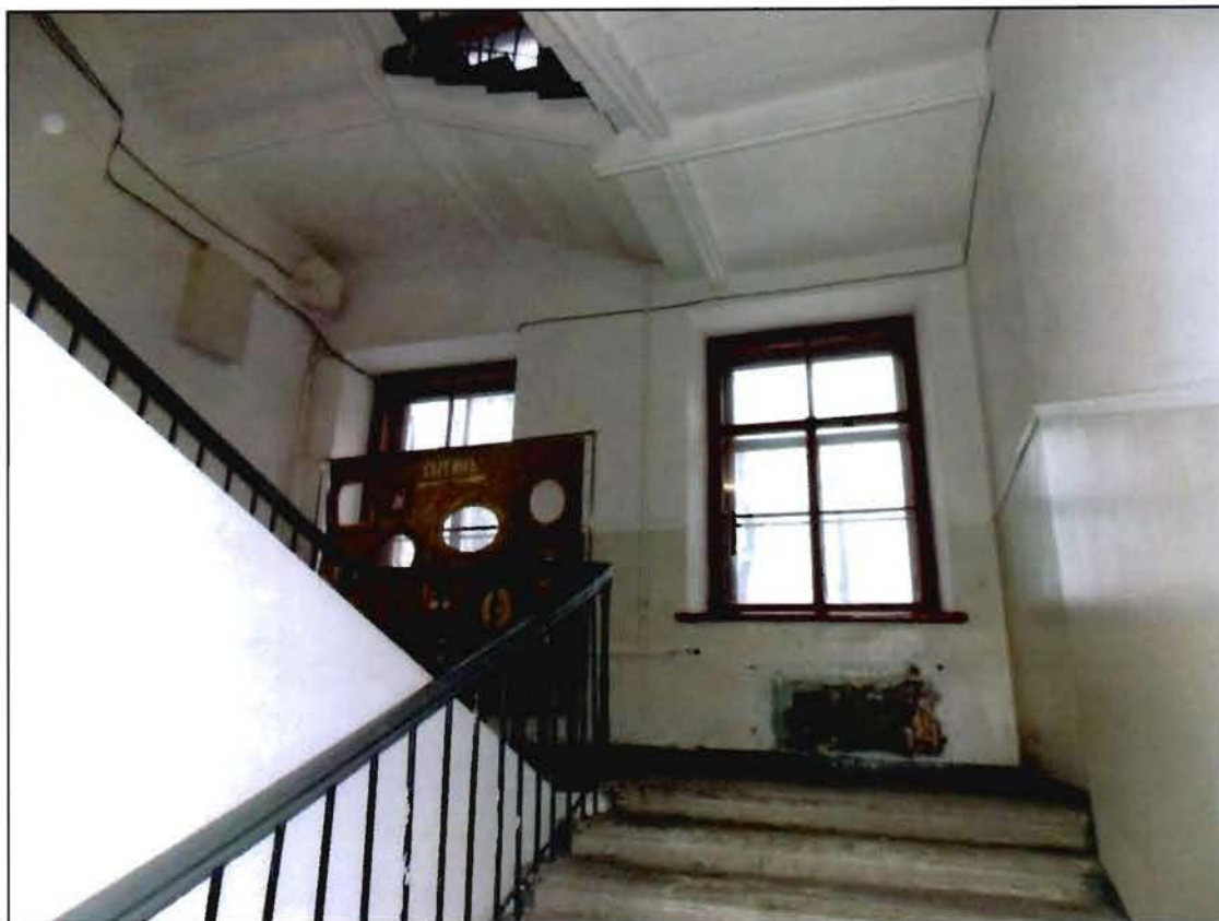
Фото 18. Интерьер. Лестница 7 ЛК.
