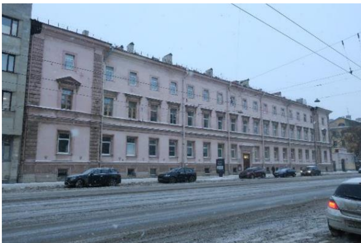
5. Вид на лицевой фасад объекта культурного наследия регионального значения «Здание Консistorского управления Могилевской Римской-католической архиепархии с костелом Успения Девы Марии (Духовная семинария Римско-католической архиепархии)», расположенного по адресу: г. Санкт-Петербург, 1-я Красноармейская д. 11, лит. А. 01.12.2021
