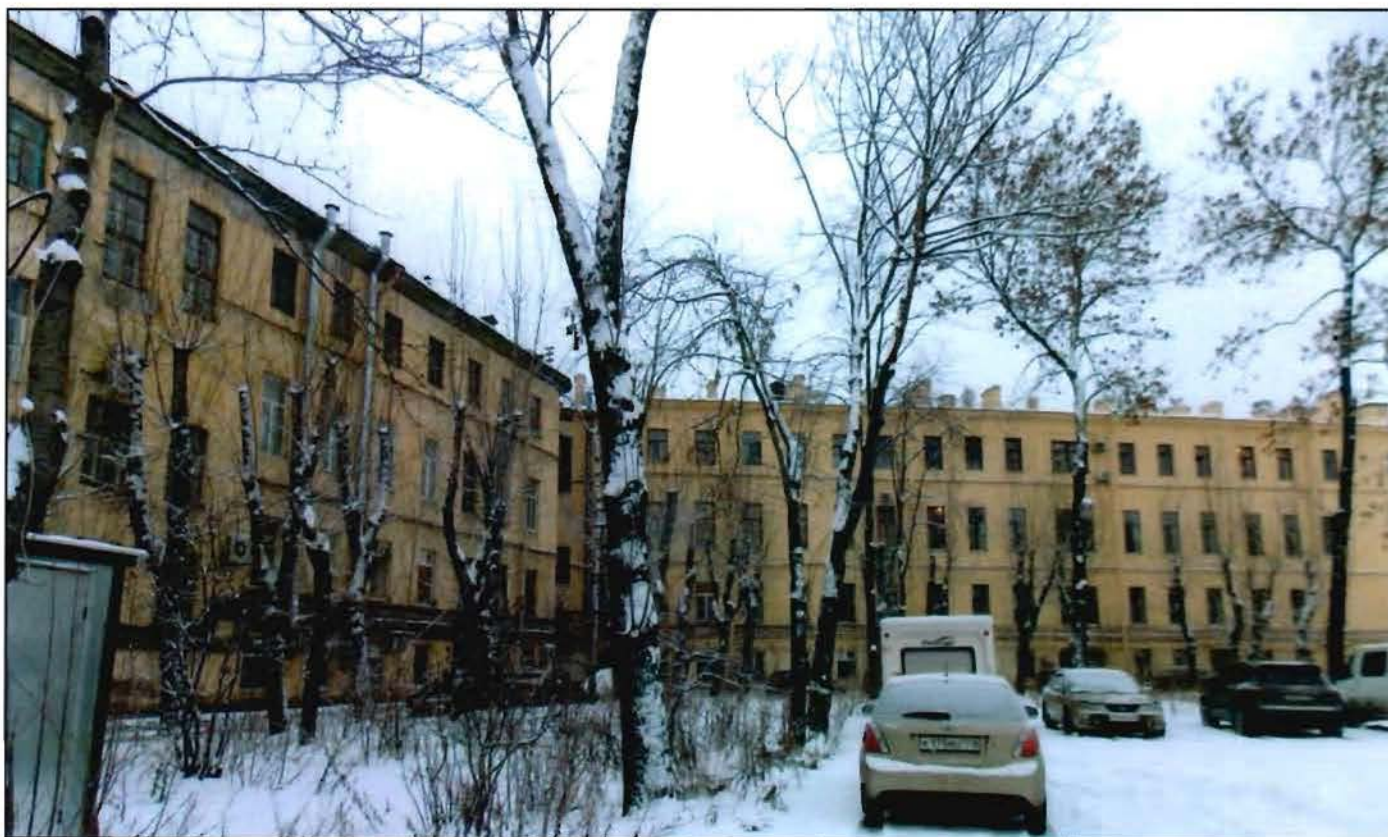
Фото 14. Фрагмент дворового фасада.
