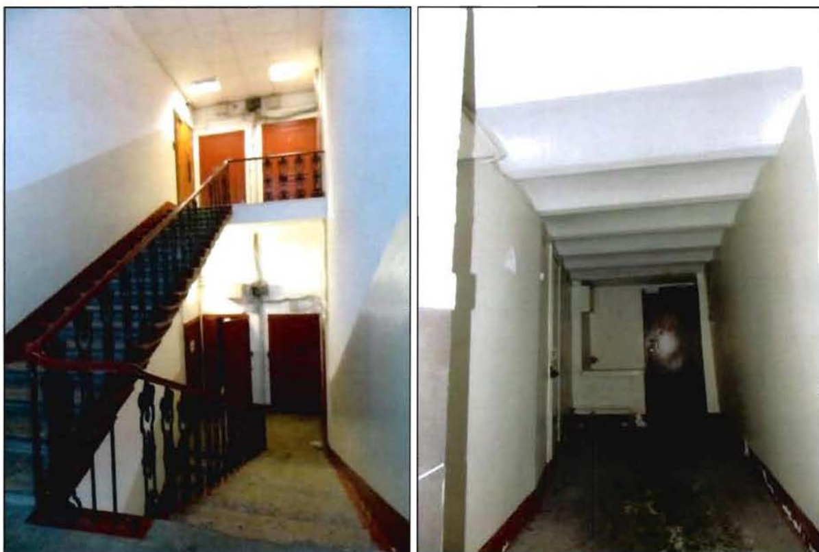
Фото 15-16. Интерьер. Лестница 3 ЛК.
