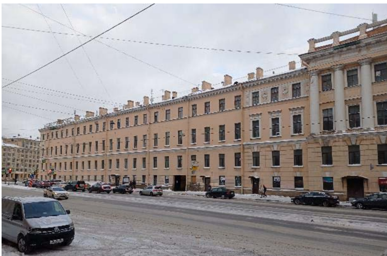
11. Вид на западный лицевой фасад объекта культурного наследия регионального значения «Офицерская казарма лейб-гвардии Измайловского полка (бывший дом М.А. Гарновского)», расположенного по адресу: г. Санкт-Петербург, Измайловский пр., д. 2, лит. А. 01.12.2021
