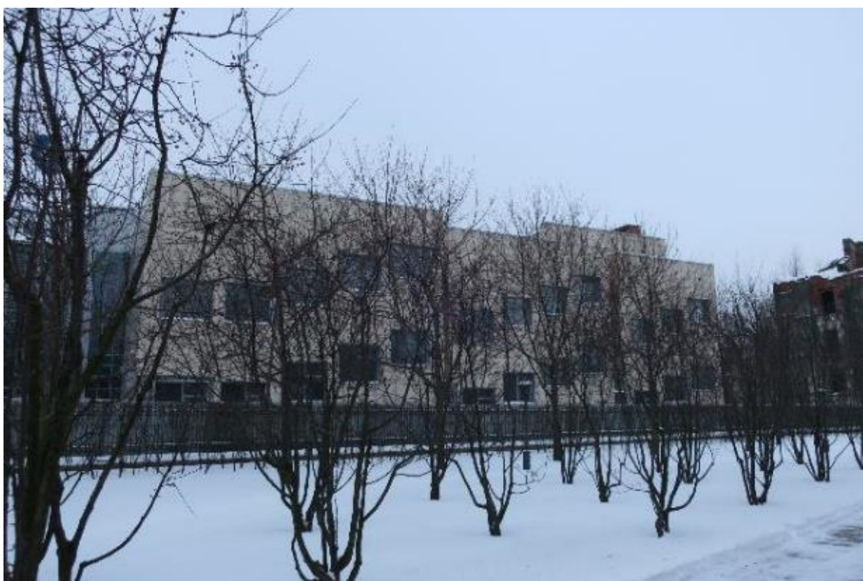
2. Вид на зону производства работ - учебно-лабораторный корпус с территории объекта культурного наследия федерального значения «Сад», расположенного по адресу: г. Санкт-Петербург, наб. реки Фонтанки, д. 118, входящего в состав объекта культурного наследия федерального значения «Усадьба Державина Г.Р.». 01.12.2021
