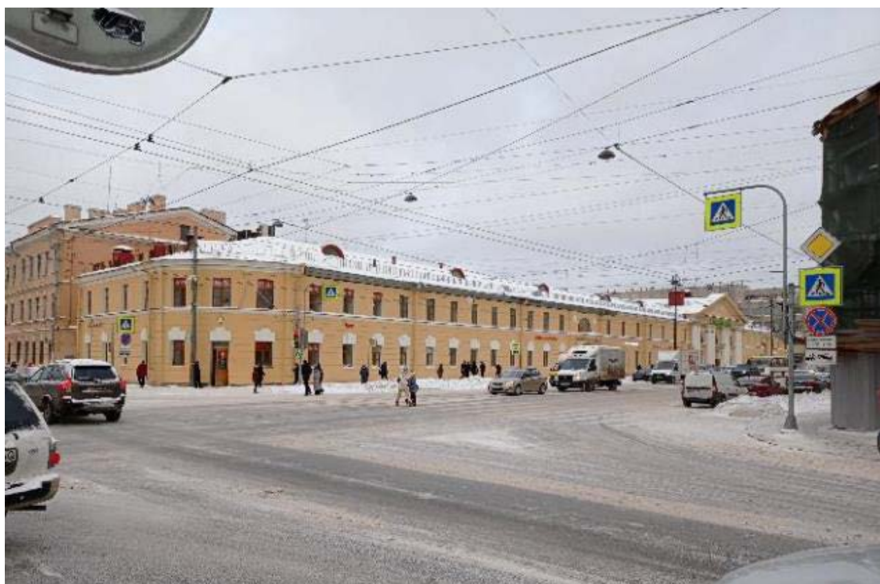
7. Вид на лицевой фасад объекта культурного наследия регионального значения «Здание манежа (экзерциргауса) лейб-гвардии Измайловского полка» по адресу: г. Санкт-Петербург, 1-я Красноармейская д. 15, лит. А. 01.12.2021
