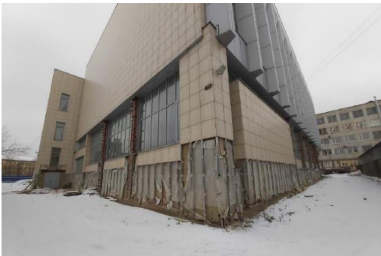
17. Вид на учебно-лабораторный корпус, расположенный по адресу: г. Санкт-Петербург, 1-я Красноармейская улица, д. 13, литера В. 01.12.2021
