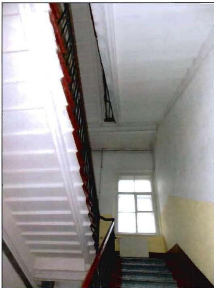
Фото 20. Интерьер. Лестница 14 ЛК.
