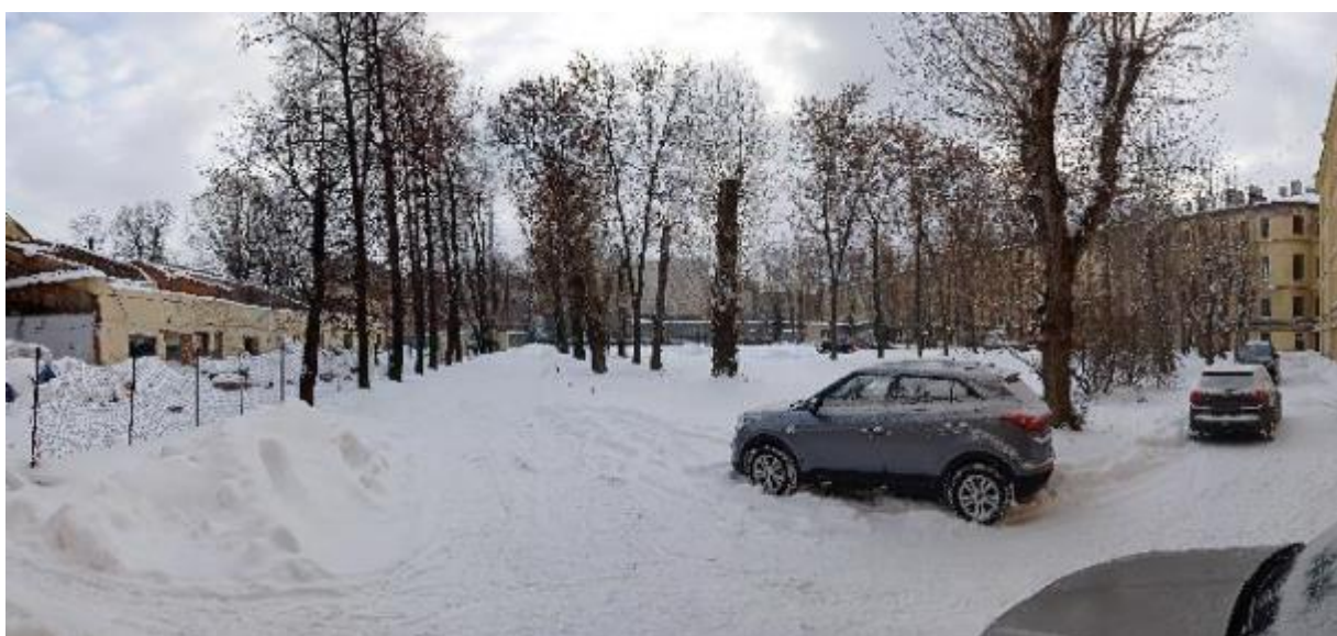
12. Вид на дворовый фасад объекта культурного наследия регионального значения «Офицерская казарма лейб-гвардии Измайловского полка (бывший дом М.А. Гарновского)», расположенного по адресу: г. Санкт-Петербург, Измайловский пр., д. 2, лит. А, и учебно-лабораторный корпус. 01.12.2021
