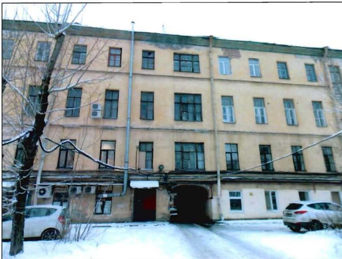
Фото 13. Фрагмент дворового фасада.
