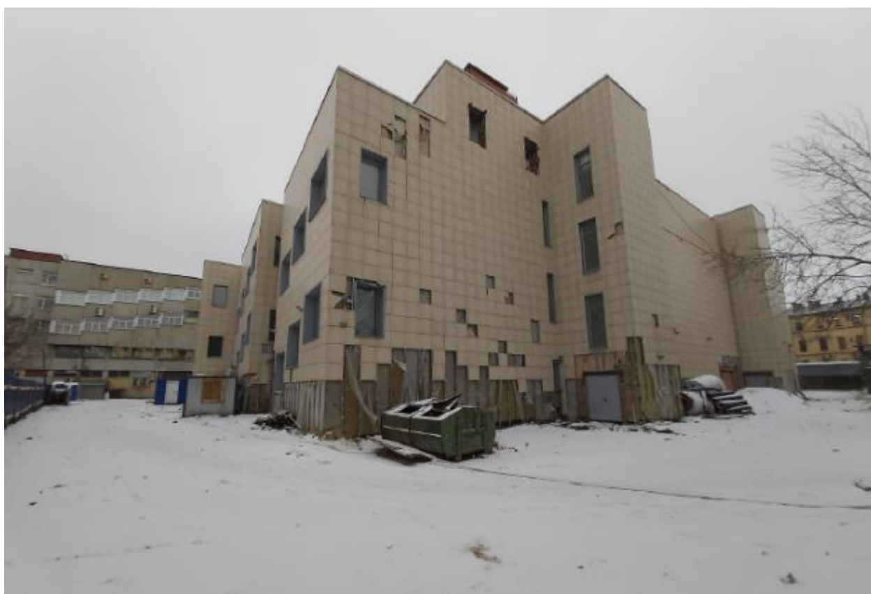
16. Вид на учебно-лабораторный корпус, расположенный по адресу: г. Санкт-Петербург, 1-я Красноармейская улица, д. 13, литера В. 01.12.2021
