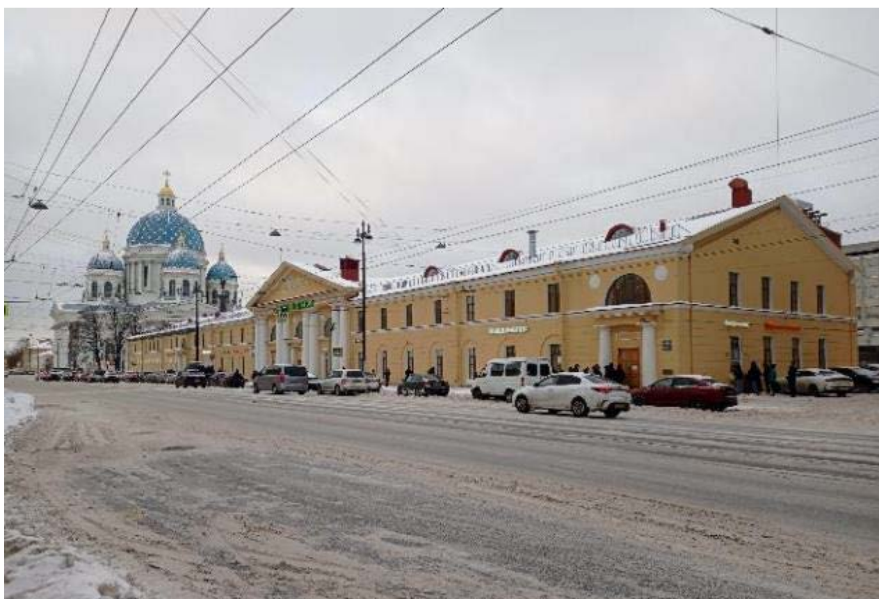
6. Вид на лицевой фасад объекта культурного наследия регионального значения «Здание манежа (экзерциргауса) лейб-гвардии Измайловского полка» по адресу: г. Санкт-Петербург, 1-я Красноармейская д. 15, лит. А. 01.12.2021
