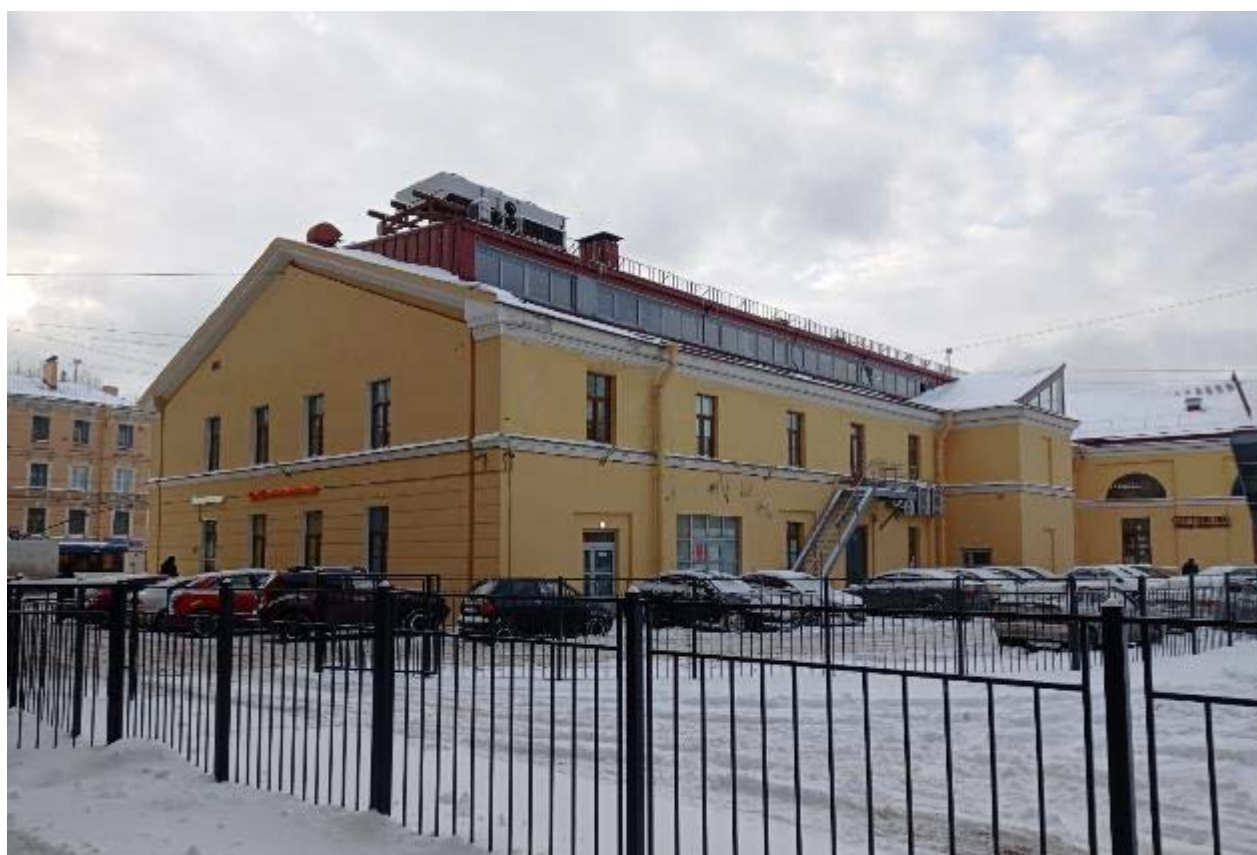
9. Вид на дворовые фасады объекта культурного наследия регионального значения «Здание манежа (экзерциргауса) лейб-гвардии Измайловского полка» по адресу: г. Санкт-Петербург, 1-я Красноармейская д. 15, лит. А. 01.12.2021
