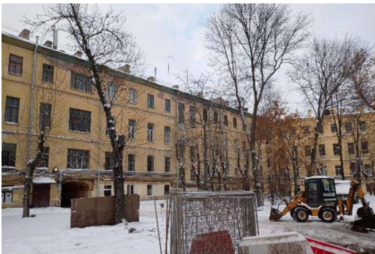
14. Вид на дворовый фасад объекта культурного наследия регионального значения «Офицерская казарма лейб-гвардии Измайловского полка (бывший дом М.А. Гарновского)», расположенного по адресу: г. Санкт-Петербург, Измайловский пр., д. 2, лит. А. 01.12.2021
