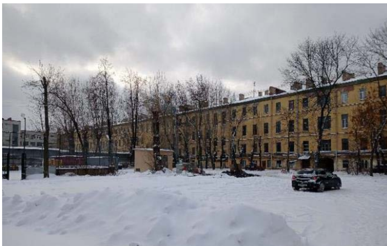
13. Вид на дворовый фасад объекта культурного наследия регионального значения «Офицерская казарма лейб-гвардии Измайловского полка (бывший дом М.А. Гарновского)», расположенного по адресу: г. Санкт-Петербург, Измайловский пр., д. 2, лит. А, и учебно-лабораторный корпус. 01.12.2021
