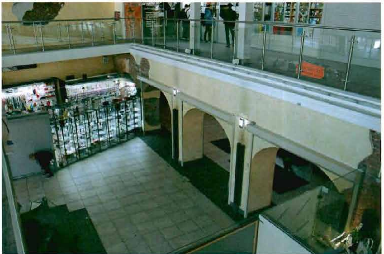
Фото №6. Галерея на опорных пилонах центрального зала.
