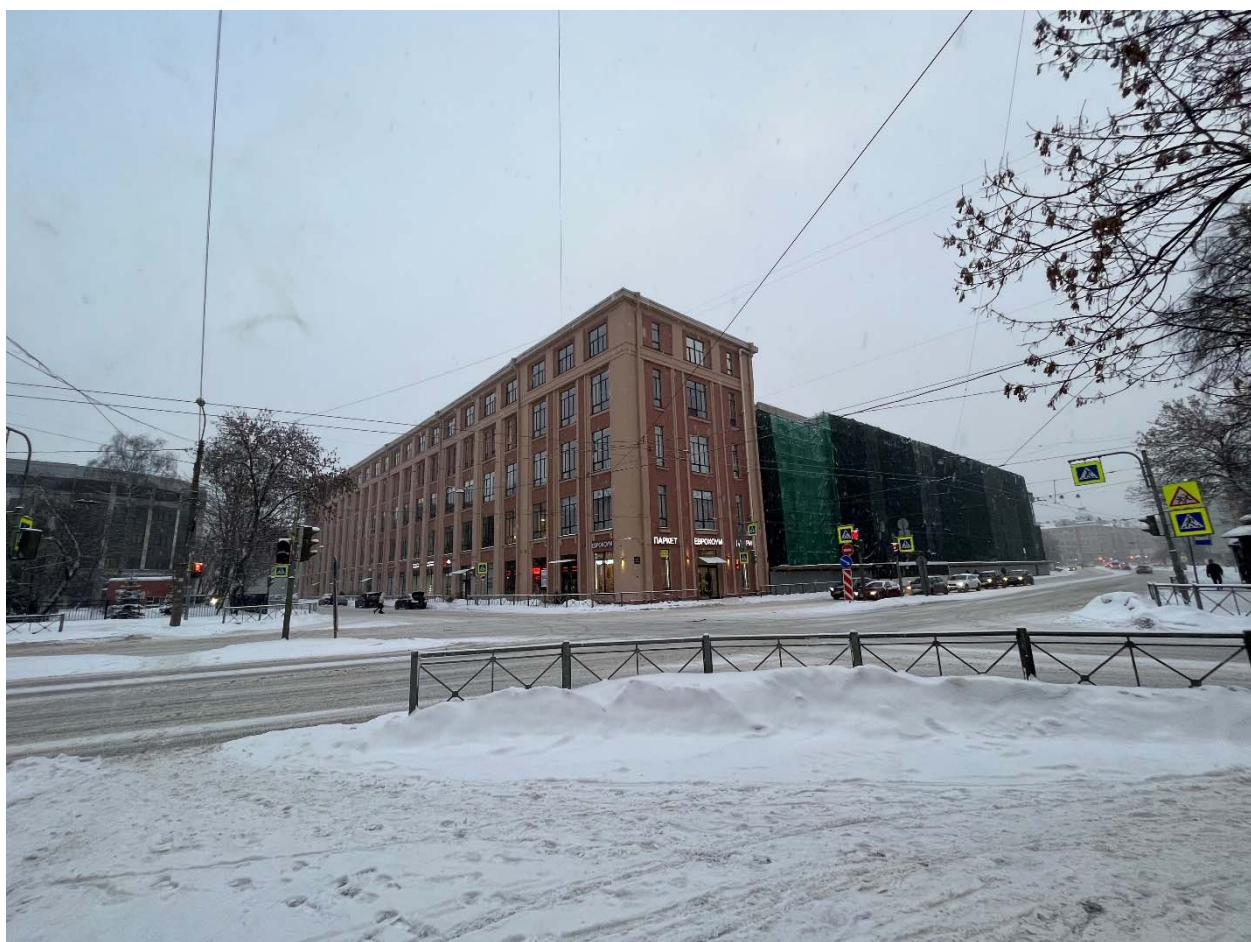
Фото №1. Общий вид здания по пр. Медиков, д. 7, лит. Ж (объекта незавершенного строительства).
