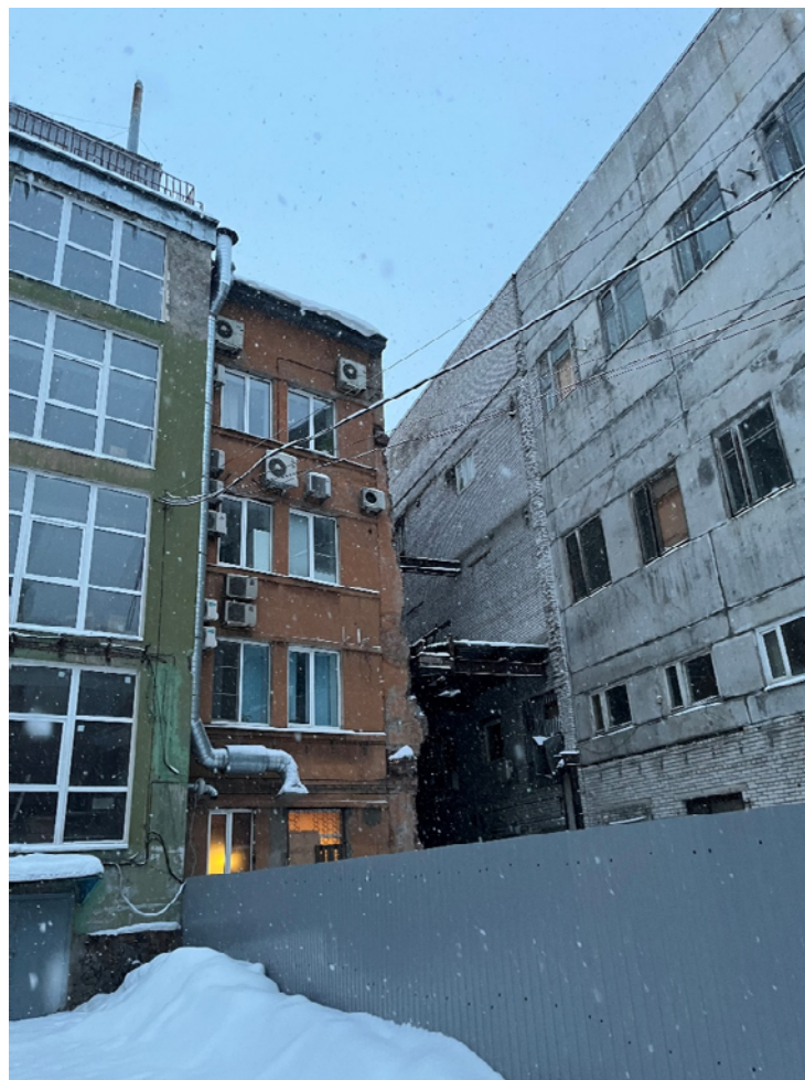
Фото №12. Место примыкания выявленного объекта культурного наследия «Здание Полиграфмаша» по адресу: пр. Медиков, д. 5, лит. В к зданию по пр. Медиков, д. 7, лит. Ж (объекта незавершенного строительства) со стороны двора.
