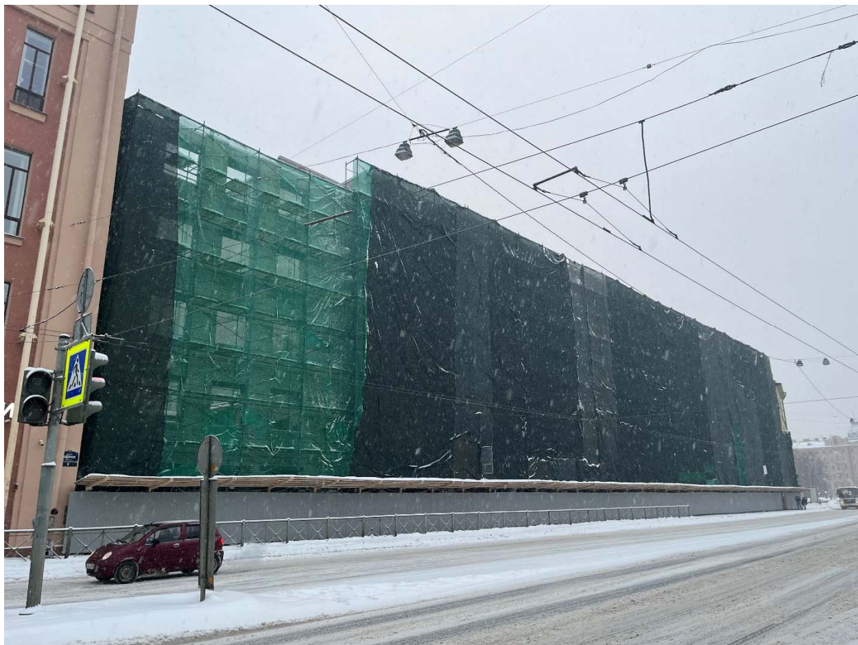
Фото №2. Лицевой фасад здания по пр. Медиков, д. 7, лит. Ж (объекта незавершенного строительства).
