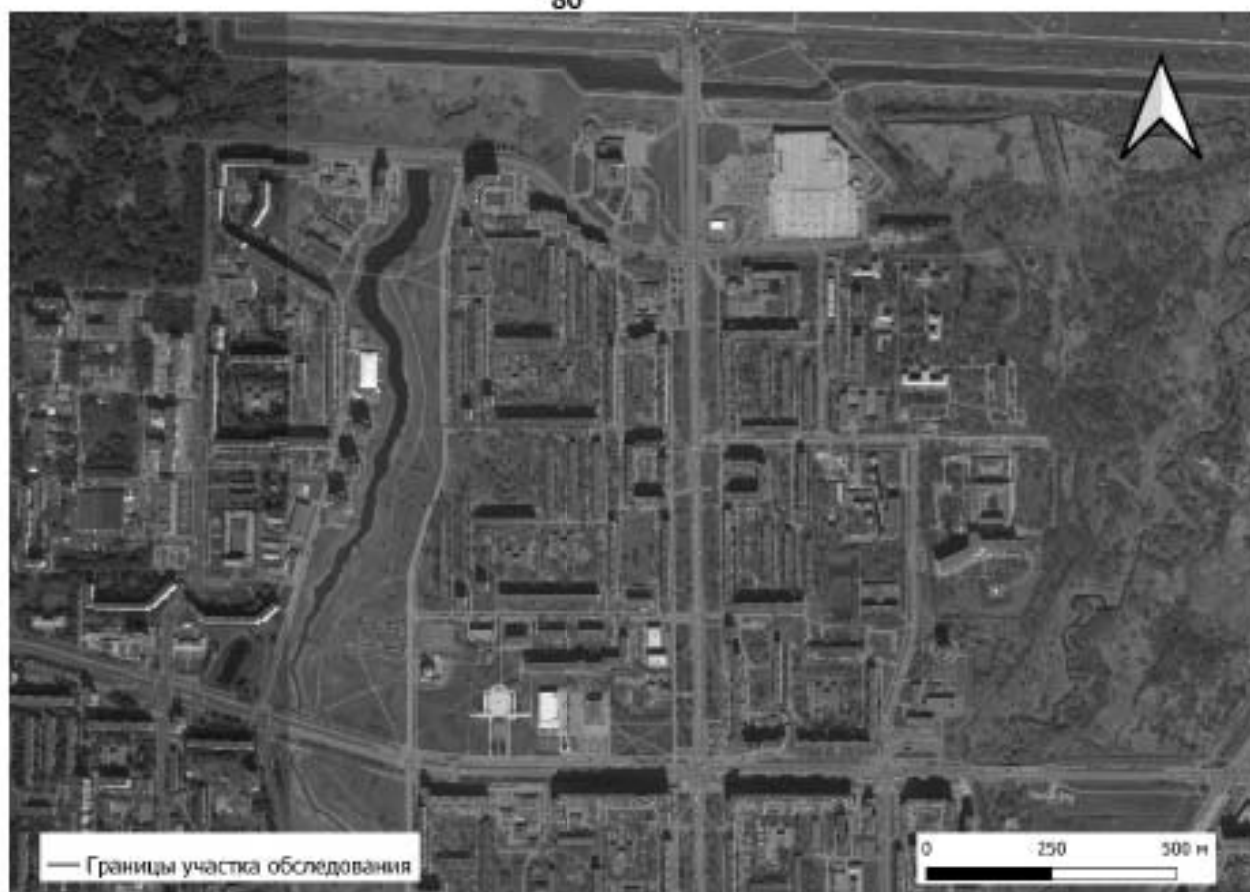
Рис. 3. Санкт-Петербург, Улица Добровольцев, участок 1, (юго-восточнее пересечения с Андреевским переулком) (кадастровый номер: 78:40:0008454:22). Расположение участка обследования на спутниковом снимке (Yandex)
