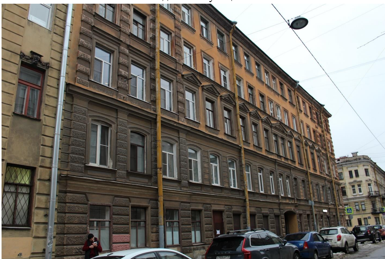
Фото 20. Вид на фасад лицевого корпуса объекта культурного наследия регионального значения «Дом, где в 1893-1894 гг. бывал Ленин В.И.» по Подольской улице.
