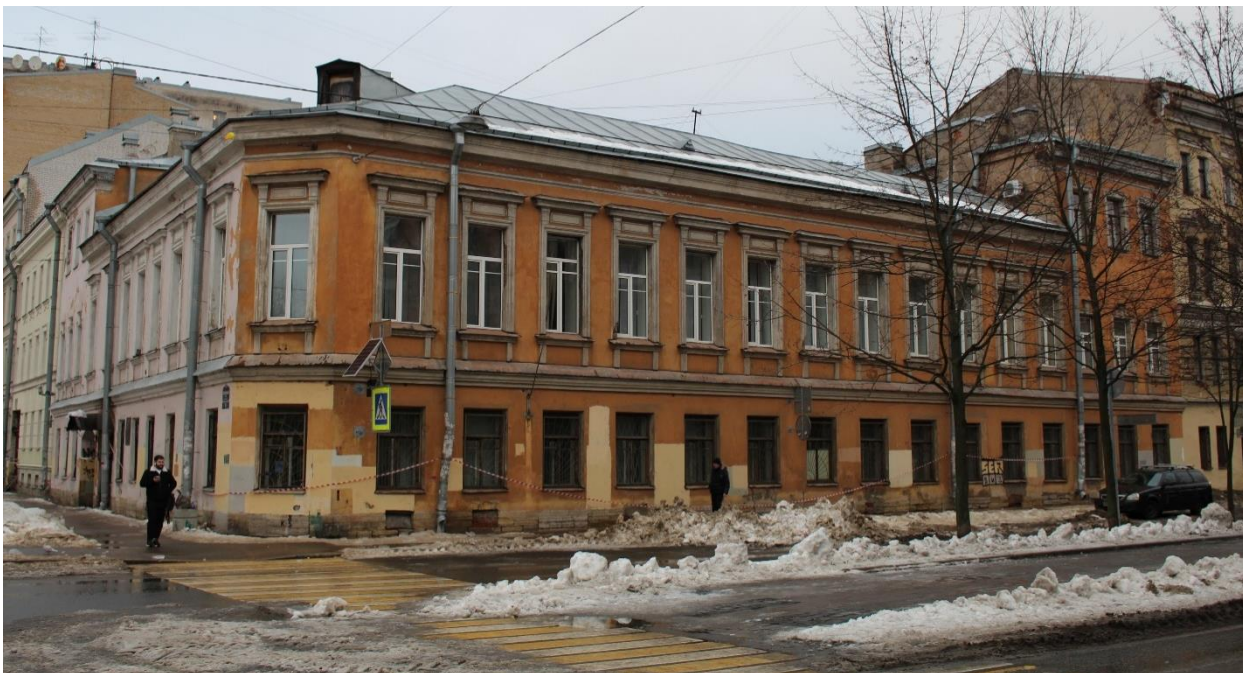
Фото 13. Вид на фасад лицевого корпуса выявленного объекта культурного наследия «Особняк и зрительный зал А.Н. Виноградова» по Малодетскосельскому проспекту.
