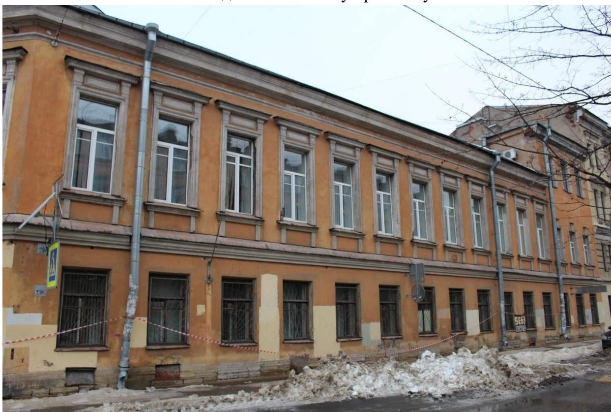
Фото 14. Вид на фасад лицевого корпуса выявленного объекта культурного наследия «Особняк и зрительный зал А.Н. Виноградова» по Малодетскосельскому проспекту.
