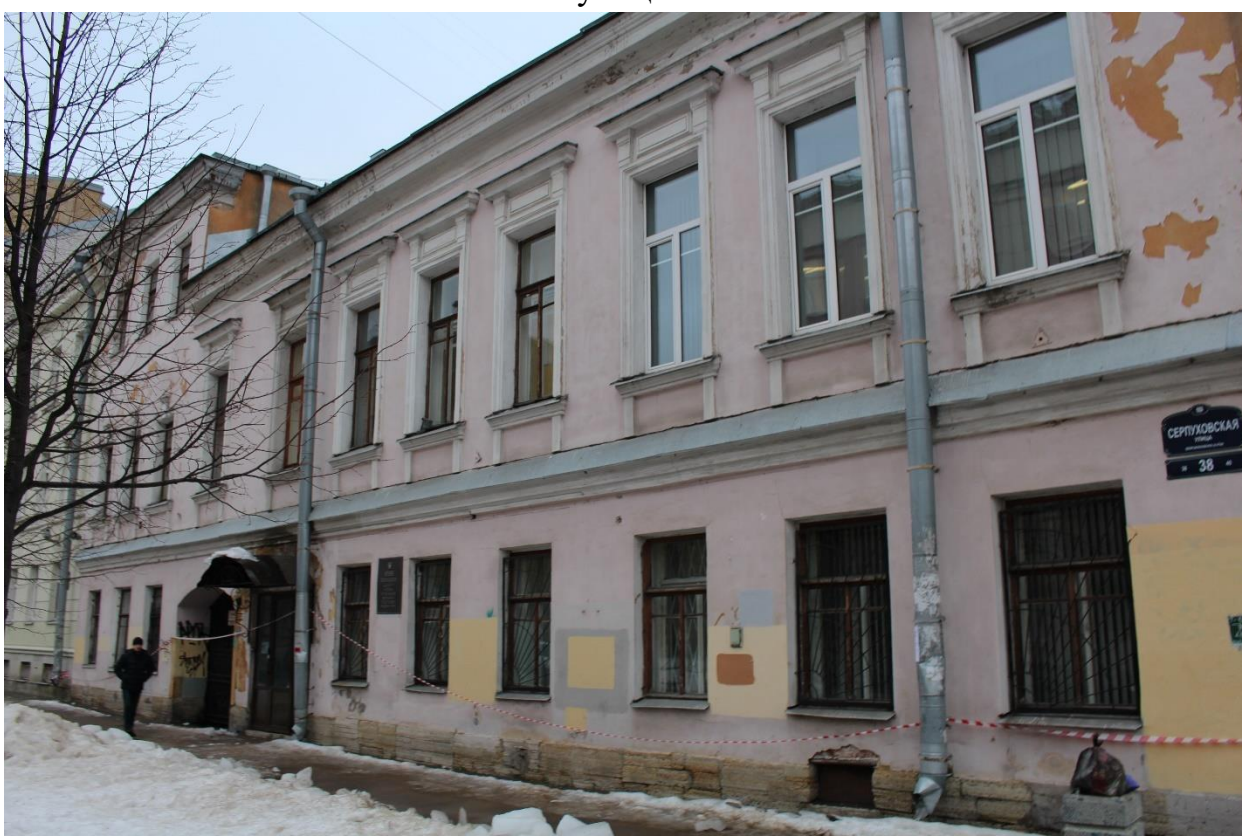
Фото 12. Вид на фасад лицевого корпуса выявленного объекта культурного наследия «Особняк и зрительный зал А.Н. Виноградова» по Серпуховской улице.
