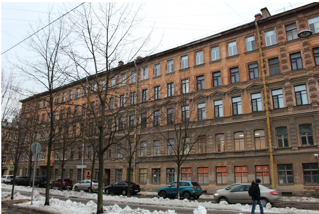
Фото 17. Вид на фасад лицевого корпуса объекта культурного наследия регионального значения «Дом, где в 1893-1894 гг. бывал Ленин В.И.» по Малодетскосельскому проспекту.
