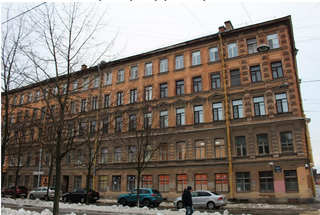
Фото 16. Вид на фасад лицевого корпуса объекта культурного наследия регионального значения «Дом, где в 1893-1894 гг. бывал Ленин В.И.» по Малодетскосельскому проспекту.
