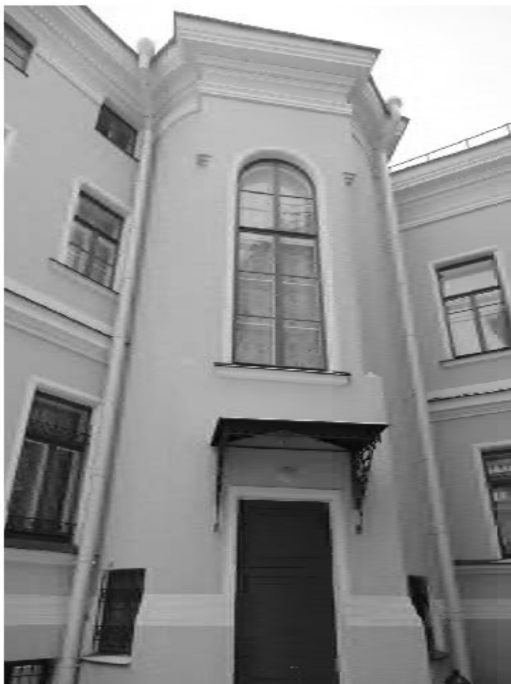
21. ОКН "Усадьба Военного министра", расположенный по адресу: г. Санкт-Петербург, ул. Садовая, д. 4, лит. А. Дворовый фасад (Особняк). Дата фотофиксации: 17.11.2021
