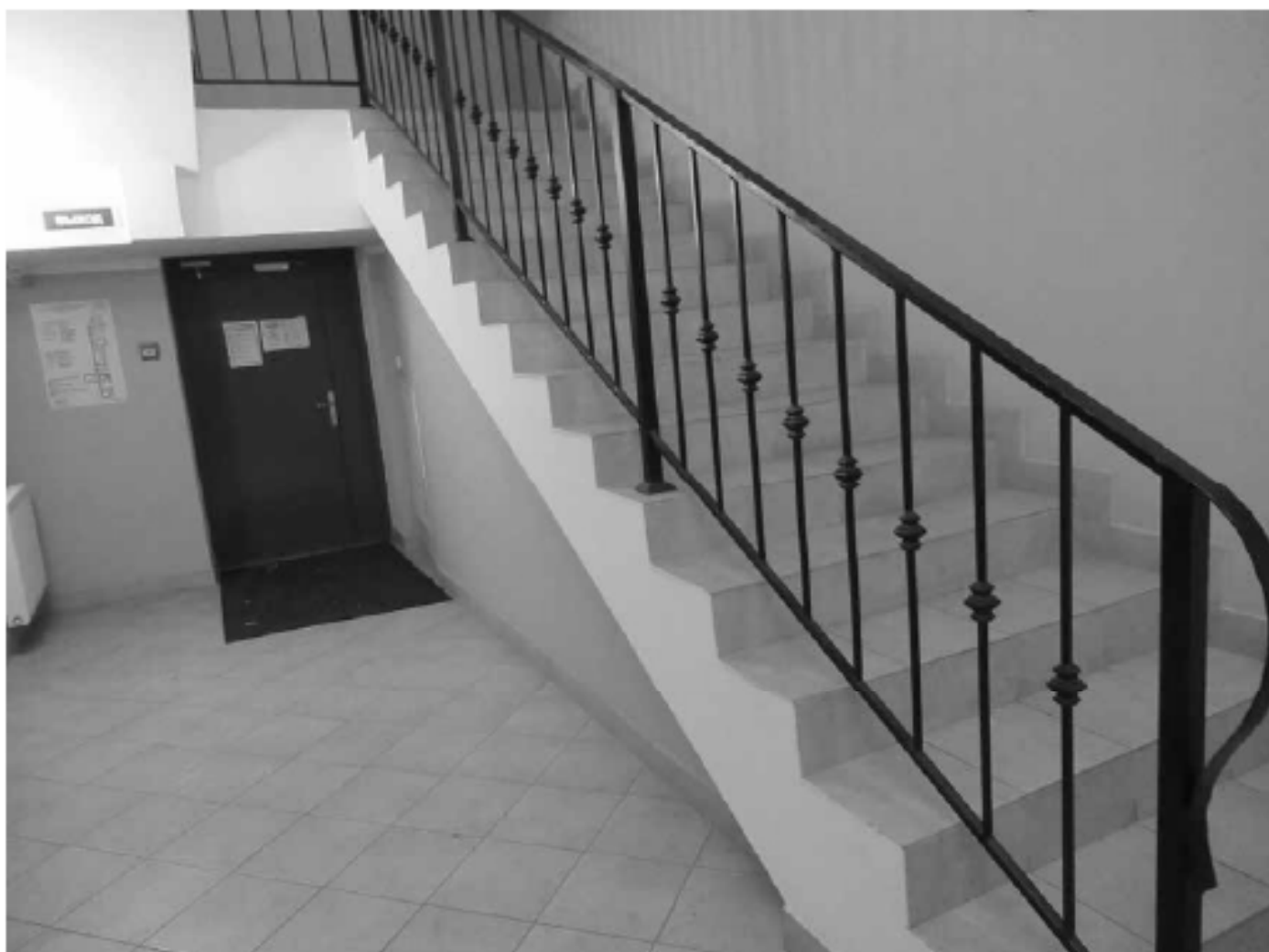
1. ОКН "Усадьба Военного министра", расположенный по адресу: г. Санкт-Петербург, ул. Садовая, д. 4, лит. А. Лестница служебного флигеля. Дата фотофиксации: 17.11.2021
