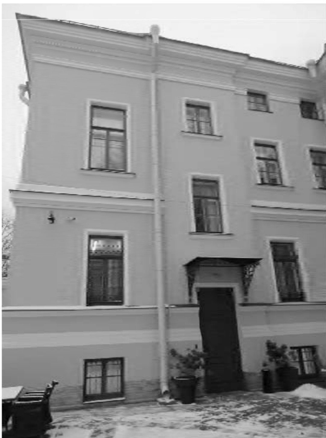
24. ОКН "Усадьба Военного министра", расположенный по адресу: г. Санкт-Петербург, ул. Садовая, д. 4, лит. А. Дворовый фасад (Особняк). Дата фотофиксации: 17.11.2021
