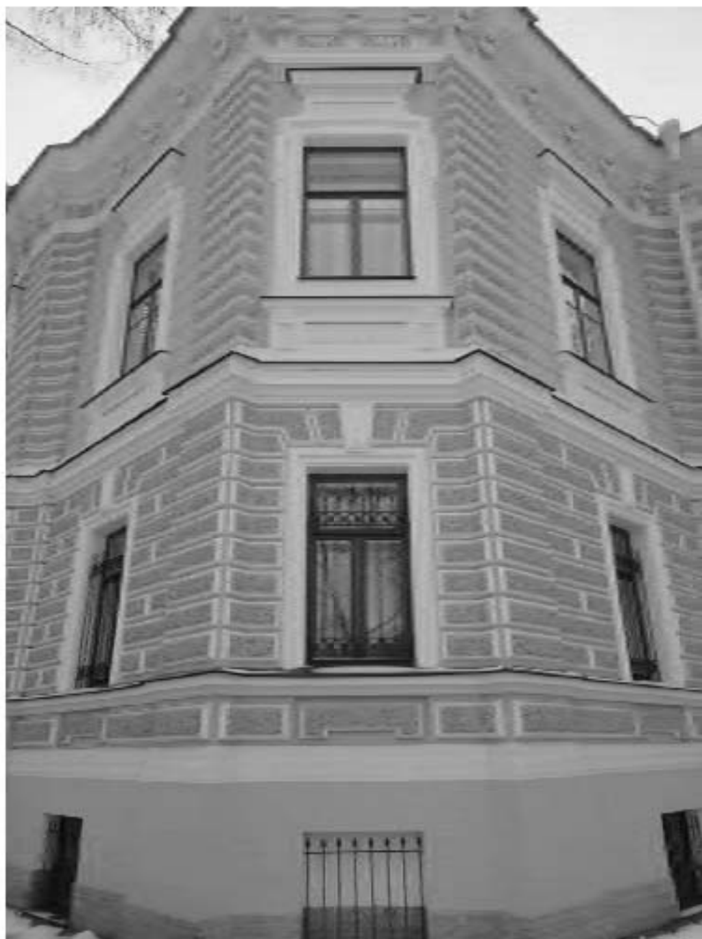
13. ОКН “Усадьба Военного министра”, расположенный по адресу: г. Санкт-Петербург, ул. Садовая, д. 4, лит. А. Северо-восточный угол здания (Особняк). Дата фотофиксации: 17.11.2021
