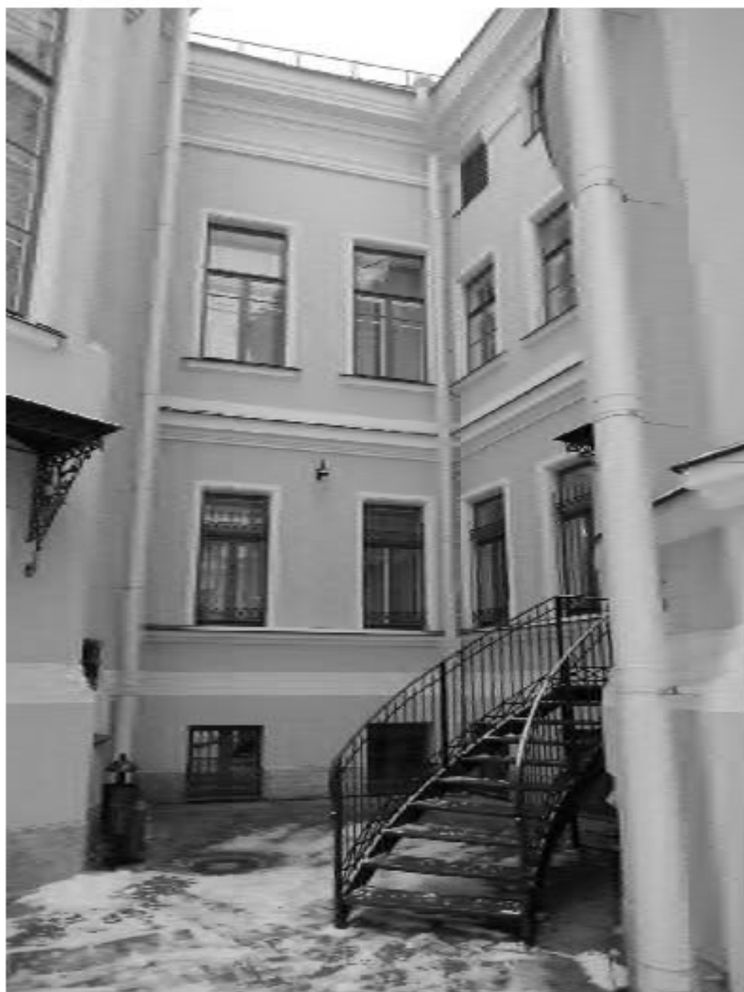
22. ОКН "Усадьба Военного министра", расположенный по адресу: г. Санкт-Петербург, ул. Садовая, д. 4, лит. А. Дворовый фасад (Особняк). Дата фотофиксации: 17.11.2021
