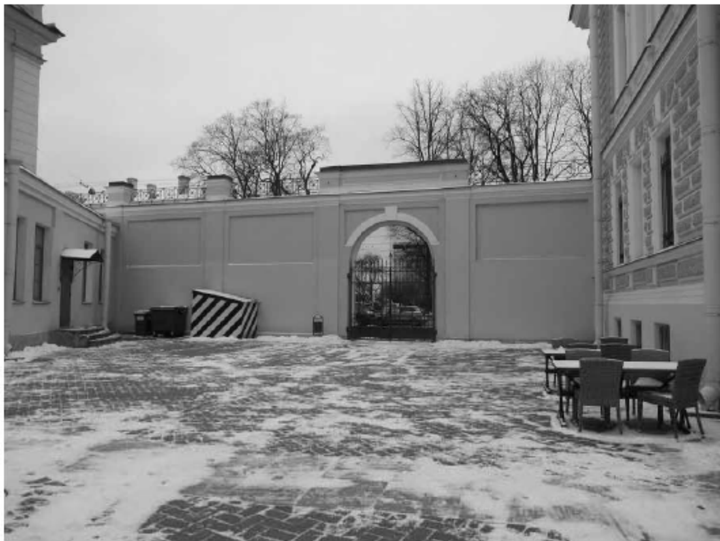
27. ОКН "Усадьба Военного министра", расположенный по адресу: г. Санкт-Петербург, ул. Садовая, д. 4, лит. А. Каменная ограда с воротами (Особняк). Дата фотофиксации: 17.11.2021
