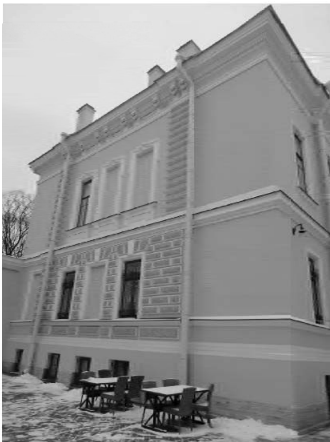
28. ОКН “Усадьба Военного министра”, расположенный по адресу: г. Санкт-Петербург, ул. Садовая, д. 4, лит. А. Дворовый фасад (Особняк). Дата фотофиксации: 17.11.2021
