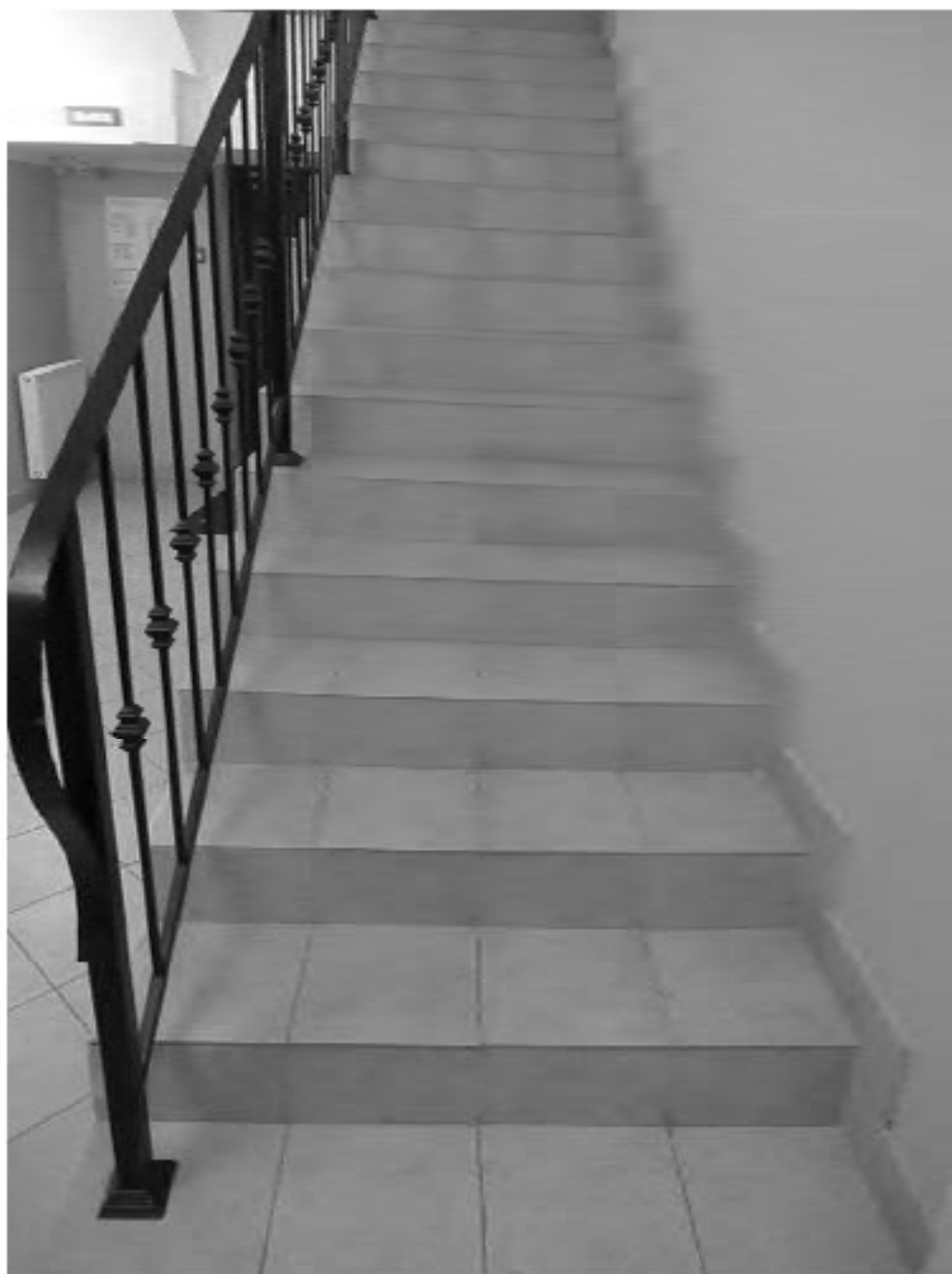
2. ОКН "Усадьба Военного министра", расположенный по адресу: г. Санкт-Петербург, ул. Садовая, д. 4, лит. А. Лестница служебного флигеля. Дата фотофиксации: 17.11.2021
