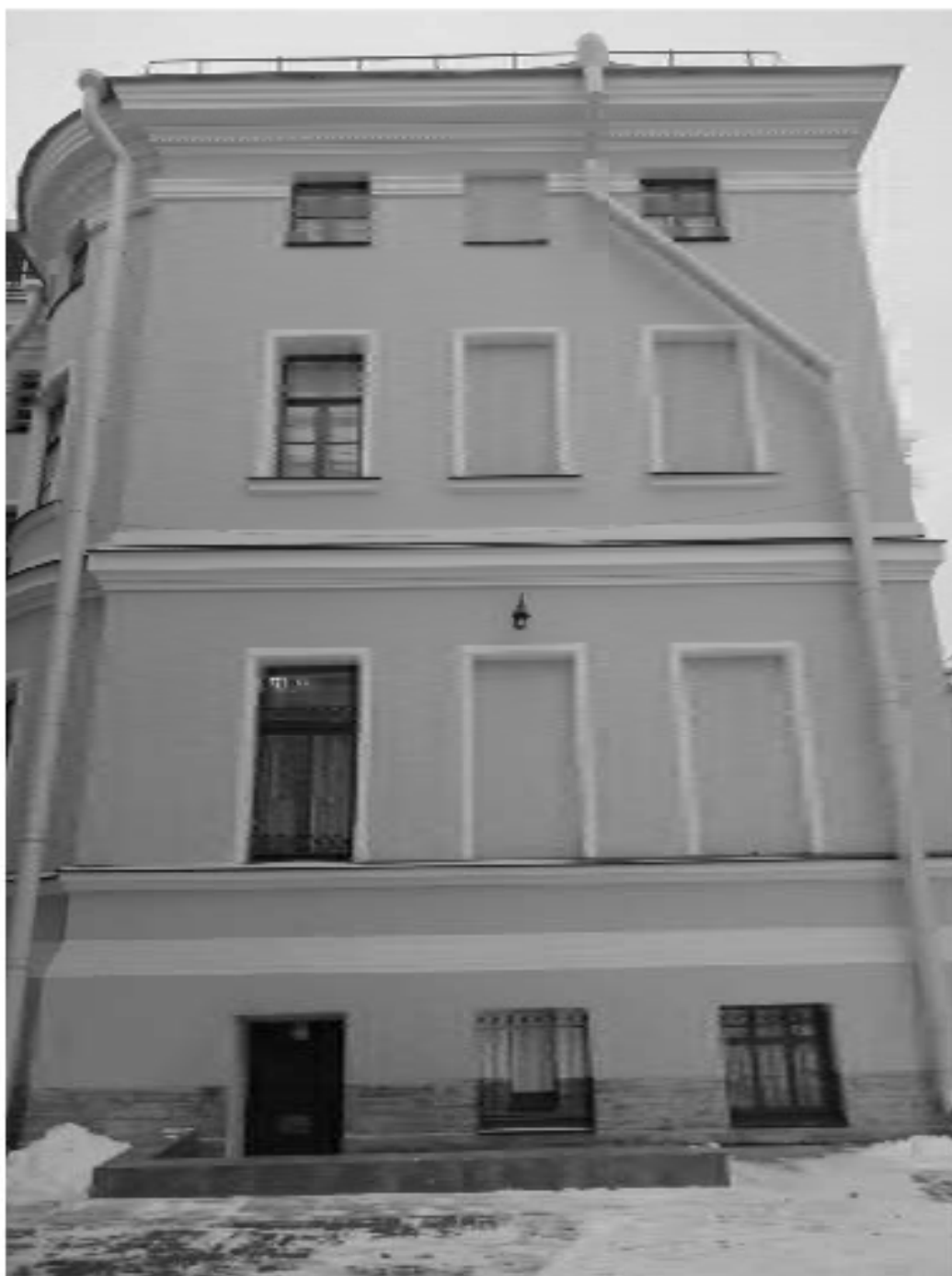
23. ОКН "Усадьба Военного министра", расположенный по адресу: г. Санкт-Петербург, ул. Садовая, д. 4, лит. А. Дворовый фасад (Особняк). Дата фотофиксации: 17.11.2021
