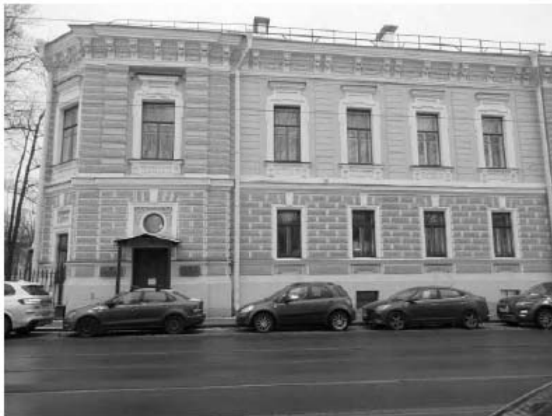
5. ОКН "Усадьба Военного министра", расположенный по адресу: г. Санкт-Петербург, ул. Садовая, д. 4, лит. А. Западный фасад (Особняк). Дата фотофиксации: 17.11.2021
