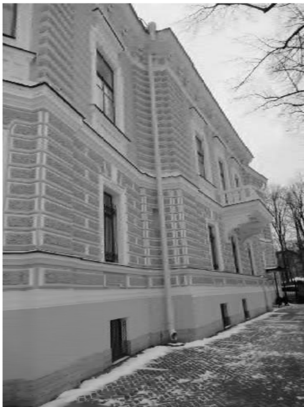
14. ОКН “Усадьба Военного министра”, расположенный по адресу: г. Санкт-Петербург, ул. Садовая, д. 4, лит. А. Северный фасад (Особняк). Дата фотофиксации: 17.11.2021
