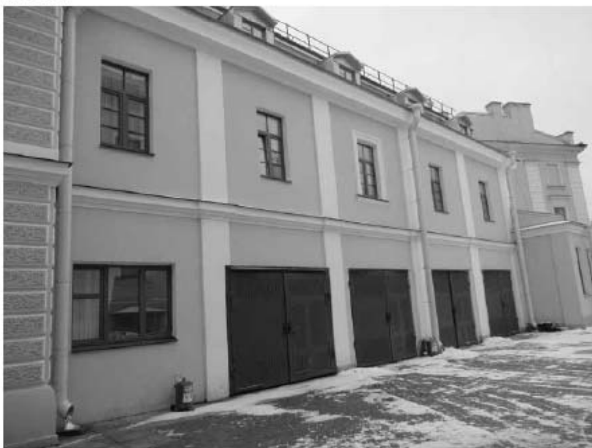
31. ОКН "Усадьба Военного министра", расположенный по адресу: г. Санкт-Петербург, ул. Садовая, д. 4, лит. А. Северный фасад (Флигель служебный). Дата фотофиксации: 17.11.2021
