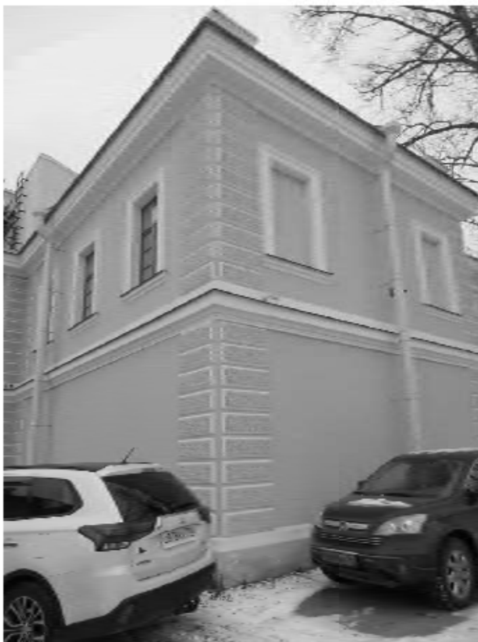
19. ОКН “Усадьба Военного министра”, расположенный по адресу: г. Санкт-Петербург, ул. Садовая, д. 4, лит. А. Восточный фасад (Флигель служебный). Дата фотофиксации: 17.11.2021
