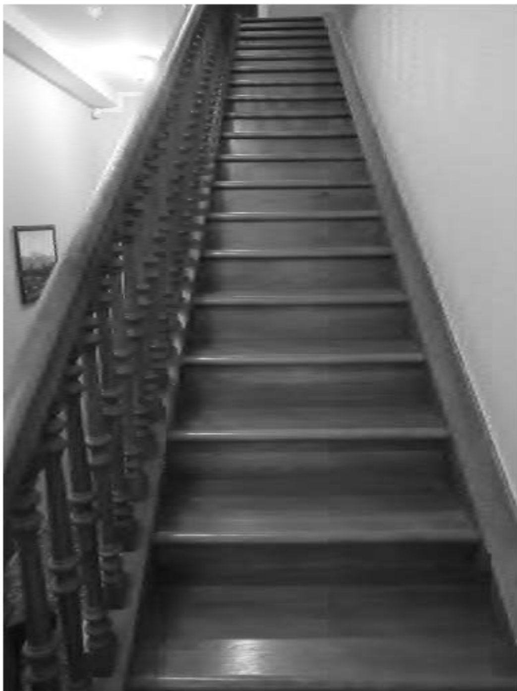
23. ОКН "Усадьба Военного министра", расположенный по адресу: г. Санкт-Петербург, ул. Садовая, д. 4, лит. А. Особняк. Дубовая лестница. Дата фотофиксации: 17.11.2021
