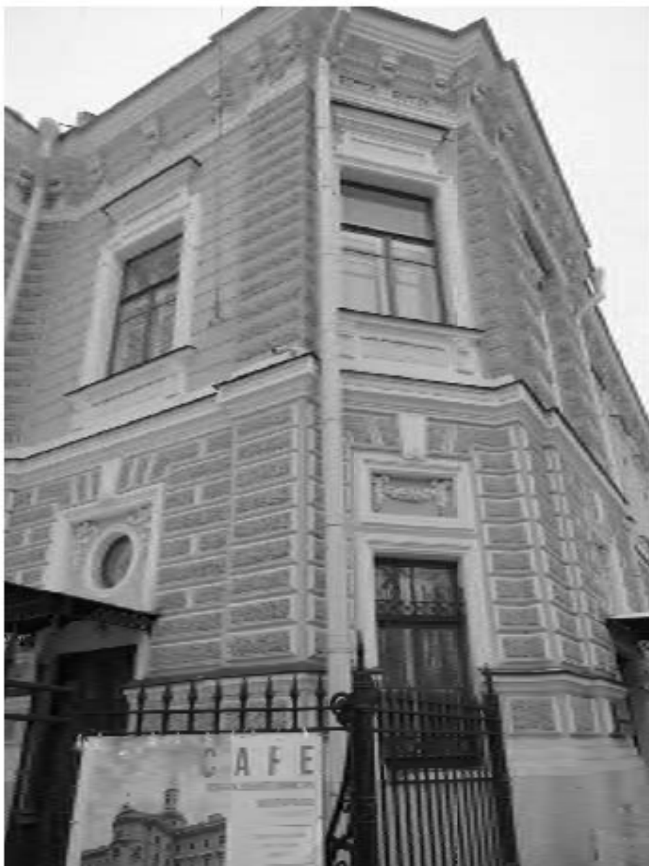
7. ОКН “Усадьба Военного министра”, расположенный по адресу: г. Санкт-Петербург, ул. Садовая, д. 4, лит. А. Северо-западный угол здания. (Особняк). Дата фотофиксации: 17.11.2021
