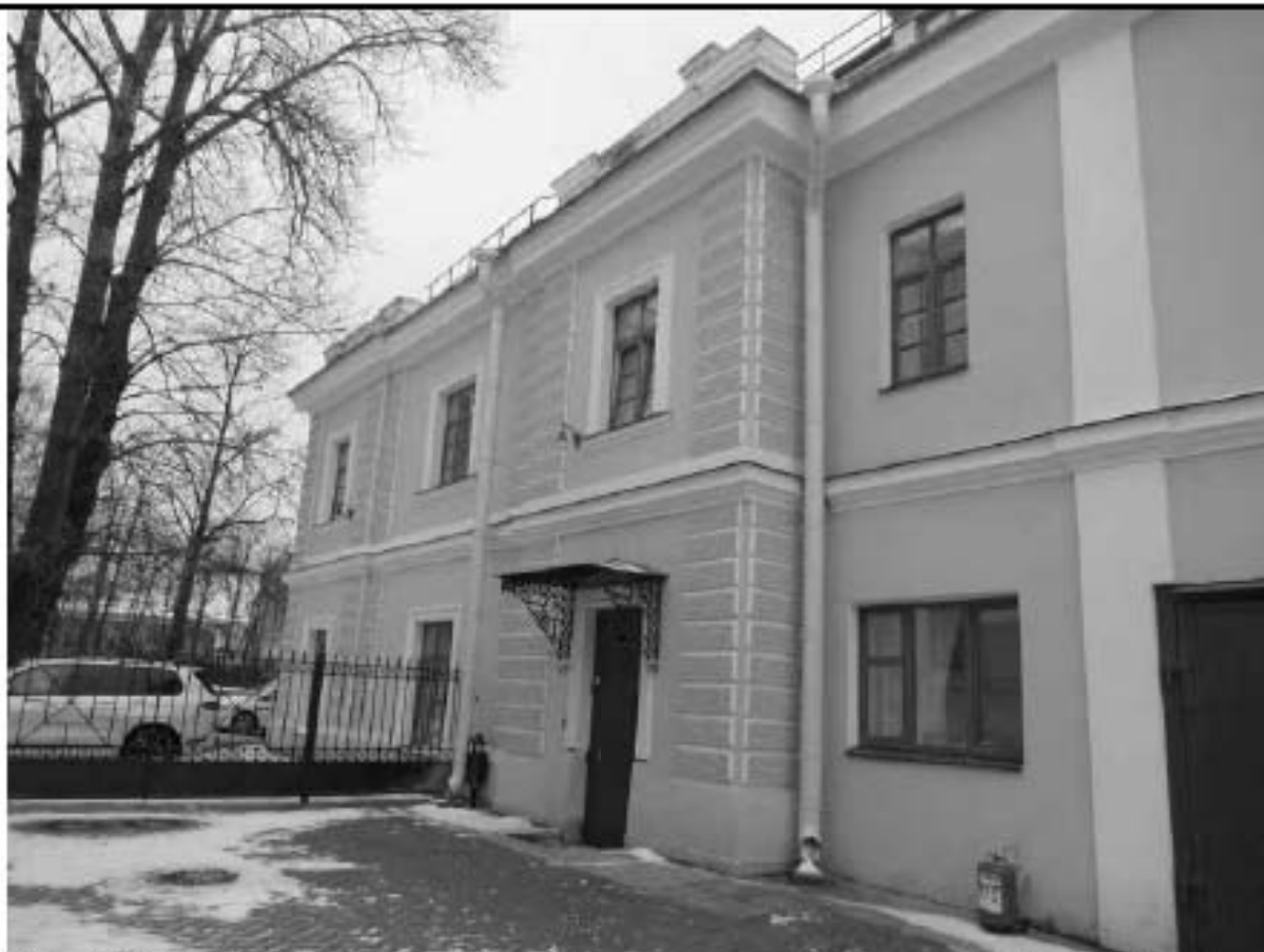
30. ОКН "Усадьба Военного министра", расположенный по адресу: г. Санкт-Петербург, ул. Садовая, д. 4, лит. А. Северный фасад (Флигель служебный). Дата фотофиксации: 17.11.2021
