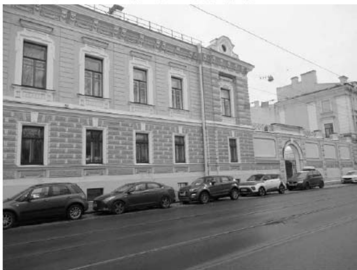
4. ОКН "Усадьба Военного министра", расположенный по адресу: г. Санкт-Петербург, ул. Садовая, д. 4, лит. А. Западный фасад (Обошняк). Дата фотофиксации: 17.11.2021
