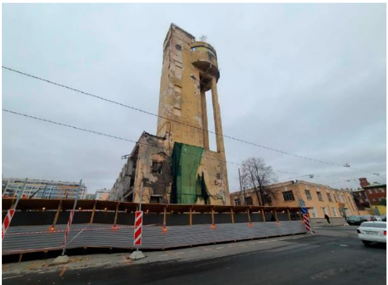
1. Юго-восточный фасад объекта культурного наследия регионального значения «Канатный цех с водонапорной башней завода «Красный гвоздильщик» по адресу: г. Санкт-Петербург, 25-я линия В.О., д. 6, корп. 1, литера Б. 25.10.2021
