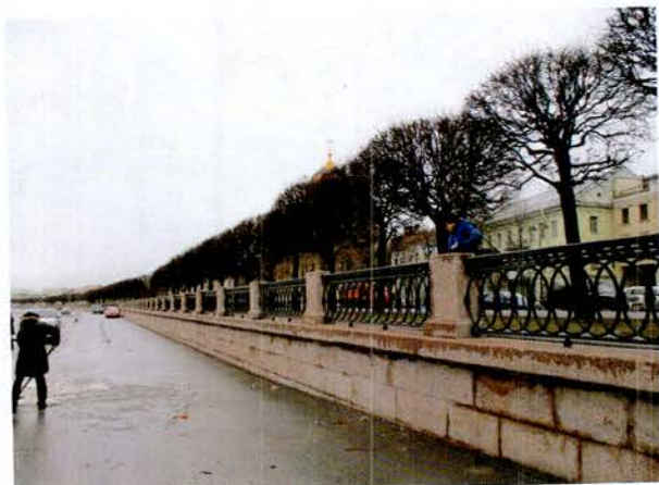
7. Стенка набережной верхнего яруса. Вид с нижнего яруса
