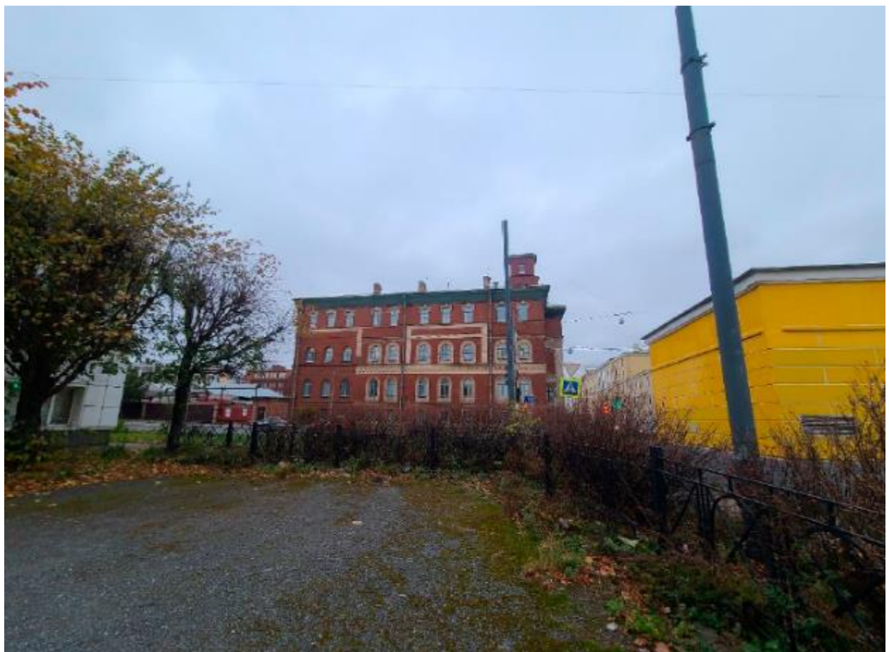
8. Вид на выявленный объект культурного наследия «Здание Главной Геофизической обсерватории при Горном институте» по адресу: г. Санкт-Петербург, 23-я линия В.О., д. 2а, литера А, от зоны производства работ. 25.10.2021
