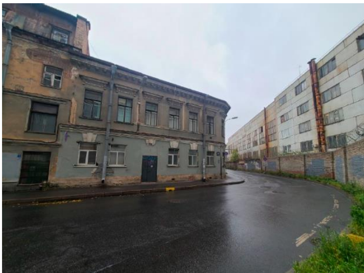
24. Вид на выявленный объект культурного наследия «Кожевенный завод А.А. Парамонова. Особняк владельца», по адресу: г. Санкт-Петербург, Кожевенная линия, д. 1-3, литера Р, от зоны производства работ. 25.10.2021
