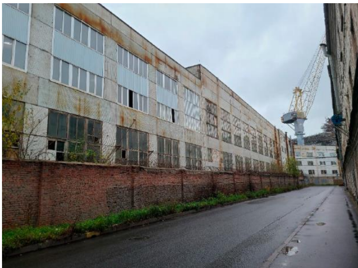
20. Вид от выявленного объекта культурного наследия «Кожевенный завод А.А. Парамонова. Котельная», по адресу: г. Санкт-Петербург, Кожевенная линия, д. 1-3, литера Д, на зону производства работ. 25.10.2021
