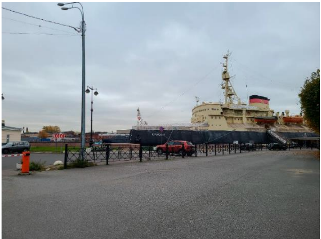
15. Вид на объект культурного наследия федерального значения «Набережная Николаевская (ныне Лейтенанта Шмидта)», г. Санкт-Петербург, участок набережной реки Невы- «мост Лейтенанта Шмидта-23-я линия В.О.», литера А, от зоны производства работ. 25.10.2021
