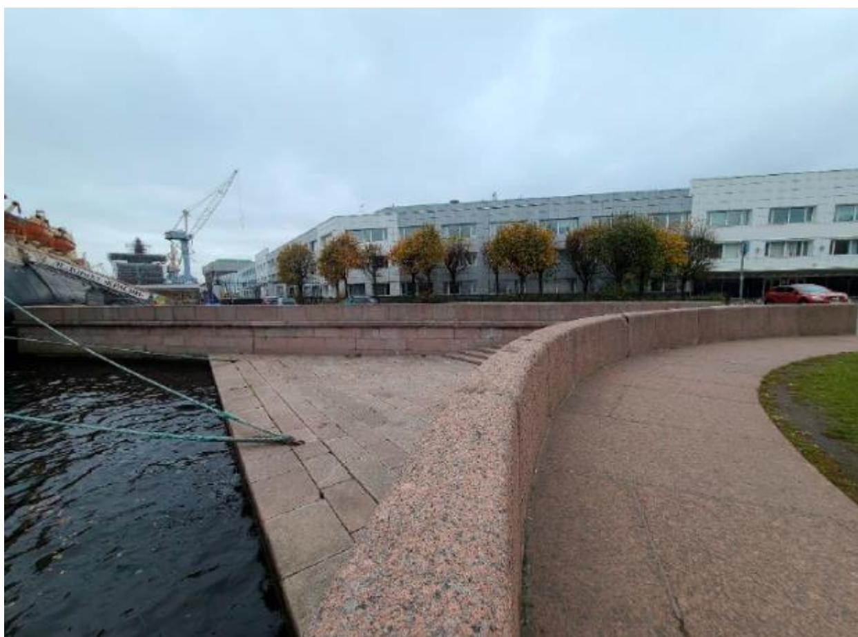
13. Объект культурного наследия федерального значения «Набережная Николаевская (ныне Лейтенанта Шмидта)», г. Санкт-Петербург, участок набережной реки Невы «мост Лейтенанта Шмидта-23-я линия В.О.», литера А, и зона производства работ. 25.10.2021
