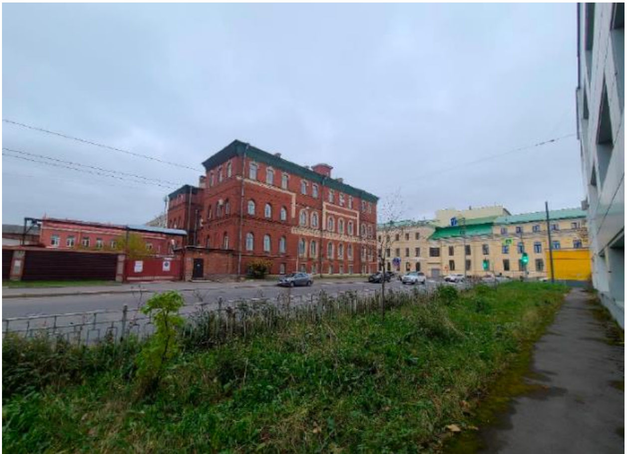
9. Вид на выявленный объект культурного наследия «Здание Главной Геофизической обсерватории при Горном институте» по адресу: г. Санкт-Петербург, 23-я линия В.О., д. 2а, литера А, от зоны производства работ. 25.10.2021
