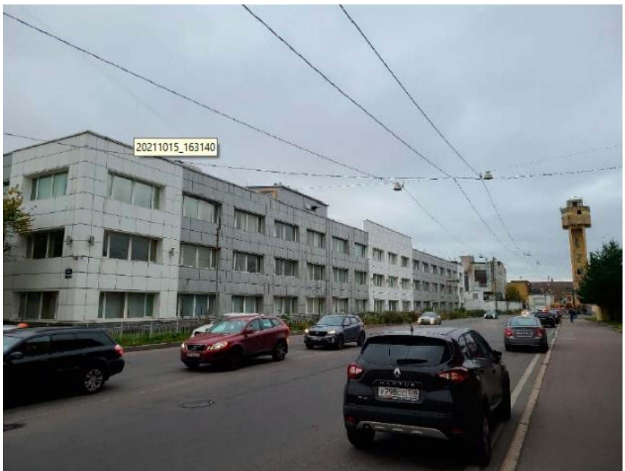
10. Вид от выявленного объекта культурного наследия «Здание Главной Геофизической обсерватории при Горном институте» по адресу: г. Санкт-Петербург, 23-я линия В.О., д. 2а, литера А, в сторону зоны производства работ. 25.10.2021
