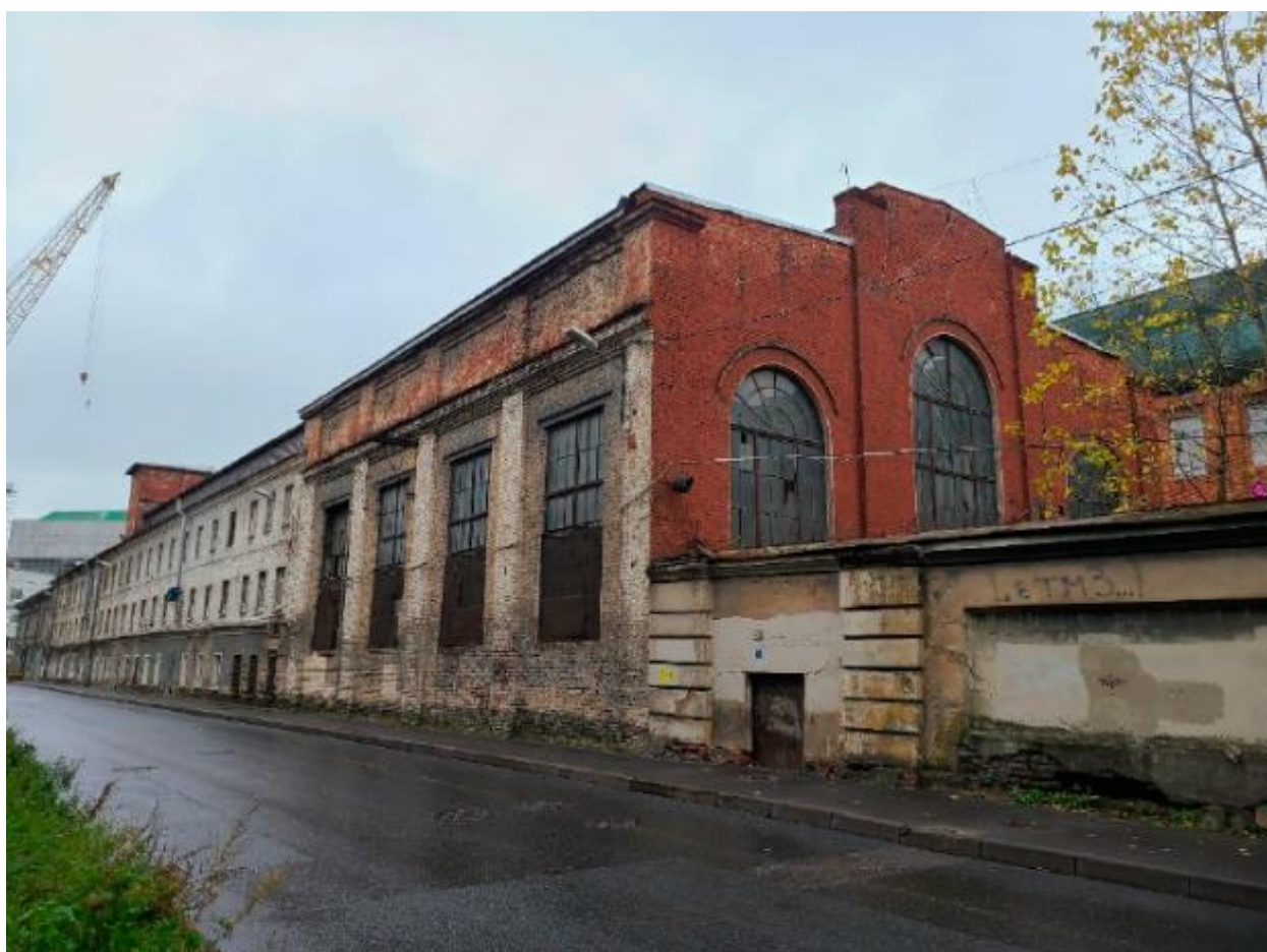
18. Северо-восточный и северо-западный фасады выявленного объекта культурного наследия «Кожевенный завод А.А. Парамонова. Котельная», по адресу: г. Санкт-Петербург, Кожевенная линия, д. 1-3, литера Д. 25.10.2021
