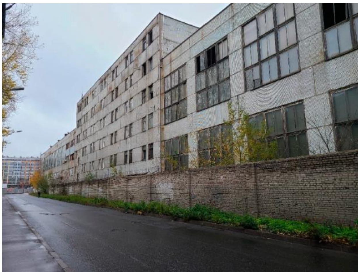
21. Вид от выявленного объекта культурного наследия «Кожевенный завод А.А. Парамонова. Котельная», по адресу: г. Санкт-Петербург, Кожевенная линия, д. 1-3, литера Д, на зону производства работ. 25.10.2021
