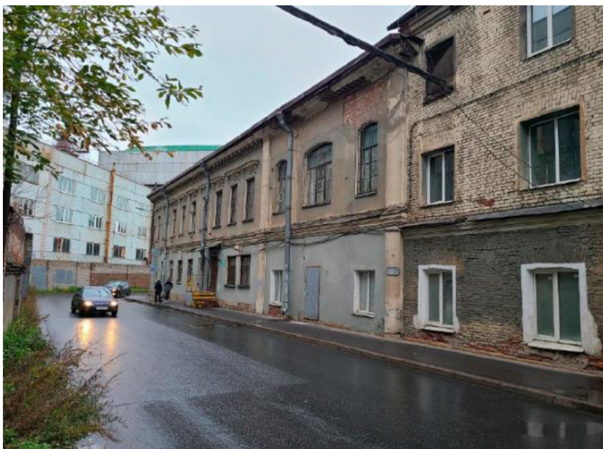
23. Вид на выявленный объект культурного наследия «Кожевенный завод А.А. Парамонова. Особняк владельца», по адресу: г. Санкт-Петербург, Кожевенная линия, д. 1-3, литера Р, от зоны производства работ. 25.10.2021
