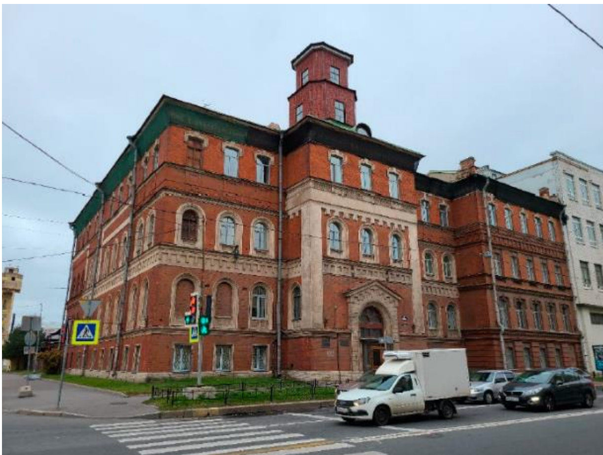
6. Юго-восточный фасад выявленного объекта культурного наследия «Здание Главной Геофизической обсерватории при Горном институте» по адресу: г. Санкт-Петербург, 23-я линия В.О., д. 2а, литера А. 25.10.2021
