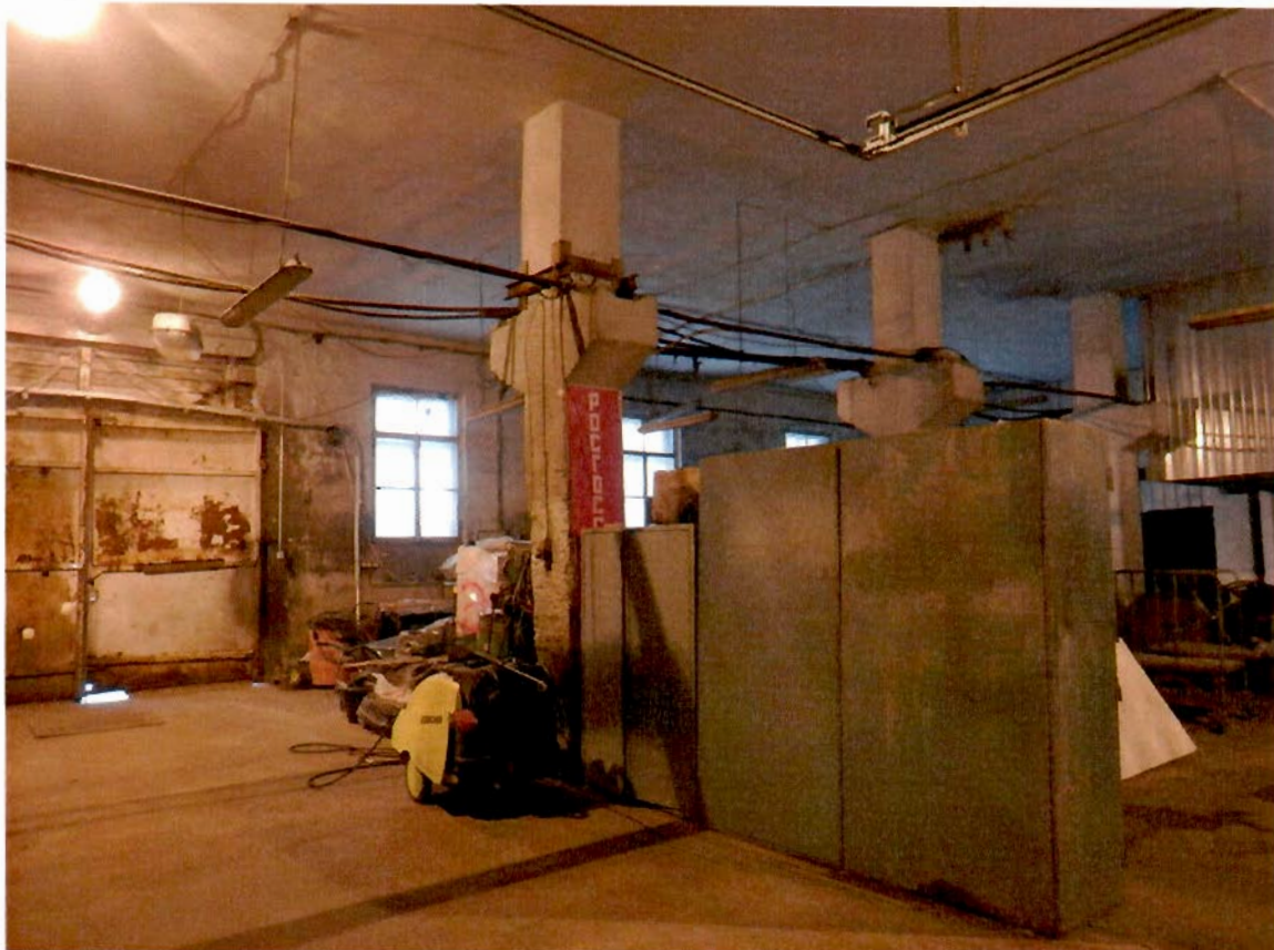
9. Помещение 1-го этажа со стороны 25-й линии В.О.
