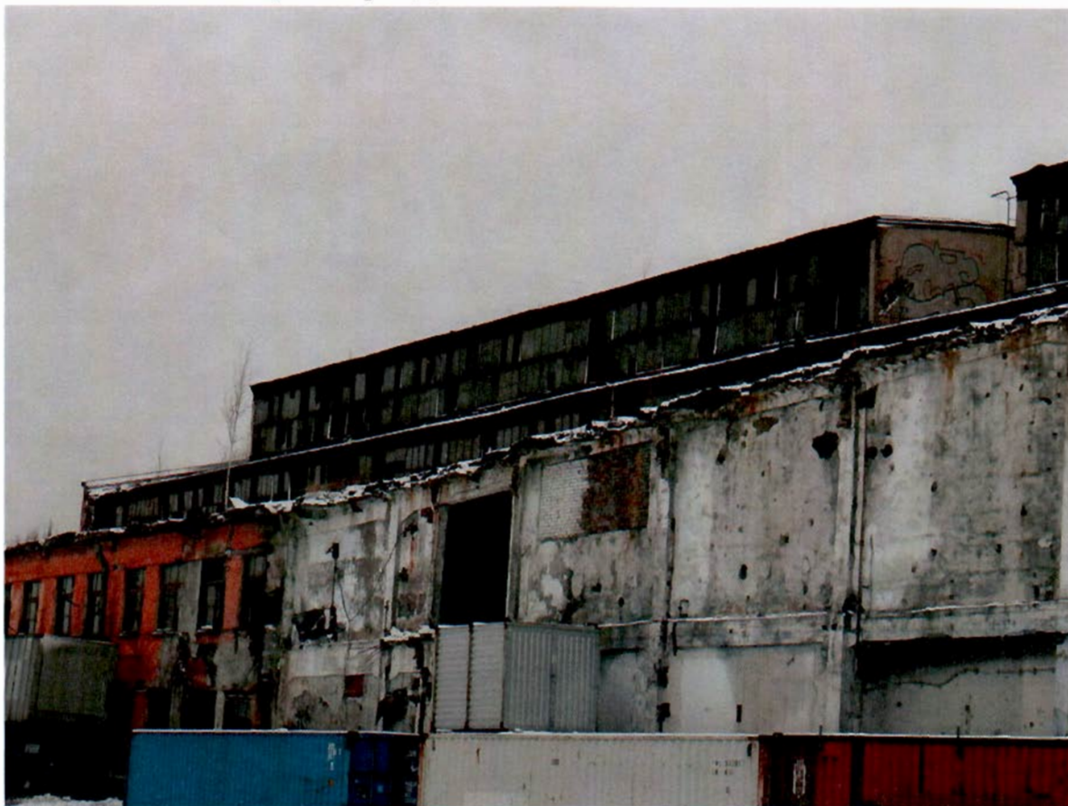
5. Западный дворовый фасад
