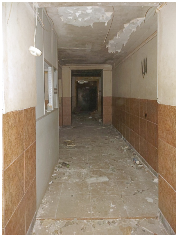
Фото 23. Коридор восточного входа.
