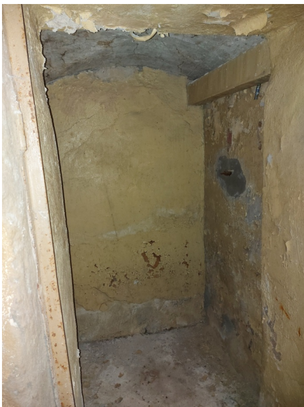
Фото 27. Помещение под парадной лестницей.
