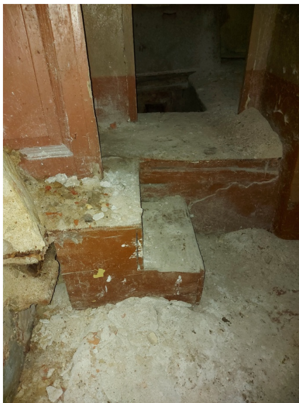
Фото 28. Ступени в западной части.
