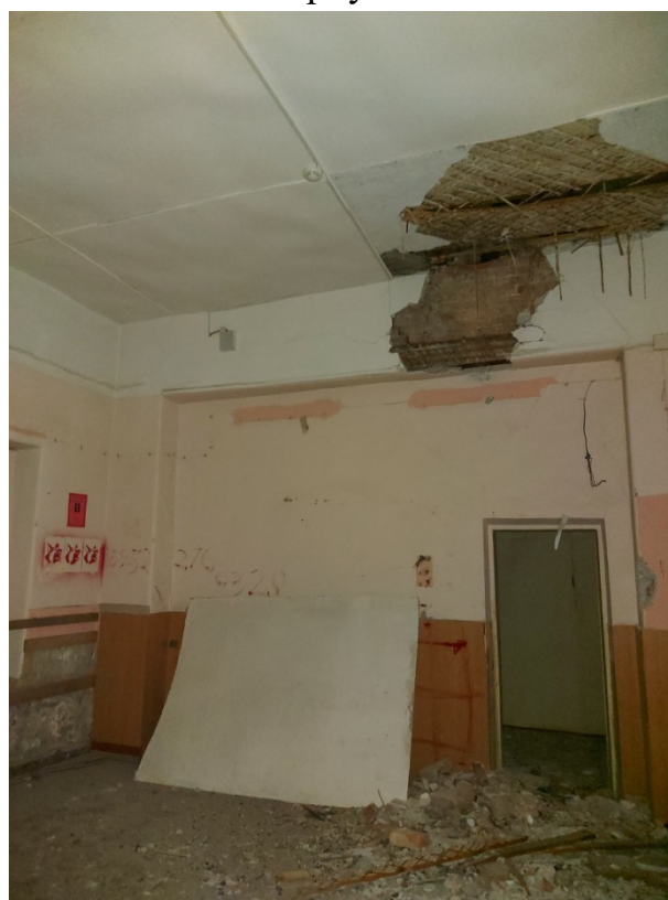
Фото 58. Помещение 8 и проем в помещении 7.
