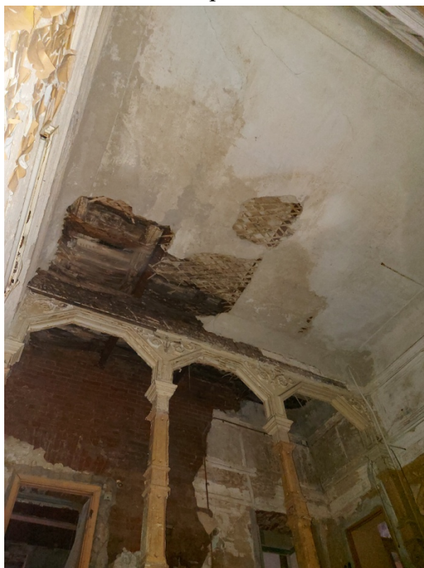
Фото 37. Перекрытие парадной лестницы.
