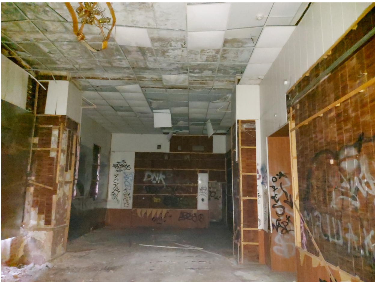
Фото 42. Восточная и центральная часть помещения 14.
