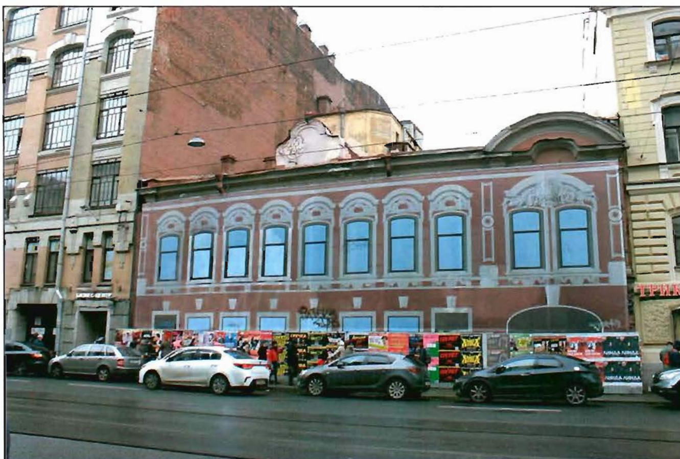
1. Общий вид со стороны лицевого фасада.
