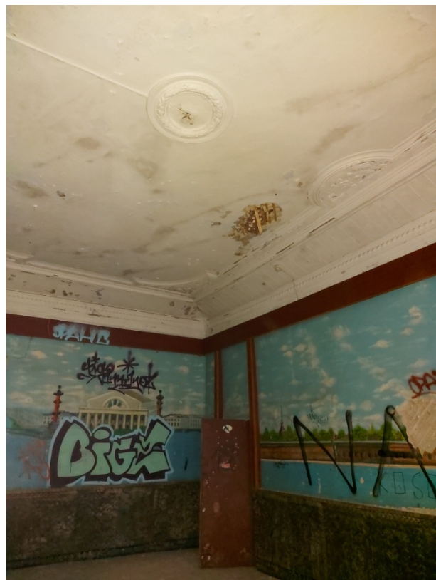
Фото 54. Северо-восточный угол помещения 9.
