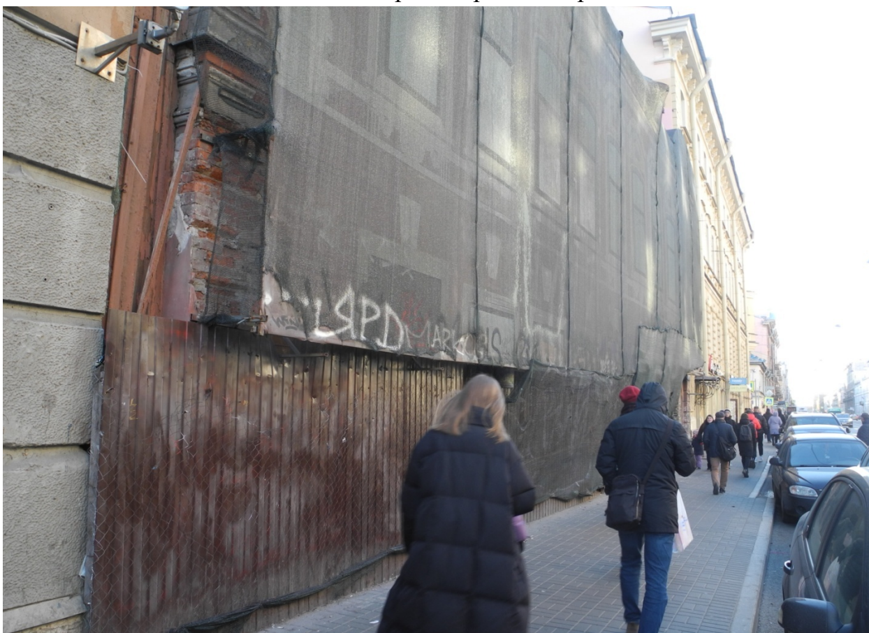
Фото 3. Лицевой фасад с северо-востока.
