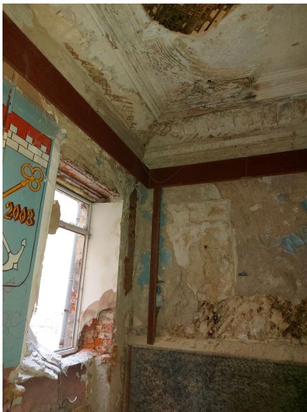
Фото 53. Фрагмент помещения 9, оконный проем.
