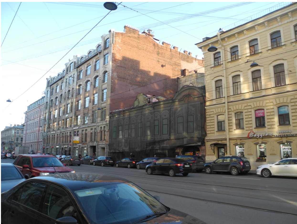
Фото 2. Вид со стороны Среднего проспекта.
