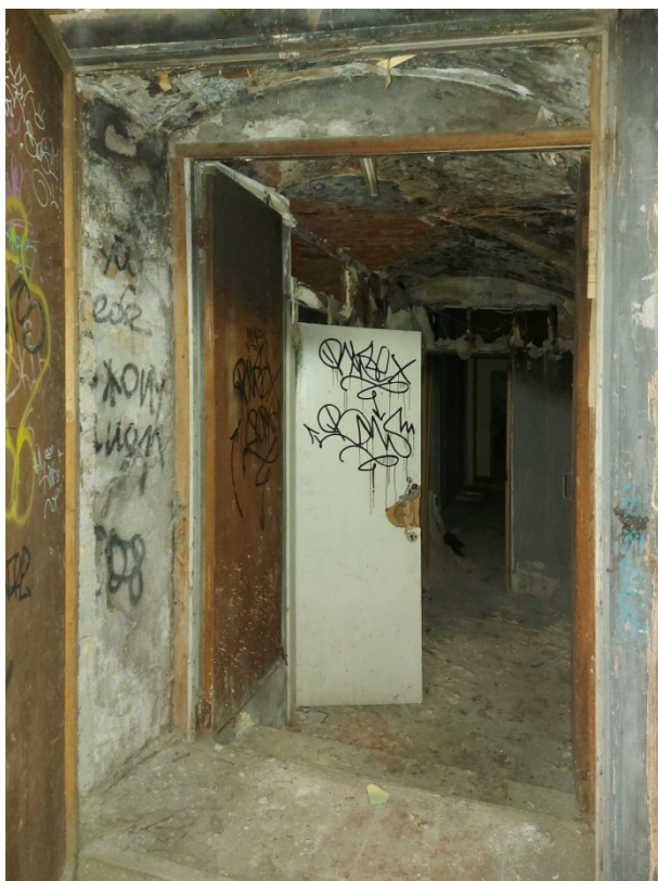
Фото 16. Вход со двора.
