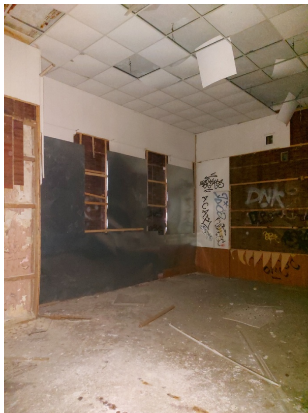
Фото 45. Северо-восточный угол помещения 14.
