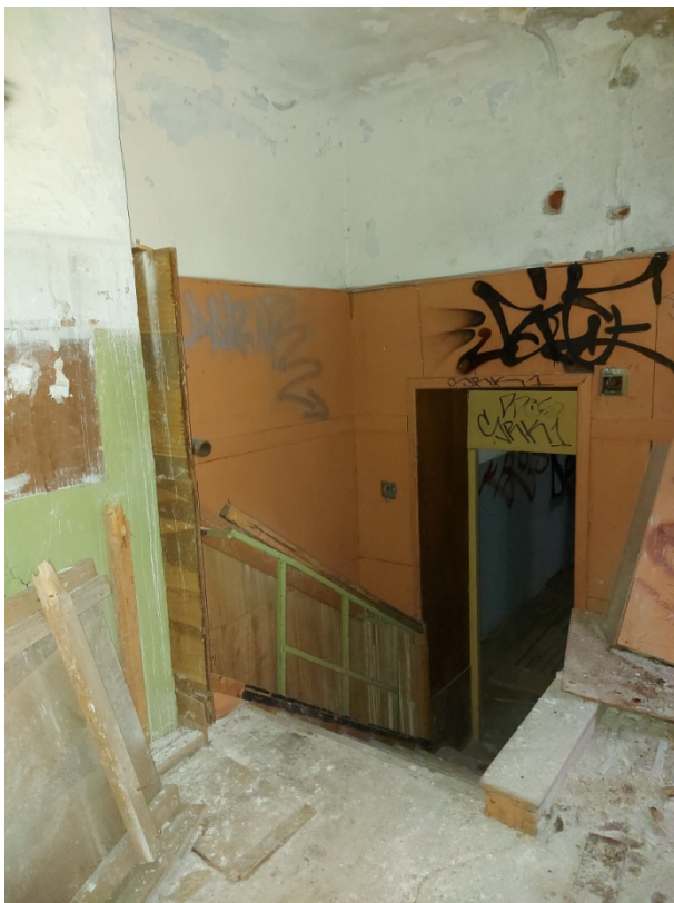
Фото 59. Юго-восточное помещение с лестницей на третий этаж.
