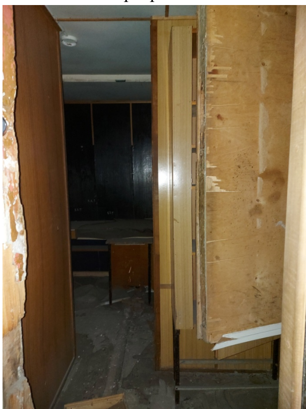
Фото 46. Вид на помещение 13.
