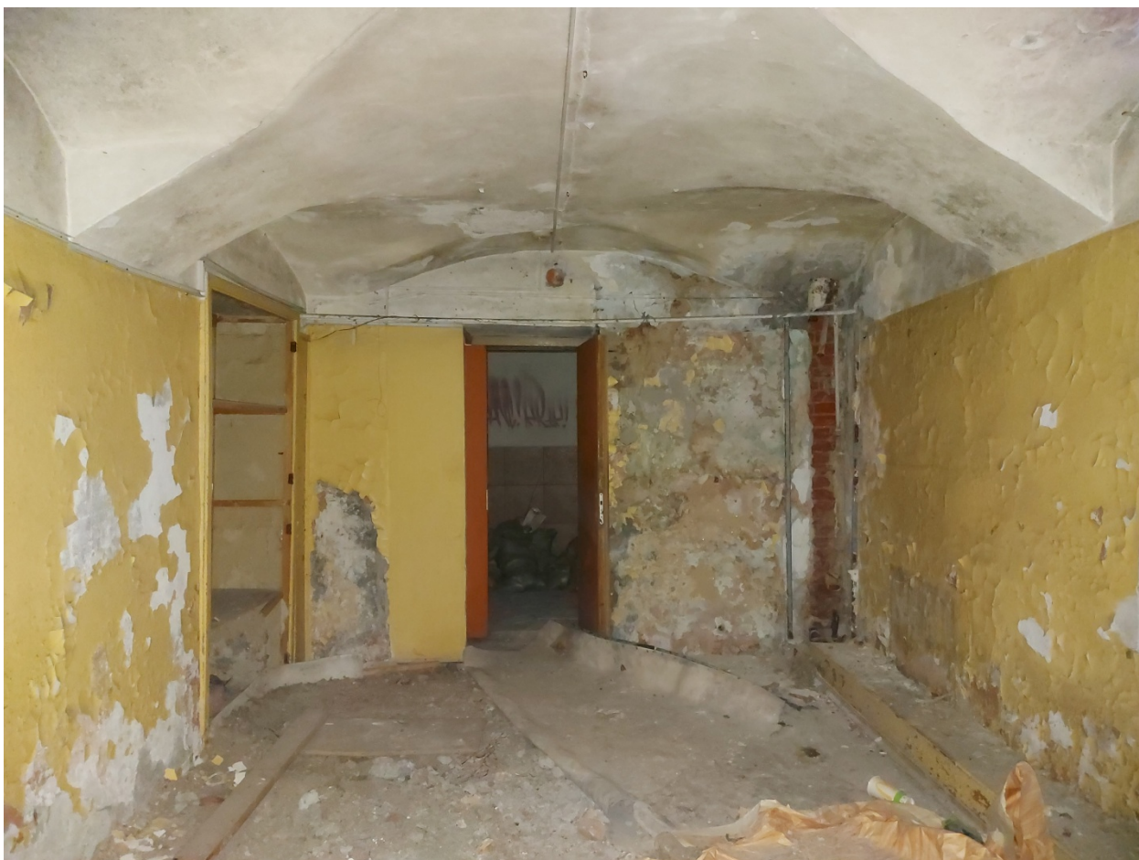
Фото 19. Помещение 5, по дворовому фасаду.
