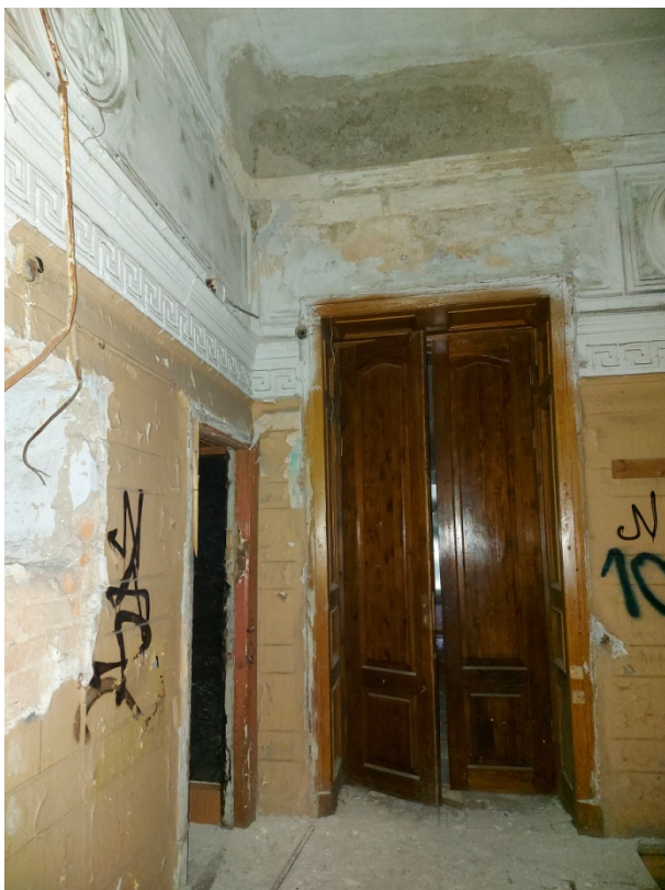
Фото 40. Площадка второго этажа.
