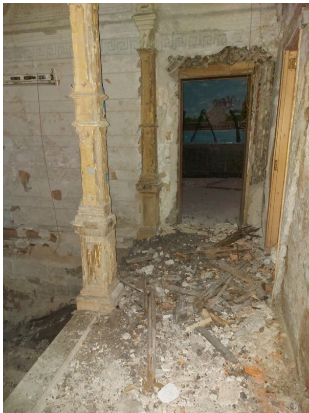
Фото 39. Галерея парадной лестницы.
