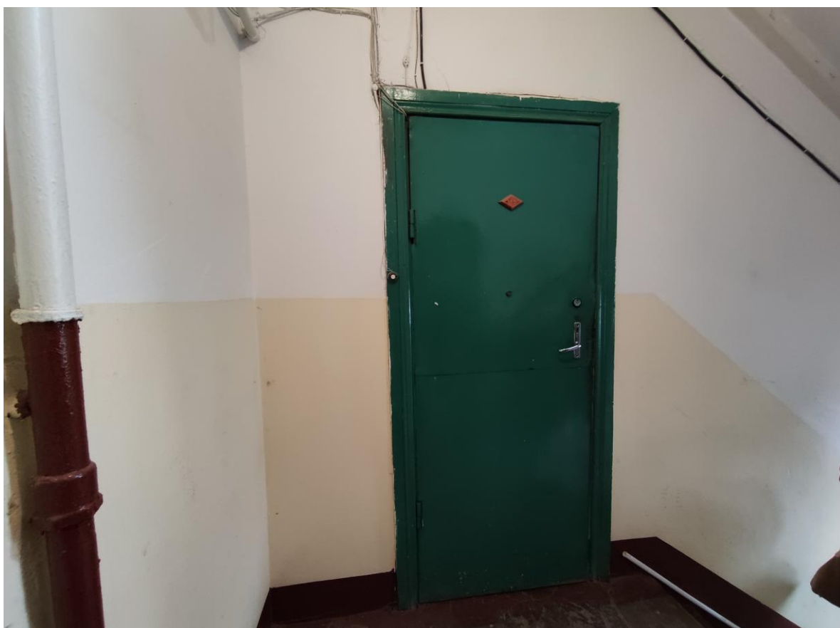
Фото 8. Входное дверное заполнение квартиры №22, вид со стороны лестничной клетки
