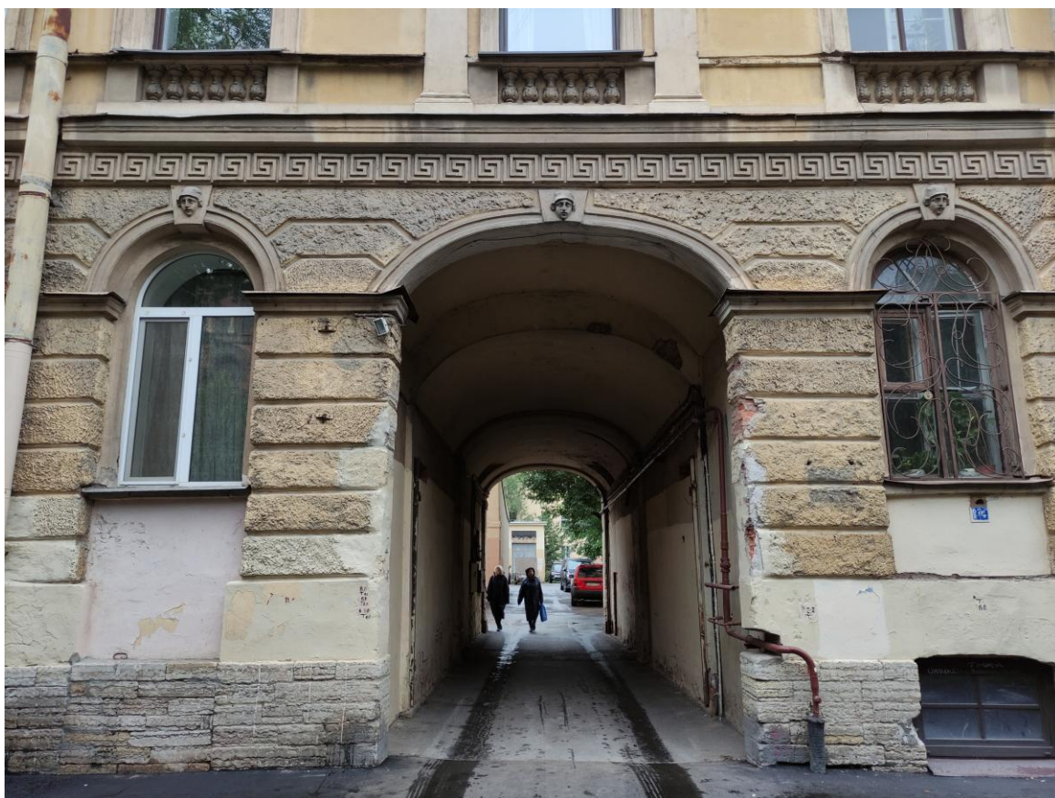
Фото 3. Фрагмент лицевого фасада выявленного объекта культурного наследия «Дом Гемилиан», воротный проезд
