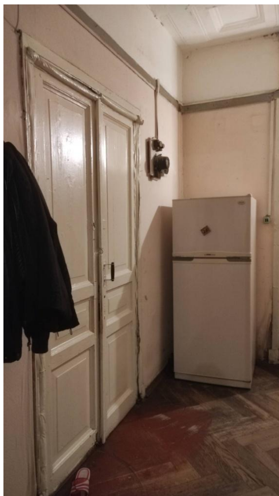
Фото 33. Интерьер квартиры №2, расположенной в выявленном объекте культурного наследия «Дом Т.М. Любищевой», ч.п.13, входное дверное заполнение в пом. №14
