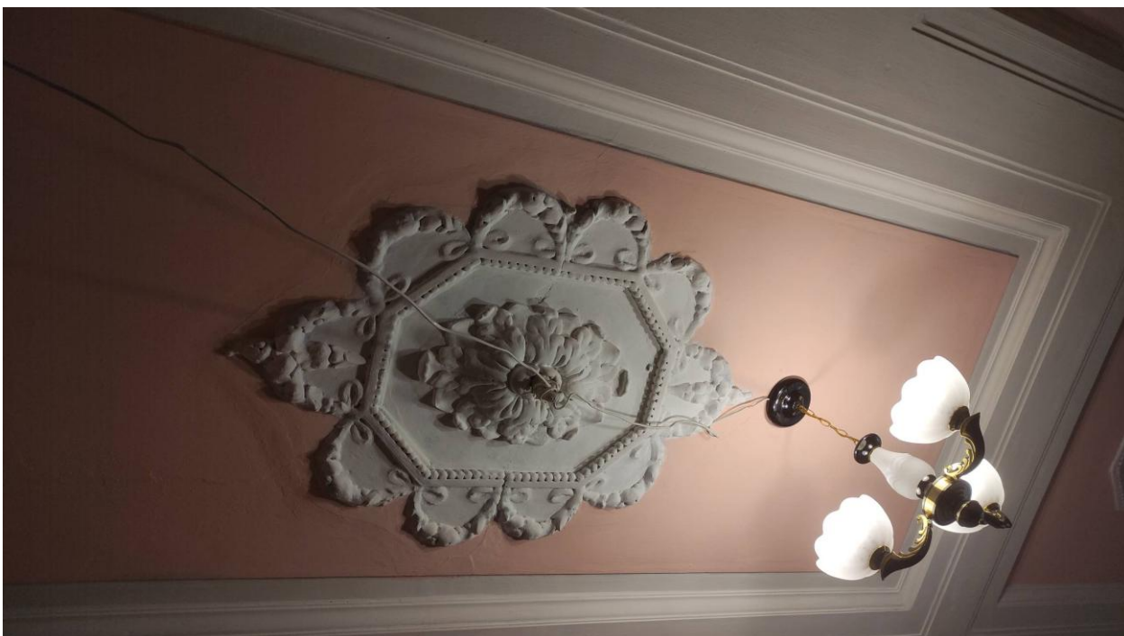
Фото 40. Интерьер квартиры №2, расположенной в выявленном объекте культурного наследия «Дом Т.М. Любищевой», ч.п.14, лепная восьмигранная розетка
