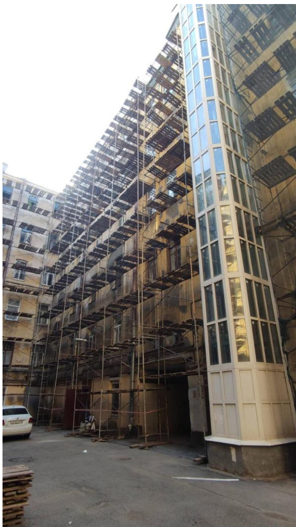
Фото 10. Фрагмент дворового фасада выявленного объекта культурного наследия «Дом Т.М. Любищевой»
