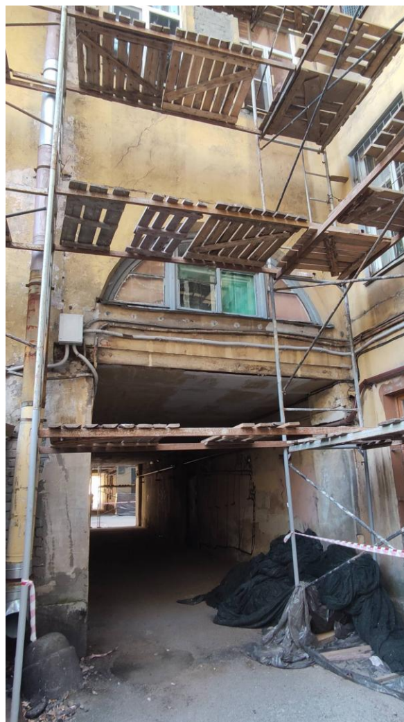
Фото 11. Воротный проезд лицевого корпуса выявленного объекта культурного наследия «Дом Т.М. Любищевой», вид со стороны двора
