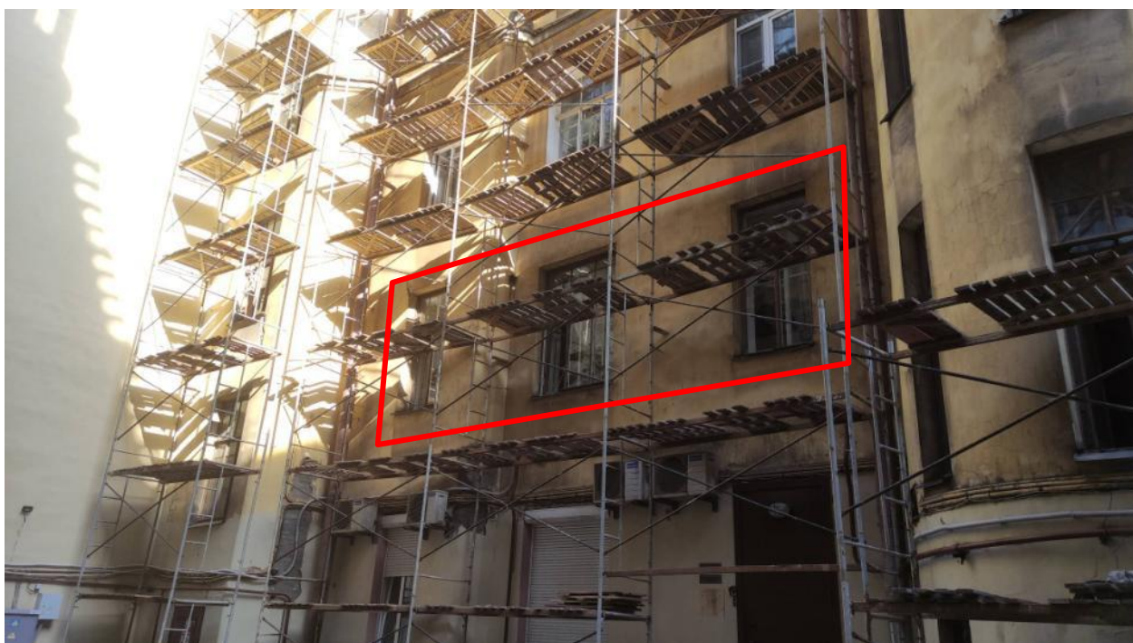
Фото 9. Фрагмент дворового фасада выявленного объекта культурного наследия «Дом Т.М. Любищевой», оконные заполнения кв.№2
