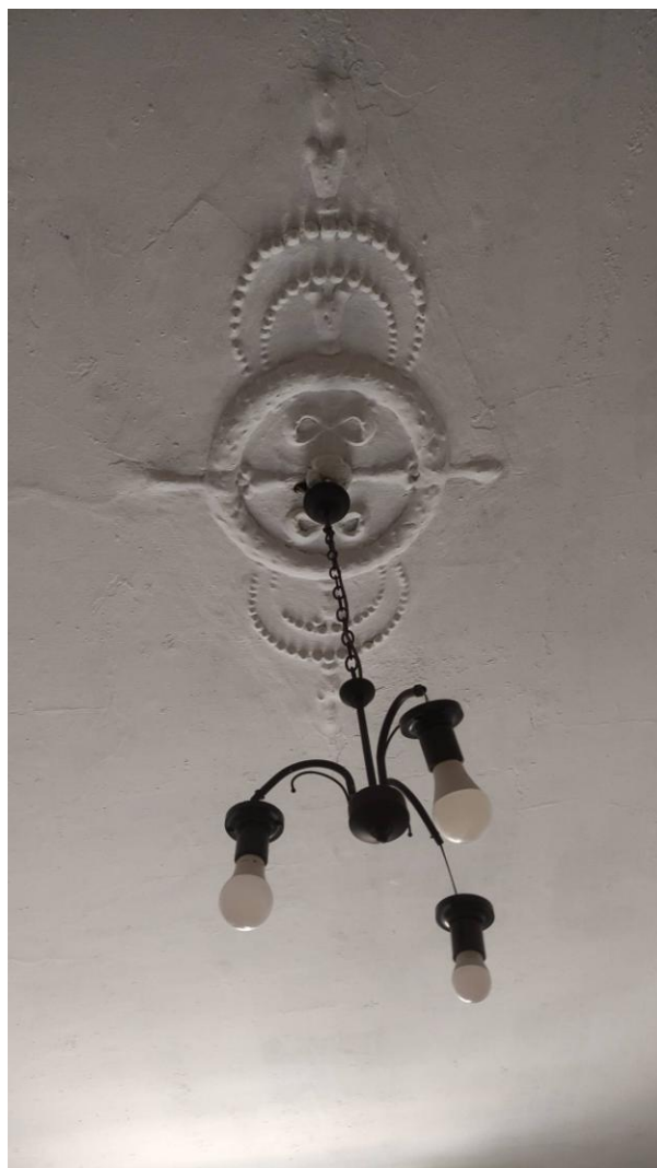
Фото 20. Интерьер квартиры №2, расположенной в выявленном объекте культурного наследия «Дом Т.М. Любищевой», ч.п.10, лепной потолочный декор
