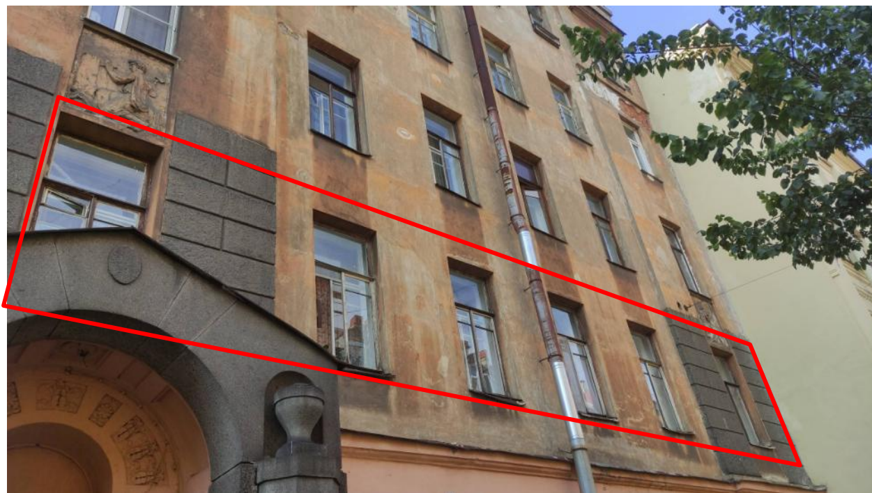
Фото 4. Фрагмент фасада выявленного объекта культурного наследия «Дом Т.М. Любищевой», оконные заполнения квартиры № 2
