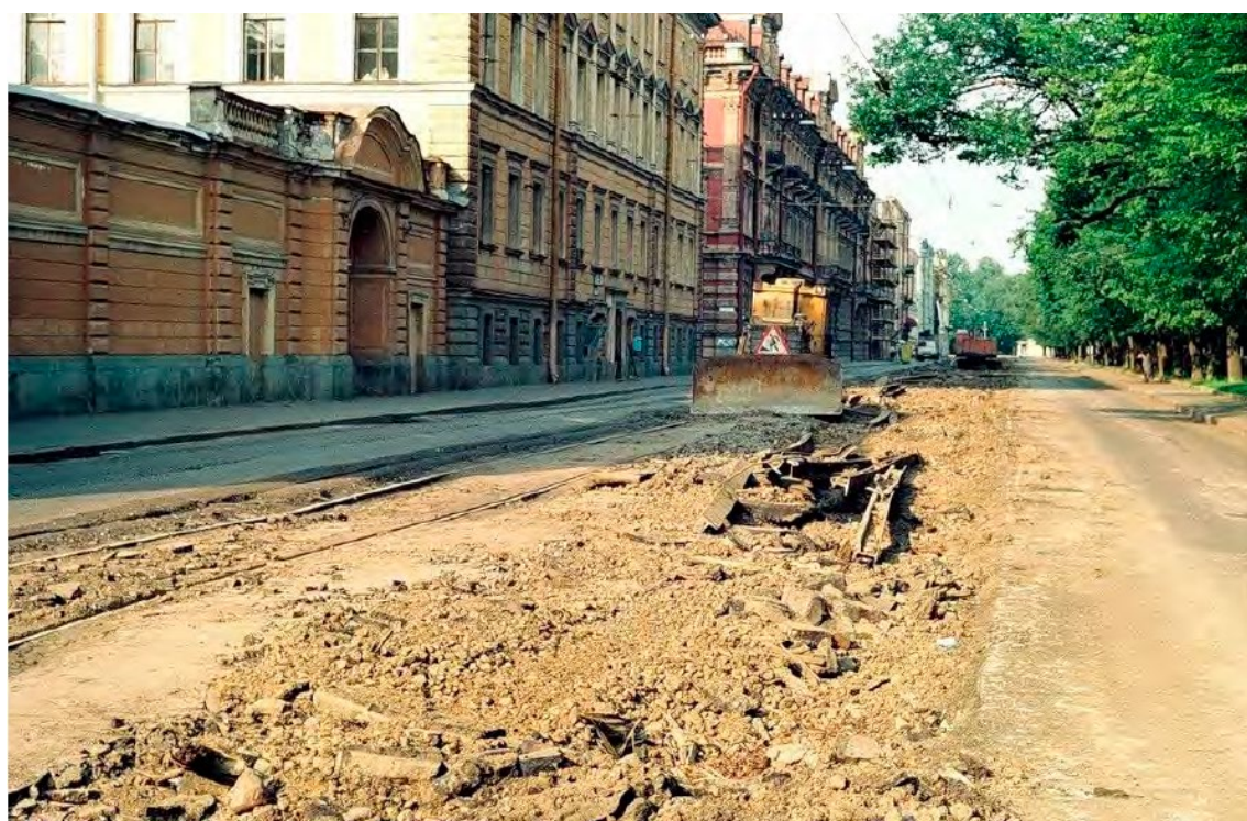
47. Демонтаж трамвайной линии на Конногвардейском бульваре. 1987 г. — «PastVu» – ретро-фотографии стран и городов [Электронный ресурс]. URL: https://pastvu.com/p/129637 .
