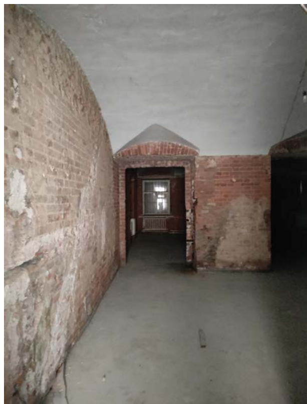
Фото 12. Интерьер квартиры №11, ч.п.№1, вид на ч.п.№3(дата фотофиксации: 08.10.2021)
