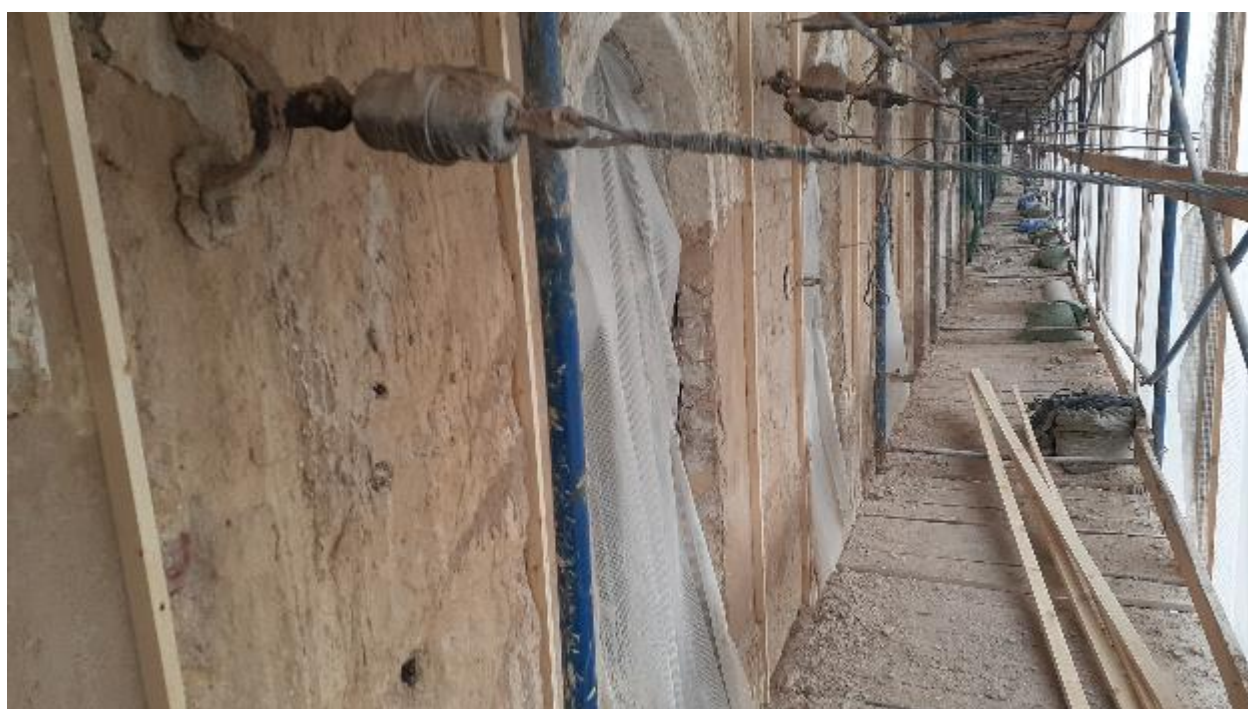
7. Северо-западный лицевой фасад объекта культурного наследия регионального значения «Академия Михайловская артиллерийская, где преподавали ученые Ленц Э.Х., Остроградский М.В., Петрушевский В.Ф.», расположенного по адресу: г. Санкт-Петербург, ул. Комсомола, д. 22, литера А. 06.12.2021
