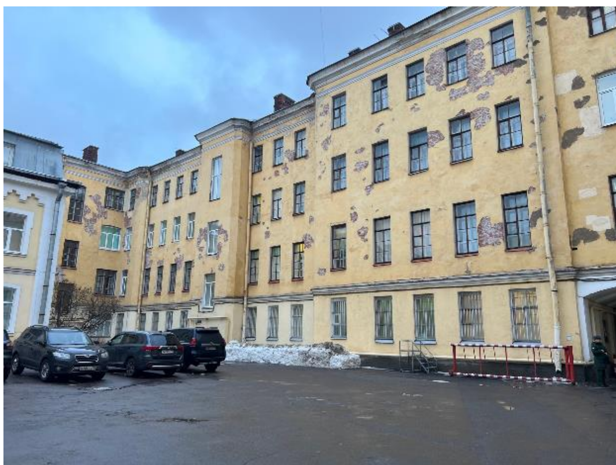
8. Дворовые фасады объекта культурного наследия регионального значения «Академия Михайловская артиллерийская, где преподавали ученые Ленц Э.Х., Остроградский М.В., Петрушевский В.Ф.», расположенного по адресу: г. Санкт-Петербург, ул. Комсомола, д. 22, литера А. 06.12.2021
