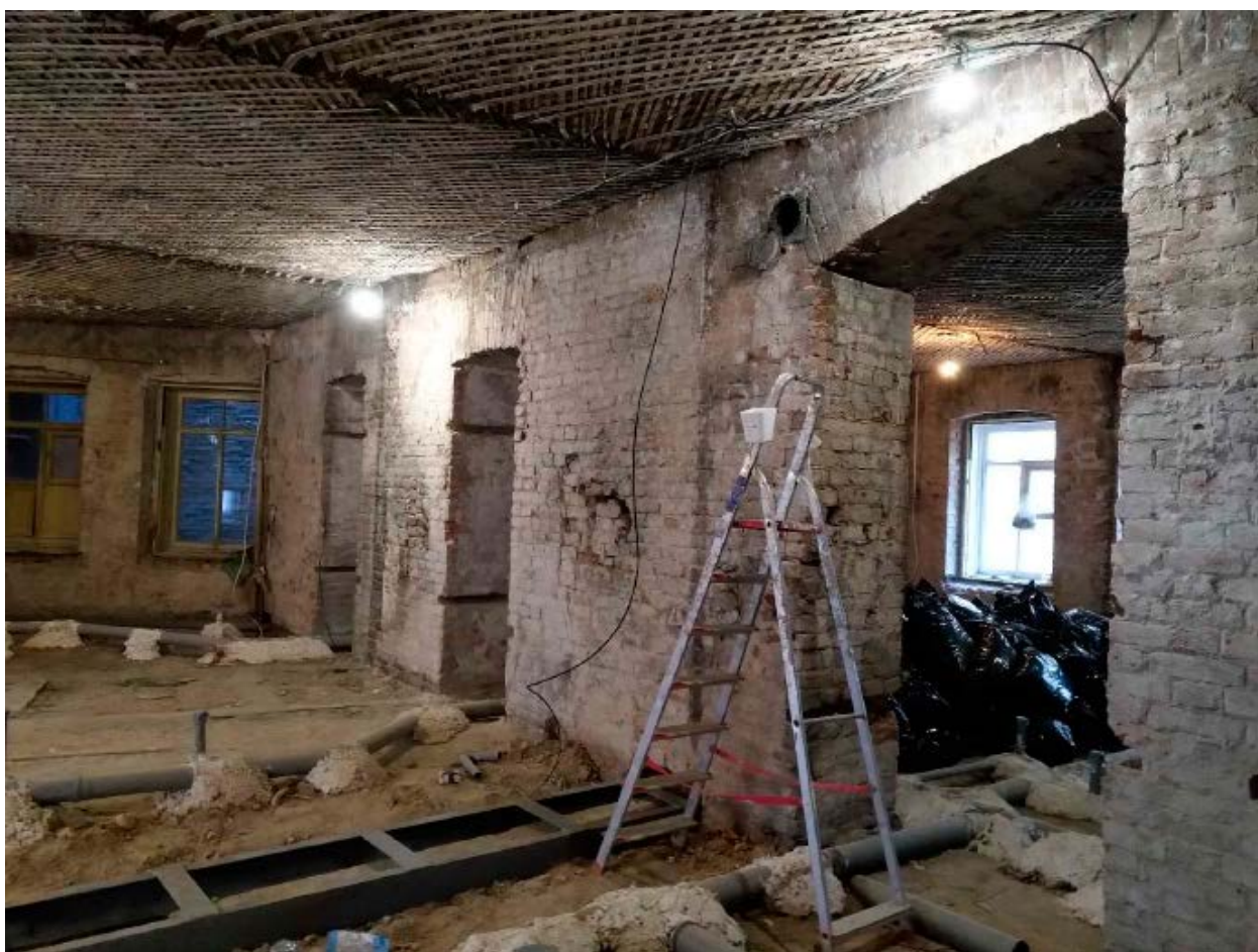
5. Помещение №11 квартиры №21 в уровне 3-го этажа выявленного объекта культурного наследия «Дом И.И. Антонова», расположенного по адресу: г. Санкт-Петербург, Литейный пр., д. 61, лит. А. 20.12.2020.
