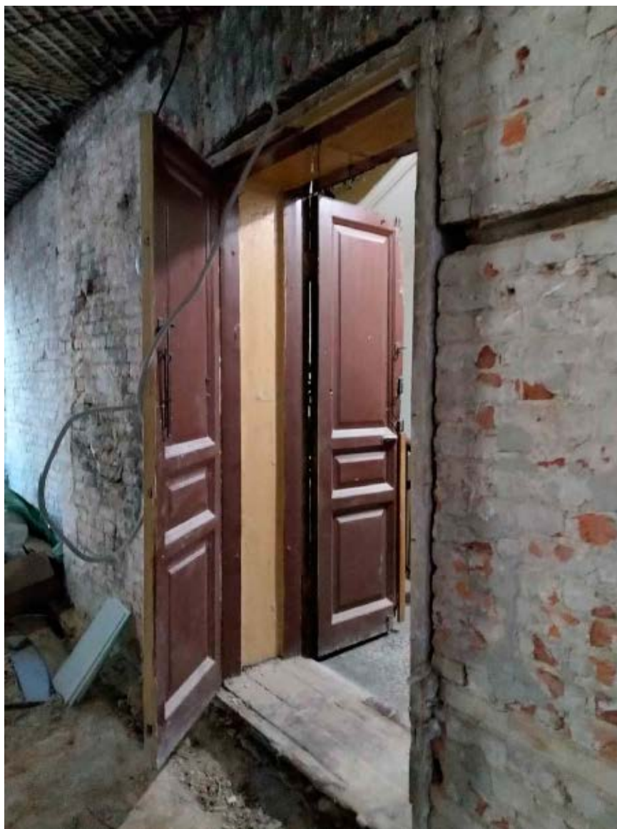
3. Входные дверные заполнения квартиры №21 с парадной лестницы в уровне 3-го этажа выявленного объекта культурного наследия «Дом И.И. Антонова», расположенного по адресу: г. Санкт-Петербург, Литейный пр., д. 61, лит. А. 20.12.2020.
