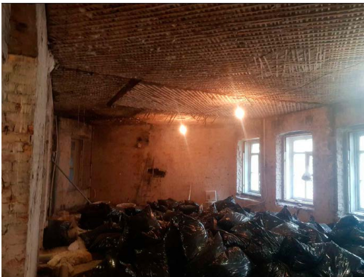
7. Помещение №3 квартиры №21 в уровне 3-го этажа выявленного объекта культурного наследия «Дом И.И. Антонова», расположенного по адресу: г. Санкт-Петербург, Литейный пр., д. 61, лит. А. 20.12.2020.
