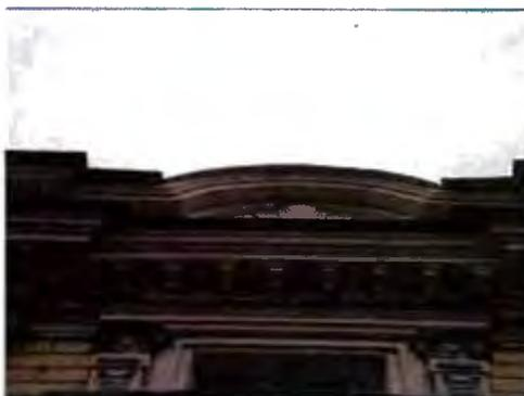
широкий профилированный раскрепованный карниз с модульонами в уровне 4-5-го этажей (до перестройки являющийся венчающим карнизом);
