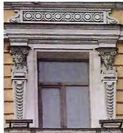
в уровне 5-го этажа оконные проемы прямоугольной формы обрамлены профилированными наличниками с «ушками», с граненым трехчастным замковым камнем; оконные проемы с полуциркульным завершением обработаны рустованными наличниками;
