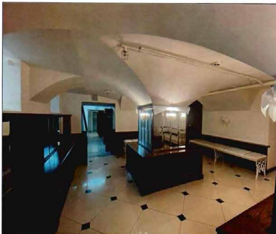
15. Сводчатые перекрытия помещений на столбах
