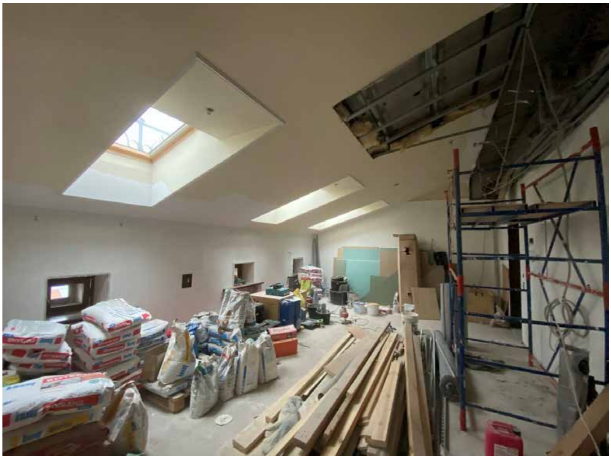
Фото 22. Помещение № 237. Кабинет. Вид с востока.
