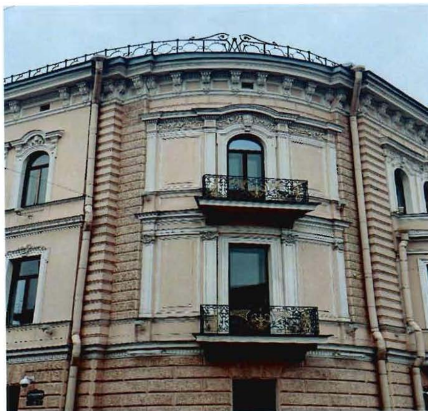
6. Фрагмент северо-восточного фасада объекта культурного наследия.
