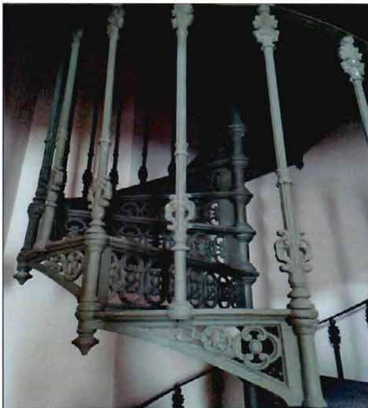
25. Чугунная, винтовая лестница.
