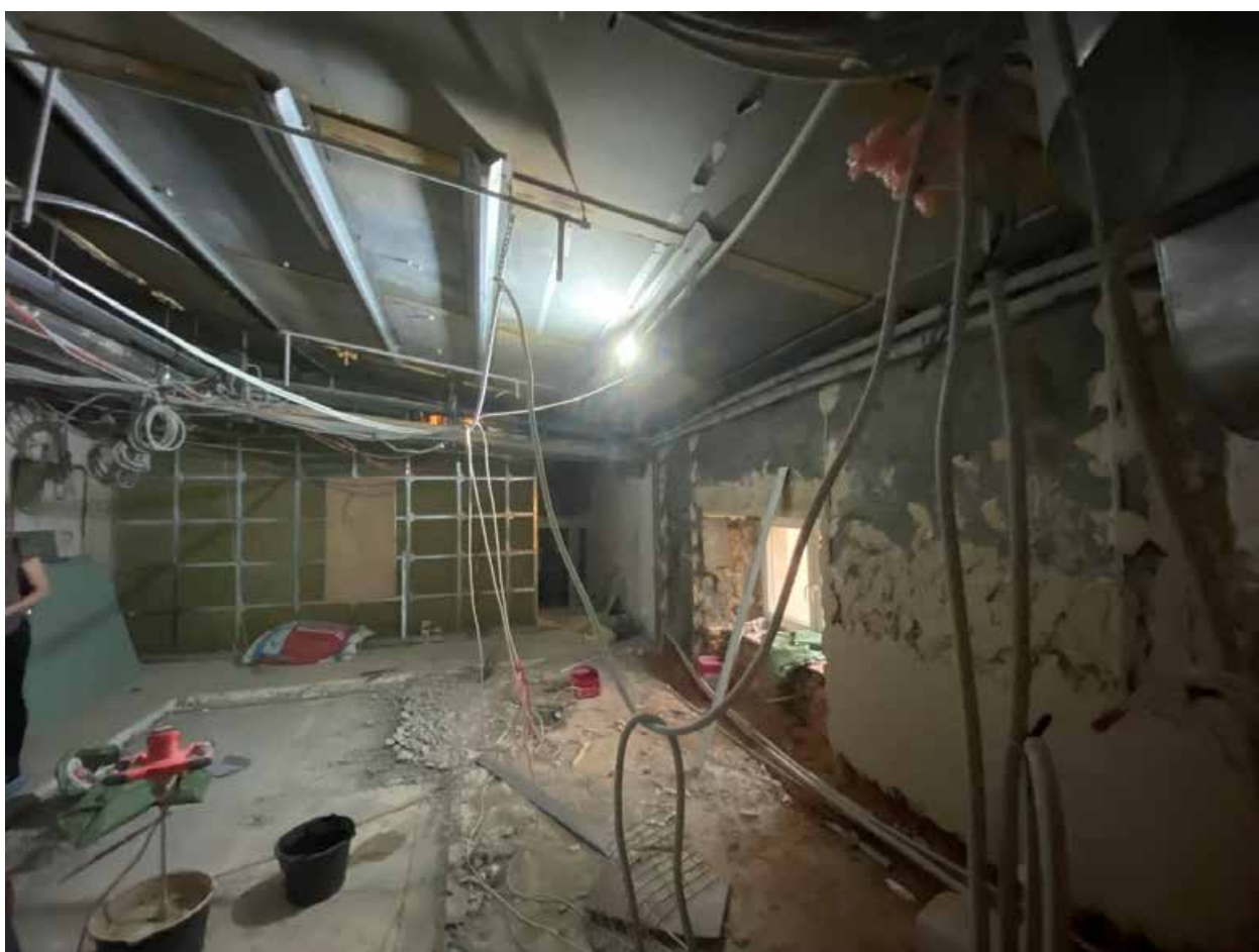
Фото 19. Помещение № 241. Кабинет. Вид с востока.
