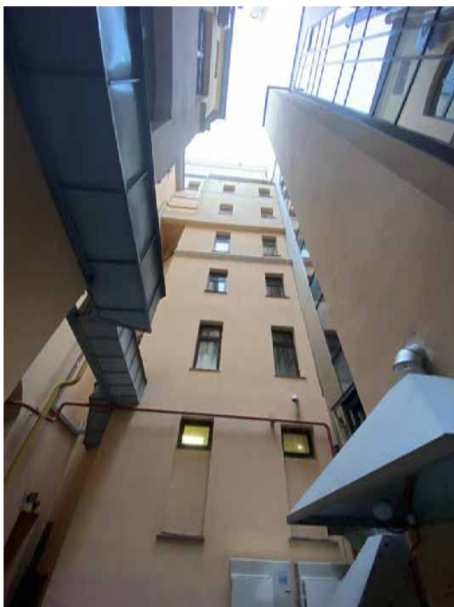
Фото 6. Южный дворовый фасад.
