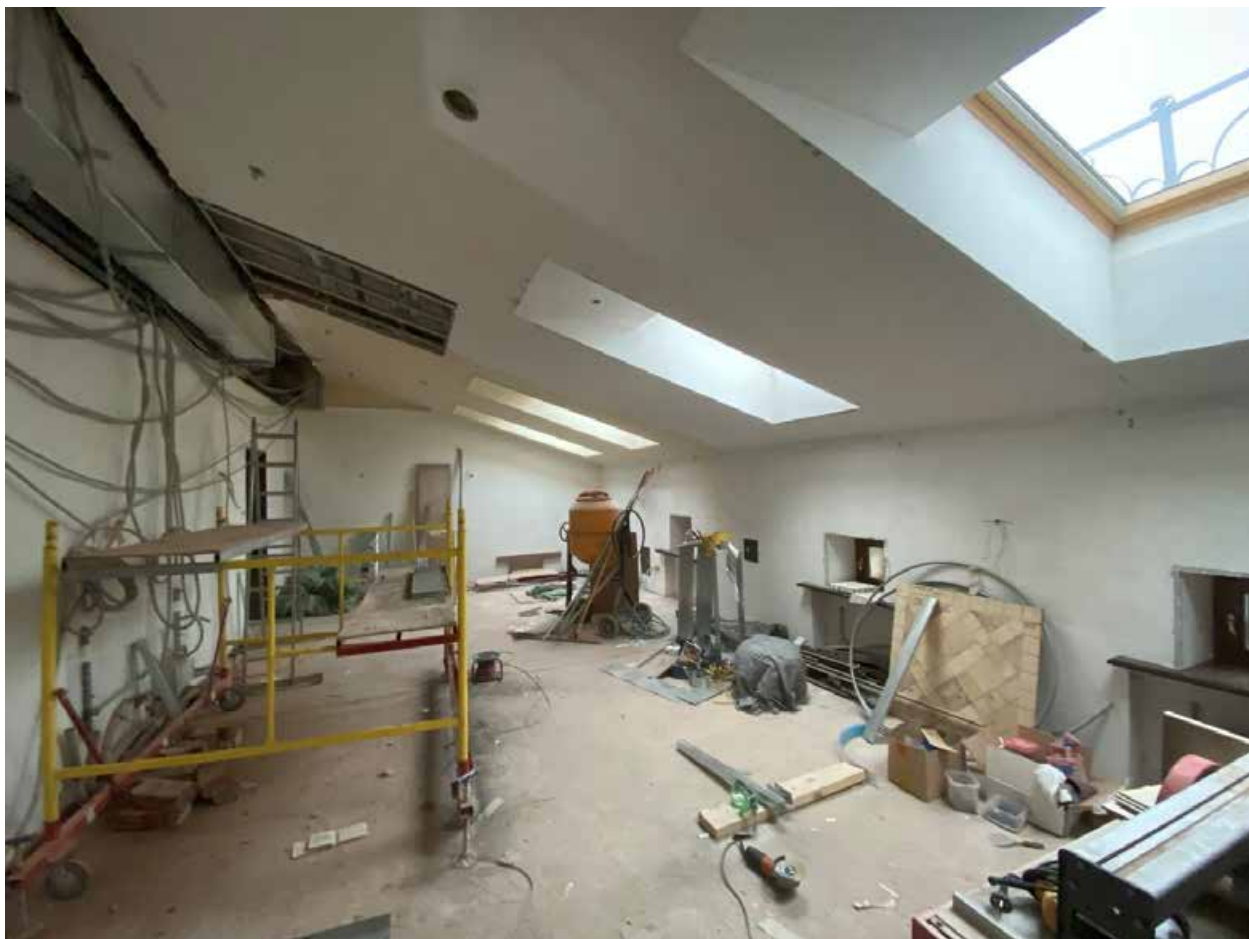
Фото 25. Помещение № 242. Кабинет. Вид с запада.
