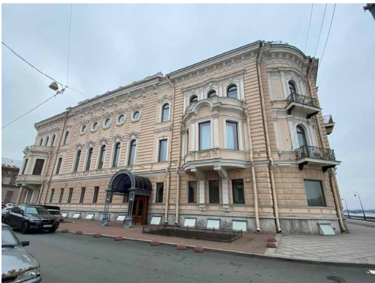
Фото 4. Восточный лицевой фасад, выходящий на Кричевский переулок.
