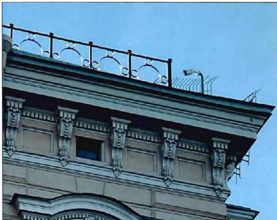
14. Карниз с выносом, декорированный филёнками, на фигурных кронштейнах.
