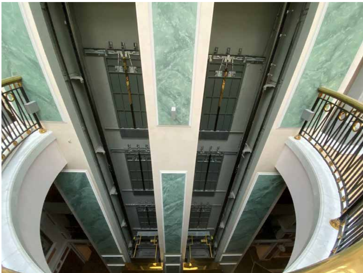
Фото 13. Помещение № 228. Лифтовая шахта. Вид сверху.
