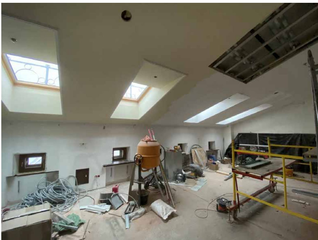
Фото 24. Помещение № 242. Кабинет. Вид с северо-востока.
