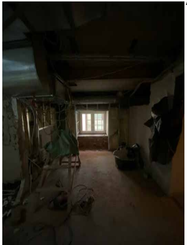
Фото 21. Помещение № 239. Вид с юга.
