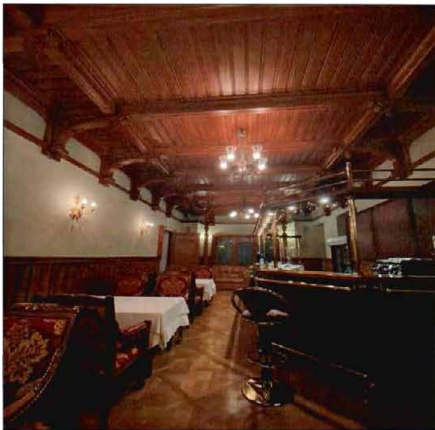
19. Потолок деревянный, с тягами, на резных кронштейнах в помещении 1-Н.
