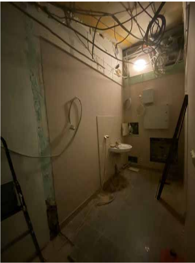
Фото 20. Помещение № 244. Умывальная. Вид с востока.
