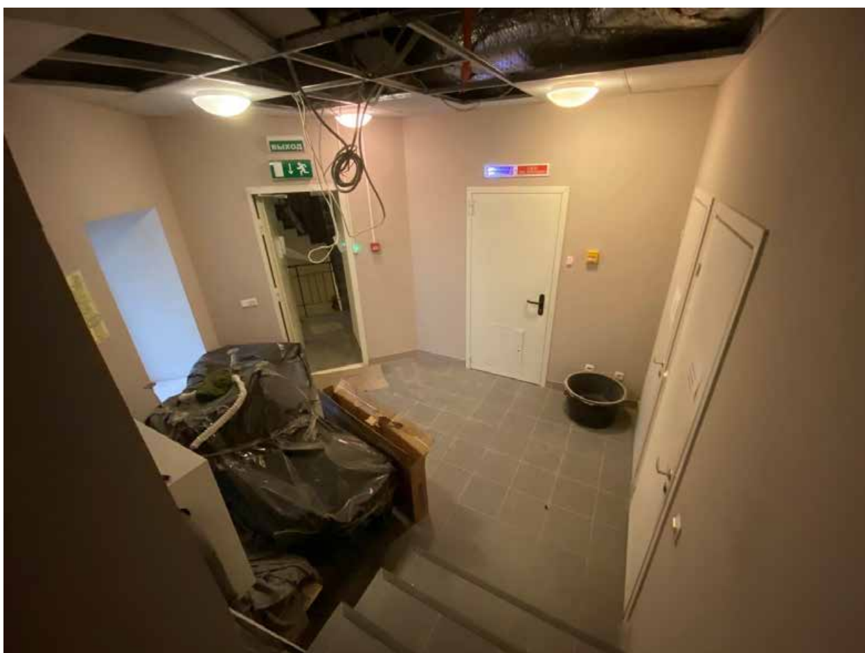
Фото 26. Помещение № 231. Коридор. Вид с юго-запада.
