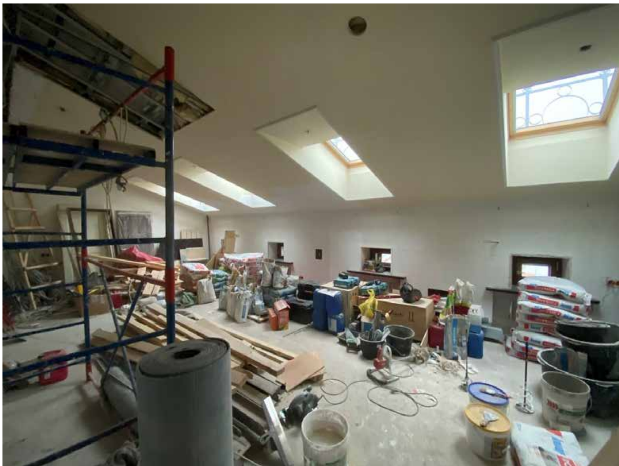
Фото 23. Помещение № 237. Кабинет. Вид с северо-запада.
