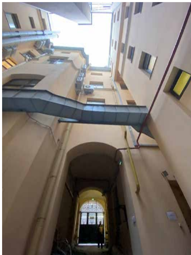
Фото 9. Восточный дворовый фасад.
