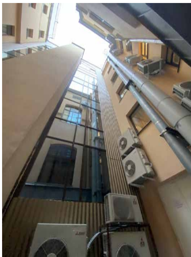
Фото 7. Западный дворовый фасад.
