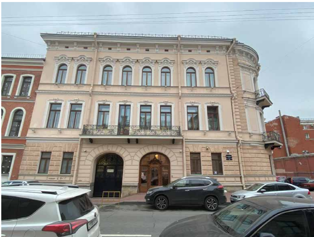
Фото 2. Южный лицевой фасад, выходящий на ул. Шпалерную.
