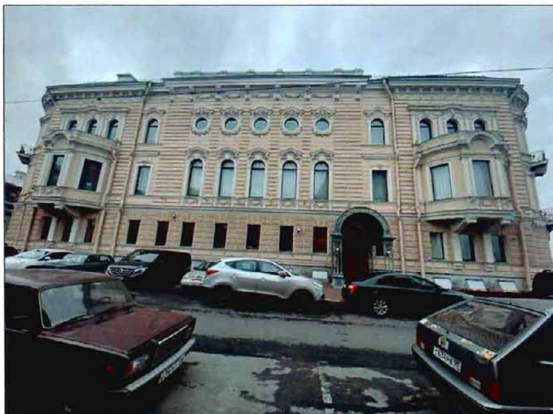
4. Восточный фасад объекта культурного наследия.
