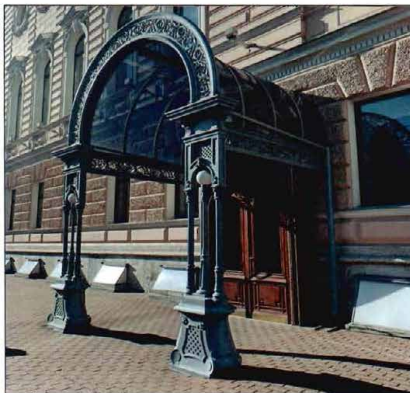
10. Чугунный козырек большого выноса в оформлении парадного входа с Кричевского переулка.
