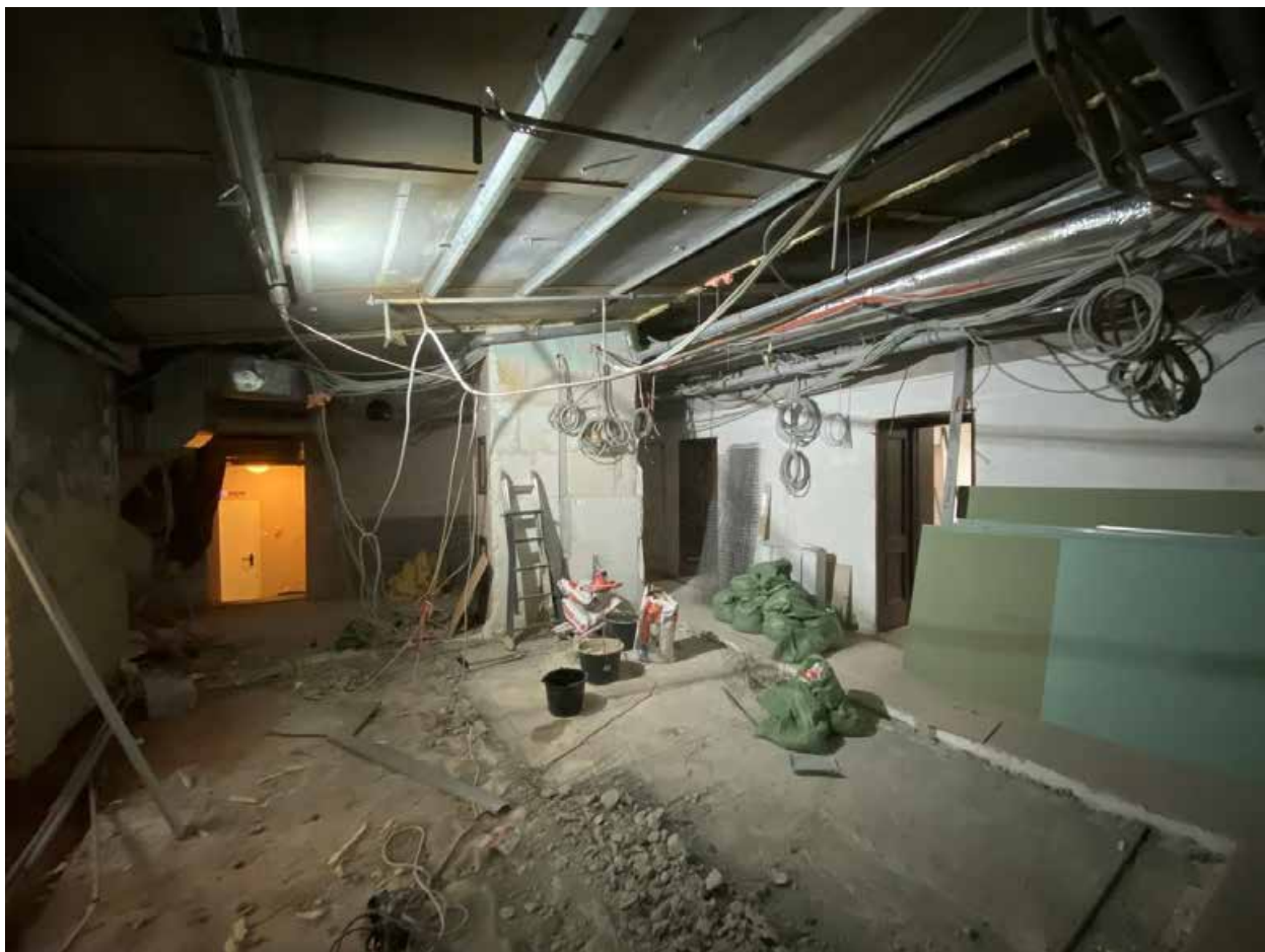
Фото 18. Бывшие помещения №№ 232-236. Вид с северо-востока.
