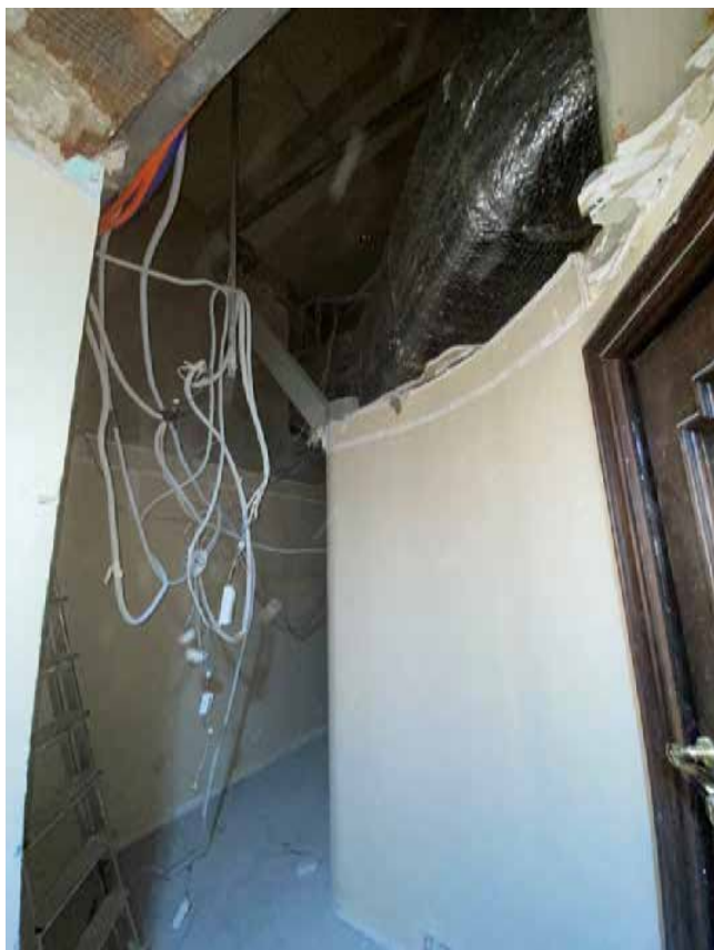
Фото 16. Помещений № 227. Коридор. Вид с северо-запада.
