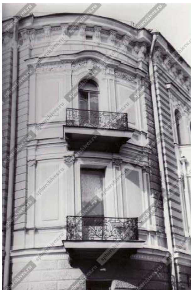
Илл. 19. Вид части углового фасада, декорированного балконом, Дома писателей им. В.В.Маяковского на улице Воинова, 18 (бывший особняк А.Д.Шереметева, архитекторы Е.А.Тур, В.А.Пруссаков, В.Г.Тургенев, 1858 год, 1883-1885 гг.). 1986 г. // ЦГАКФФД СПб. Архивный шифр: Ар 214907.
