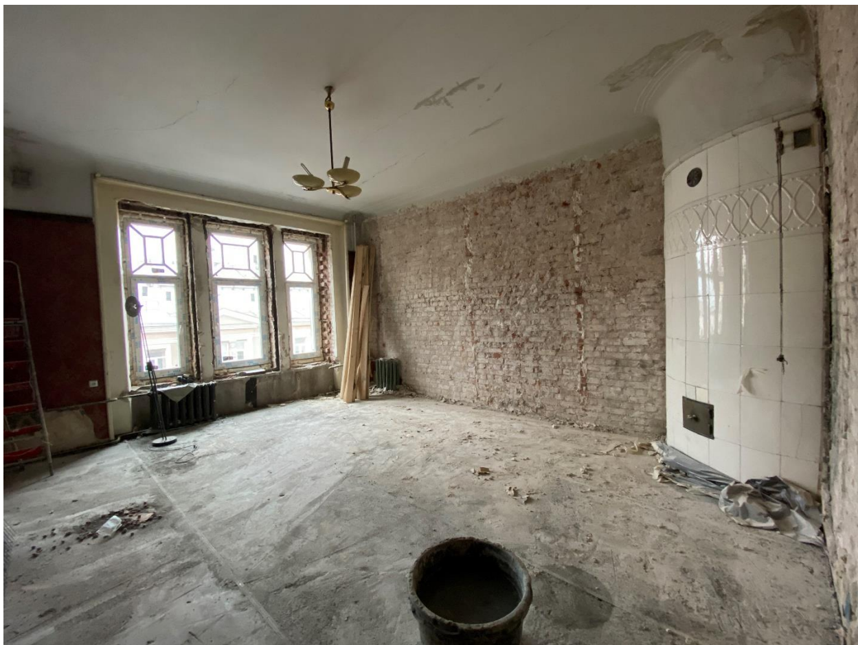
Фото 17. Помещение № 10. Комната. Вид с юго-востока.
