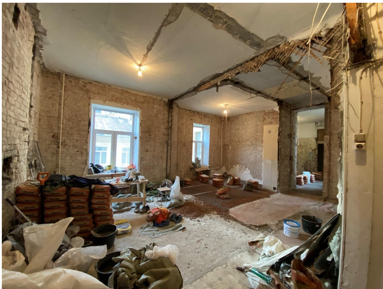
Фото 9. Общий вид помещений №№ 3, 4, 5, 9, 12 после демонтажа межкомнатных перегородок. Вид с северо-востока.
