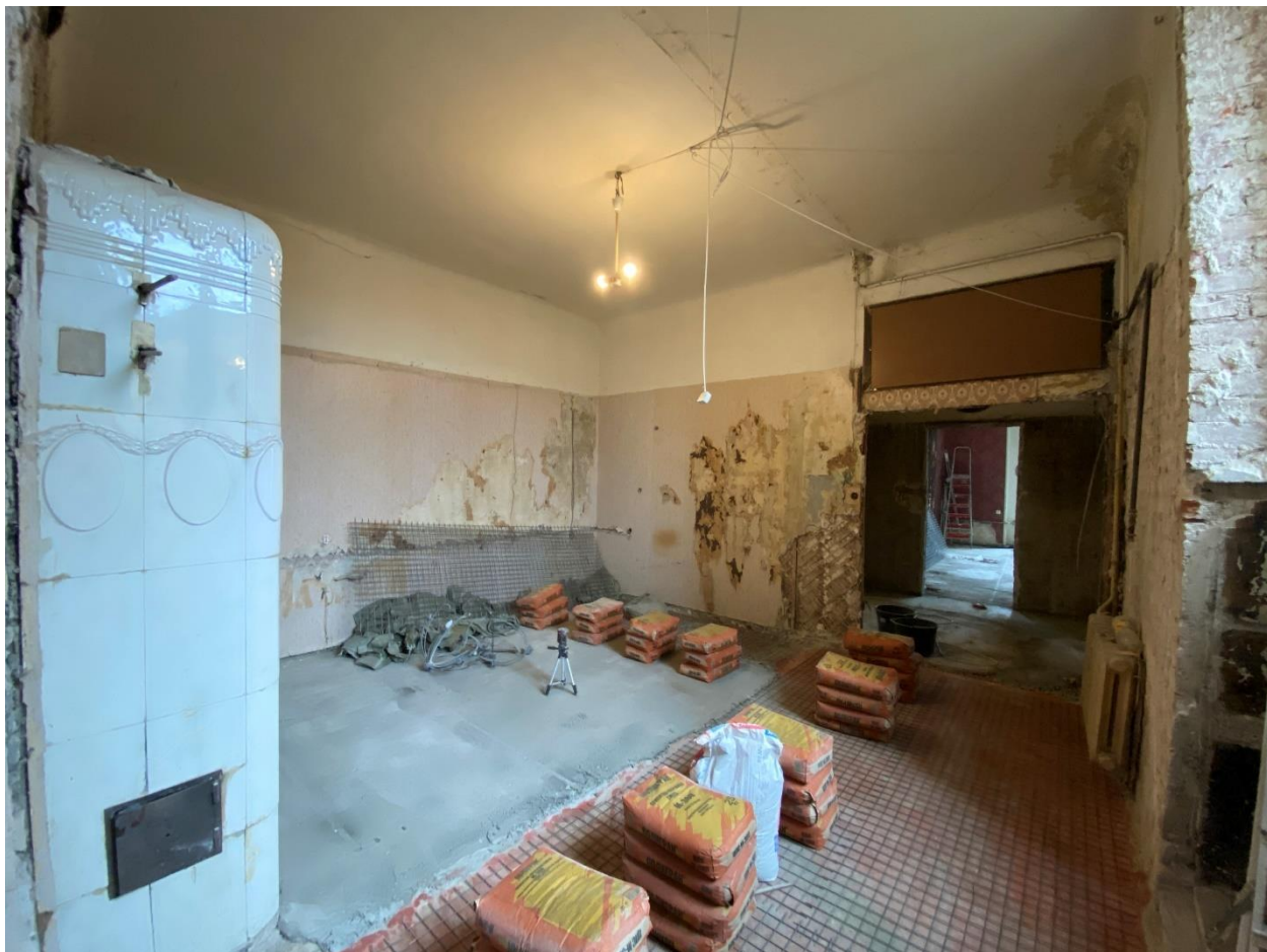
Фото 11. Помещение № 6. Кухня. Вид с северо-востока.
