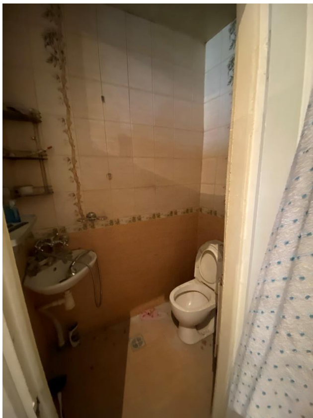
Фото 7. Помещение № 2. Туалет . Вид с юго-востока.
