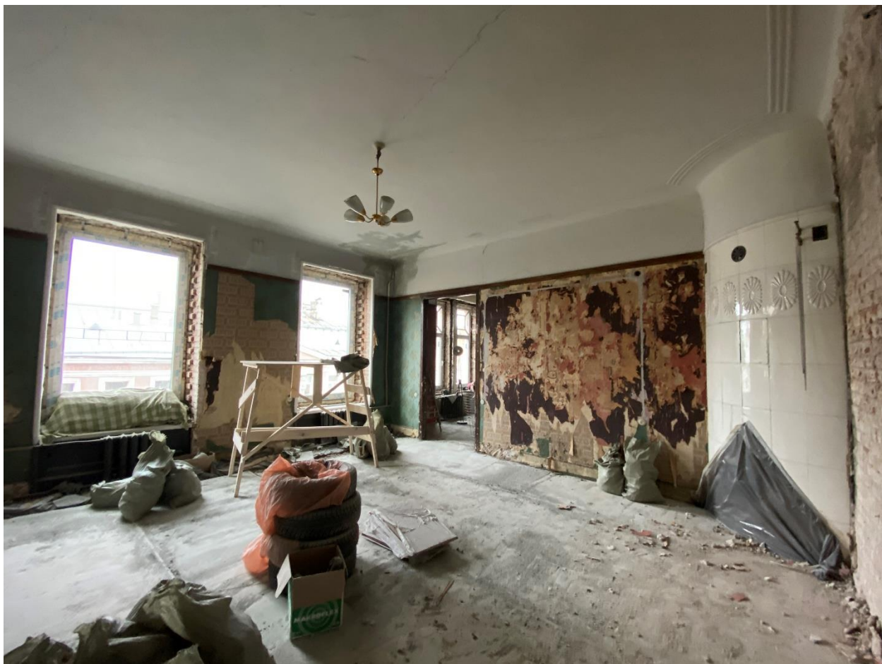
Фото 21. Помещение № 11. Комната. Вид с юго-востока.
