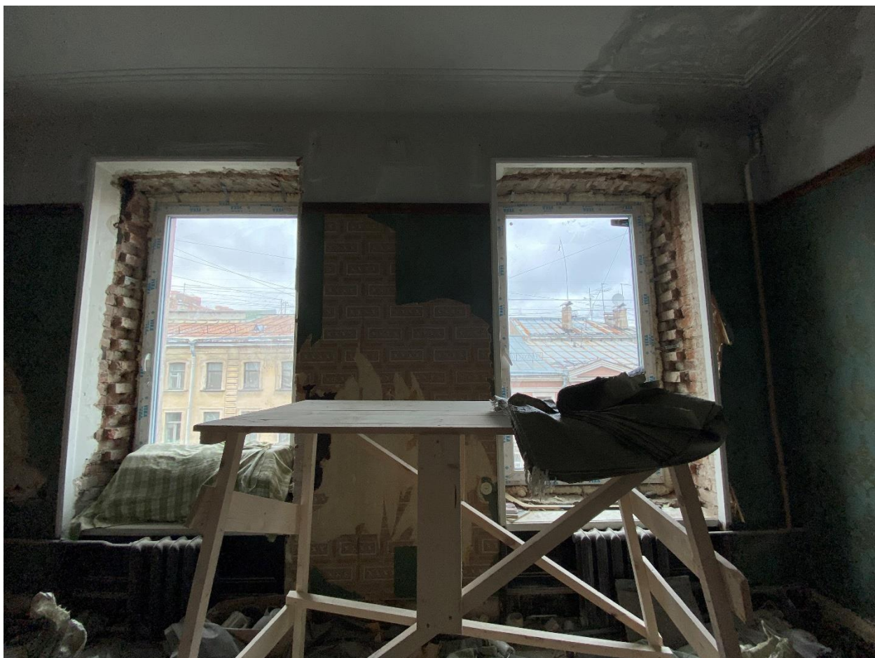
Фото 22. Помещение № 10. Комната. Современные металлопластиковые оконные заполнения с сохранением исторического рисунка расстекловки в помещении № 11. Вид с востока.
