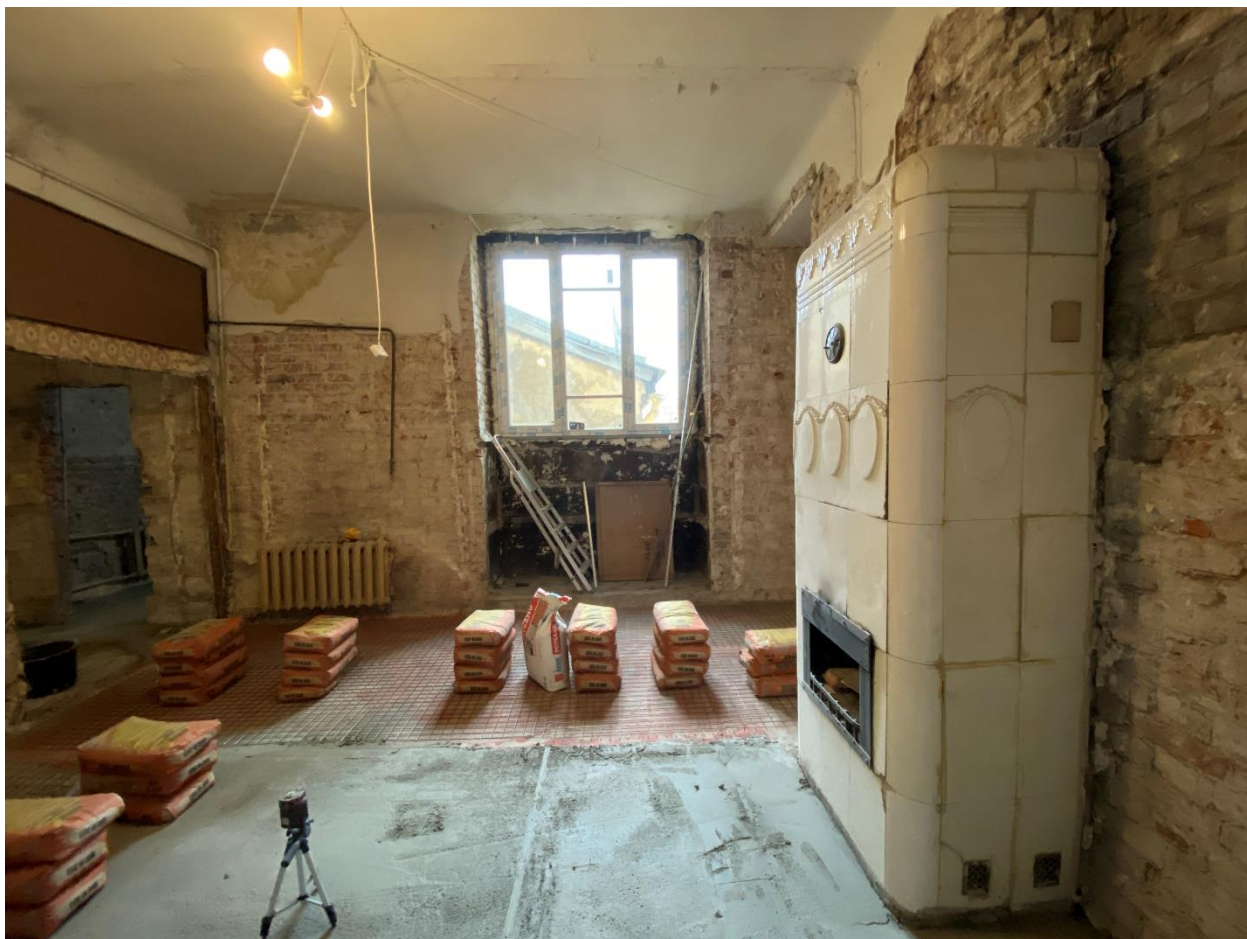
Фото 12. Помещение № 6. Кухня. Вид с юга.
