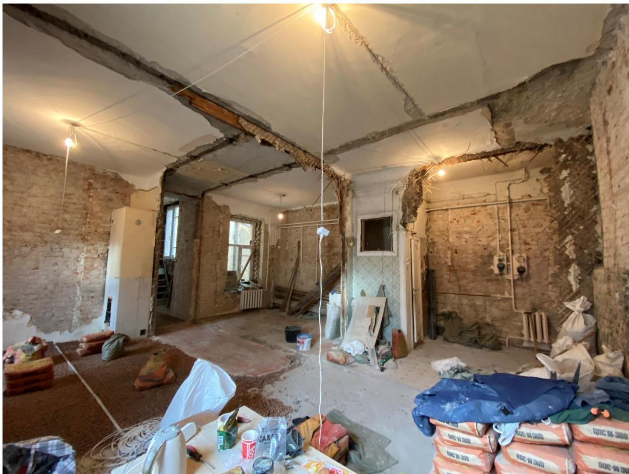
Фото 10. Общий вид помещений №№ 3, 4, 5, 9, 12 после демонтажа межкомнатных перегородок. Вид с юго-востока.
