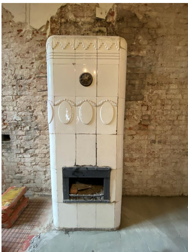
Фото 13. Помещение № 6. Кухня. Одноярусная печь, облицованная белыми рельефными изразцами, являющаяся элементом предмета охраны. Вид с запада.
