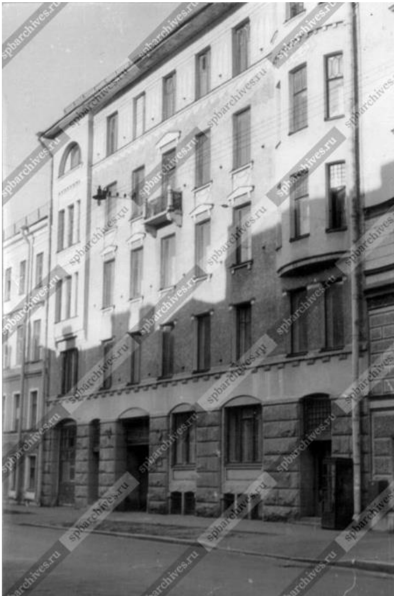
Илл. 69. «Вид фасада дома №14 на Моховой улице, построенного архитектором Ф.И. Лидвалем в 1905-1906 годах». Дата съёмки: 1982 г. // ЦГАКФФД СПб. Архивный шифр: Ар 122342.
