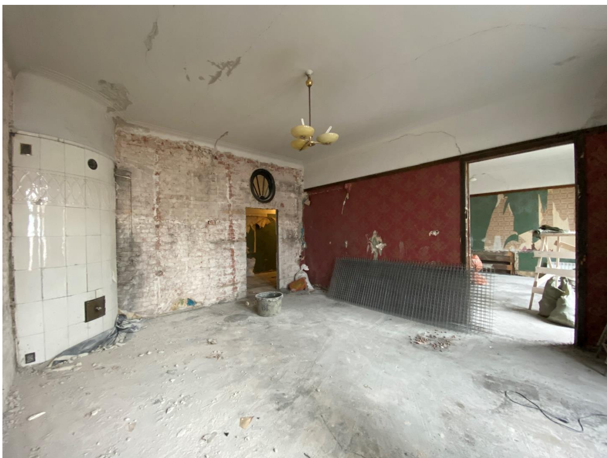
Фото 18. Помещение № 10. Комната. Вид с северо-запада.
