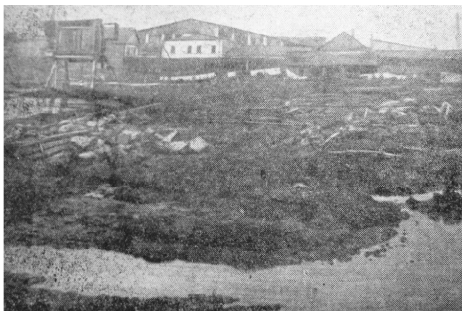
12. Начало строительства Володарского моста. Снимок 1932 года. «Невская застава. Володарский район». Л. 1939 г.
