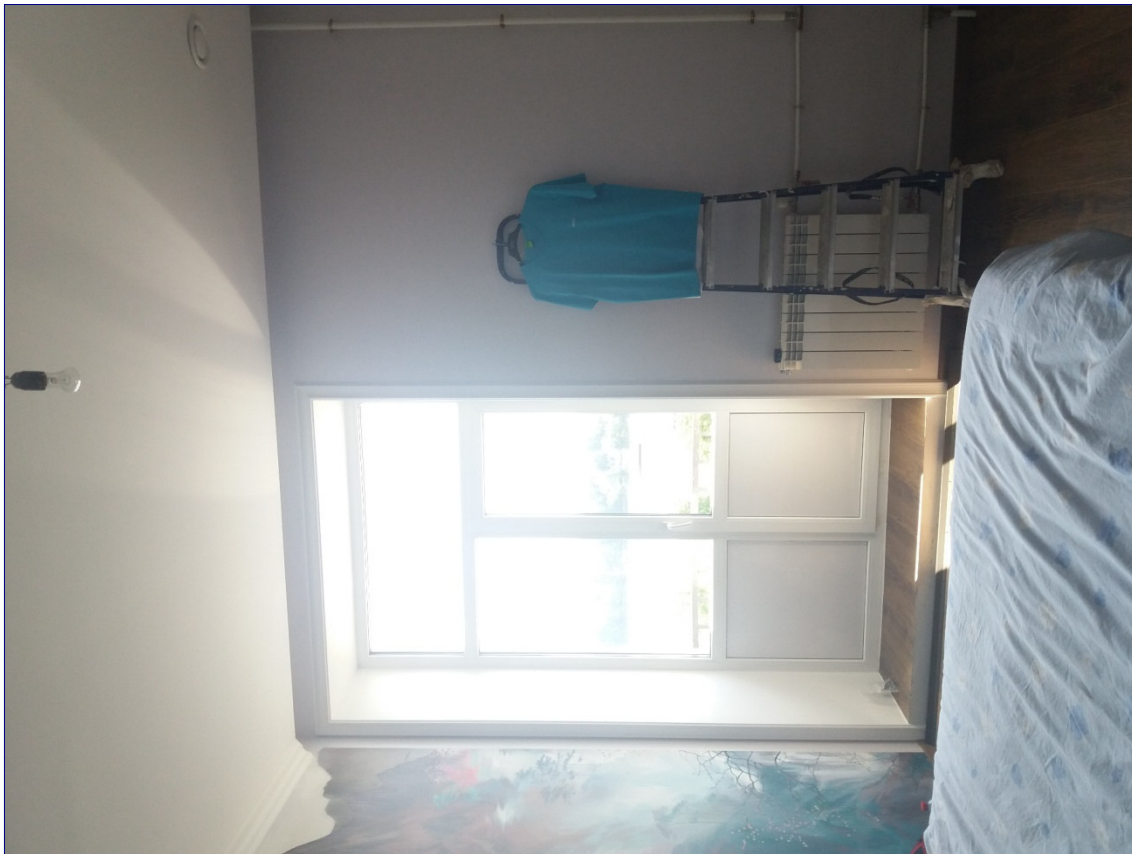
Фото 17. Помещение № 8. Дата съемки 05.06.2019 г.
