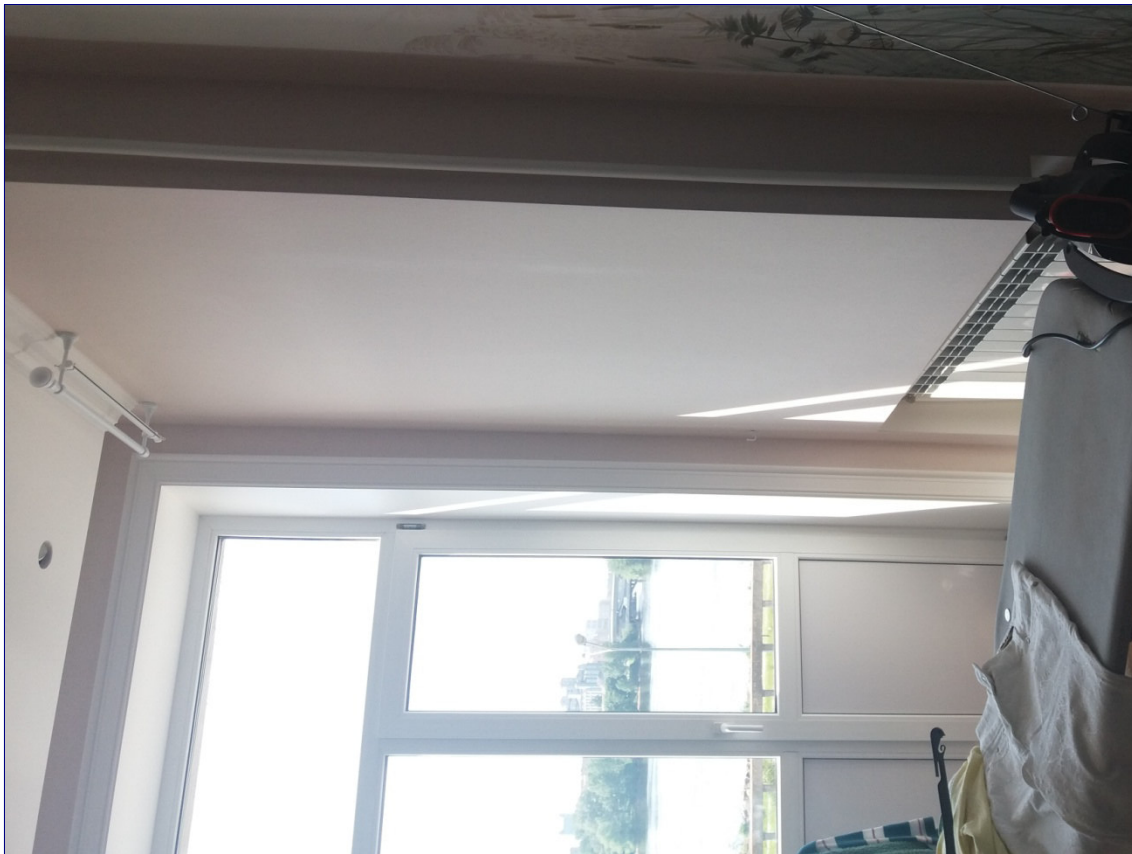
Фото 11. Помещение № 10. Дата съемки 05.06.2019 г.
