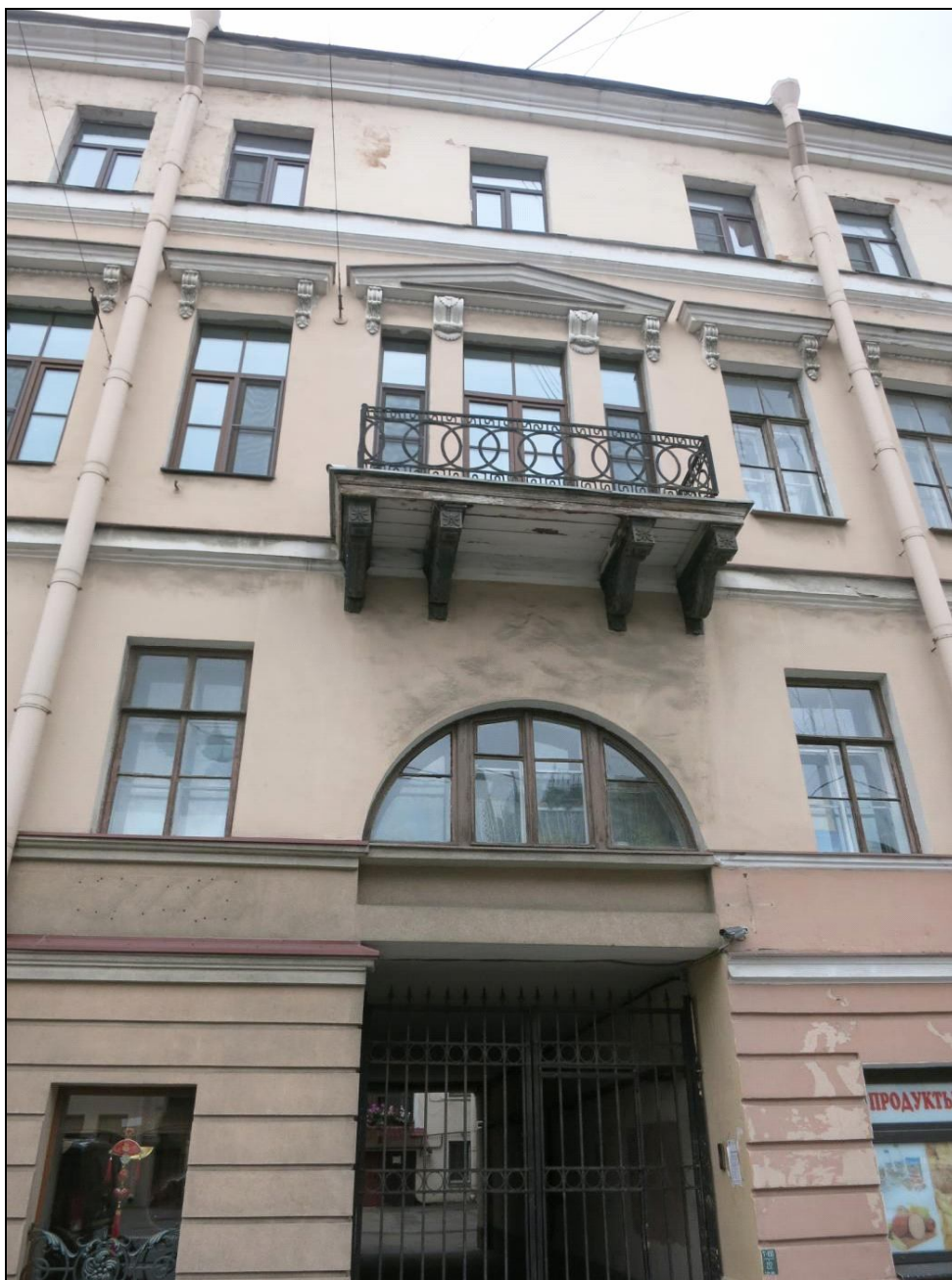
2. Фрагмент лицевого фасада. Вид с 8-й линии В.О.
