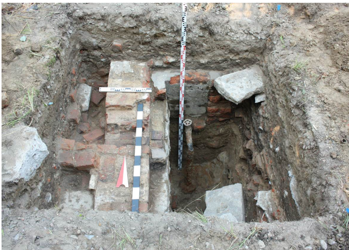
Рис. 21. Шурф № 3. Кладка поперечной стены оранжереи с каналом воздуховода. Кладка северной стенки приемки под стальную трубу. Вид с юга.
