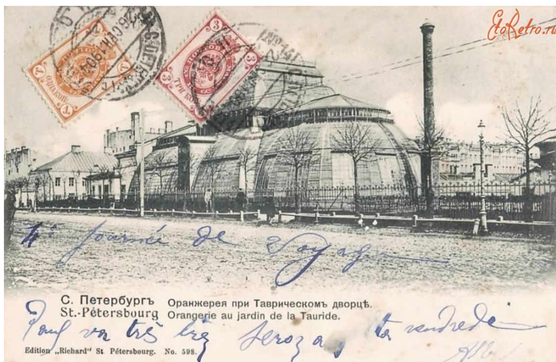
Рис. 12. Санкт-Петербург-2021. Таврический сад. Оранжерейный комплекс Таврического сада. Вид со стороны Потемкинской улицы. Открытка 1904 г.
