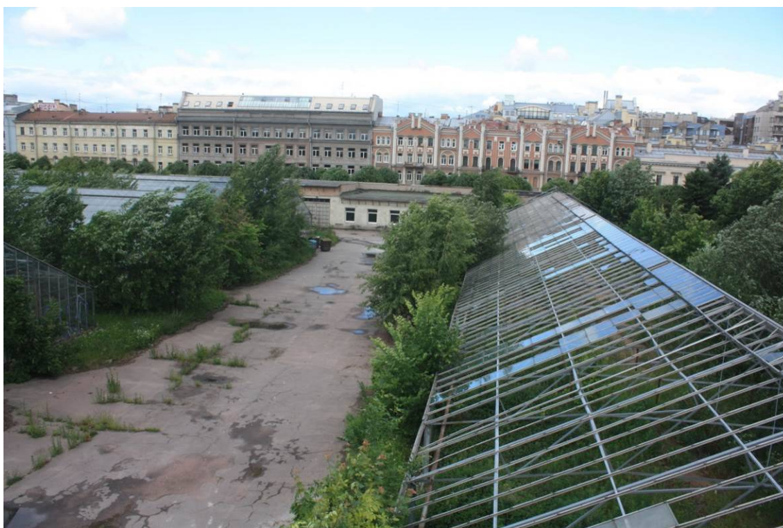
Рис. 34. Санкт-Петербург-2021. Таврический сад. Вид на северо-восточную часть обследуемой территории. Вид с юга. Фото 2016 г.
