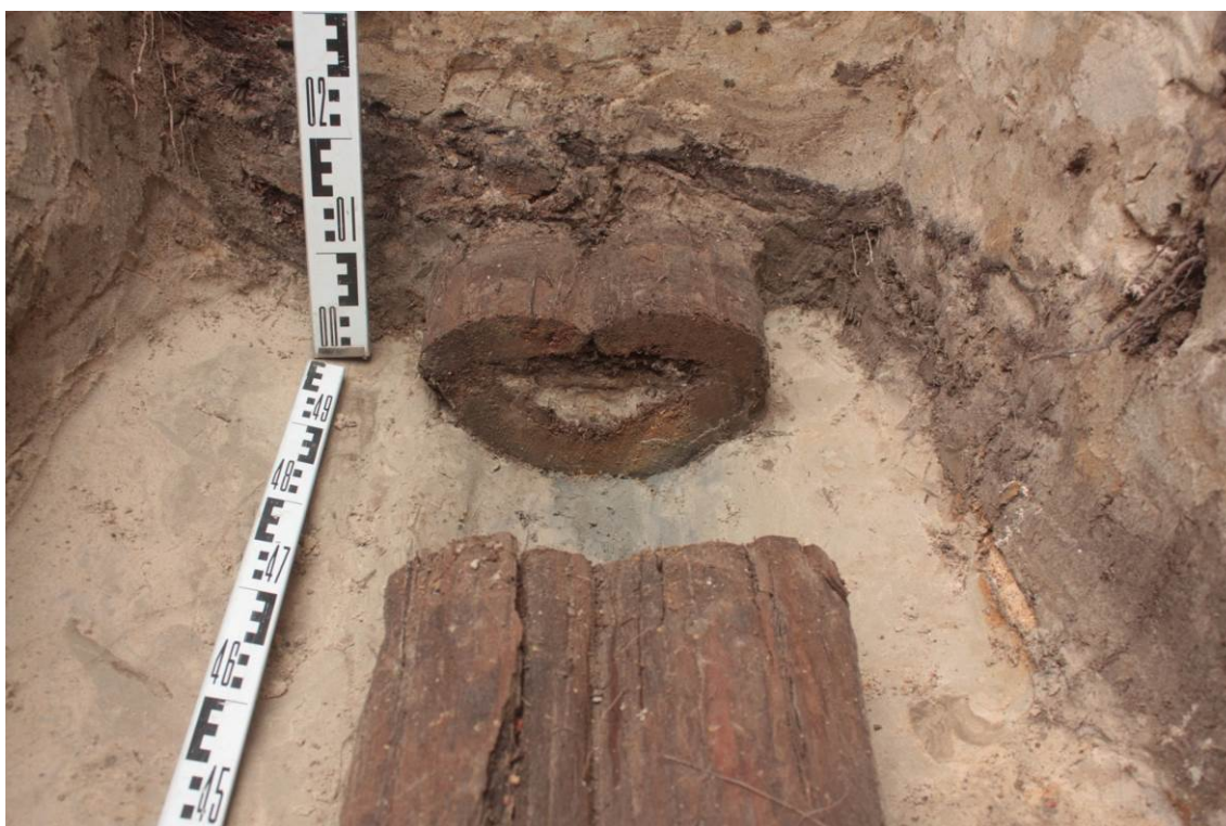
Рис. 17. Санкт-Петербург-2021. Таврический сад. Шурф № 2 2016 г. Деревянная труба в траншее № 2. Разрез трубы. Вид с юго-запада.
