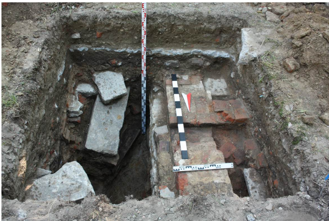
Рис. 22. Шурф № 3. Кладка поперечной стены оранжереи с каналом воздуховода. Каменная плита и каменная ступень в юго-восточном углу шурфа. Вид с севера.
