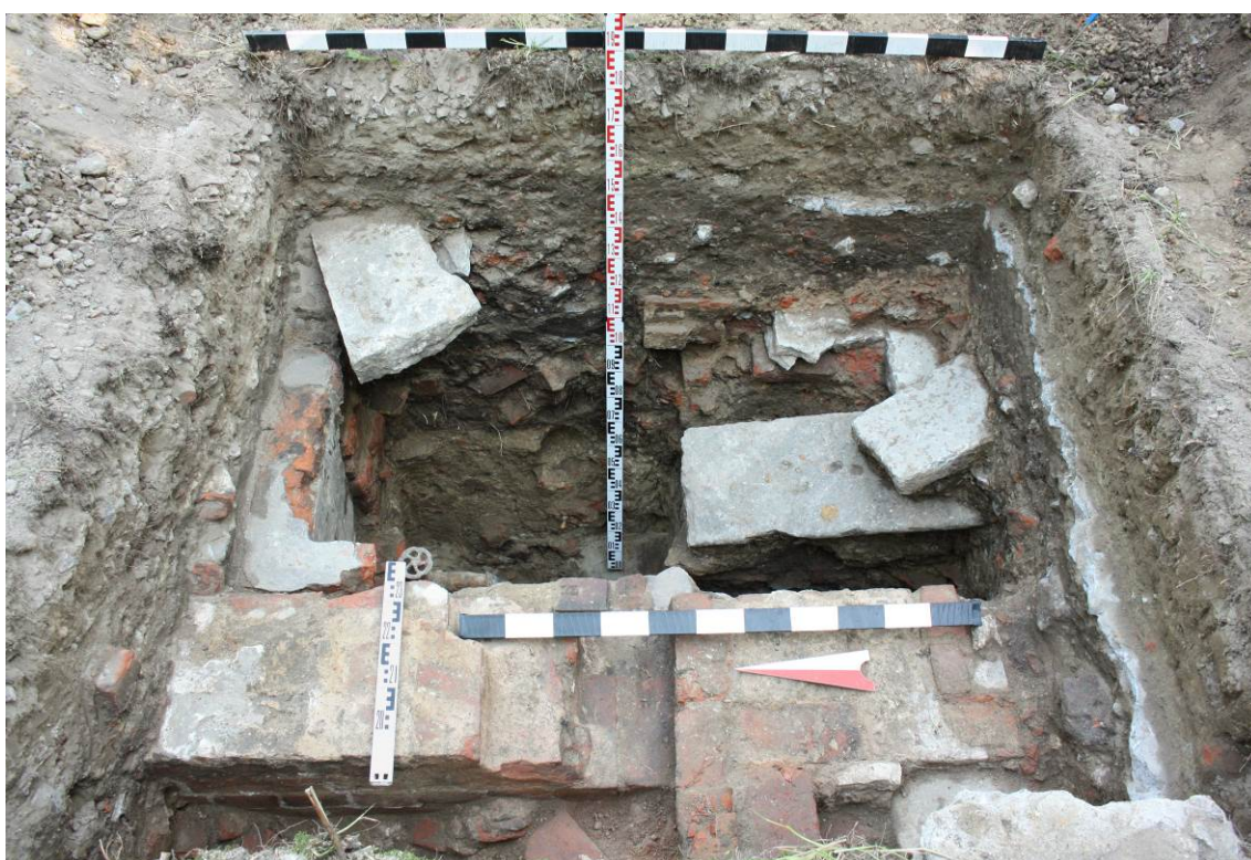
Рис. 23. Шурф № 3. Кладка поперечной стены оранжереи с каналом воздуховода. Каменная плита и каменная ступень в юго-восточном углу шурфа. Вид с запада.
