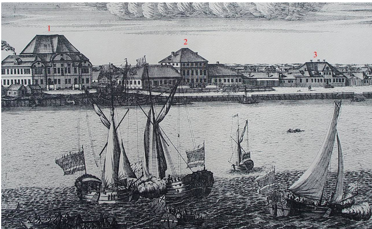
Рис. 3. Санкт-Петербург-2021. Таврический сад. Застройка набережной Невы к востоку от Литейного двора (фрагмент гравюры А.Ф. Зубова «Панорама Санкт-Петербурга» 1716 г.): 1 – дворец А.П. Голицыной, 2 – дворец Натальи Алексеевны, 3 – дворец Алексея Петровича.
