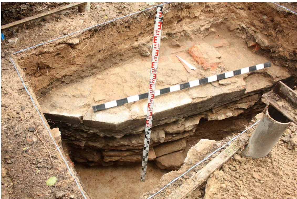
Рис. 18. Шурф № 2. Кладка фундамента выступа южной стены оранжереи. Вид с юго-запада.
