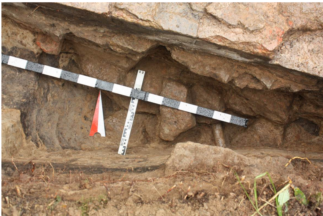
Рис. 61. Санкт-Петербург-2021. Таврический сад. Шурф № 2. Зачистка поверхности восточной части шурфа по материке и западной части шурфа по слою светло-желтой супеси. Выбранное заполнения траншеи. Керамическая труба, проложенная через кладку фундамента. Вид с юга.
