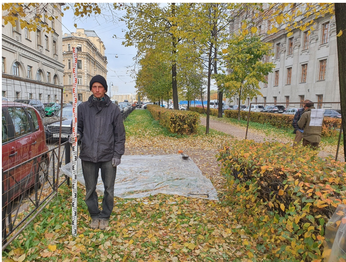
Рис. 17. СПб-2021. Василеостровский район, Биржевая линия, д. 14. Общий вид участка обследования. Шурф 1. До начала работ. Вид с юга
