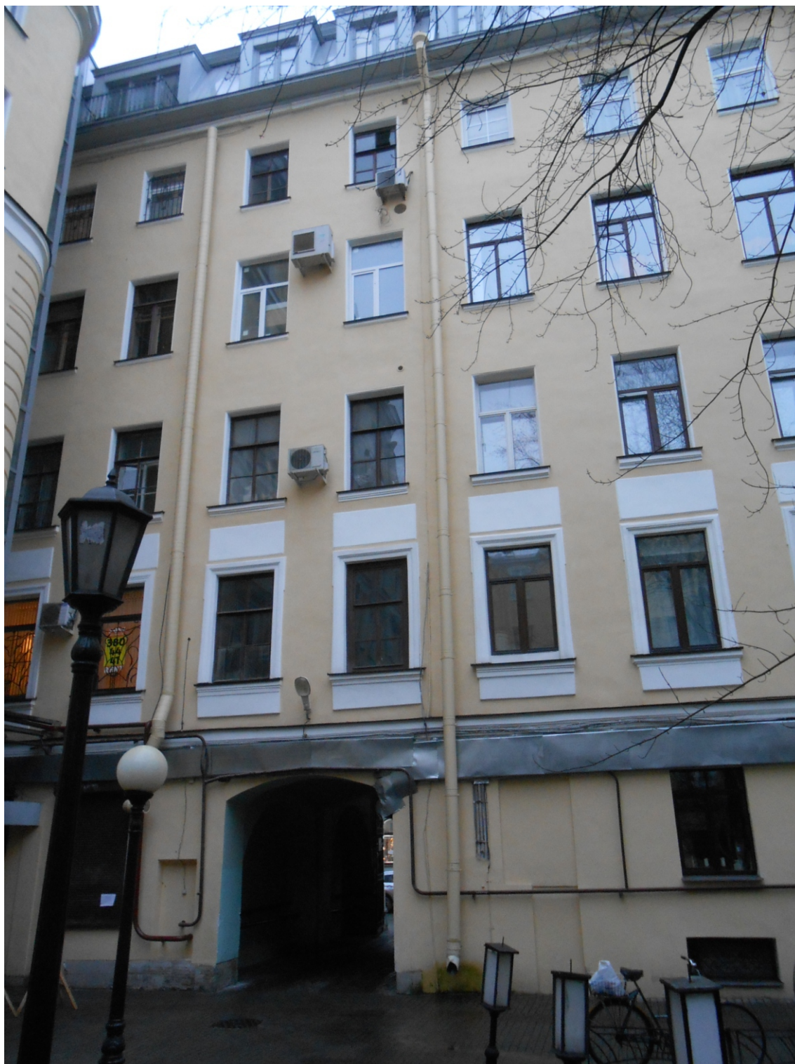
10. Дом Меншиковых (Русско-Азовского банка). Караванная ул., дом 11/64, литера А. Восточный дворовый фасад. Фрагмент. Фото: 02.12.2021.
