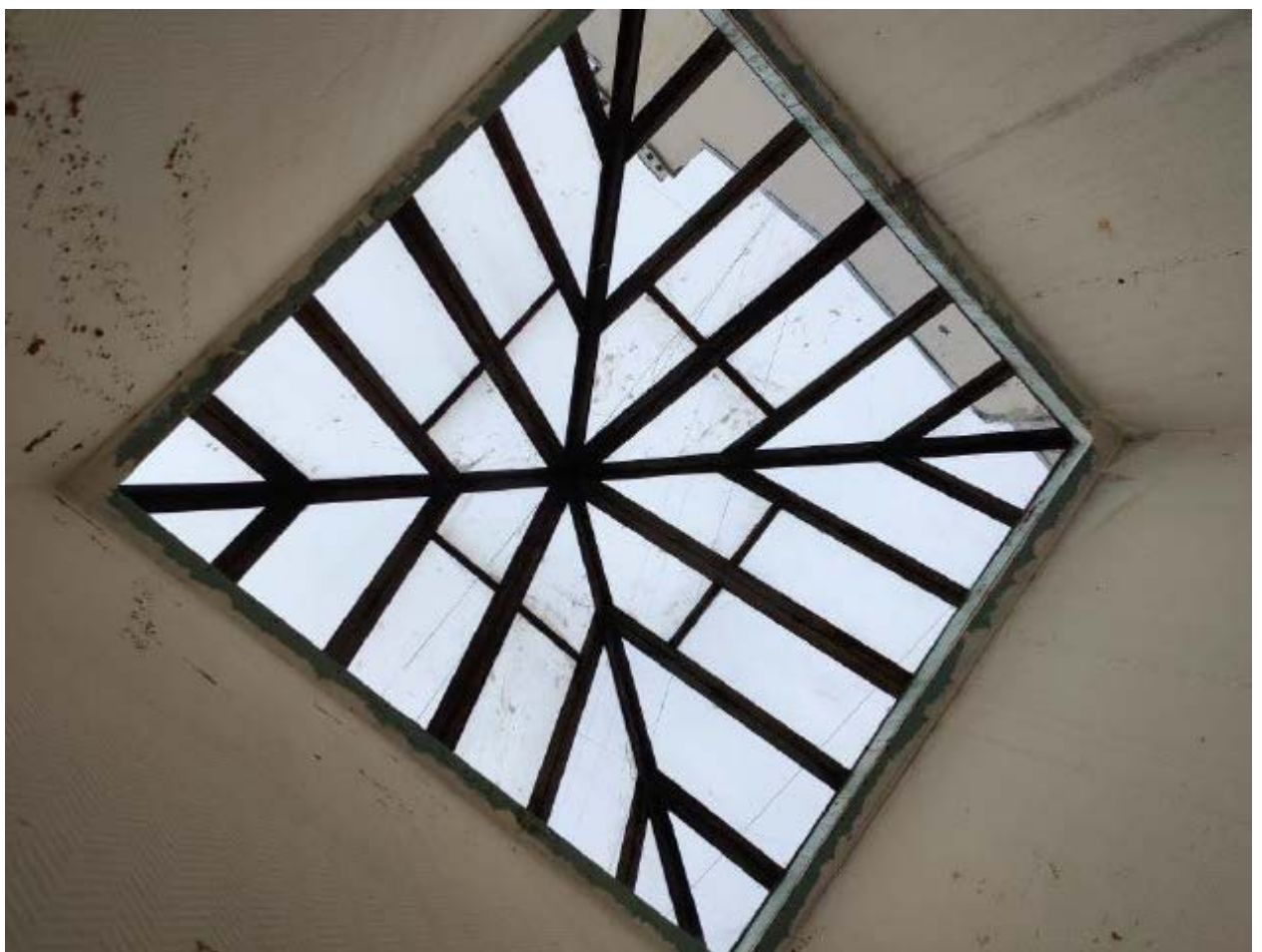
5. Световой фонарь объекта культурного наследия регионального значения «Быв. дом Белозерского», расположенного по адресу: г. Санкт-Петербург, ул. Куйбышева, д. 25, литера А. 15.10.2021
