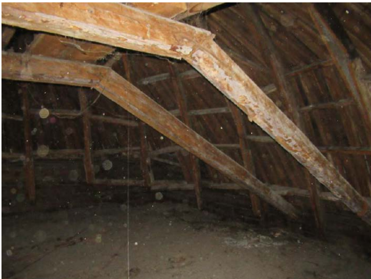
18. Конструкции купола объекта культурного наследия регионального значения «Быв. дом Белозерского», расположенного по адресу: г. Санкт-Петербург, ул. Куйбышева, д. 25, литера А. 15.10.2021.
