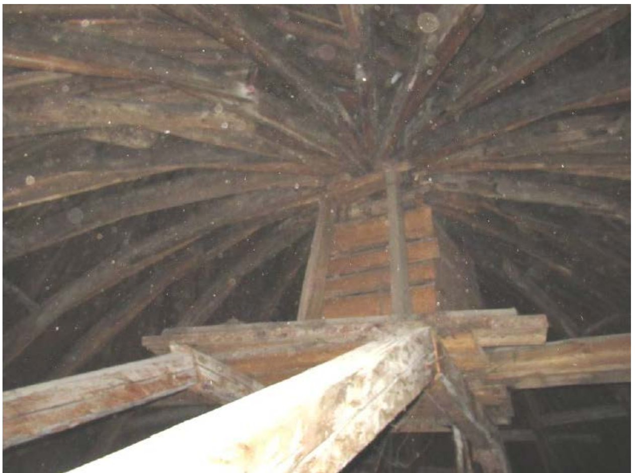
17. Конструкции купола объекта культурного наследия регионального значения «Быв. дом Белозерского», расположенного по адресу: г. Санкт-Петербург, ул. Куйбышева, д. 25, литера А. 15.10.2021.
