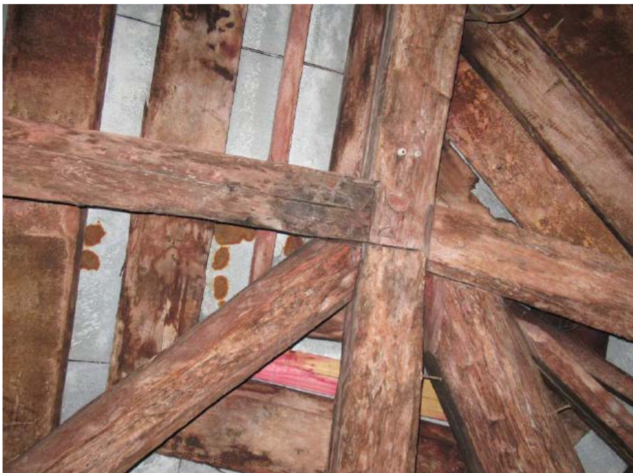
14. Стропильная система объекта культурного наследия регионального значения «Быв. дом Белозерского», расположенного по адресу: г. Санкт-Петербург, ул. Куйбышева, д. 25, литера А. 15.10.2021.
