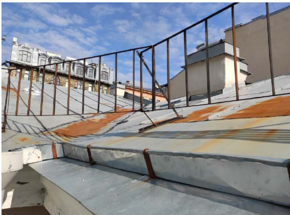
19. Кровля объекта культурного наследия регионального значения «Быв. дом Белозерского», расположенного по адресу: г. Санкт-Петербург, ул. Куйбышева, д. 25, литера А. 15.10.2021.
