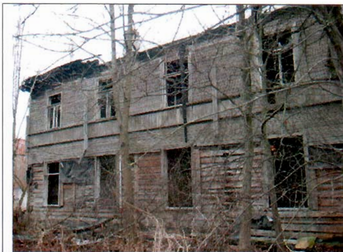
7. Восточный фасад. Общий вид.
