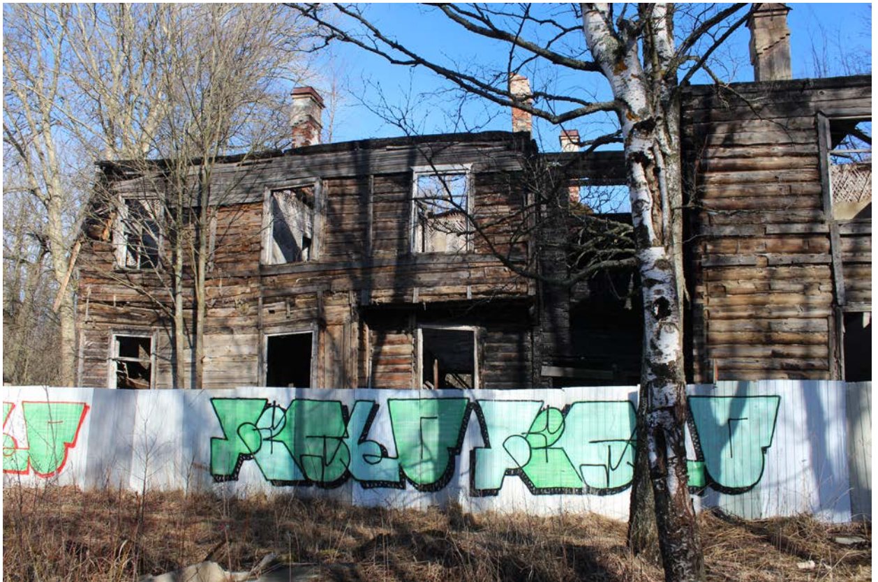
13. Объект культурного наследия «Усадьба Ю.И. Жерар-де-Суконтон (главный дом с территорией)», расположенный по адресу: Санкт-Петербург, город Петергоф, Собственный проспект, дом 4, литера А. Южный фасад.
