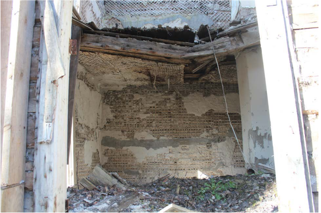
15. Объект культурного наследия «Усадьба Ю.И. Жерар-де-Суконтон (главный дом с территорией)». Восточный фасад, первая световая ось.
