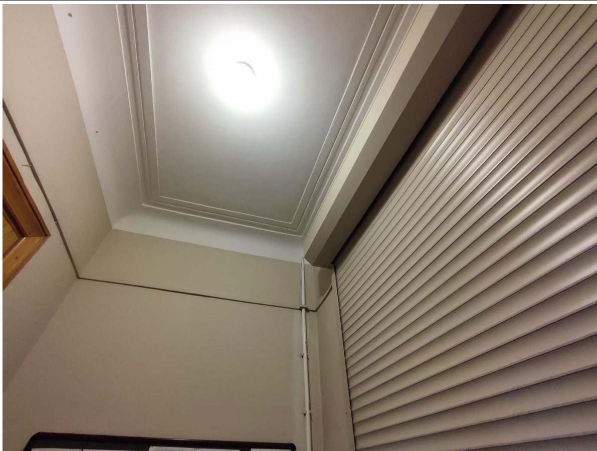
10. Фрагмент пом. 1-Н (1) в уровне 1-го этажа.
