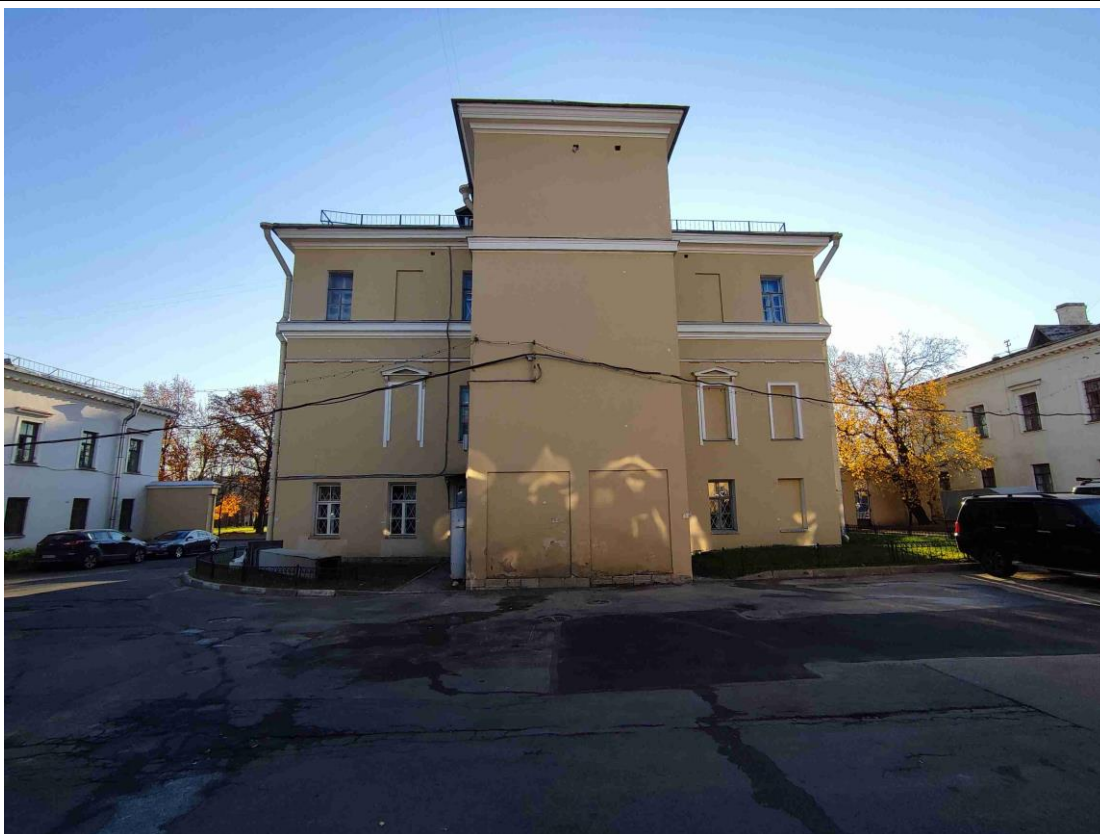
7. Общий вид северо-западного дворового фасада объекта культурного наследия федерального значения «Управление городское с оградой и воротами».
