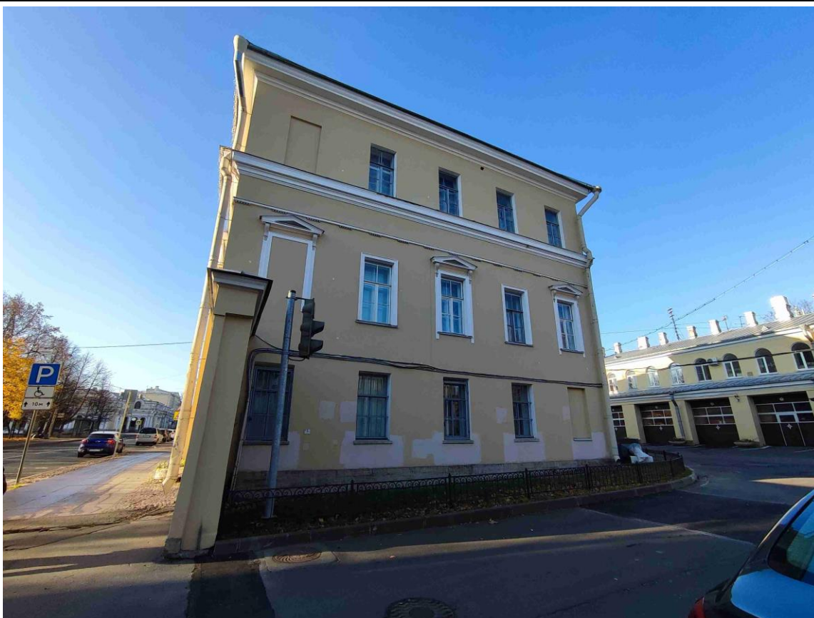
4. Общий вид северо-восточного торцевого фасада объекта культурного наследия федерального значения «Управление городское с оградой и воротами».
