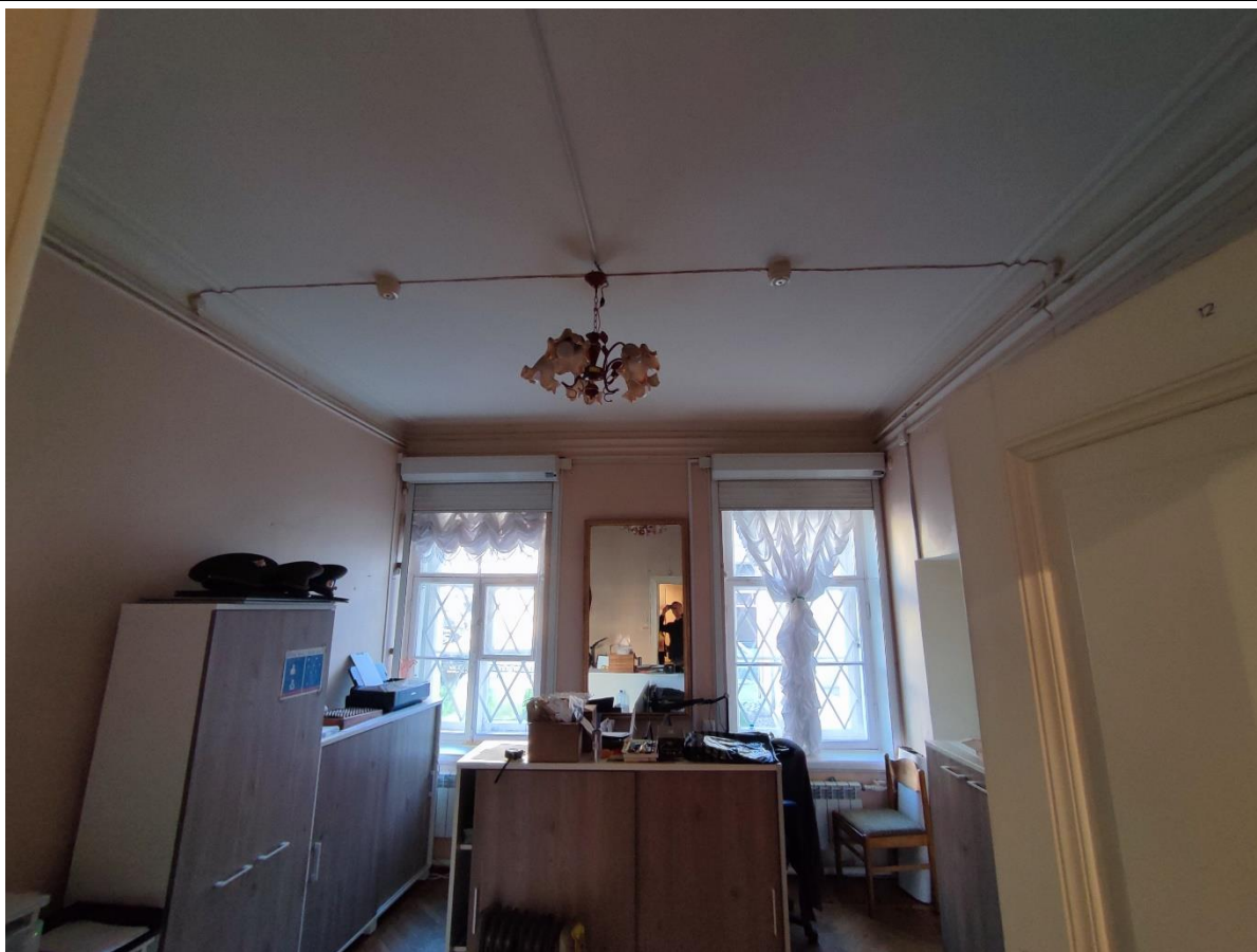
12. Общий вид пом. 1-Н (8) в уровне 1-го этажа.
