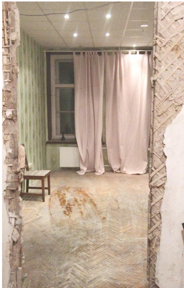
Фото 20. Помещение 2 до демонтажа перегородки между помещениями 1 и 2.
