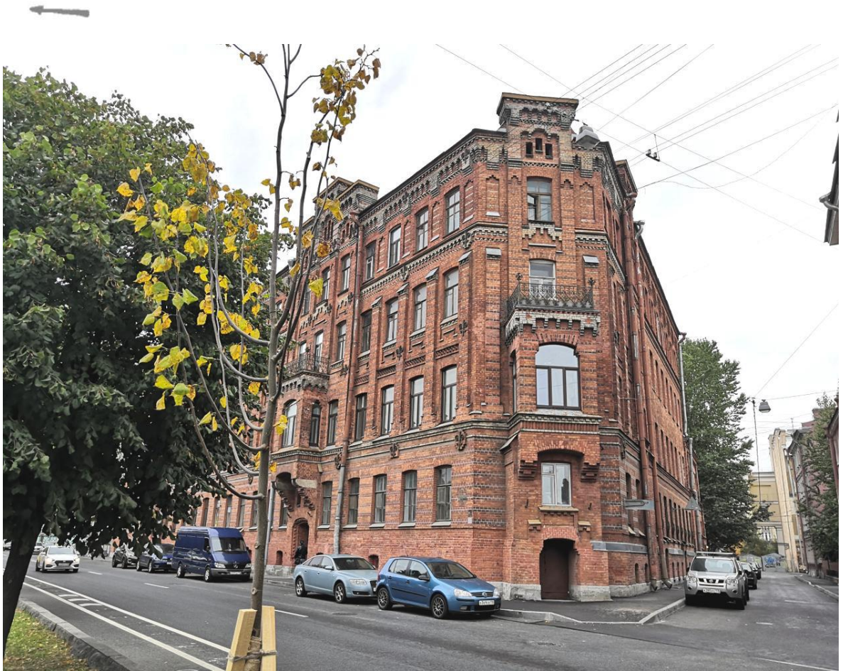
Фото 2. Угловая часть дома №183. Вид с нечетной стороны набережной реки Фонтанки. Справа – Калинин пер. Вид с юго-востока.
