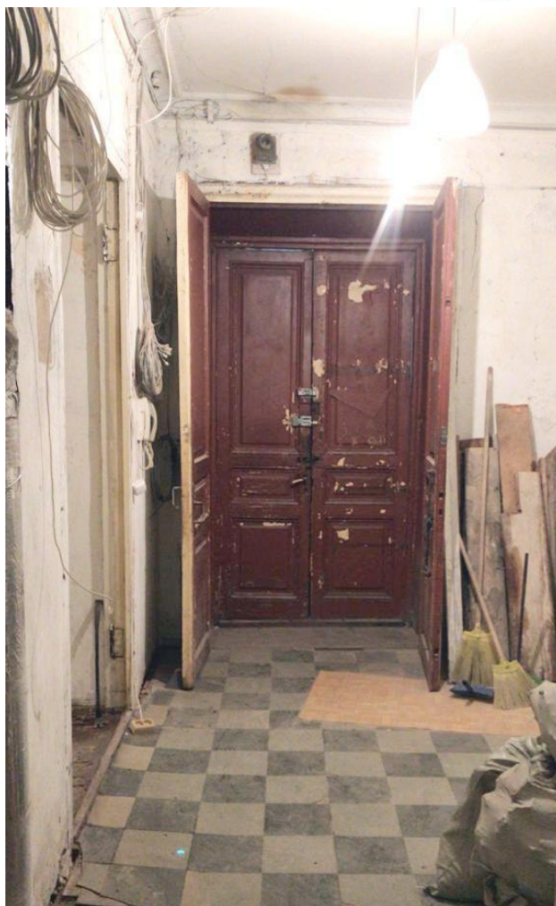
Фото 17. Вход в кв. №10 с парадной лестницы. Вид со стороны квартиры.
