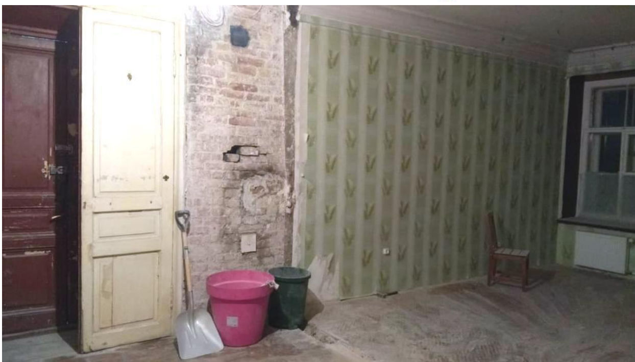
Фото 19. Помещение 1. Холл. Вид на комнату 2 после демонтажа перегородки между помещениями 1 и 2.
