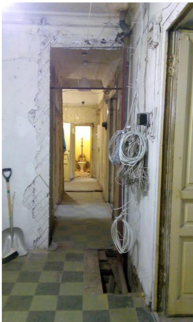
Фото 18. Помещение 1. Холл. Вид от парадного входа в квартиру в сторону помещений 11, 6, 12.
