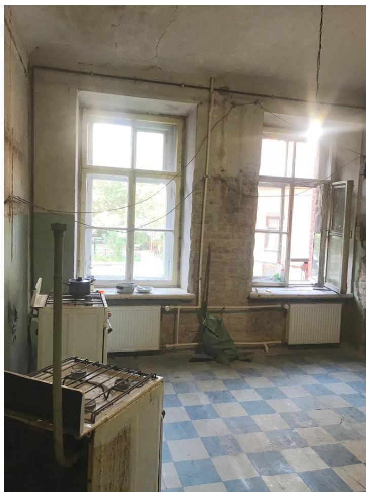
Фото 23. Кухня (помещение 4). Вид в сторону окон.
