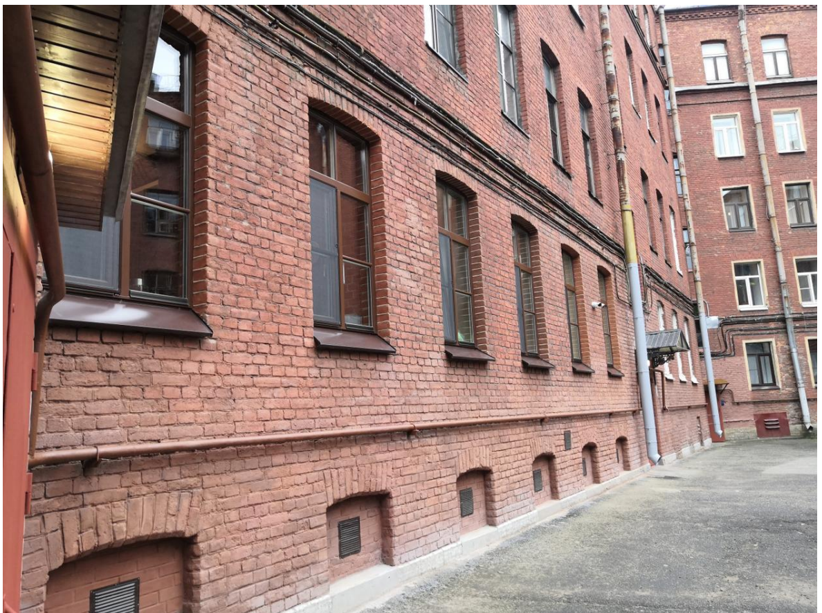
Фото 8. Дворовый фасад лицевого флигеля по наб. р. Фонтанки. Вид с востока. 6 окон первого этажа в левой части фотографии принадлежат квартире №10.
