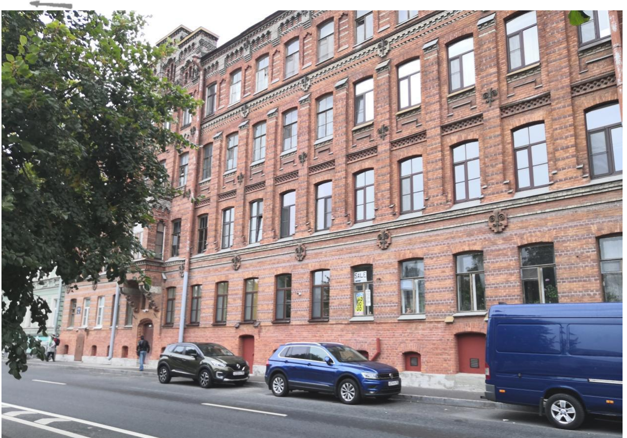
Фото 3. Западная часть лицевого фасада по наб. р. Фонтанки. Вид с юго-востока.
