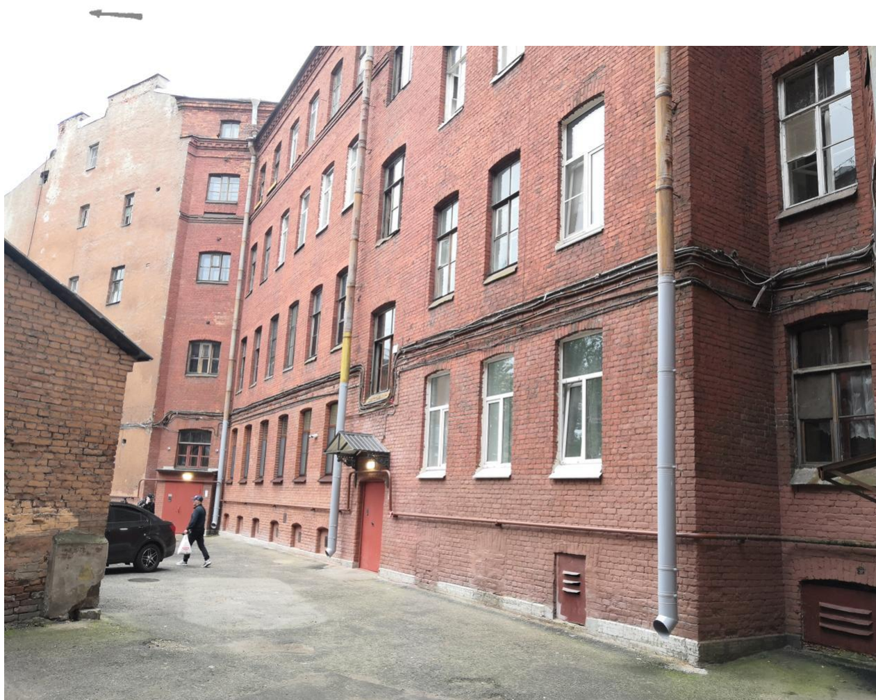
Фото 12. Фрагмент дворового фасада лицевого флигеля по наб. р. Фонтанки. Вид с запада.
