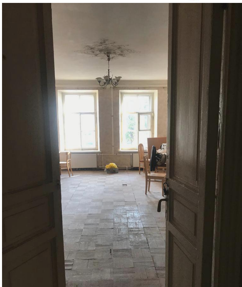
Фото 27. Общий вид помещения 9 в сторону окон
