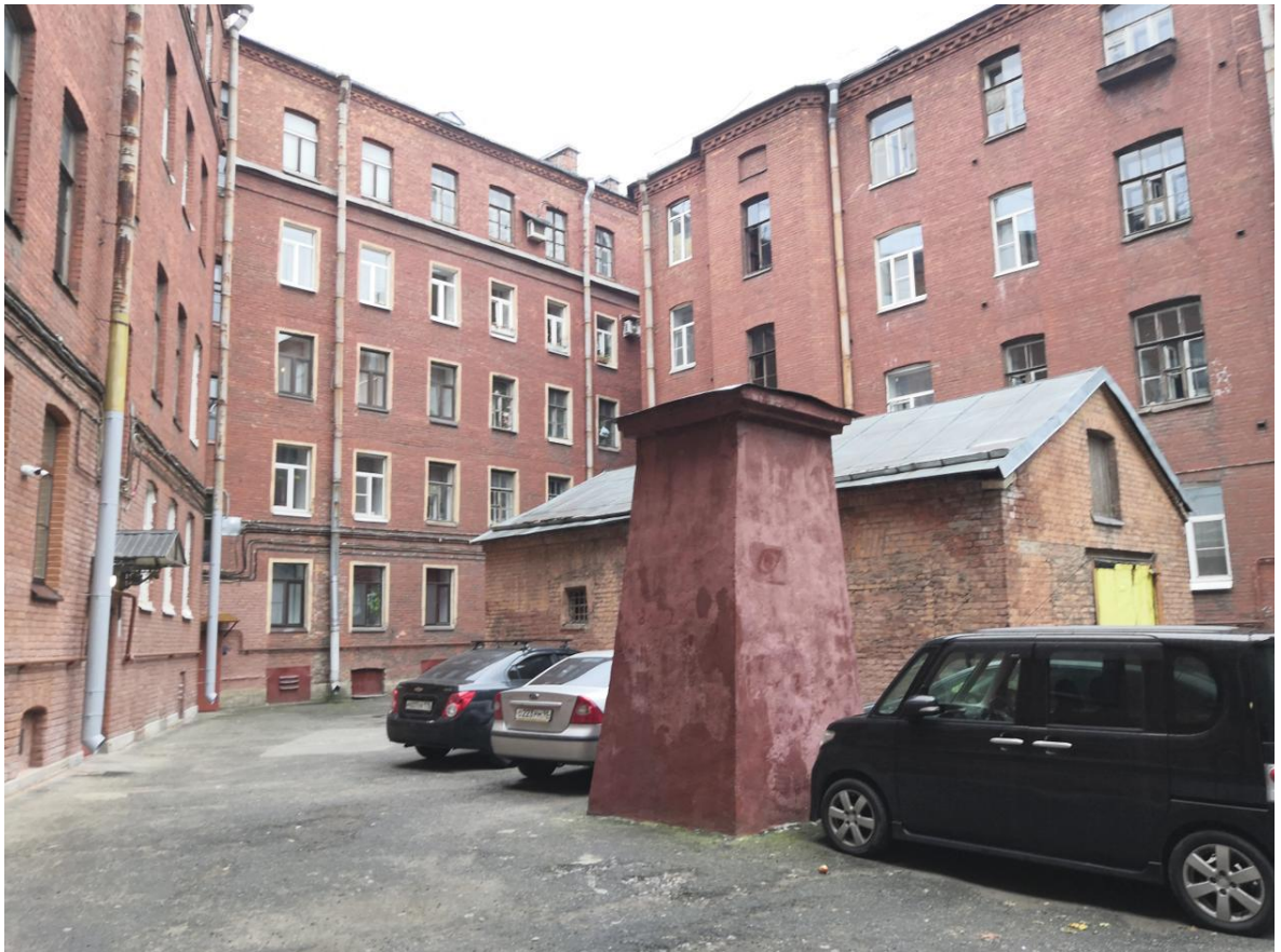
Фото 9. Дворовая территория. Западная часть. Вид с востока.
