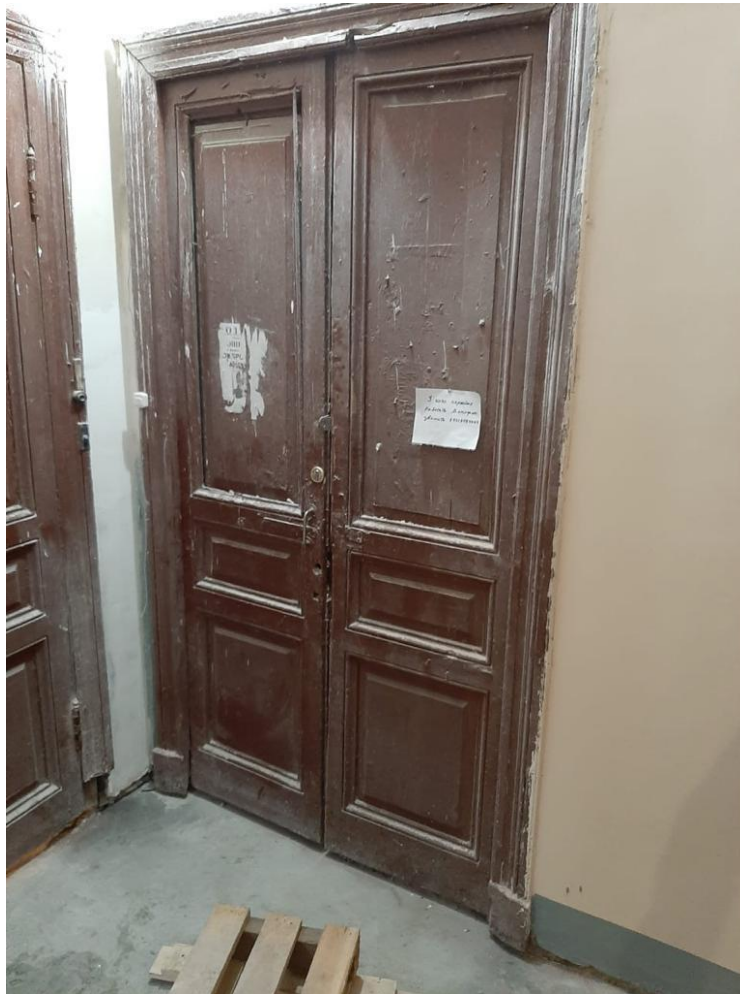
Фото 14. Лестничная площадка 1-го этажа парадного входа с наб. р. Фонтанки.
