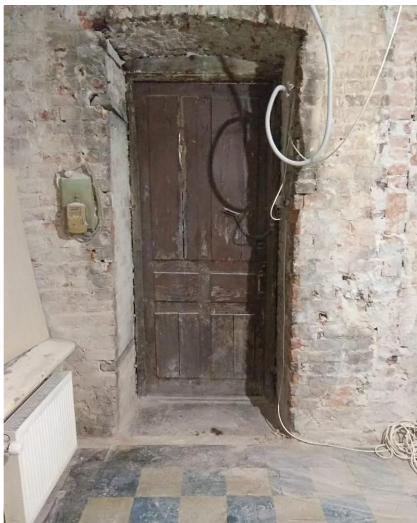
Фото 16. Вход в кв. №10 с «черной» лестницы. Вид со стороны квартиры.
