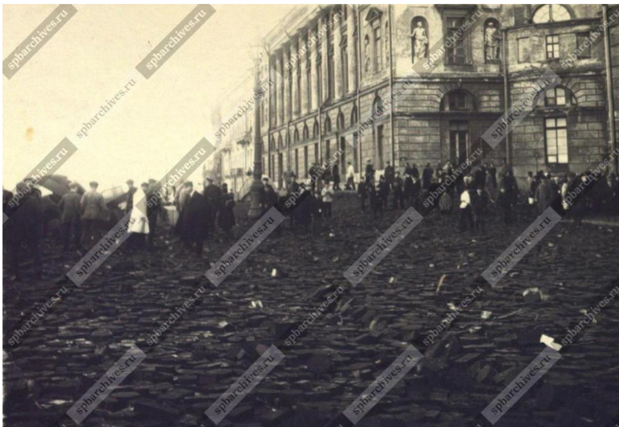
Илл. 7. Разборка торцовых шашек на Дворцовой набережной у Эрмитажа после наводнения. 23 сентября 1924 г. (источник: ЦГАКФФД СПб. Фотодокумент Гр 1607).
