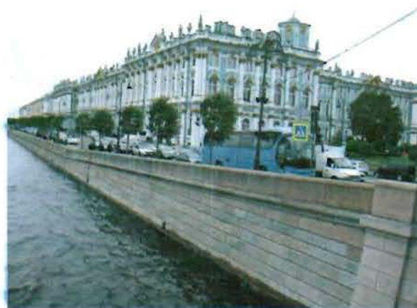
16. Вид стенки набережной с Дворцового моста
