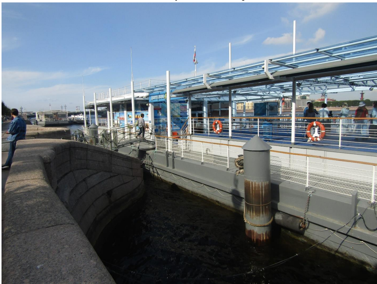
Фото 15. Вид на северо-восточный швартовно-отбойный бал.
