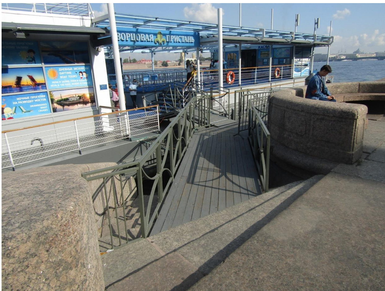
Фото 6. Вид на юго-западную часть трапового перехода.
