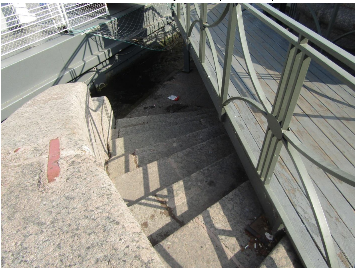
Фото 7. Вид на юго-западную лестницу спуска № 8.
