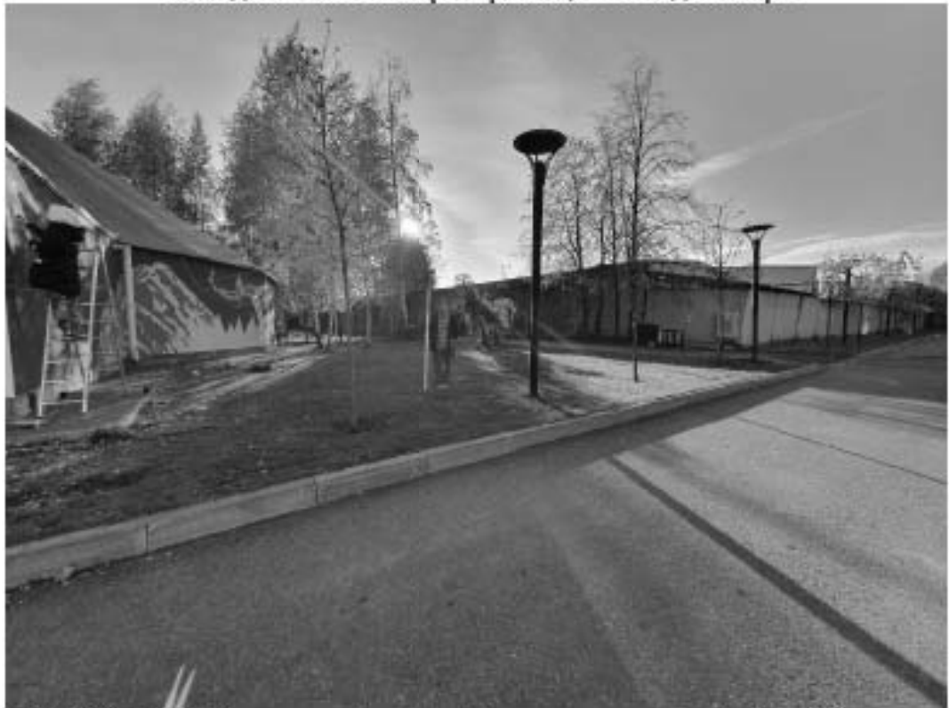
Рис. 20. СПб-2021. Калининский район, Свердловская наб., 44. Общий вид участка обследования. Точка фотофиксации 4. Вид с юго-востока
