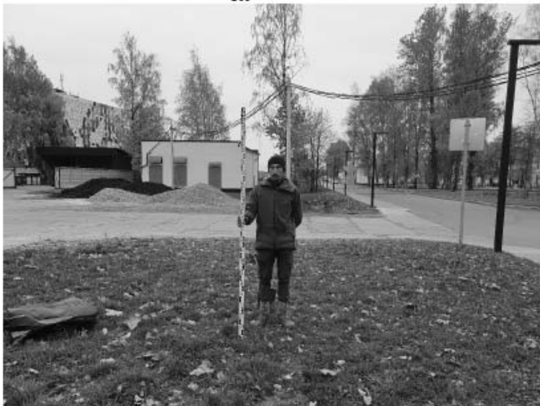
Рис. 46. СПб-2021. Калининский район, Свердловская наб., 44. Общий вид участка обследования. Шурф 3. До начала работ. Вид с севера
