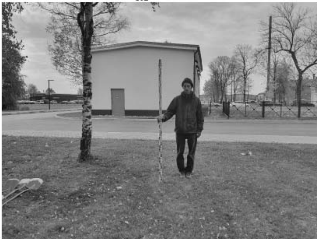
Рис. 35. СПб-2021. Калининский район, Свердловская наб., 44. Общий вид участка обследования. Шурф 2. До начала работ. Вид с севера
