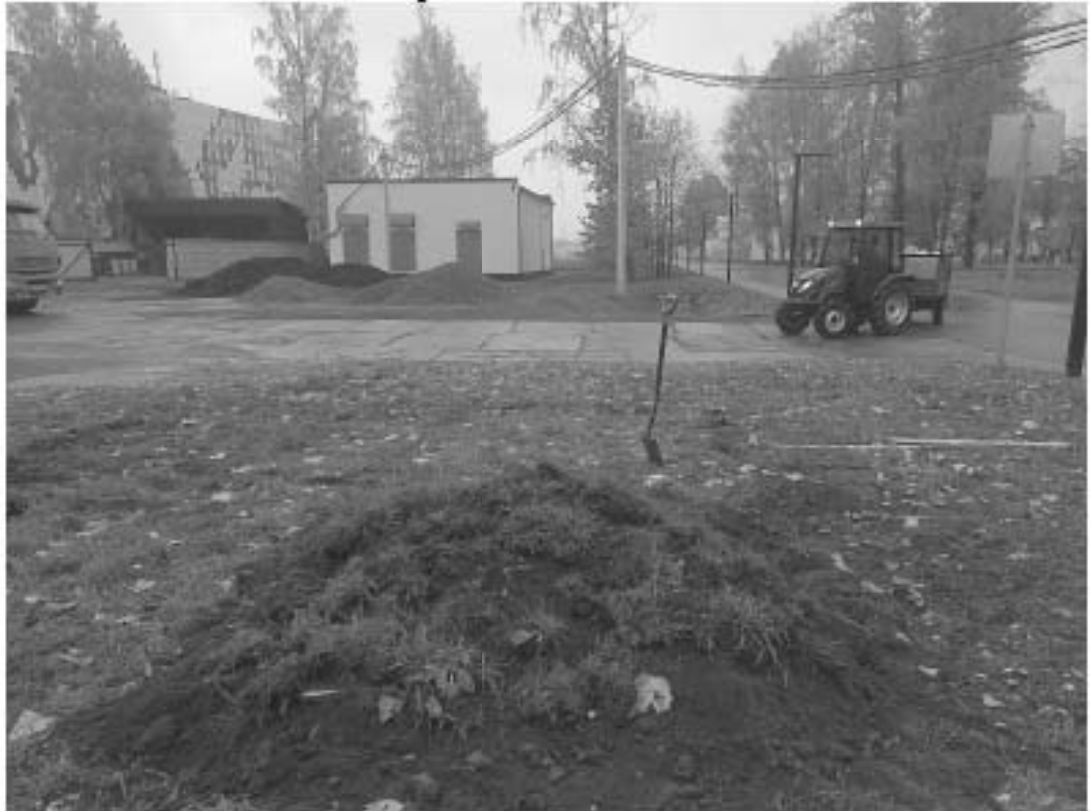
Рис. 53. СПб-2021. Калининский район, Свердловская наб., 44. Шурф 3. Общий вид участка обследования. Рекультивация
