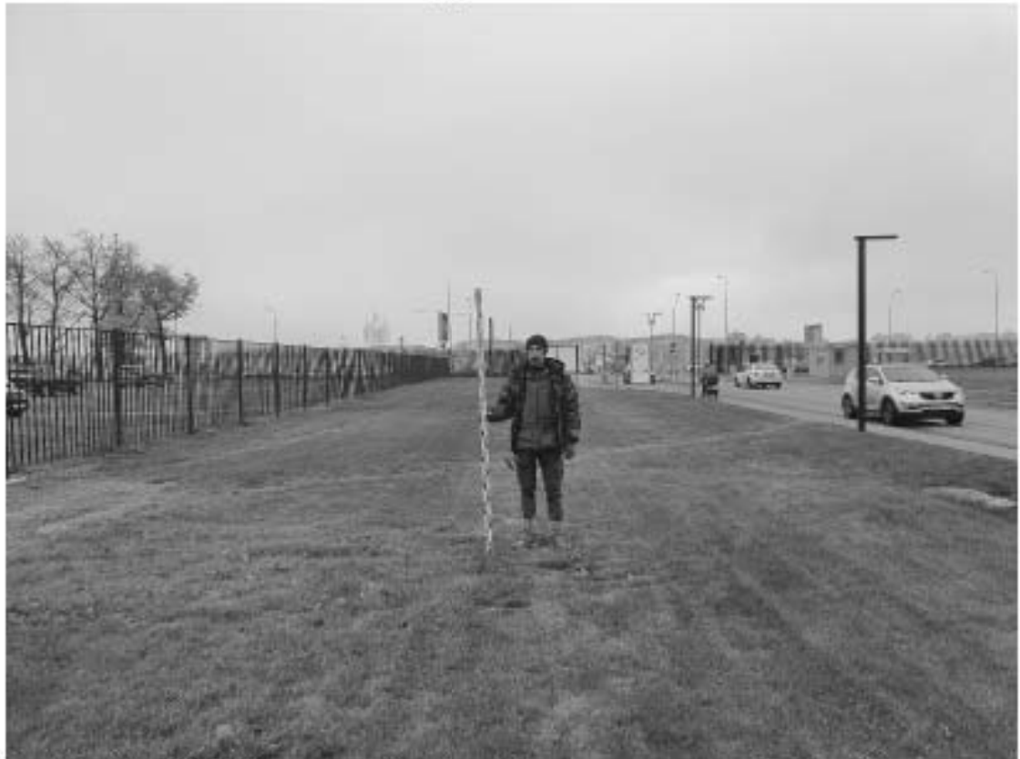
Рис. 56. СПб-2021. Калининский район, Свердловская наб., 44. Общий вид участка обследования. Шурф 4. До начала работ. Вид с севера
