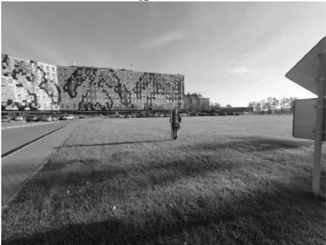
Рис. 17. СПб-2021. Калининский район, Свердловская наб., 44. Общий вид участка обследования. Точка фотофиксации 1. Вид с запада
