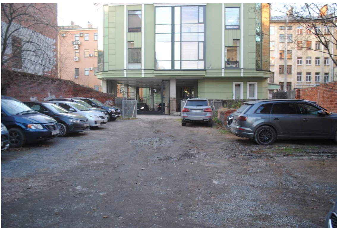
Рис. 31. Санкт-Петербург, Лиговский проспект, д. 112. Общий вид участка обследования. Точка съемки 2. Вид на запад
