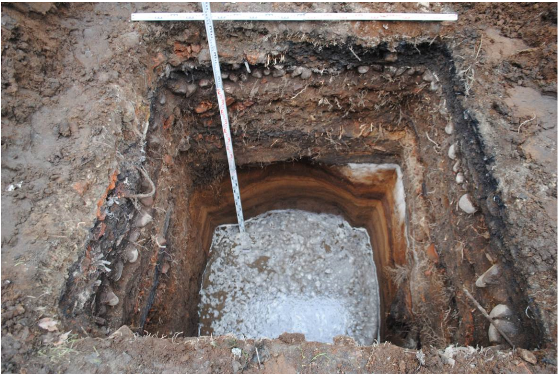
Рис. 35. Санкт-Петербург, Лиговский проспект, д. 112. Шурф 1. Фиксация по уровню грунтовых вод. Уровень прекращения работ. Вид на север
