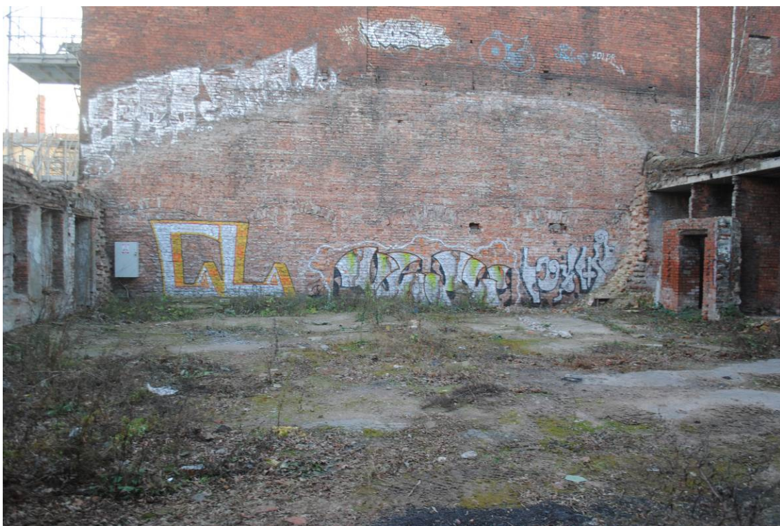
Рис. 27. Санкт-Петербург, Лиговский проспект, д. 112. Общий вид участка обследования. Точка съёмки 1. Вид на юг
