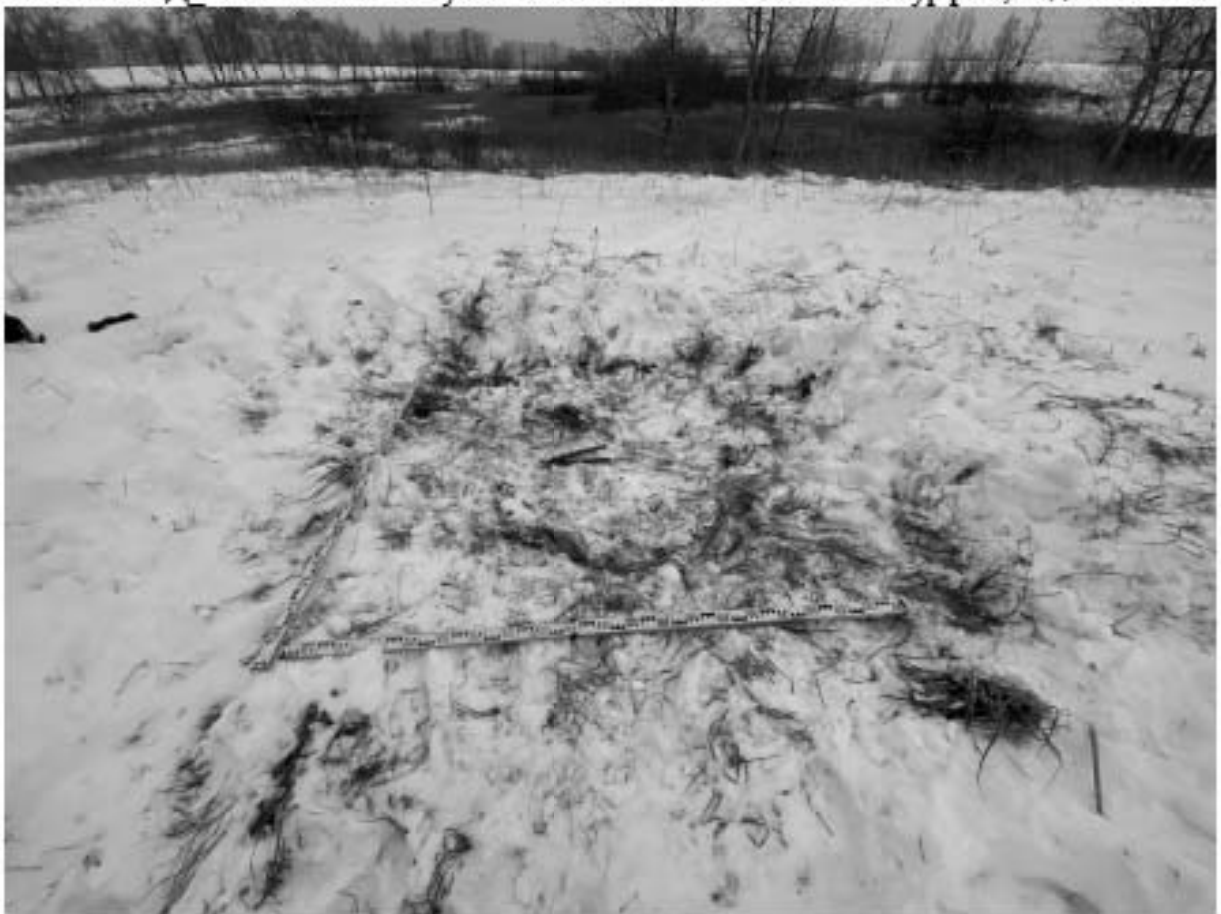
Рис. 110. ЖД_СПб Главный-Обухово П-2021. Шурф 3, дневная поверхность до начала работ, вид на восток.
