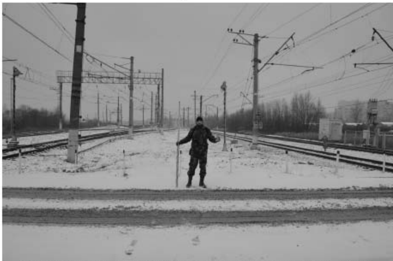
Рис. 11. ЖД_СПб Главный-Обухово II-2021. Точка фотофиксации 1, вид на север.
