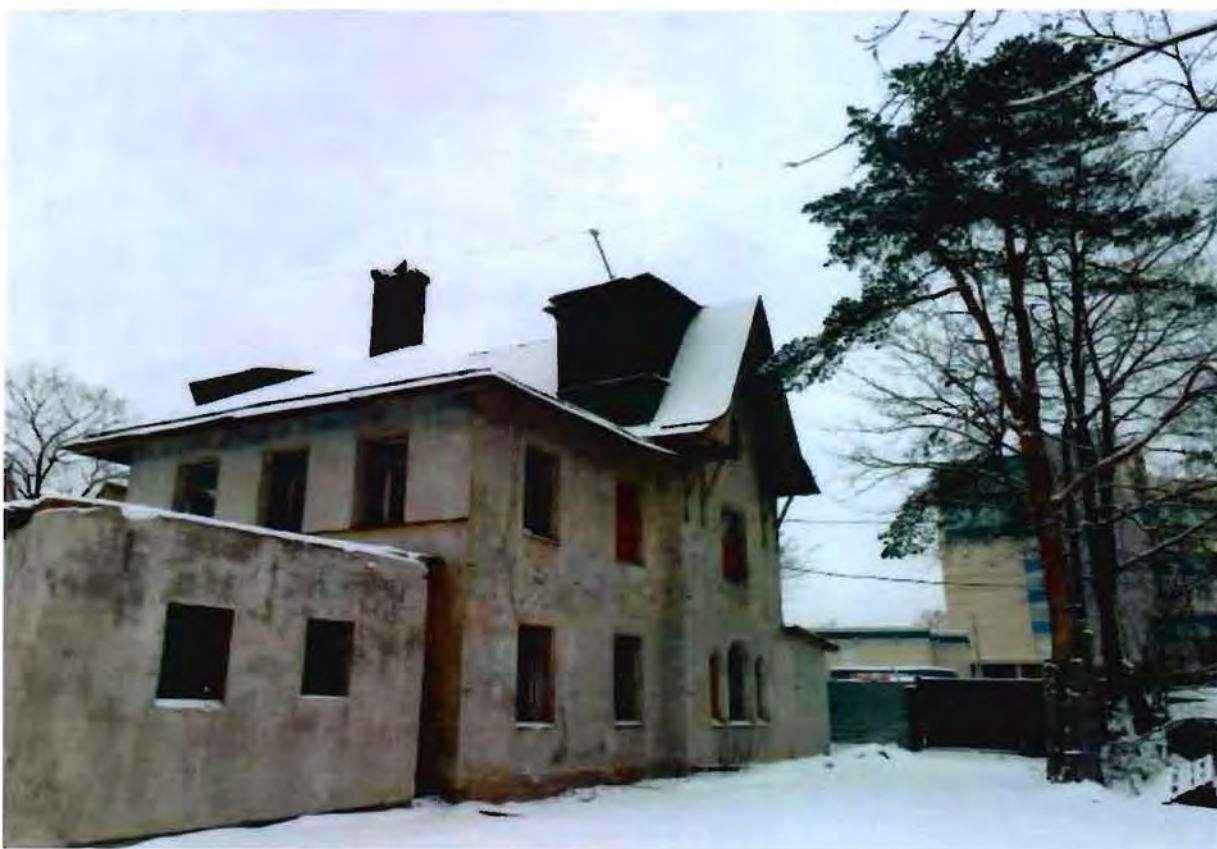
3. Общий вид (юго-восточный фасад и часть территории объекта культурного наследия).
