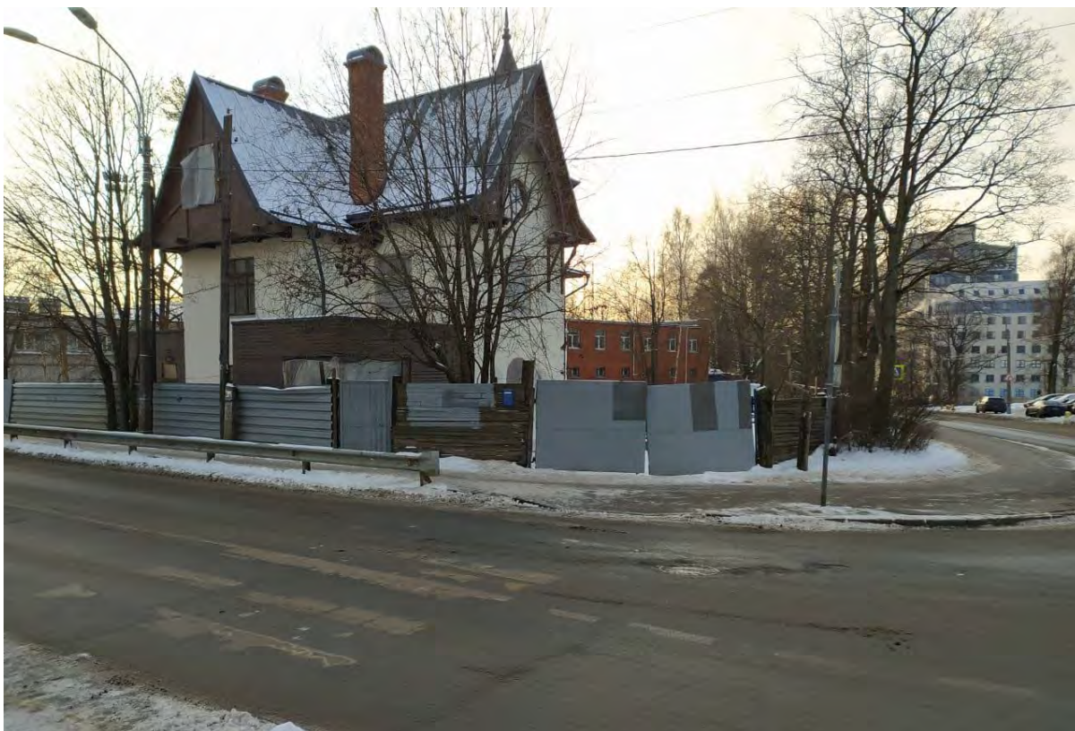
Фото 1. Вид с перекрестка ул. Солунской и 3-й линии 1-половины в сторону объекта культурного наследия регионального значения «дом Грабе».
