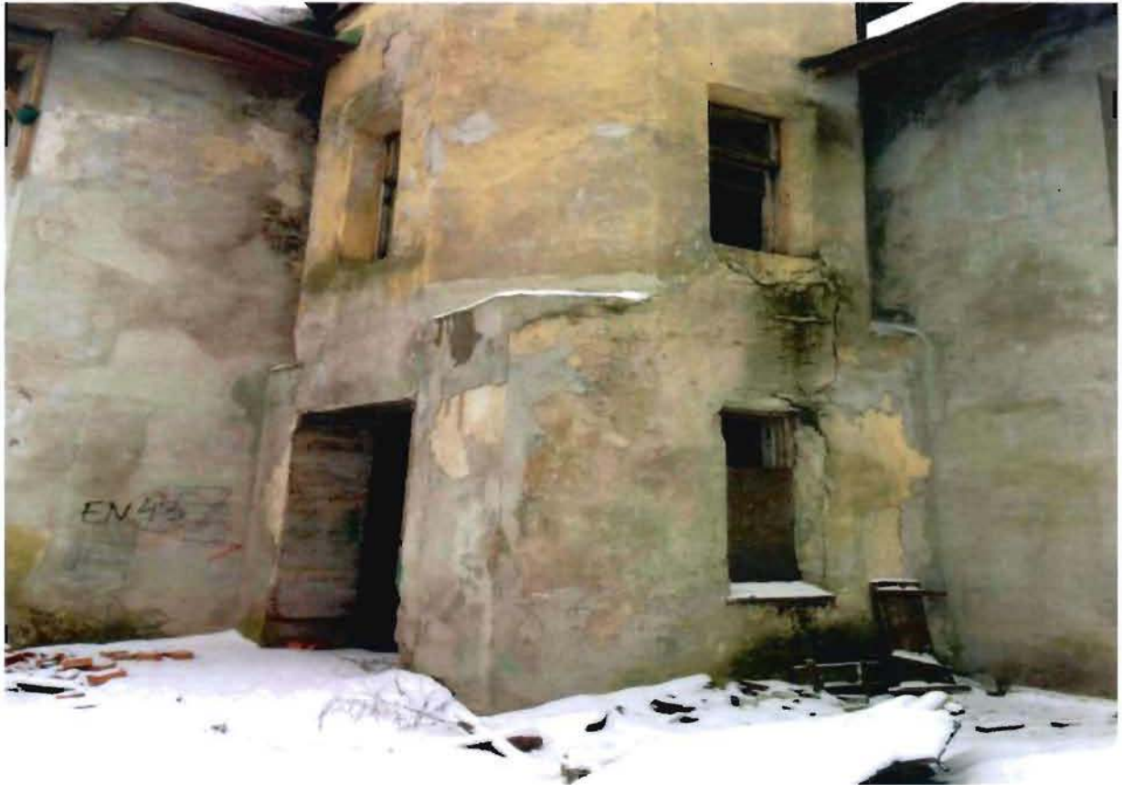
4. Вход со стороны северо-западного фасада.
