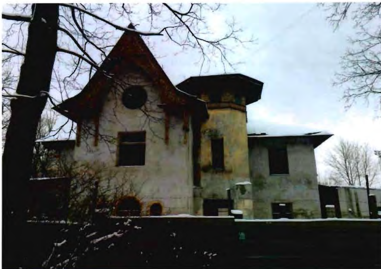
2. Общий вид (юго-восточный фасад).
